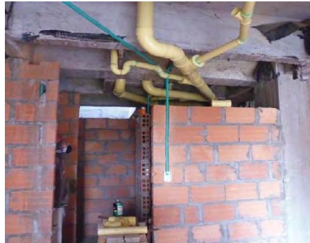
Figura 28. Instalaciones internas de la tubería hidráulica
