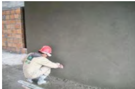
Figura 39. Repello de muros internos
