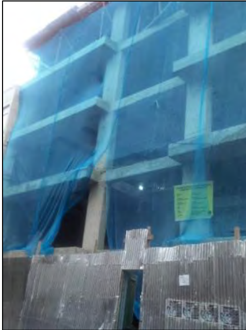
Figura 38. Fachadas del edificio
