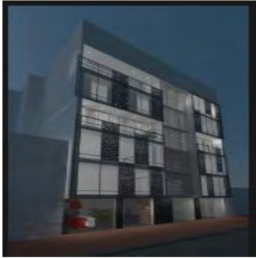
Figura 4. Edificio “KAOBA” (ver anexo 9)
