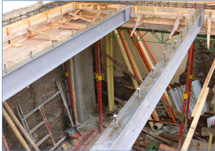
Figura 16. Instalación elementos estructurales metálicos (vigas ipe)
