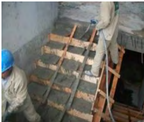
Figura 41. Fundición de escaleras
