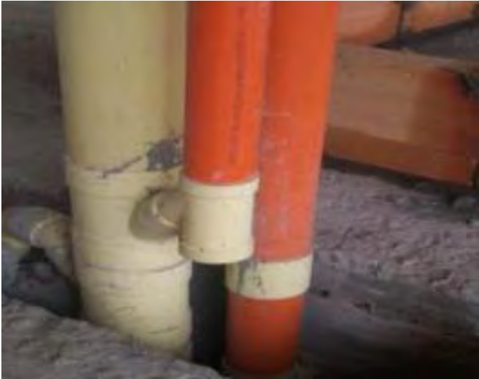
Figura 25. Instalación de tubería
