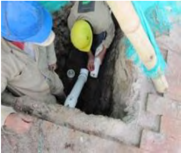
Figura 26. Limpieza y soldadura de la tubería
