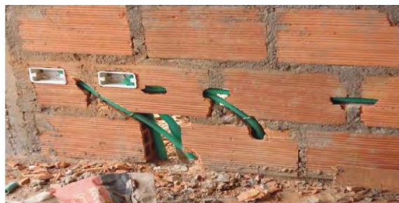
Figura 34. Instalaciones tubería eléctricas
