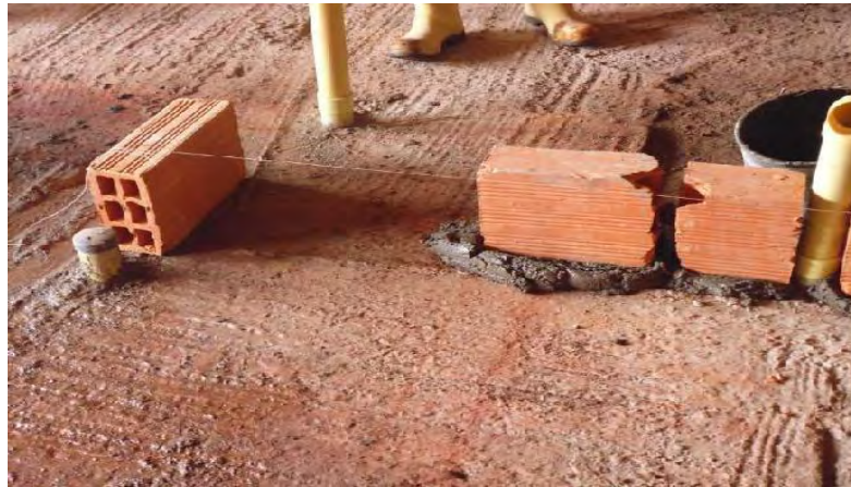
Figura 36. Verificación de Hilada
