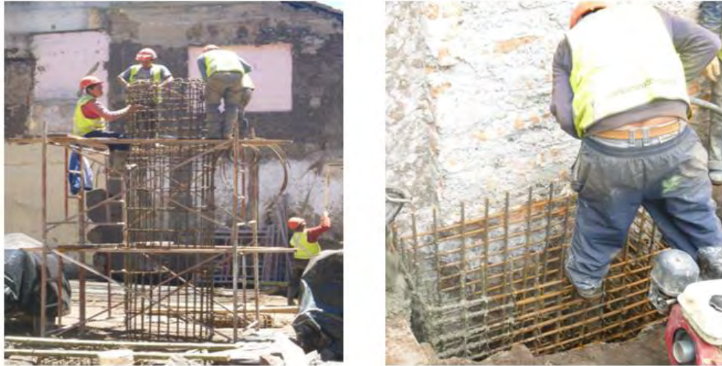
Figura 6. Construcción de caisson y barretes
