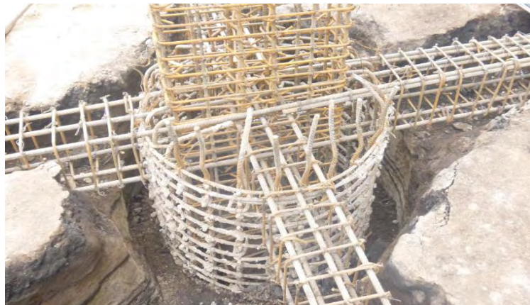
Figura 8. Vigas de cimentación
