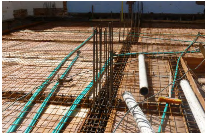
Figura 21. Instalación de la malla electrosoldada
