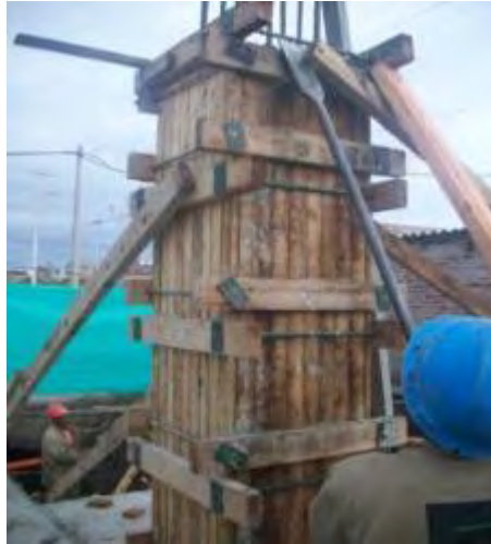
Figura 11. Formaleta de columnas
