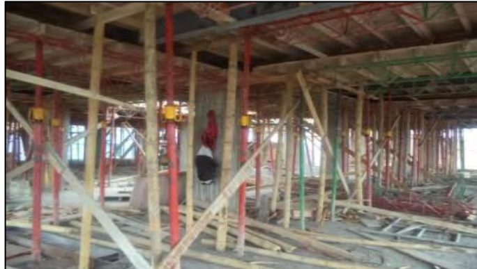
Figura 14. Armado de formaleta para la losa
