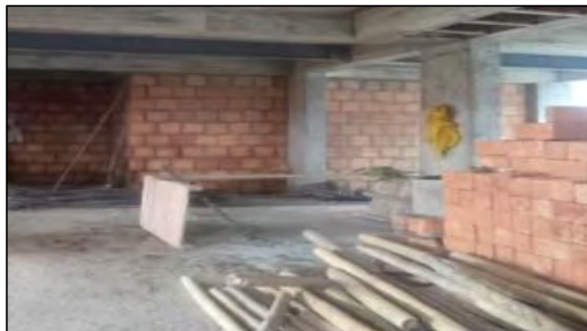
Figura 35. Pega de ladrillo farol
