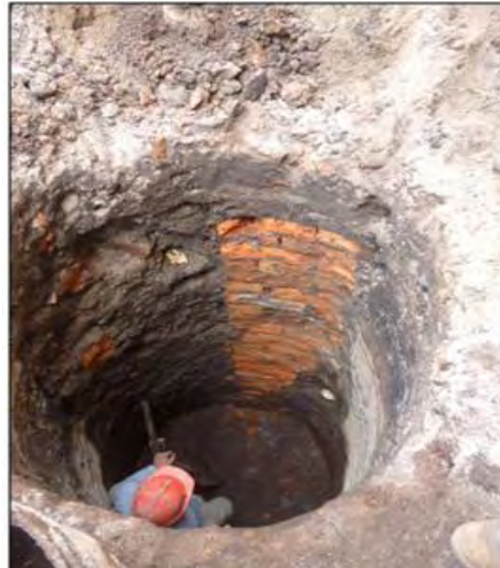
Figura 5. Excavación para el cimiento
