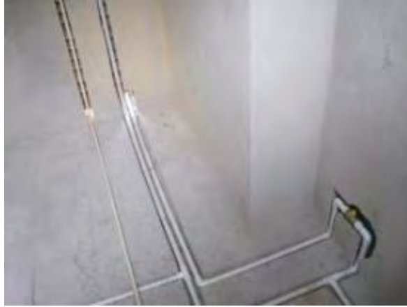
Figura 27. Instalaciones internas de la tubería hidráulica
