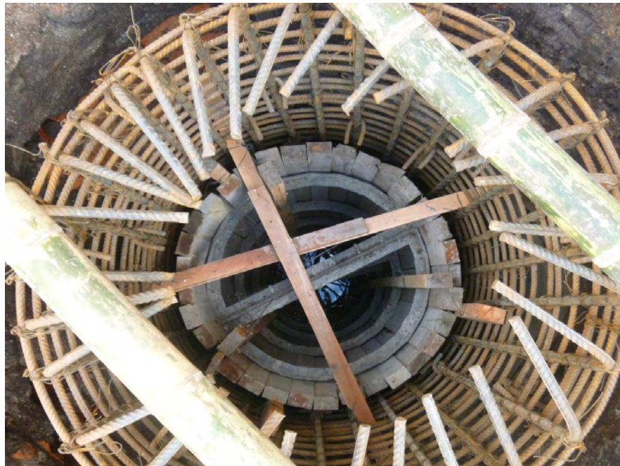
Figura 7. Armado de formaleta para caisson
