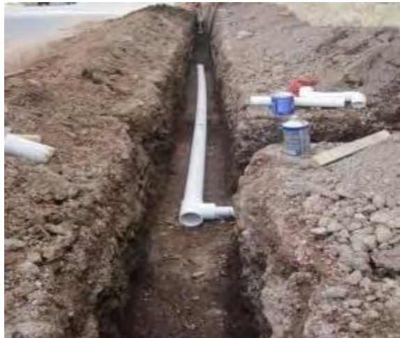
Figura 24. Excavación y conexión de la red hidráulica
