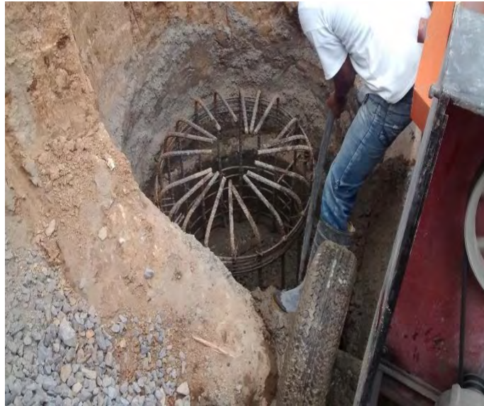
Figura 47. Construcción de caissons con un concreto de 3000 psi.
