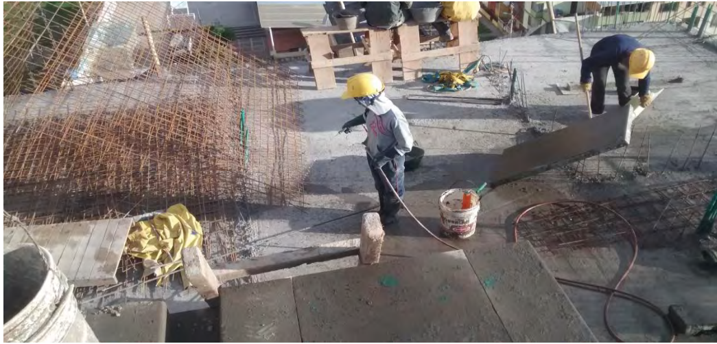
Figuras 41. Curado del concreto después de la fundición.
