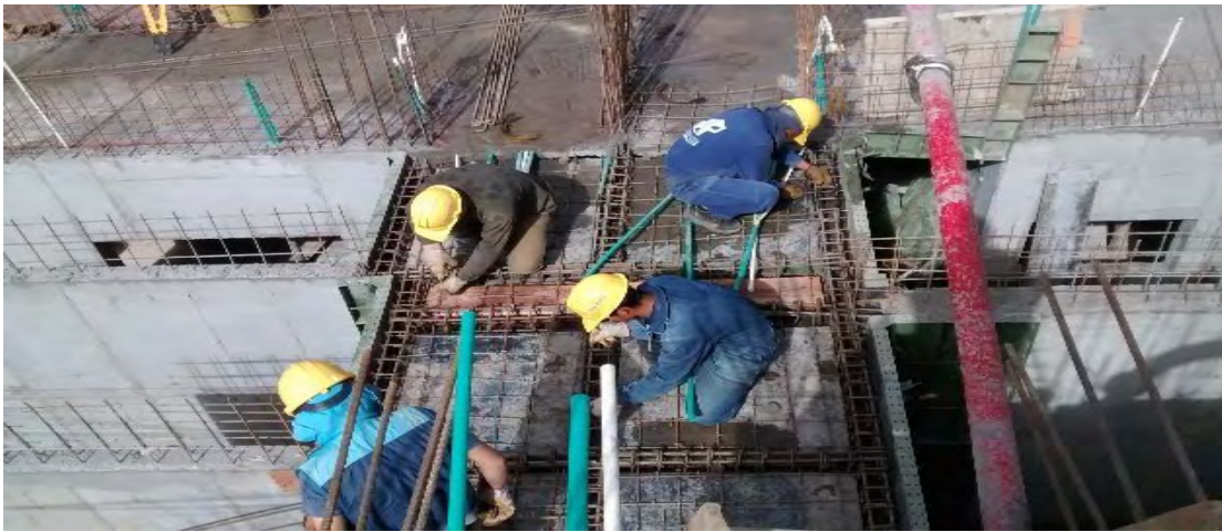
Figuras 36. Armado de refuerzo del punto fijo.
