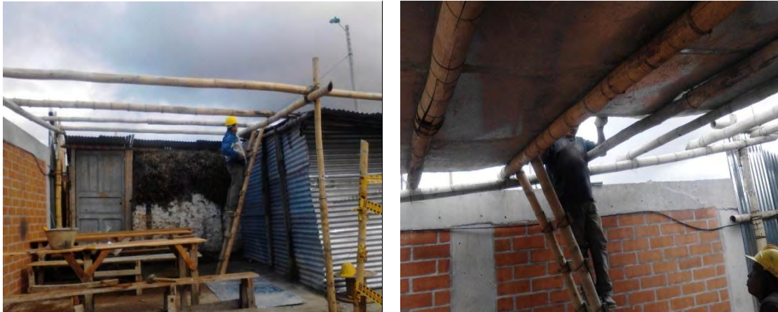
Figuras 6 y 7. Instalación cubierta adicional 1er casino
