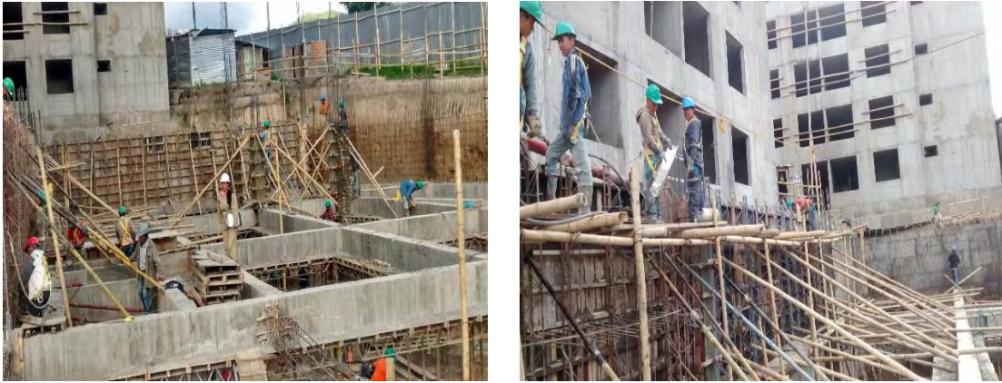
Figuras 60 y 61. Construcción de vigas, columnas y muro de contención en concreto de 3000 psi.
