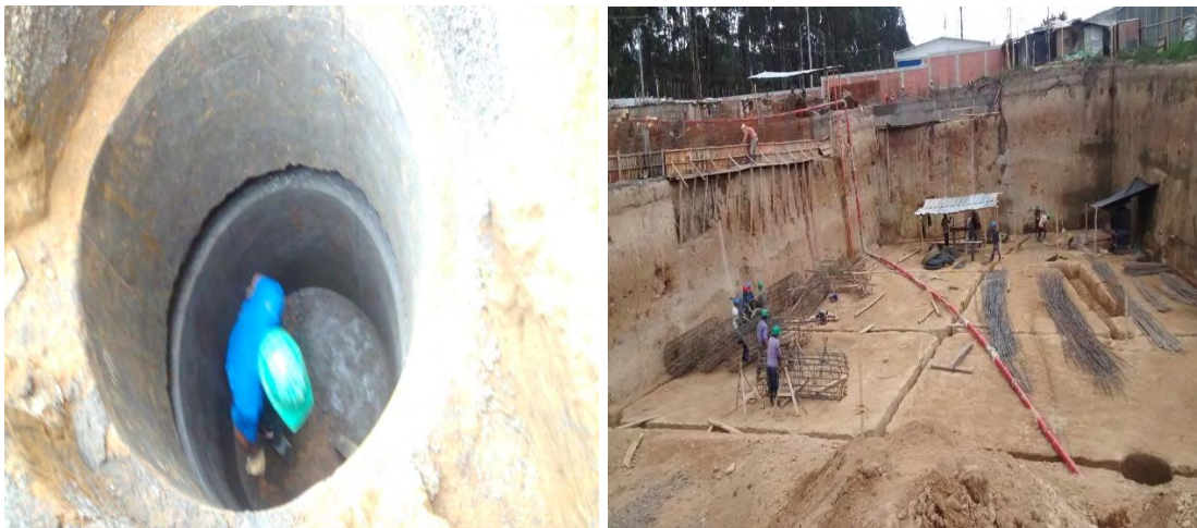
Figuras 45 y 46. Construcción de anillos y armado de canastillas con un concreto de 3000 psi.
