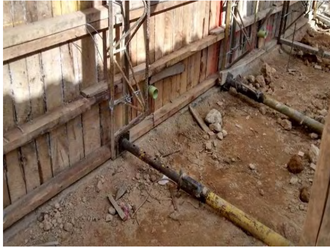
Figura 55. Colocación de pases de 2", para el drenaje del muro de contención.
