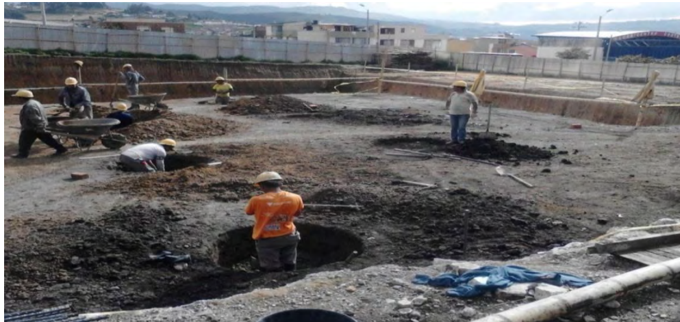
Figura 13. Excavación para construcción de caissons.
