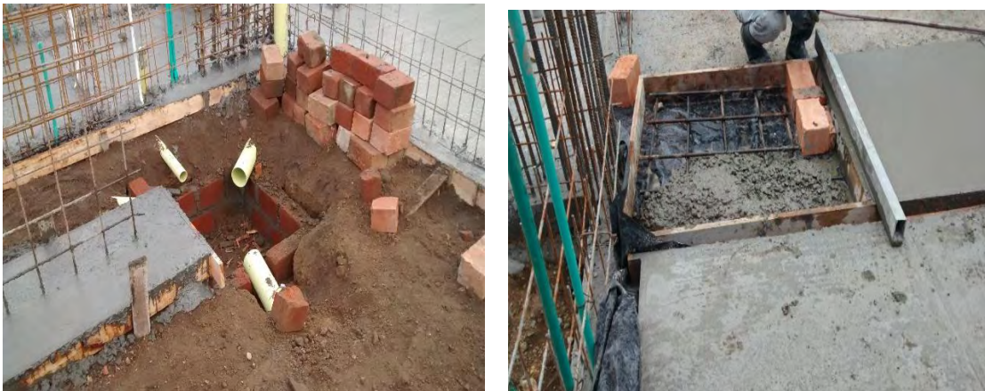
Figuras 22 y 23. Armado en mampostería y fundición de las tapas de concreto de las cajas de inspección sanitarias de las Torres 1 y 2
