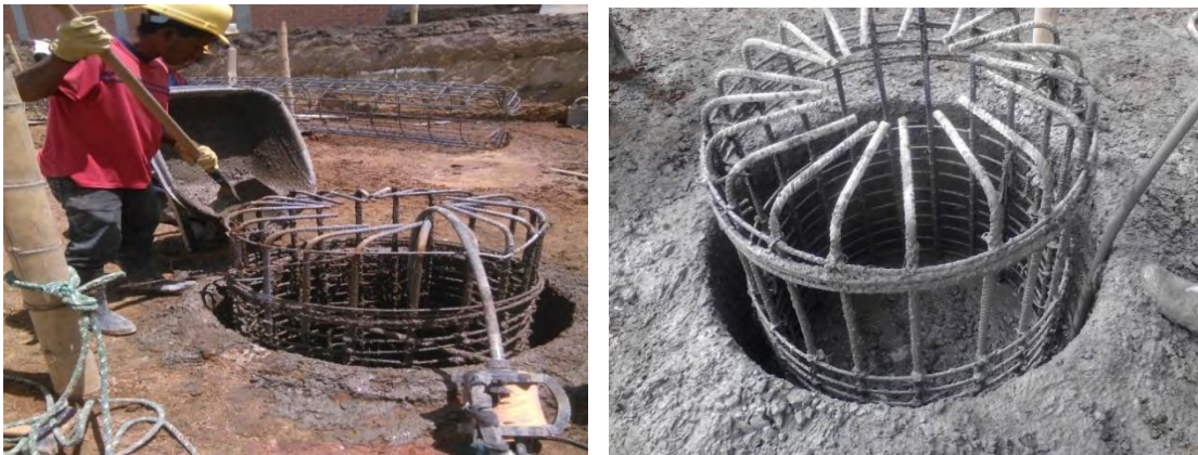
Figuras 16 y 17. Vaciado y vibrado del concreto de 3000 psi según especificaciones técnicas estructurales para construcción de caissons.
