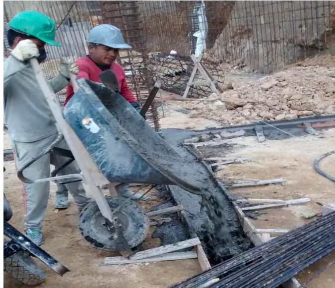
Figura 50. Vaciado de concreto de vigas de cimentación del parqueadero.
