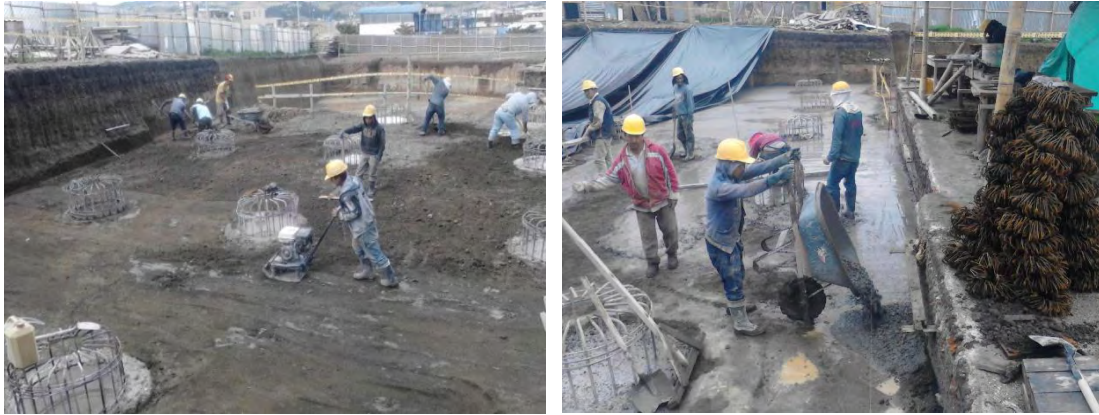
Figuras 18 y 19. Compactación y fundición del solado para la losa de cimentación
