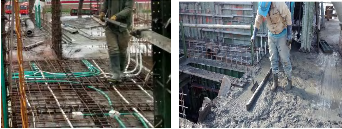
Figuras 37 y 38. Instalaciones generales del punto fijo, control del espesor del concreto de la losa mediante escantillón.
