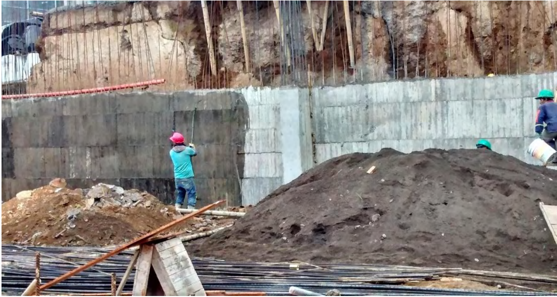
Figura 64. Proceso de curado del concreto de los distintos elementos estructurales del parqueadero.
