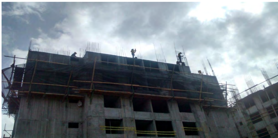
Figura 70. Instalación de malla de protección contra caída de objetos
