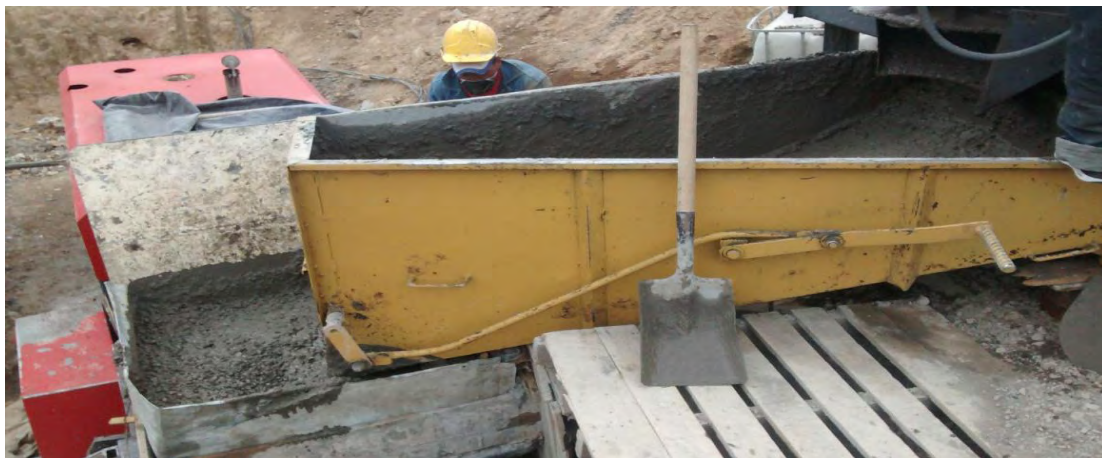
Figura 35. Vaciado de concreto mediante tara metálica empleada para medir con mayor exactitud los m3 consumidos en las fundiciones de la obra.
