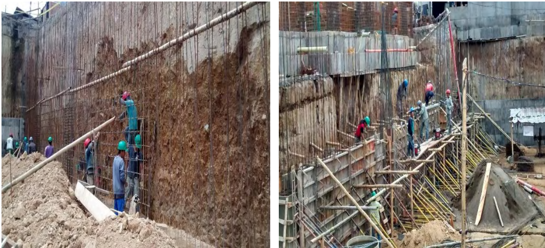
Figuras 56 y 57. Armado de refuerzo de muro de contención, armado y apuntalamiento de formaleta.
