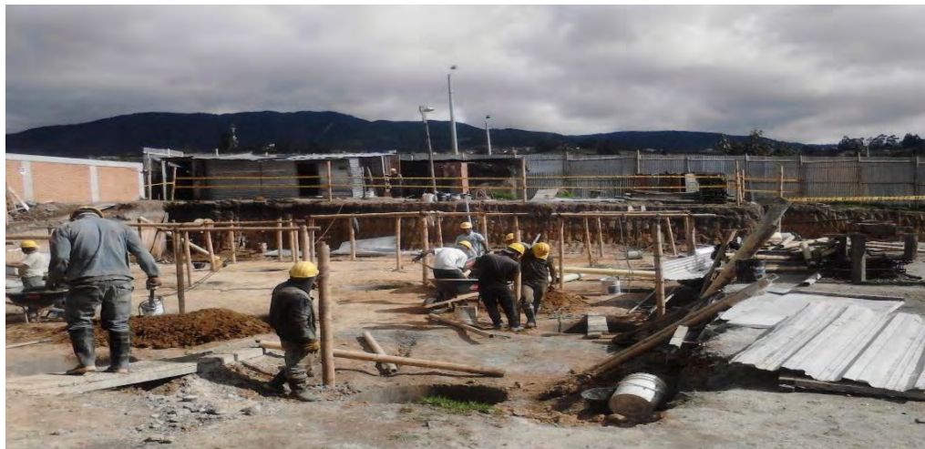
Figura 3. Estado inicial de la obra
