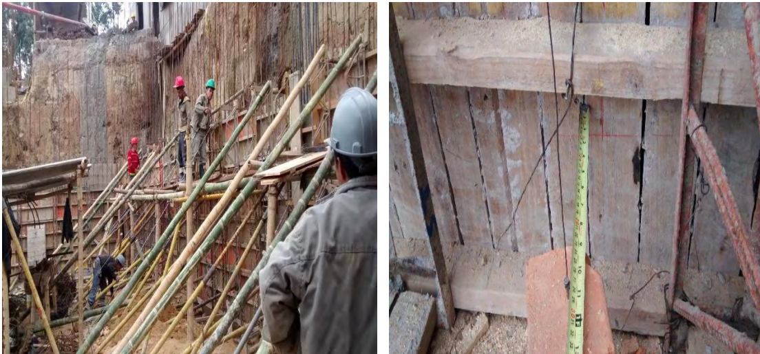
Figuras 53 y 54. Armado de formaleta, revisión de plomos.
