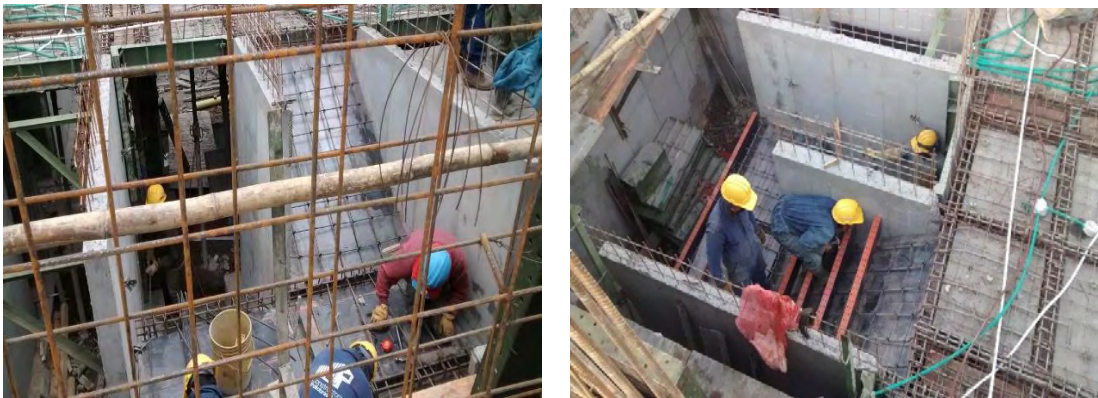
Figuras 39 y 40. Armado de refuerzo de \frac{1}{2} ", e instalación de peldaños metálicos para la conformación de las huellas y contrahuellas de las escaleras.
