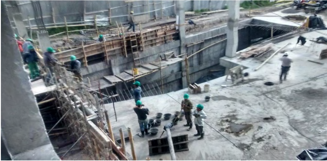
Figura 66. Estado casi finalizado de la primera etapa del parqueadero.
