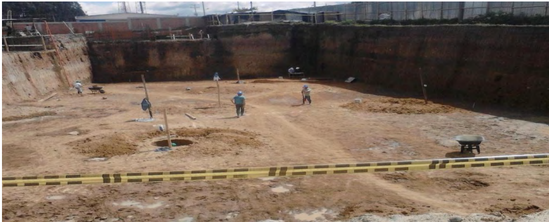
Figura 44. Replanteo, trazo y excavación de los caissons de cimentación del parqueadero.
