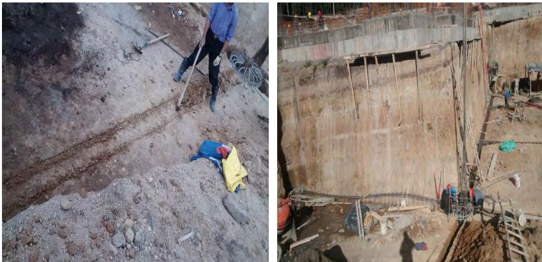
Figuras 48 y 49. Trazado, Excavación y armado de vigas de cimentación del Parqueadero.
