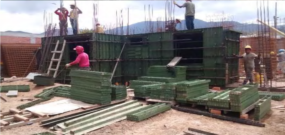
Figuras 28, 29 y 30. Cimbrado, medida de plomos de muros, y armado de un apartamento.
