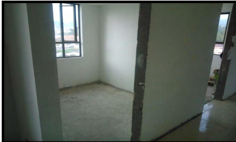
Figura 3. Estado inicial (Apartamentos Torres I y II)
