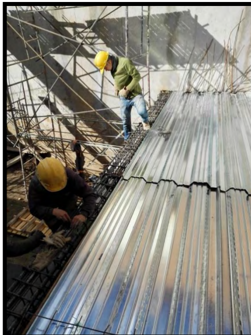
Figura 46. Amarrado de vigas que componen la losa N+2.80
