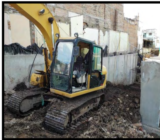
Figura 49. Excavación a máquina
