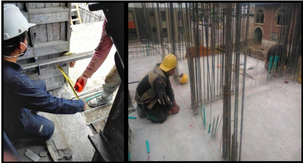
Figura 27. Verificación de plomos y cimbrado de muros estructurales torre III
