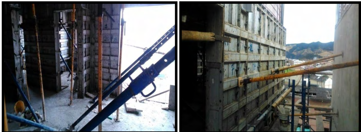
Figura 28. Encofrado y apuntalamiento muros estructurales torre III
