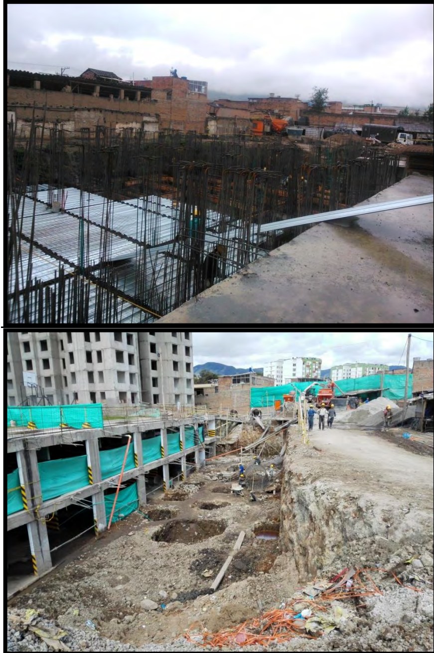
Figura 22. Panorámica general torre III (losa de transición N+6.10) y torre IV (cimentación)
