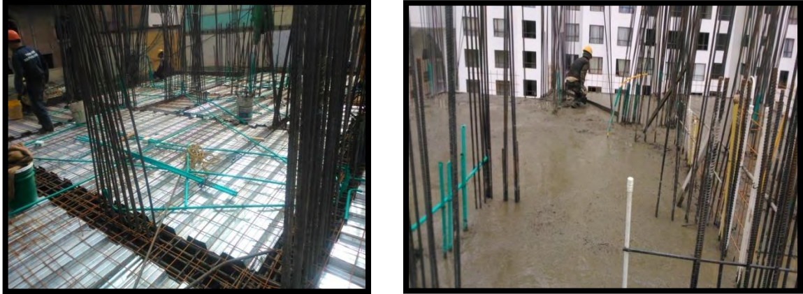
Figura 5. Losa de concreto nivel N+6.10
