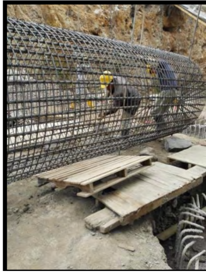
Figura 21. Amarrado y colocado de refuerzo (castillo del Caisson) Torre IV
