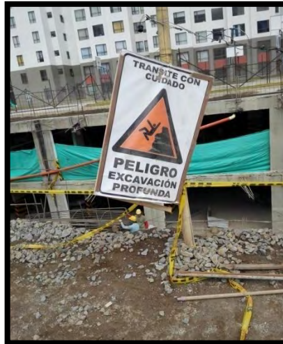
Figura 9. Señalización en obra
