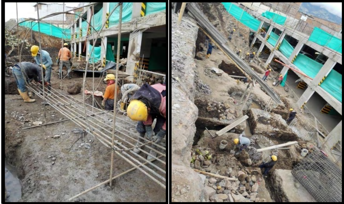
Figura 7. Armado y amarrado de castillo de caissons y ubicación de la cimentación
