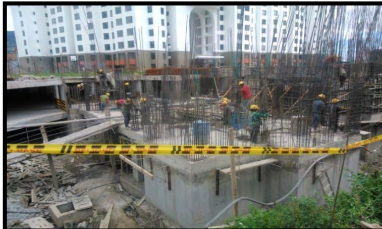
Figura 1. Estado inicial del lugar del proyecto (Torre III)
