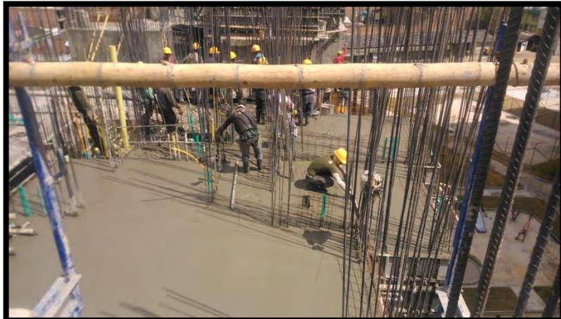
Figura 29. Texturizado final losa superior de apartamento 707 torre III
