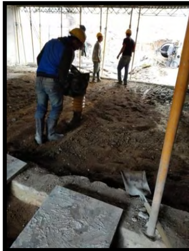
Figura 43. Mejoramiento con material suelo cemento.
