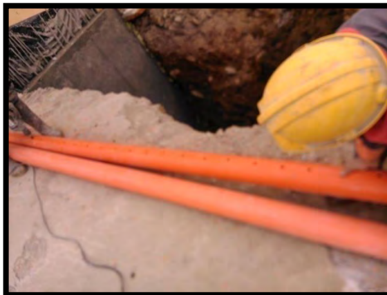
Figura 50. Proceso de perforación de tubo PVC de 4"
