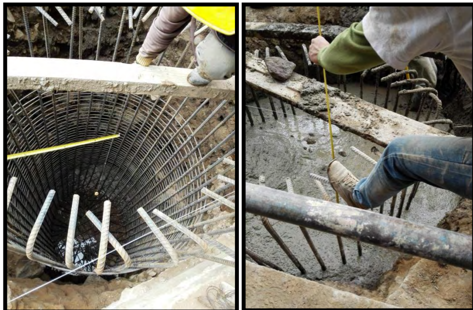
Figura 40. Supervisión caisson (CST2)
