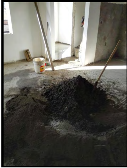
Figura 30. Repello de piso
