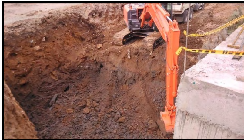
Figura 33. Excavación a máquina Torre IV.
