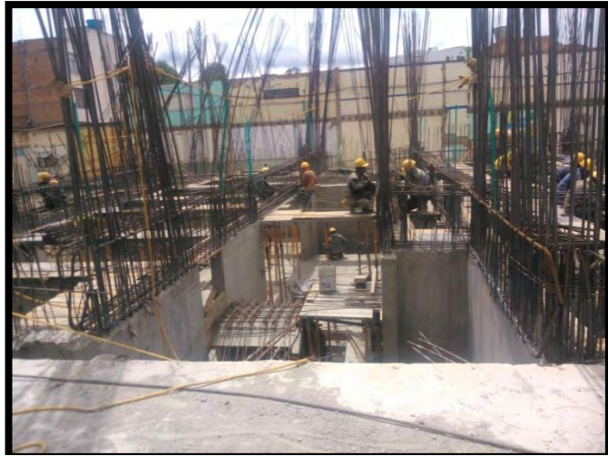
Figura 25. Amarrado y colocado de acero de refuerzo para vigas de transición
