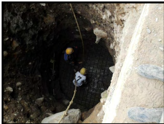
Figura 39. Armado de parrilla de refuerzo
