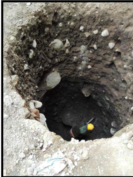
Figura 34. Excavación tipo manual.
