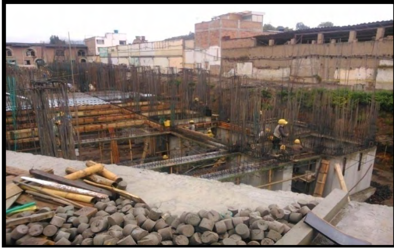
Figura 2. Estado inicial del lugar del proyecto (Torre III)
