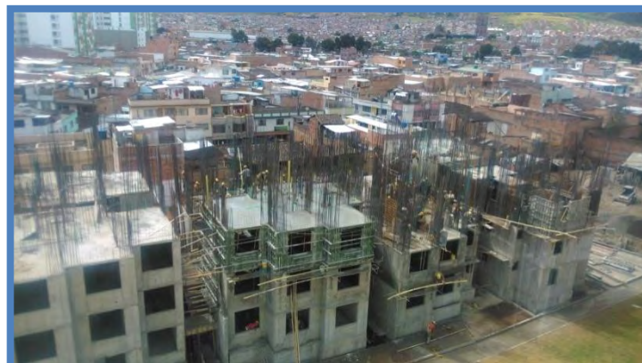
Figura 26. Torre III en construcción
