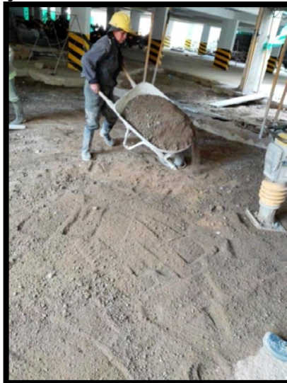
Figura 44. Mejoramiento con material suelo cemento.
