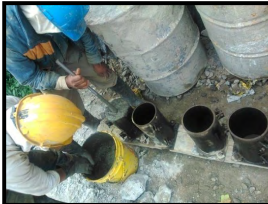
Figura 18. Toma cilindros de concreto
