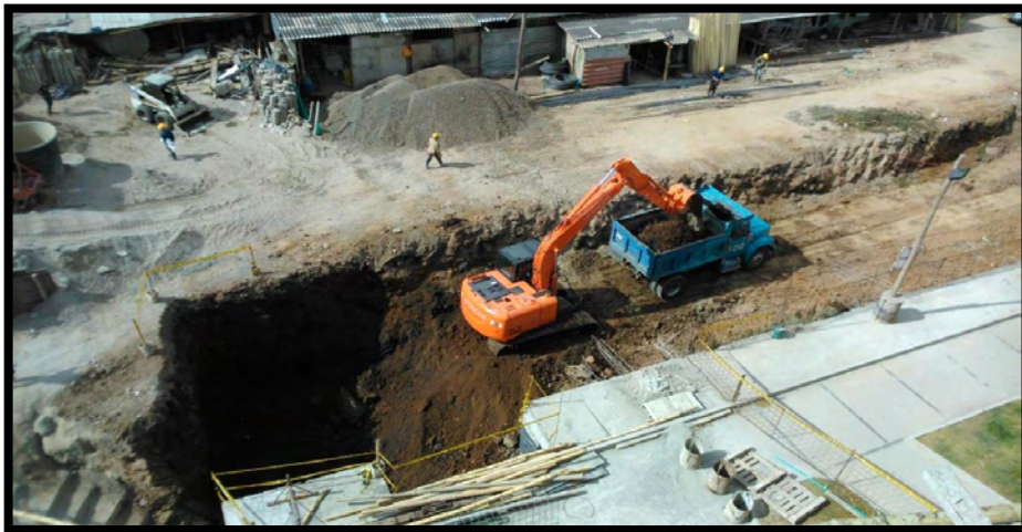
Figura 32. Localización y replanteo, excavaciones
