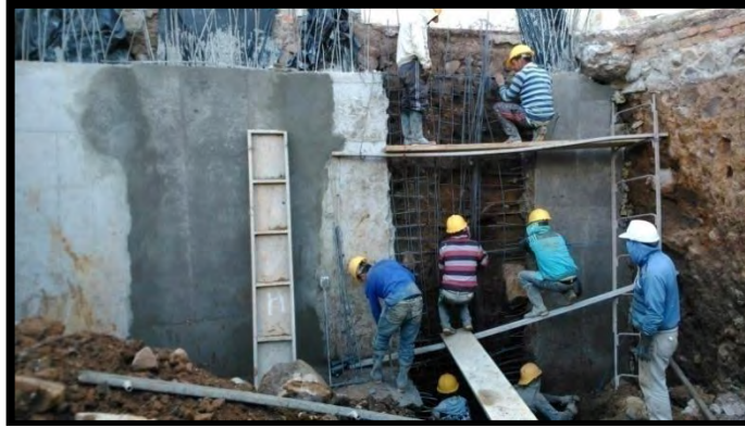
Figura 48. Muro de contención
