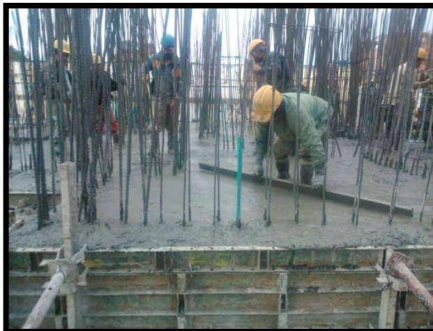
Figura 17. Acabado losa de apartamento 313 torre III
