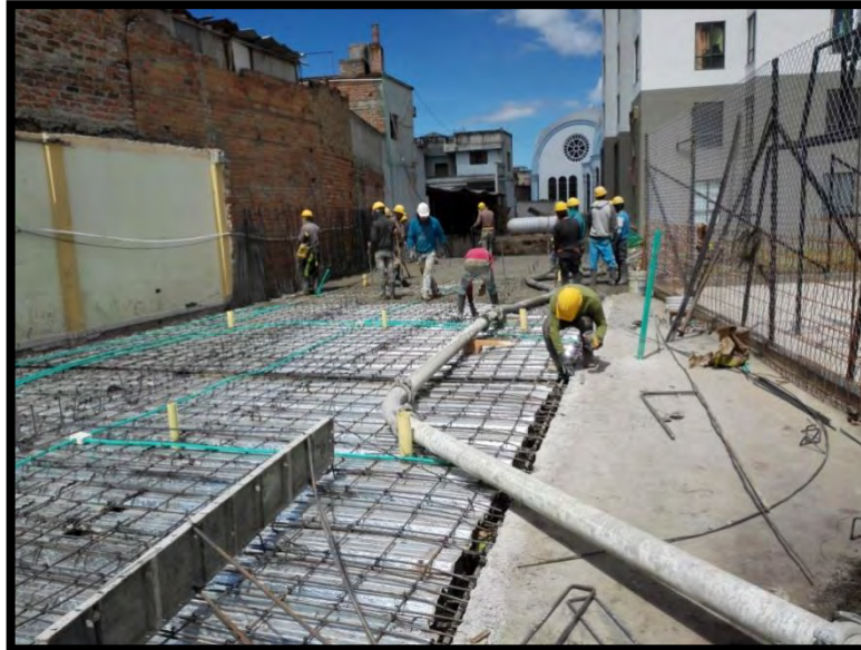
Figura 47. Fundición losa nivel N+6.10
