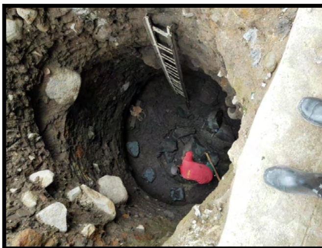
Figura 35. Excavación en roca
