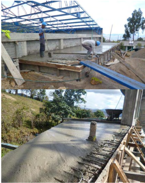
Figura 70. Construcción de losa aligerada en la tarima y media luna de acceso.
