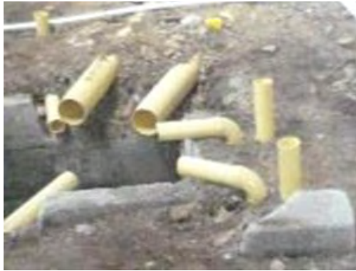
Figura 53. Instalación de tubería sanitaria PVC de 4".
