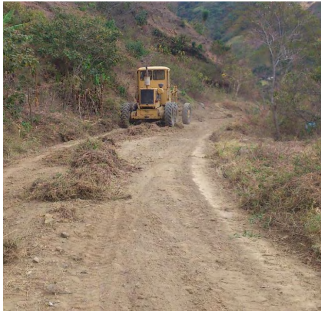
Figura 11. Conformación de calzada existente.
