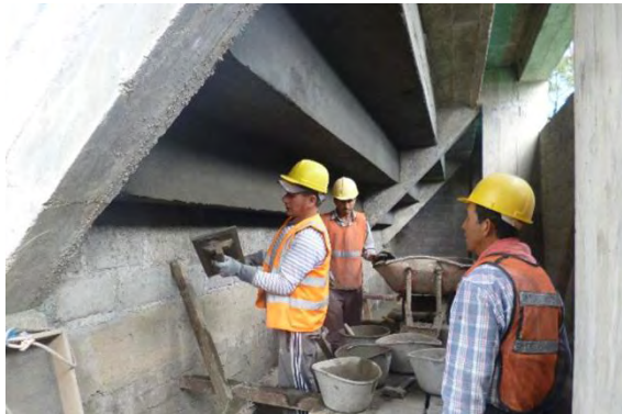
Figura 59. Repello de muros internos.
