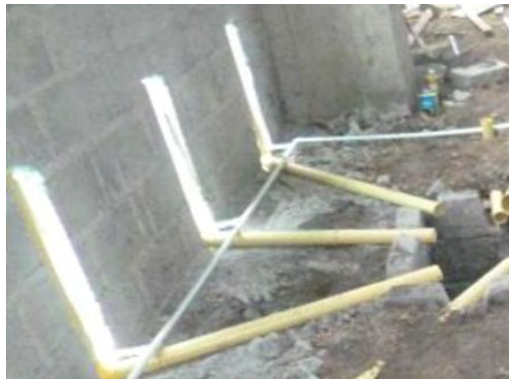
Figura 54. Instalación de tubería sanitaria PVC de 2".
