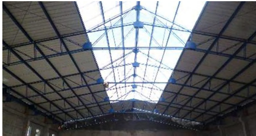
Figura 69. Teja translúcida instalada.
