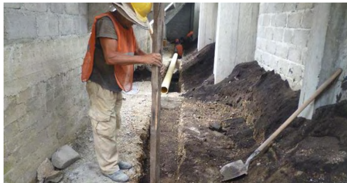
Figura 52. Instalación de tubería sanitaria PVC de 6".
