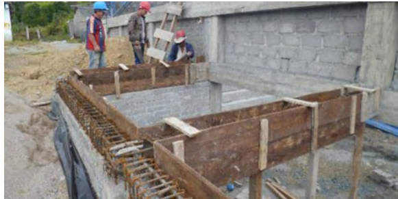
Figura 44. Construcción de viga aérea de 25 x 25cm.
