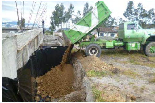
Figura 50. Relleno con recebo.
