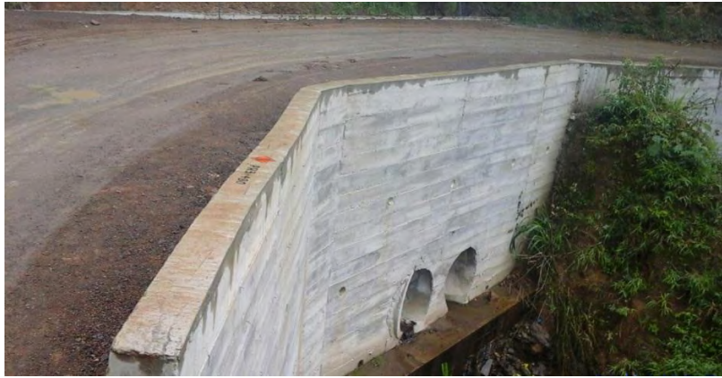
Figura 6. PR3+480 muro en concreto reforzado de 11.4m.
