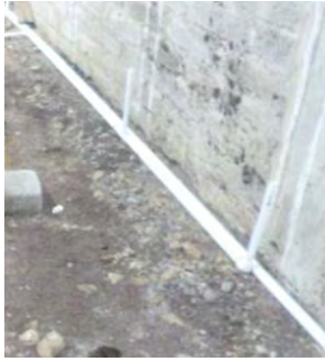
Figura 55. Instalación de tubería hidráulica de 1”.
