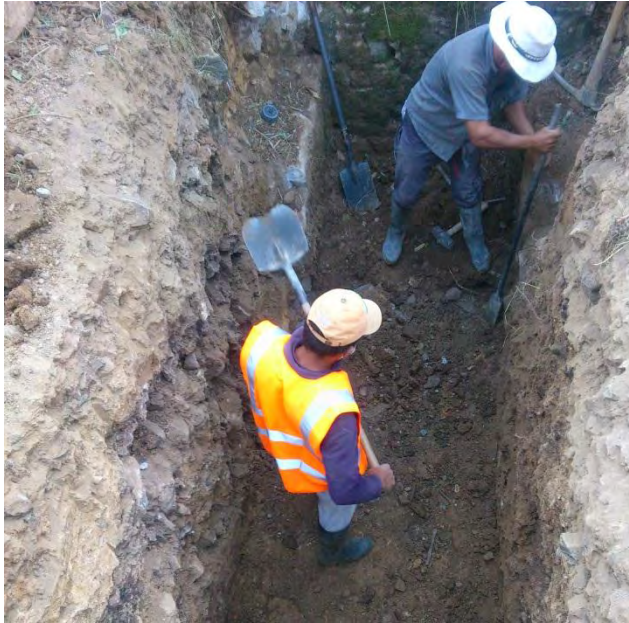
Figura 1. Excavación en material común.
