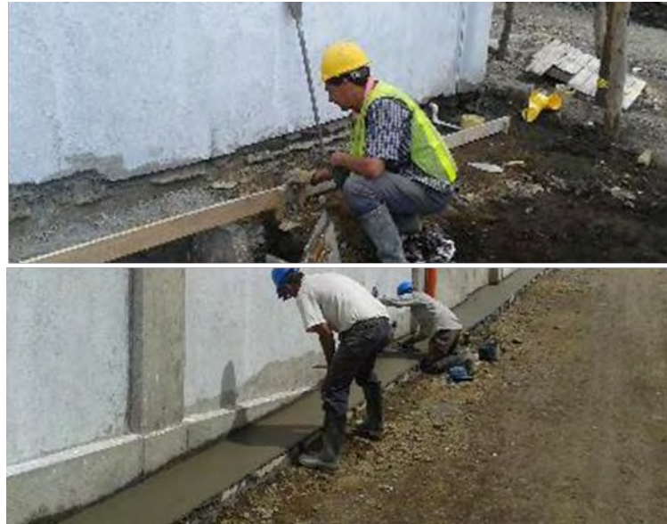
Figura 78. Construcción del andén perimetral.
