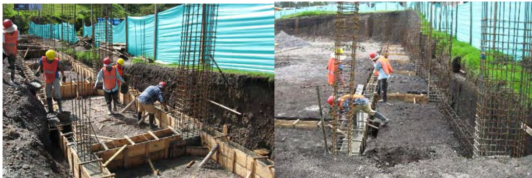
Figura 37. Construcción de vigas de cimentación de 30 x 35cm.
