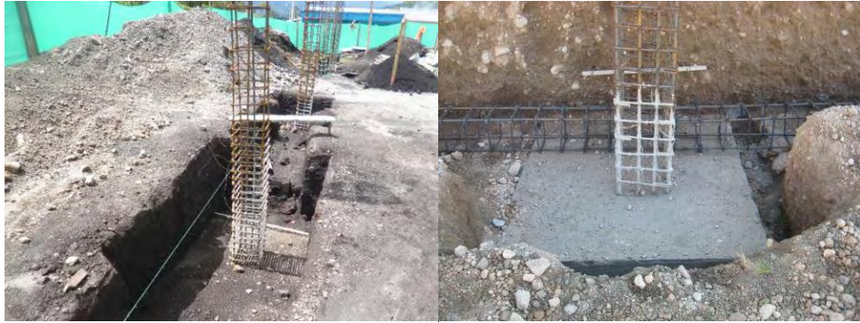
Figura 36. Construcción de zapatas.
