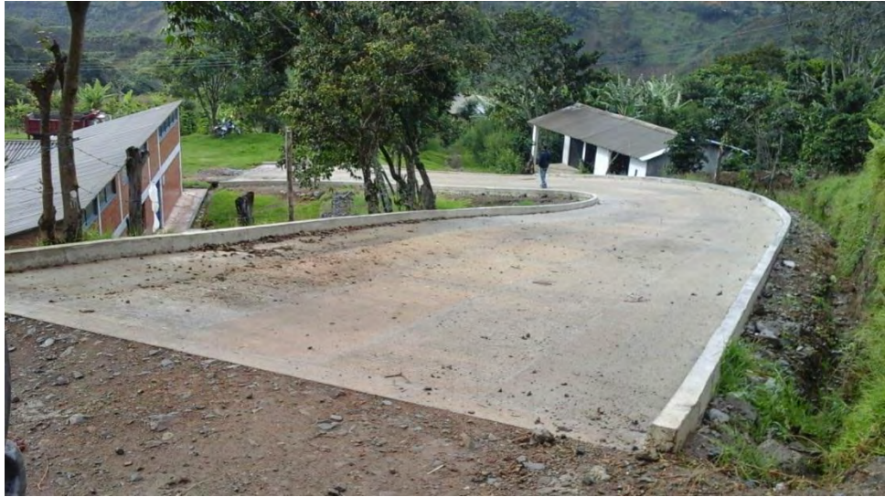
Figura 10. PR14+500 placa huella acceso IPS-I del pueblo Inga Aponte.
