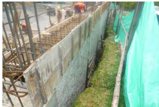
Figura 47. Construcción de viga aérea de 35 x 35cm.
