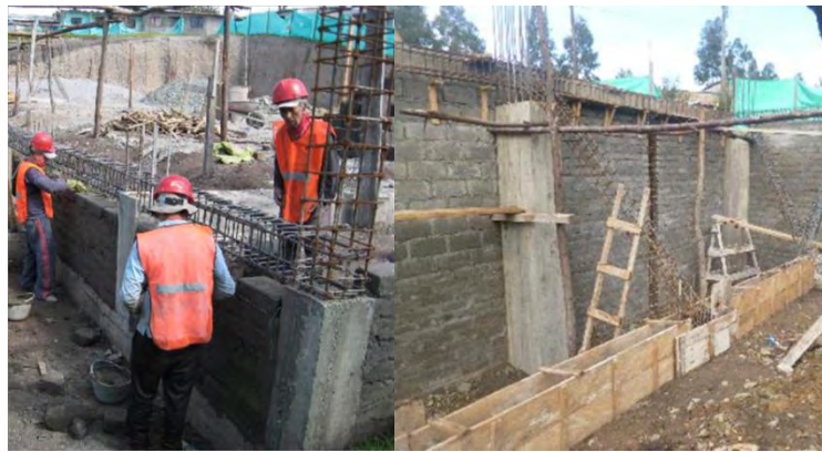
Figura 42. Mampostería en bloque de cemento.
