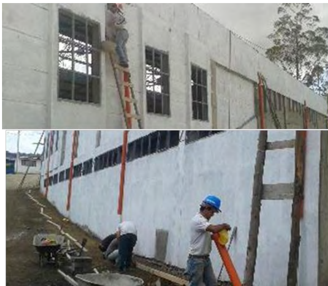
Figura 77. Instalación de tubería para agua lluvias.
