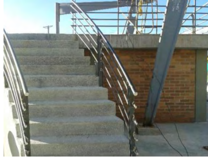
Figura 17. Pasamanos metálicos de la tarima.
