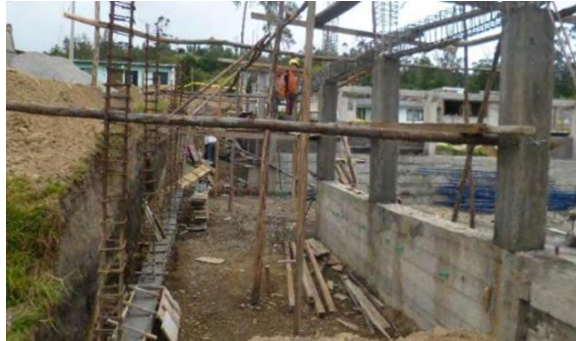
Figura 39. Construcción de vigas de cimentación de 25 x 25cm.
