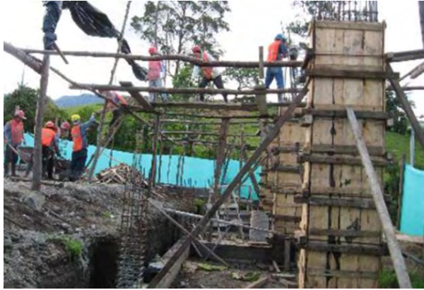
Figura 41. Construcción de columnas de 80 x 40cm.
