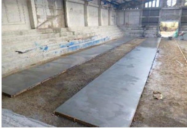
Figura 72. Piso de 10cm de espesor
