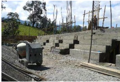
Figura 48. Construcción de graderías.
