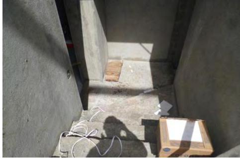
Figura 63. Escaleras en concreto de acceso a los baños.
