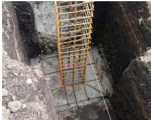
Figura 35. Solado de zapata.
