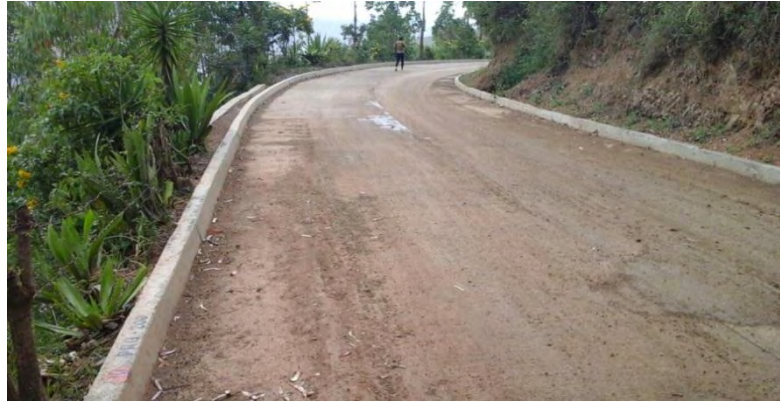
Figura 3. PR0+200 fin de pavimento construido.
