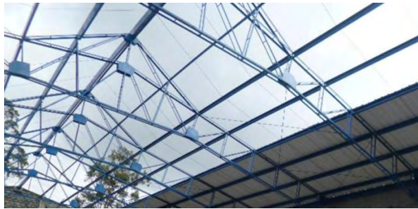
Figura 64. Cerchas metálicas en ángulo doble.
