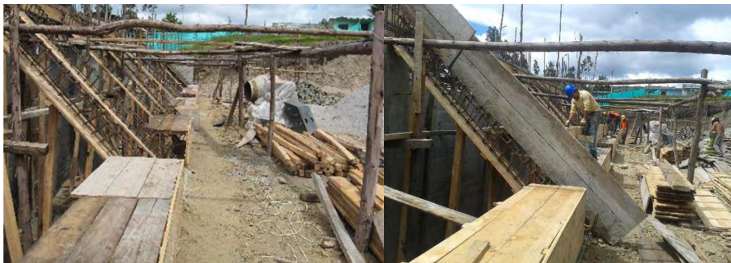
Figura 45. Construcción de viga aérea de 30 x 25cm inclinada.
