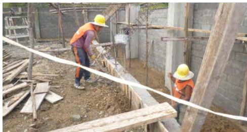
Figura 38. Construcción de vigas de cimentación de 30 x 30cm.
