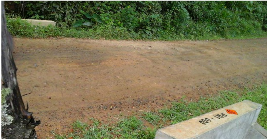
Figura 8. PR1+600 alcantarilla terminada de 36".
