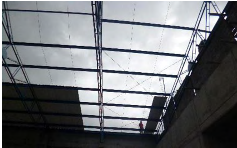
Figura 68. Instalación de teja termoacústica.
