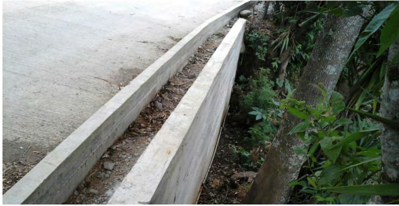
Figura 5. PR0+100 muro de contención de 9m.
