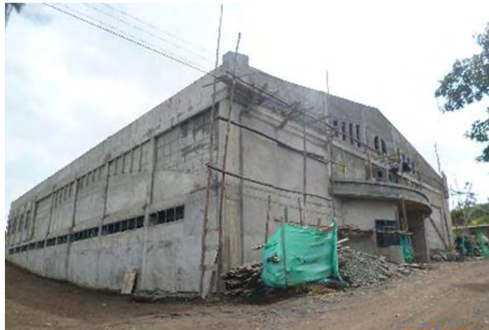
Figura 71. Repello en muros externos.
