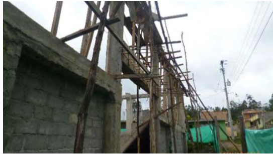
Figura 46. Construcción de viga aérea de 30 x 30cm.
