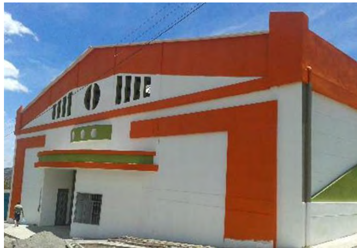
Figura 79. Pintura en muros externos.
