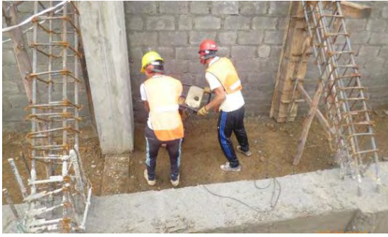
Figura 43. Base en recebo compactado en zona de camerinos.
