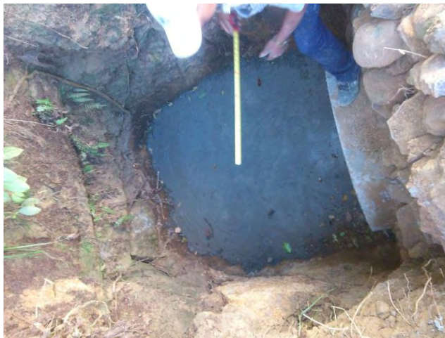
Figura 4. Solado en concreto.
