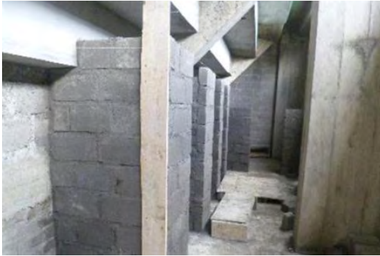
Figura 58. Muros divisorios baterías sanitarias.
