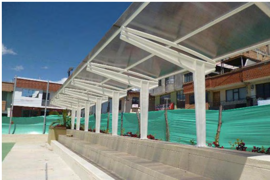
Figura 33. Cubierta en policarbonato graderías cancha de chaza.
