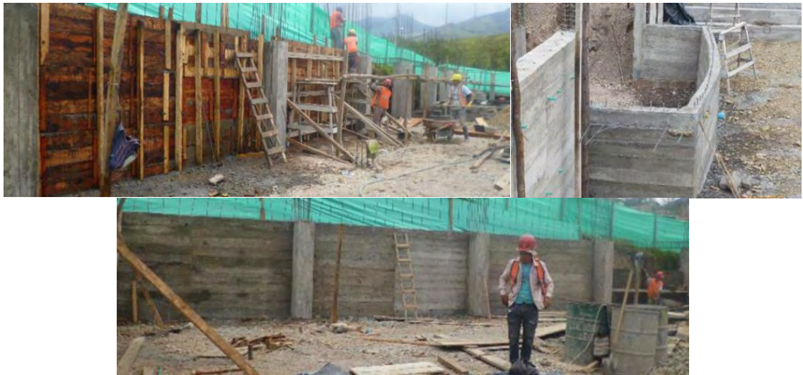
Figura 49. Construcción de muros.
