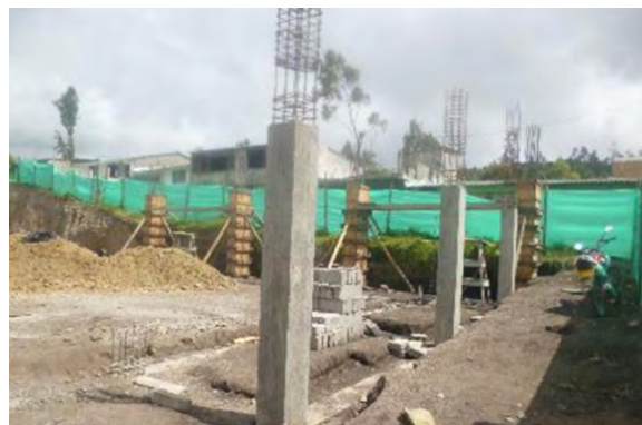
Figura 40. Columnas de 30 x 30 cm fundidos.
