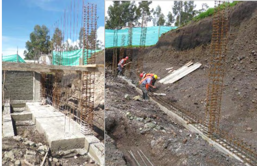
Figura 34. Concreto ciclópeo en ejes y zarpas de los muros.
