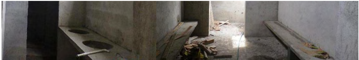
Figura 61. Mesón en concreto.
