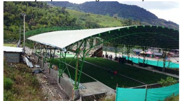
Imagen 113 Cubierta metálica con su teja tipo standing sin traslapo.
