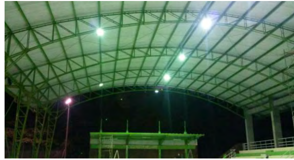
Imagen 95 Iluminación en polideportivo cubierto.
