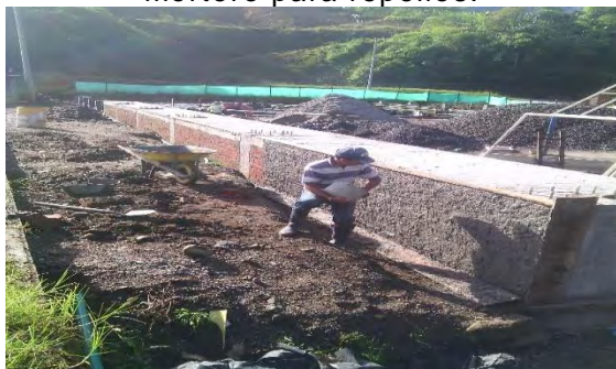
Imagen 124 Aplicación de mezcla de mortero para repellos.
