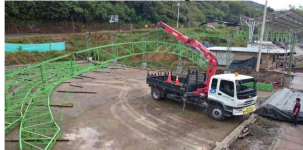
Imagen 107 Levantamiento de cercha metálica en ángulos.
