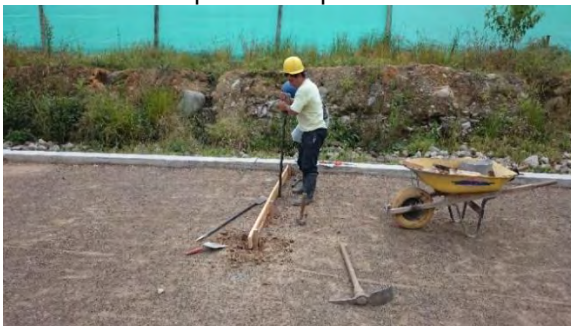
Imagen 74 Instalación de formaleta para placa de piso.
