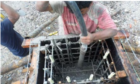
Imagen 70 Vibrado de concreto para columnas.
