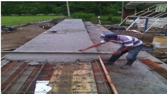
Imagen 122 Fundición de graderías en concreto.
