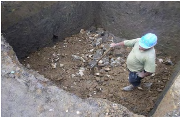
Imagen 42 Disposición de capas de recebo cemento en el suelo.
