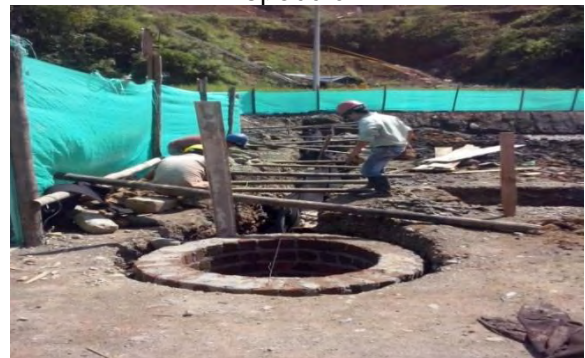
Imagen 51 Acople de filtro a cámara de inspección.
