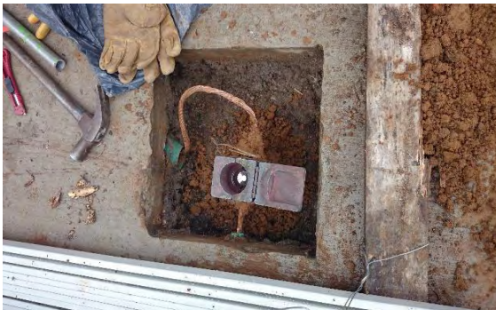
Imagen 92 Instalación de polo a tierra.
