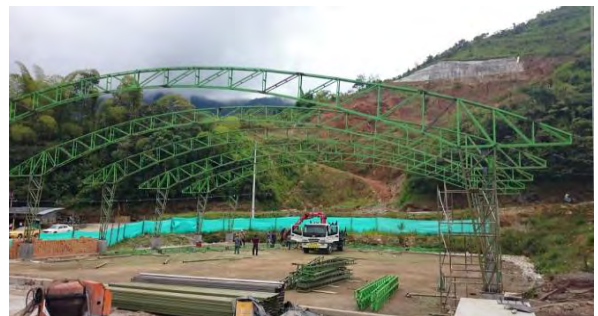
Imagen 109 Cercha en ángulos apoyada en columnas y vigas metálicas.
