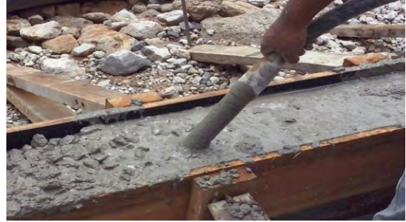
Imagen 65 Vibrado de concreto en viga de cimentación.
