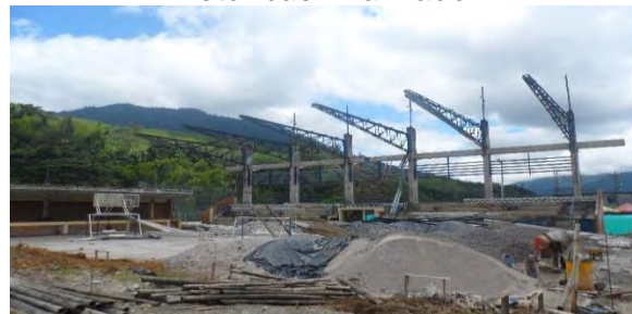
Imagen 19 Desmote de correas metálicas finalizado.
