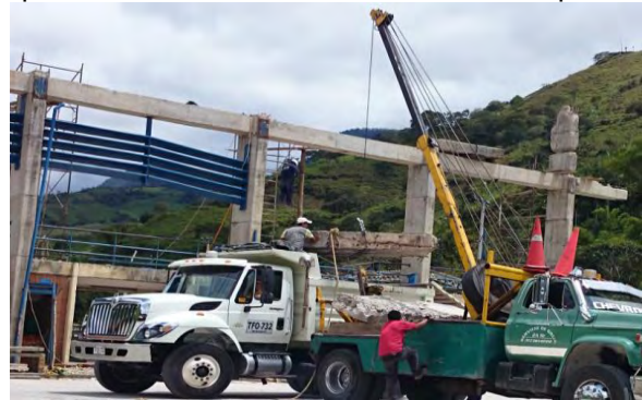
Imagen 33 Desmorte de columnas para posterior demolición sobre base de piso.
