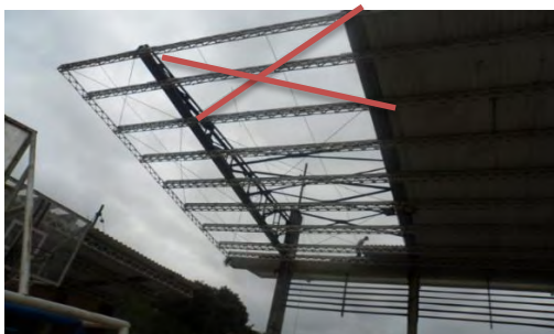
Imagen 14 Tensores a desmontar.
