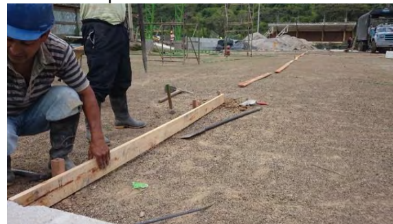
Imagen 75 Modulación y nivelación de placas de concreto.
