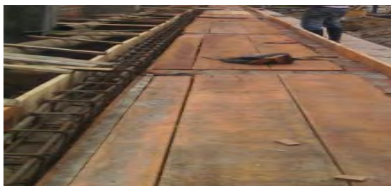
Imagen 120 Formaletado de vigas aéreas para graderías.
