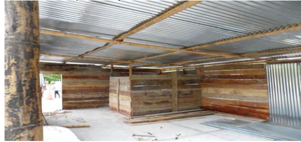
Imagen 9 Campamento finalizado en polideportivo cubierto.
