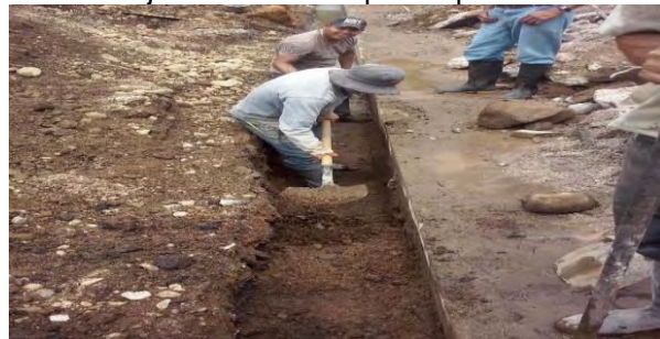
Imagen 39 Excavación para vigas en Mejoramiento de polideportivo.
