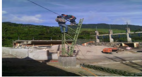
Imagen 105 Columna metálica pernada sobre base columna en concreto.
