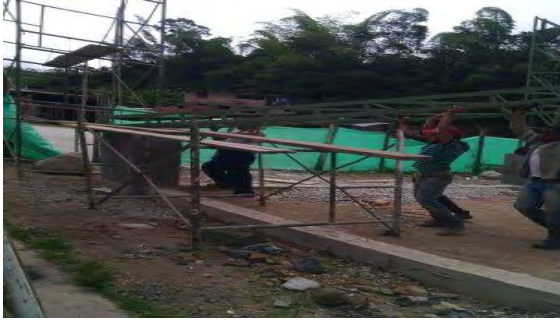
Imagen 104 Montaje de columnas en estructura metálica.
