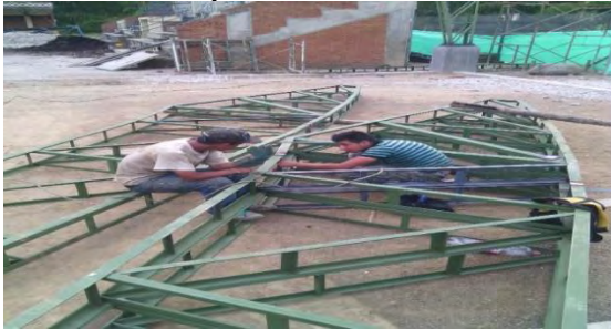
Imagen 106 Cercha metálica lista para montaje sobre columnas.
