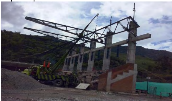
Imagen 22 Desmonte de cerchas principales de estructura de cubierta.
