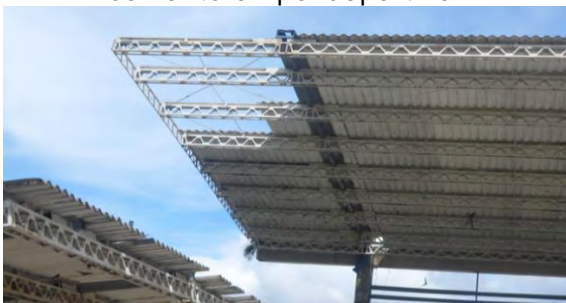
Imagen 10 Desmonte teja de asbesto cemento en polideportivo.
