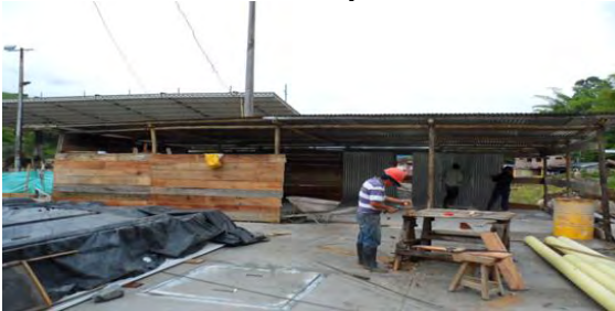
Imagen 8 Construcción de campamento en madera y zinc.
