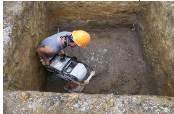
Imagen 43 Compactación de material de recebo cemento en zona de zapatas.
