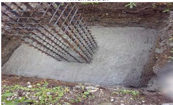
Imagen 62 Zapata en concreto finalizada.
