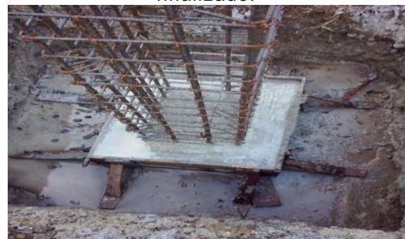
Imagen 63 Pedestal sobre zapata finalizado.
