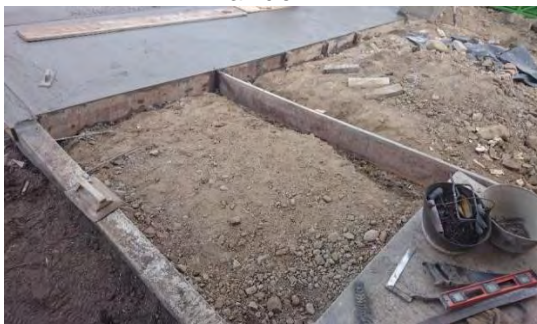
Imagen 78 Base en recebo para compactación y posterior fundición de andén.
