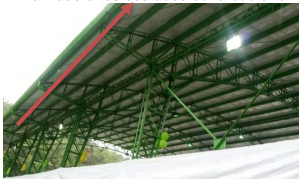
Imagen 115 Canal en lámina instalado y finalizado a los costados de la cubierta.
