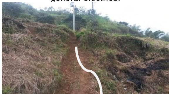
Imagen 88 Instalación de acometida general eléctrica.
