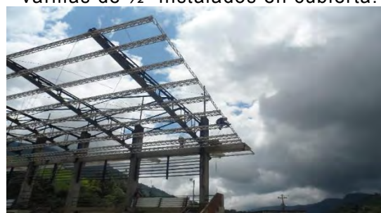
Imagen 15 Desmonte de tensores en varillas de \frac{1}{2} " instalados en cubierta.
