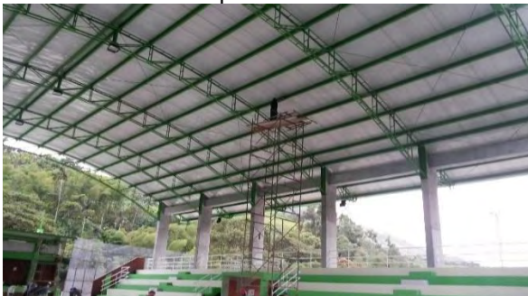
Imagen 112 Cubierta metálica tipo sin traslapo finalizada.
