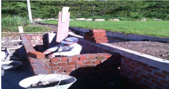
Imagen 118 Pega de ladrillo para graderías.
