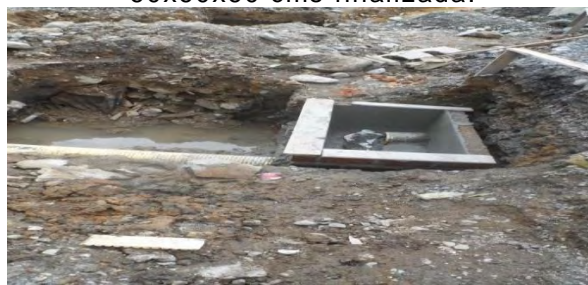
Imagen 81 Caja de inspección de 60x60x60 cms finalizada.
