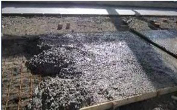
Imagen 76 Concreto para piso en concreto en cancha sintética.
