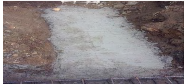
Imagen 59 Solado para viga de cimentación finalizado.
