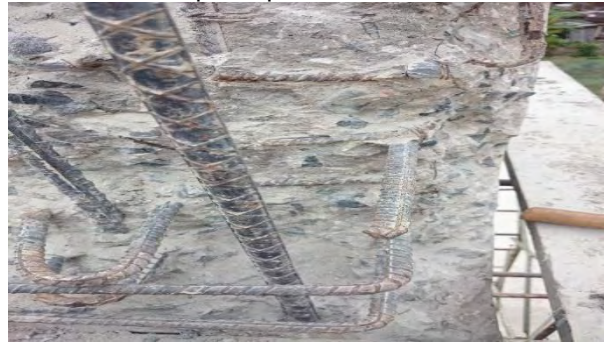
Imagen 31 Demolición de base de columna para posterior desmorte.
