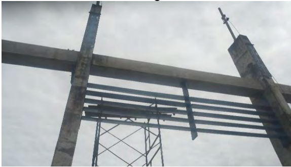
Imagen 28 Desmonte de celosías en lámina de longitud 3 mts.
