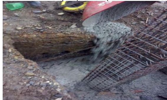
Imagen 61 Disposición de concreto de 3000 psi para zapatas.
