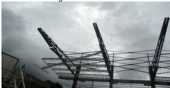
Imagen 18 Desmote de correas en ángulos metálicos.
