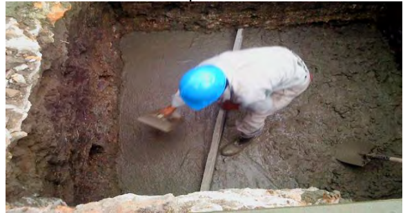
Imagen 57 Nivelación de solado de limpieza.
