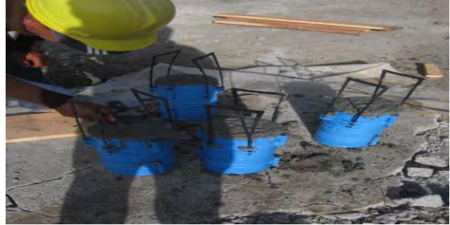
Imagen 130 Cilindros de concreto según NTC 550.
