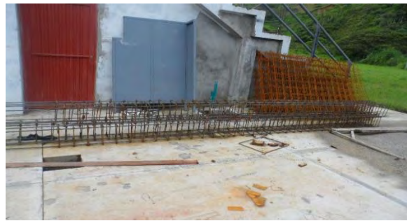
Imagen 55 Acero armado para vigas de cimentación.
