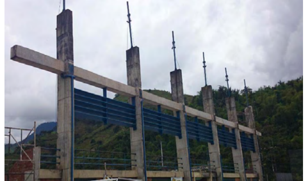
Imagen 27 Cerchas secundarios desmontadas en cubierta metálica.
