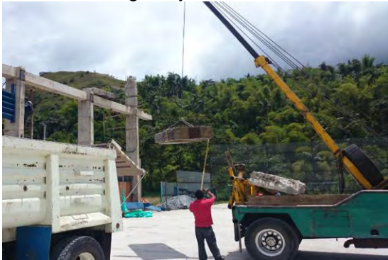
Imagen 32 Desmorte de columnas con grúa y cables.
