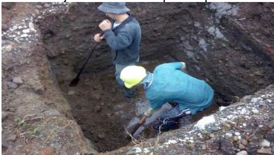
Imagen 38 Excavación para zapatas en Mejoramiento de polideportivo.
