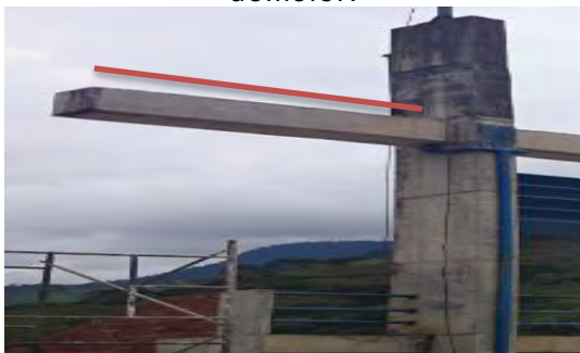
Imagen 34 longitud de viga canal a demoler.
