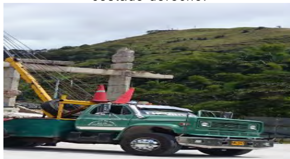
Imagen 35 Demolición de viga canal costado derecho.
