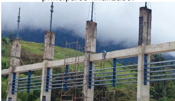
Imagen 24 Desmonte de cerchas principales finalizado.
