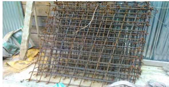
Imagen 53 Parillas de acero para zapatas finalizadas.
