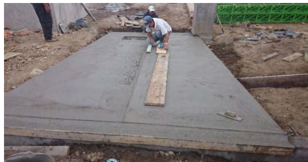
Imagen 79 Nivelación repello y acabado de andén.
