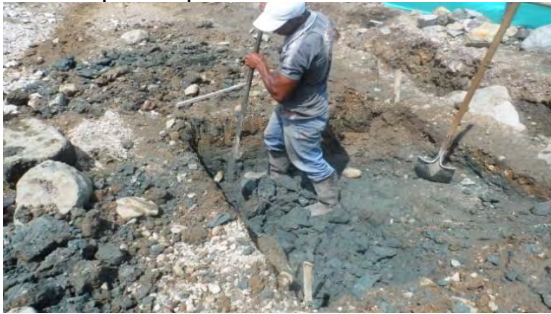
Imagen 36 Excavación y perfilado de zapatas para cancha sintética.
