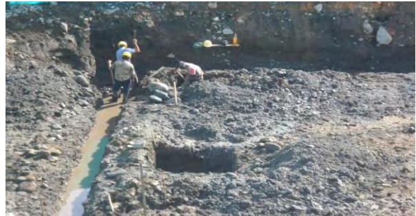
Imagen 37 Excavación para filtros para cancha sintética.
