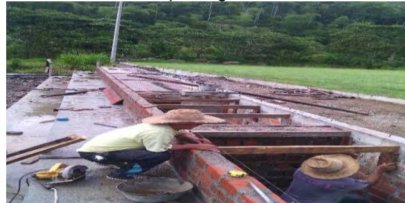
Imagen 119 Finalización de pega de ladrillo para graderías.
