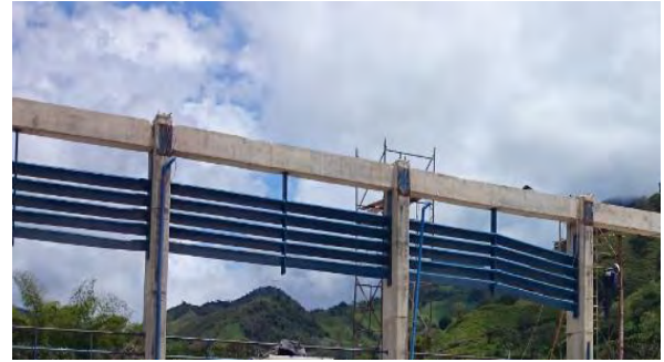
Imagen 29 Desmonte de celosías en lámina metálica.
