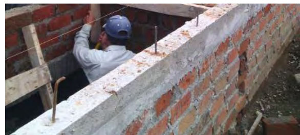
Imagen 121 Vigas aéreas en graderías finalizadas.
