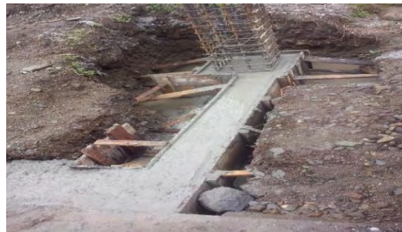
Imagen 67 Viga de cimentación finalizada.
