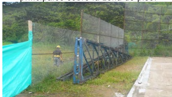
Imagen 25 Disposición de cerchas principales sobre la zona de piso.
