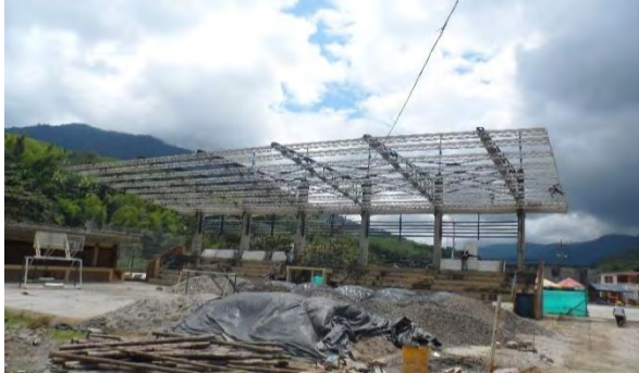
Imagen 12 Desmonte de tejas en asbesto cemento finalizado.
