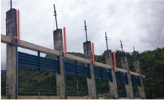
Imagen 30 longitud de columna a demoler.
