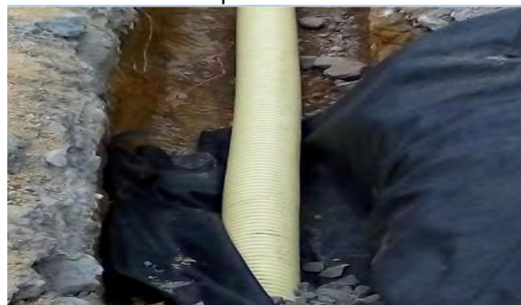
Imagen 49 Tubería perforada de 4" con tela tipo Geotextil.
