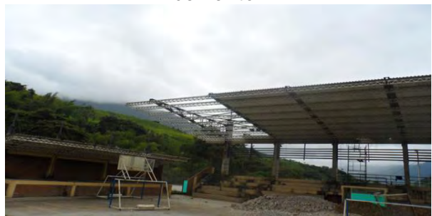
Imagen 11 Desmonte de tejas en asbesto cemento.
