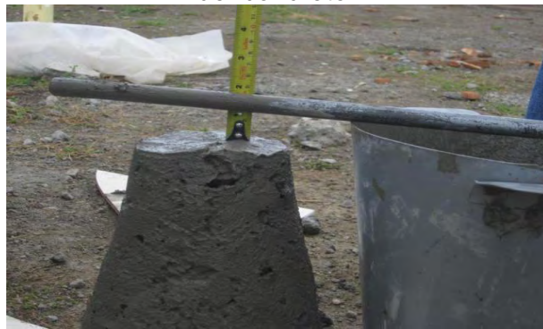
Imagen 132 Medición de la consistencia del concreto.
