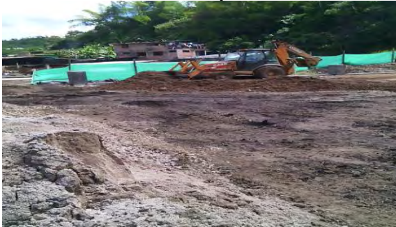
Imagen 40 Cargue de material para desalojo.
