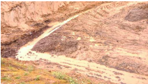
Imagen 48 Agua superficiales a recoger.
