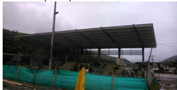
Imagen 7 Cerramiento con polisombra en polideportivo cubierto.
