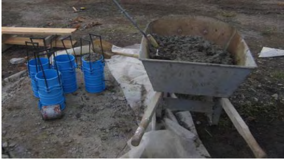
Imagen 129 Muestra para toma de cilindros de concreto
