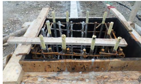
Imagen 71 Instalación de pernos en columna para acople de estructura metálica.
