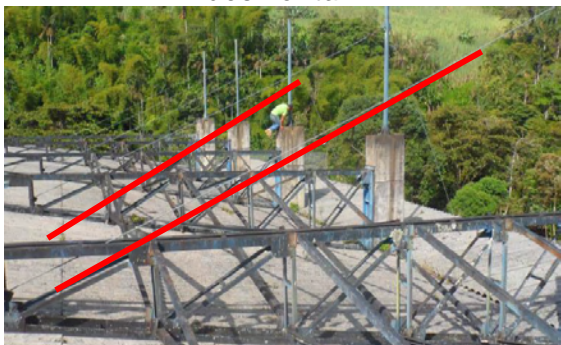
Imagen 20 Cables tensores a desmontar.
