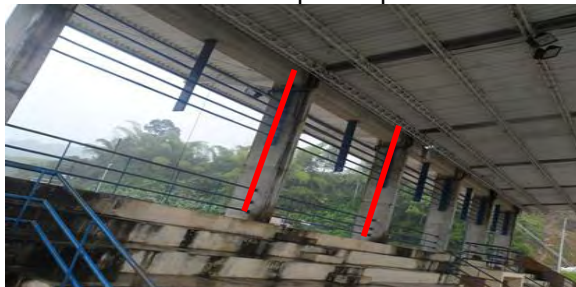
Imagen 4 Ubicación de ejes en columnas existentes de polideportivo.
