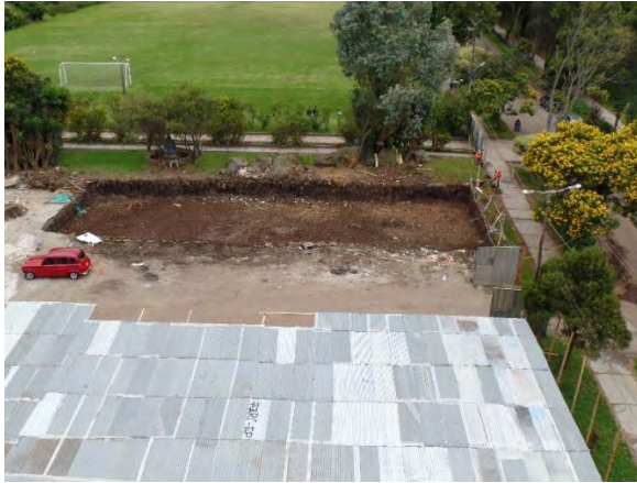
Ilustración 5. Estado inicial de excavación
