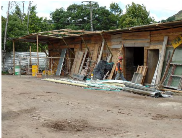
Ilustración 15. Armado de puertas
