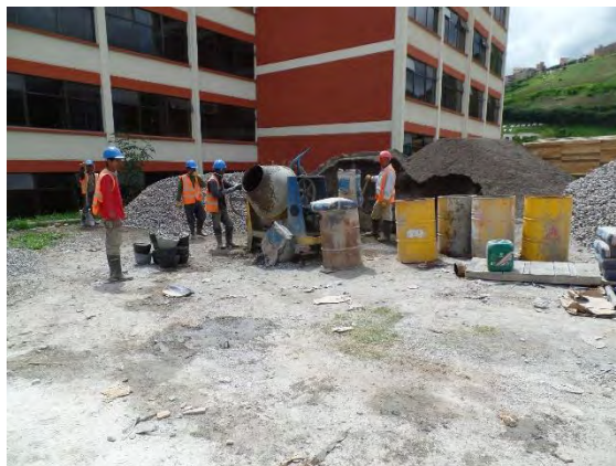
Ilustración 42. Elaboración de concreto
