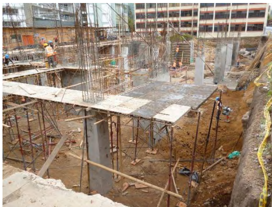
Ilustración 37. Encamillado de vigas
