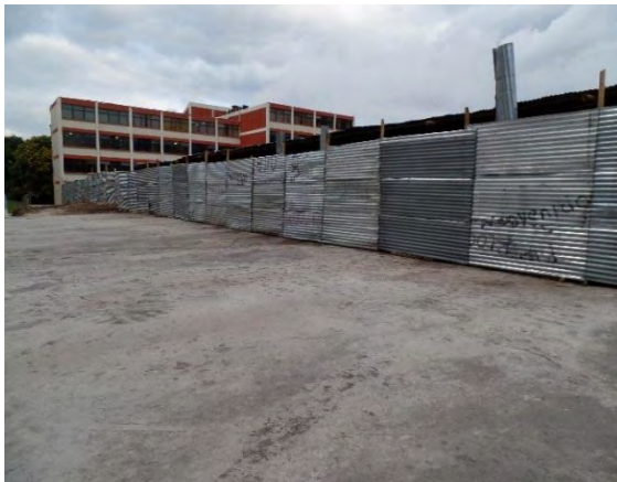
Ilustración 7. Cierre en lámina de zinc
