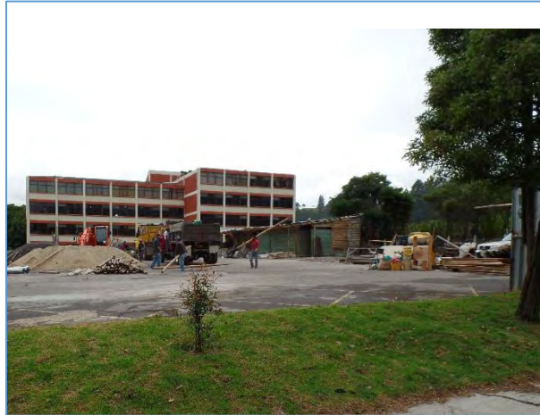
Ilustración 18. Desmonte de campamento
