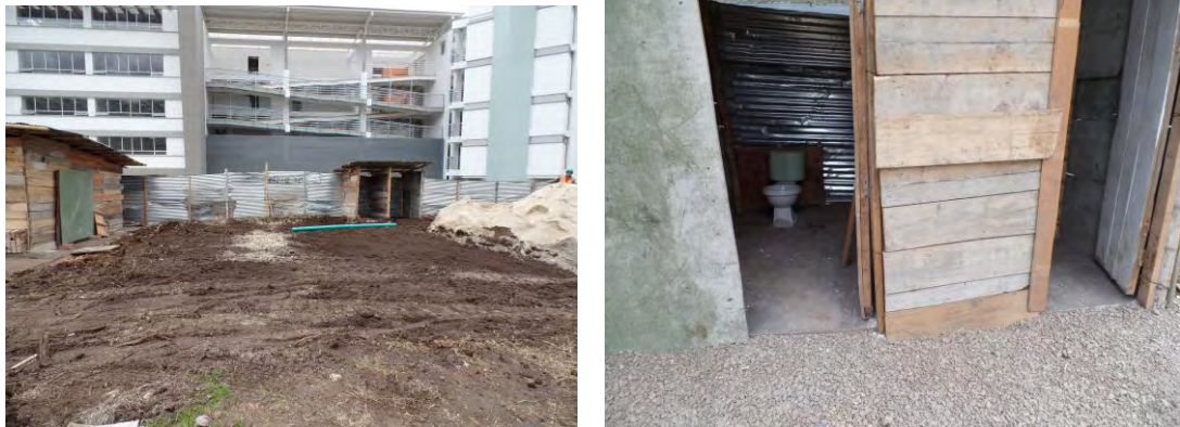
Ilustración 16. Construcción de baterías sanitarias
