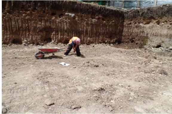
Ilustración 23. Demarcación de zapatas
