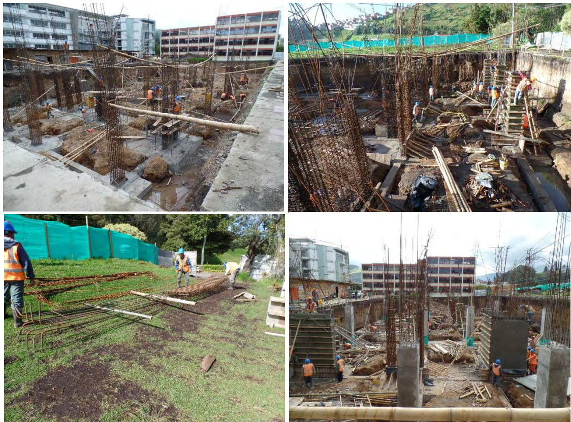
Ilustración 34. Armado de columnas y pantallas
