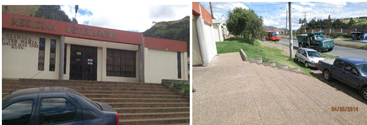
Ilustración 22. Acopio de material de rampa
