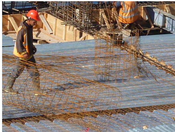
Ilustración 40. Colocación de malla electrosoldada
