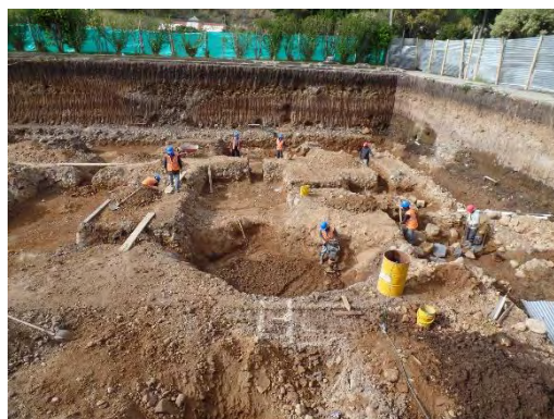
Ilustración 26. Relleno y compactación
