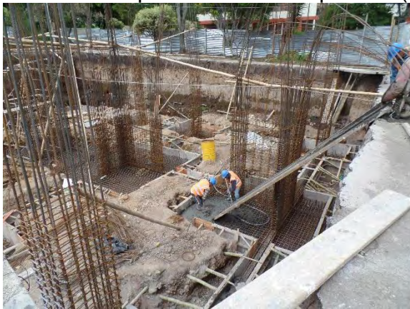
Ilustración 31. Fundición de zapatas
