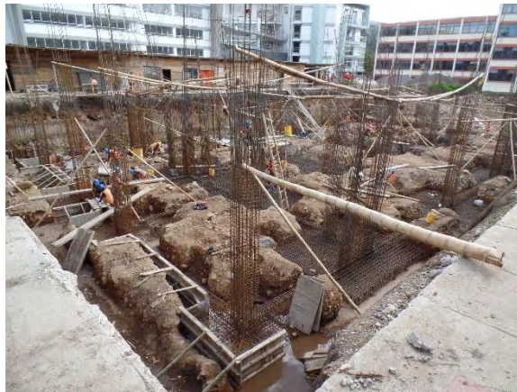
Ilustración 30. Formaleta de cimentación
