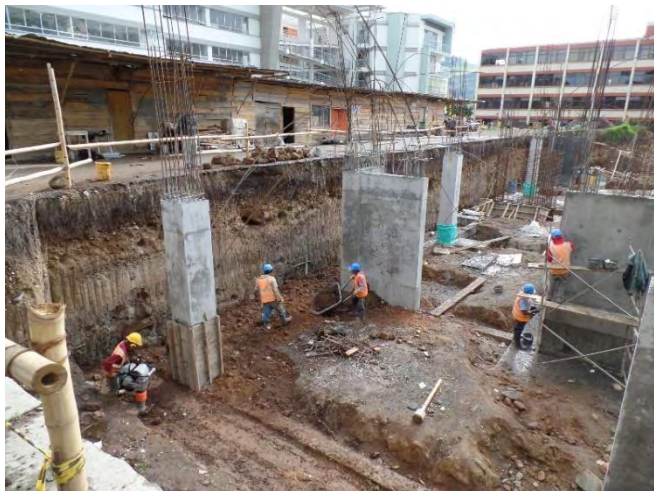
Ilustración 33. Relleno con material de sitio
