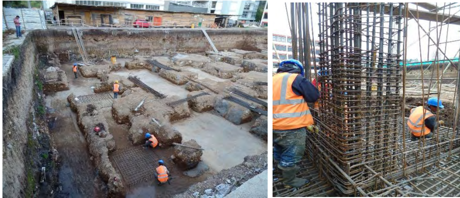
Ilustración 29. Armado de zapatas
