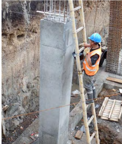
Ilustración 36. Curado de concreto
