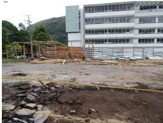
Ilustración 20. Demolición carpeta asfáltica
