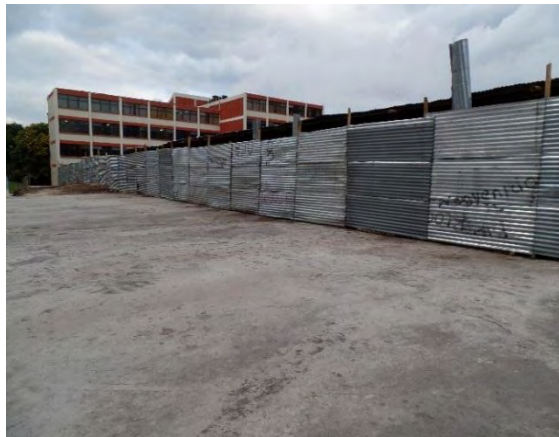
Ilustración 14. Cierre en lámina de zinc
