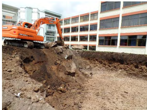
Ilustración 9. Estado de excavación
