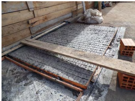
Ilustración 28. Elaboración de separadores en concreto
