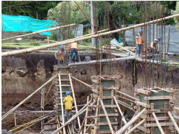
Ilustración 35. Fundición de columnas
