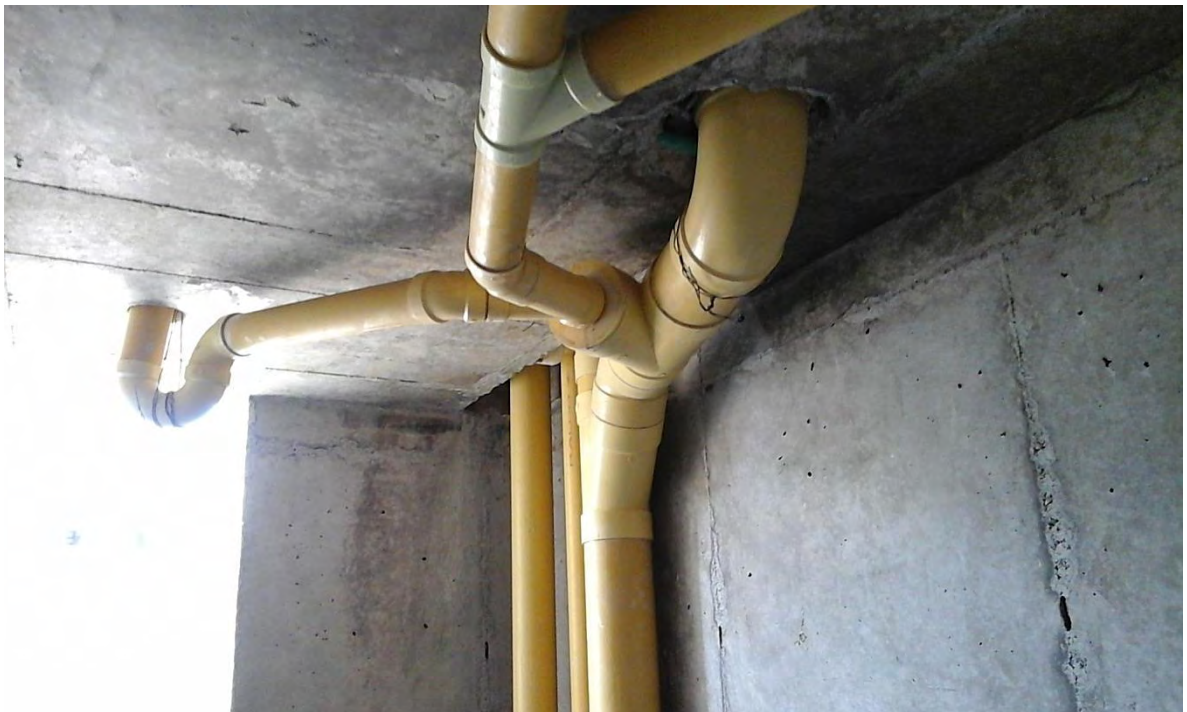
Figura 10. RED SANITARIA BAÑO TIPO
