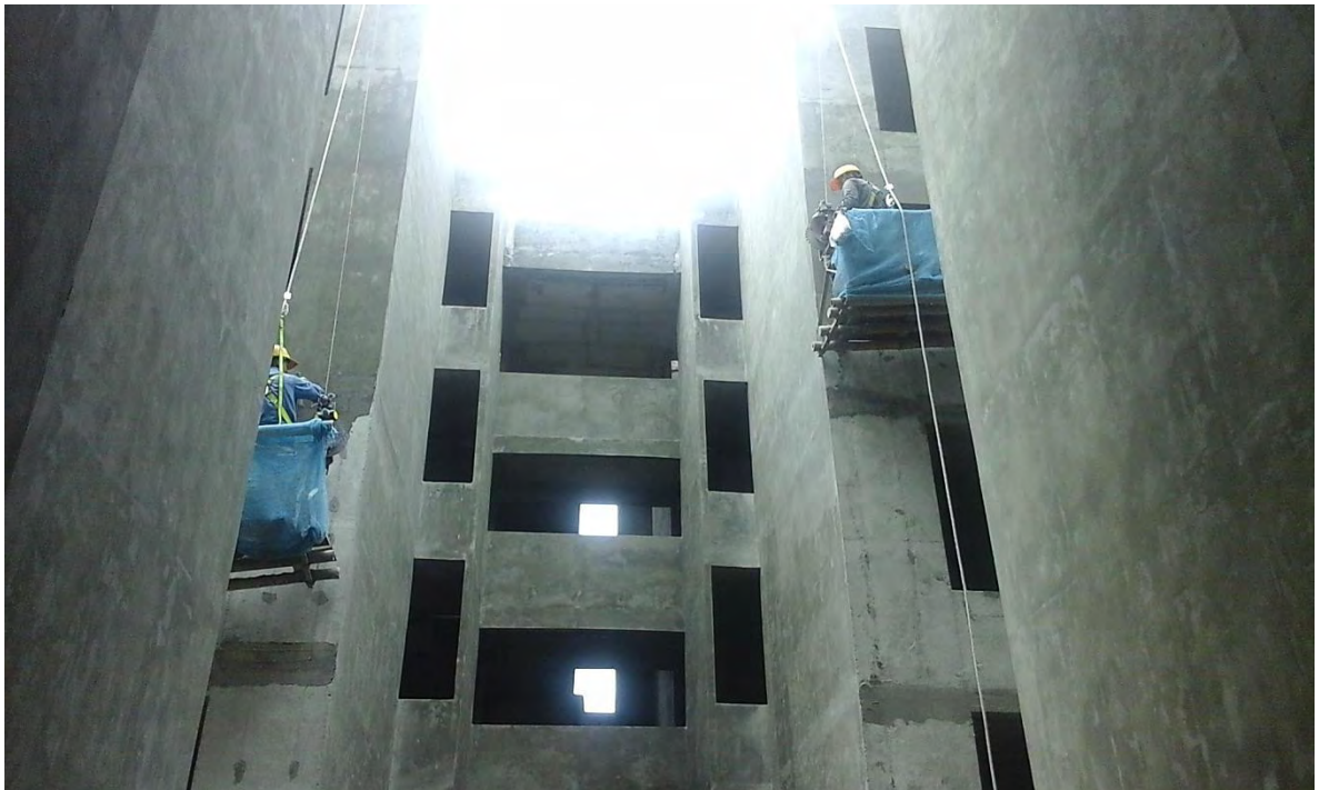
Figura 13. RESANE MUROS EXTERIORES
