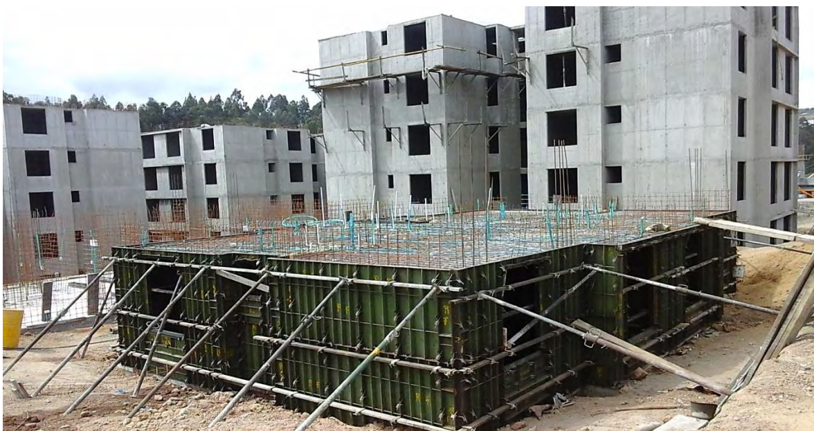
Figura 9. FORMAleta ESTRUCTURA TORRE 17
