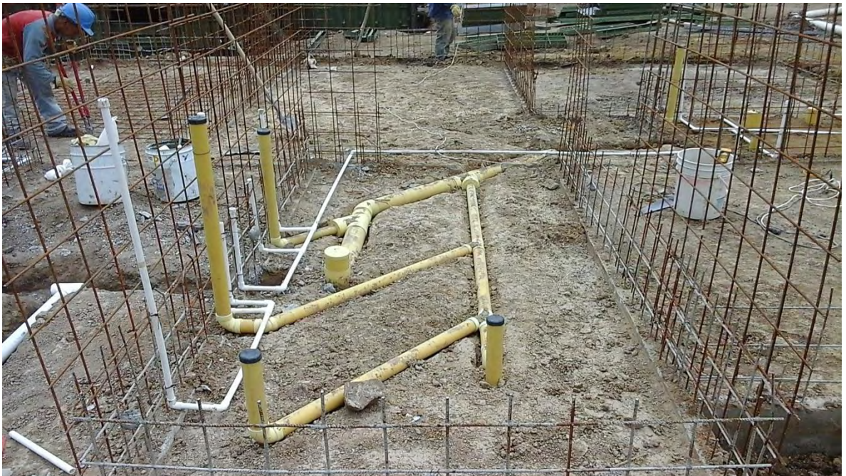
Figura 12. INSTALACIONES HIDROSANITARIAS COCINA TIPO
