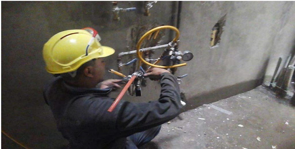
Figura 38. PRUEBAS DE HERMETICIDAD REDES DE GAS INTERNAS
