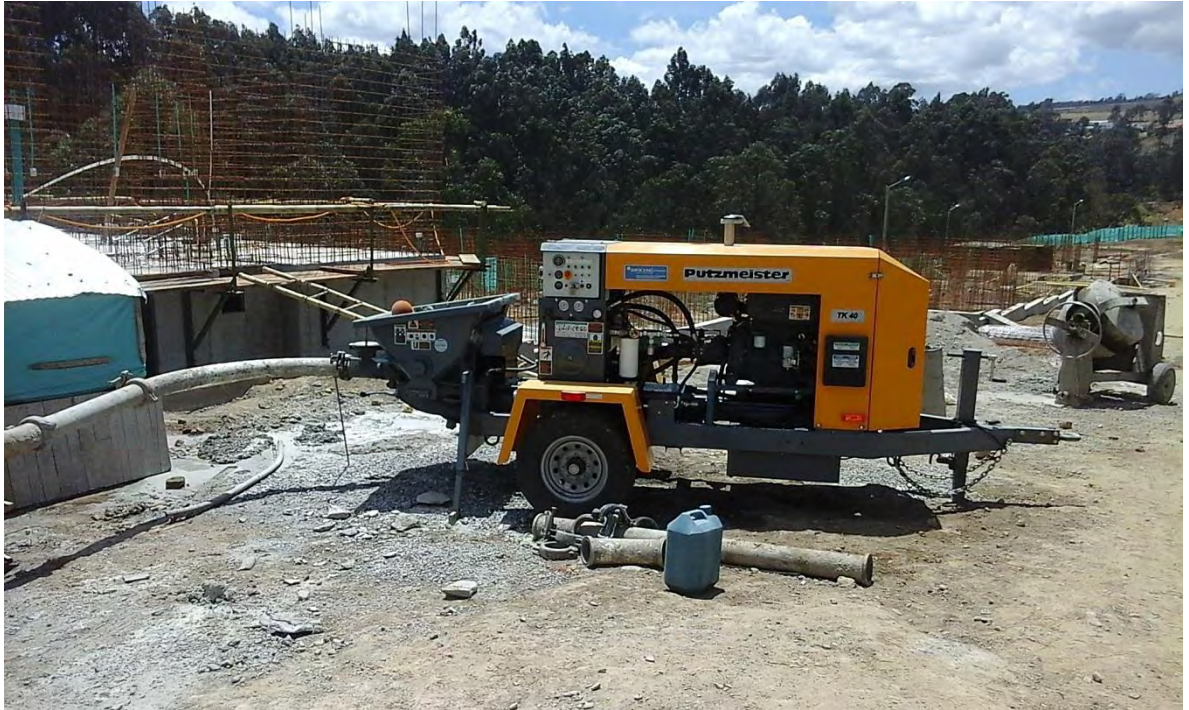
Figura 40. BOMBA DE CONCRETO
