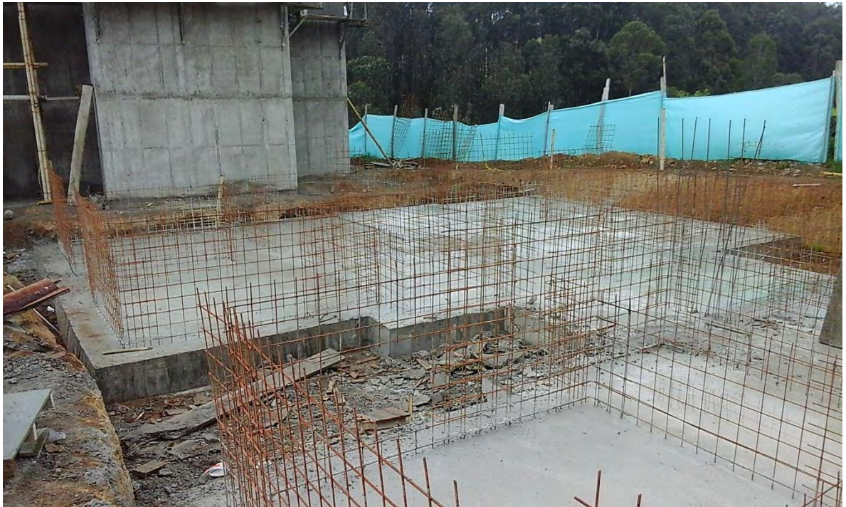
Figura 7. LOSA DE CIMENTACION TIPO 2
