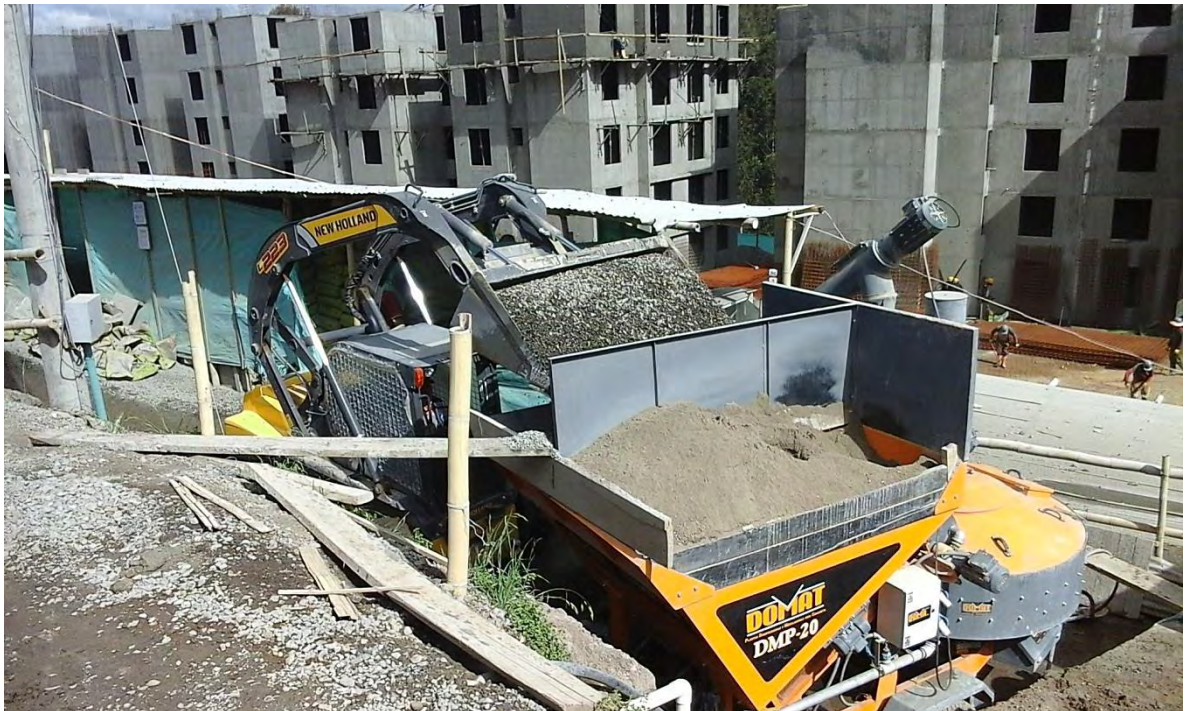
Figura 39. PLANTA DOSIFICADORA DE CONCRETO
