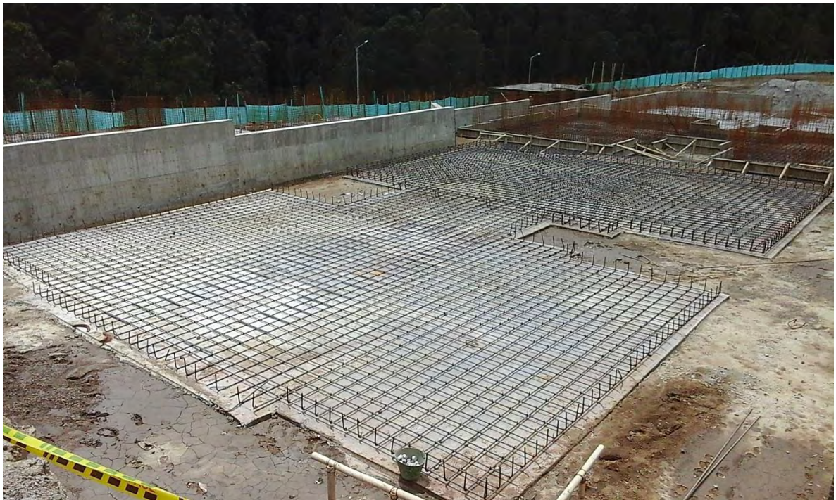
Figura 6. LOSA DE CIMENTACION TIPO 1
