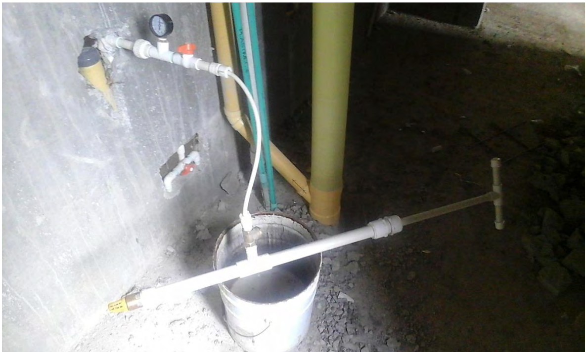
Figura 27. PRUEBA DE PRESION APT 103 TORRE 2
