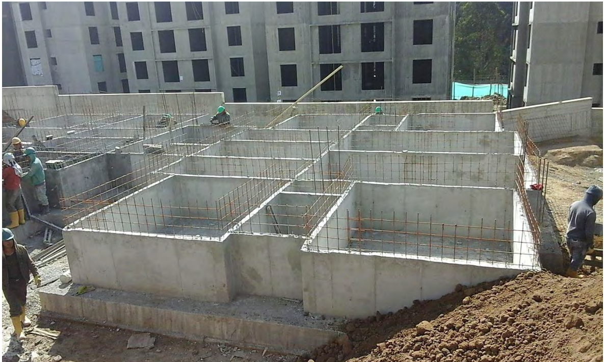
Figura 22. LOSA DE CIMENTACION CON MUROS DE ARRANQUE
