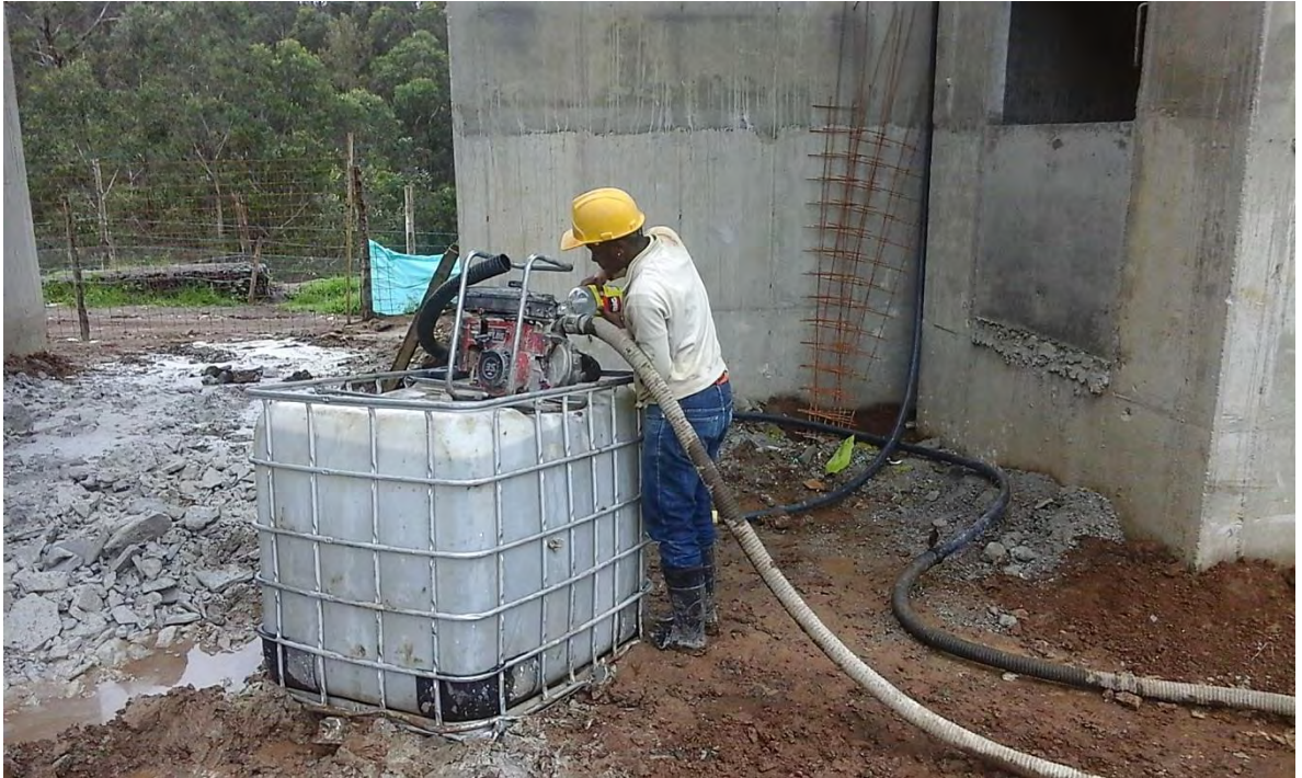
Figura 32. LLENADO SISTEMA SANITARIO TORRE 7
