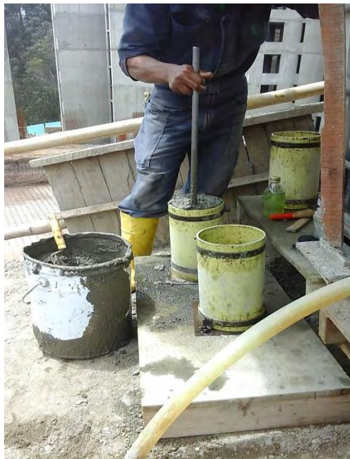
Figura 21. TOMA DE MUESTRAS DE CONCRETO
