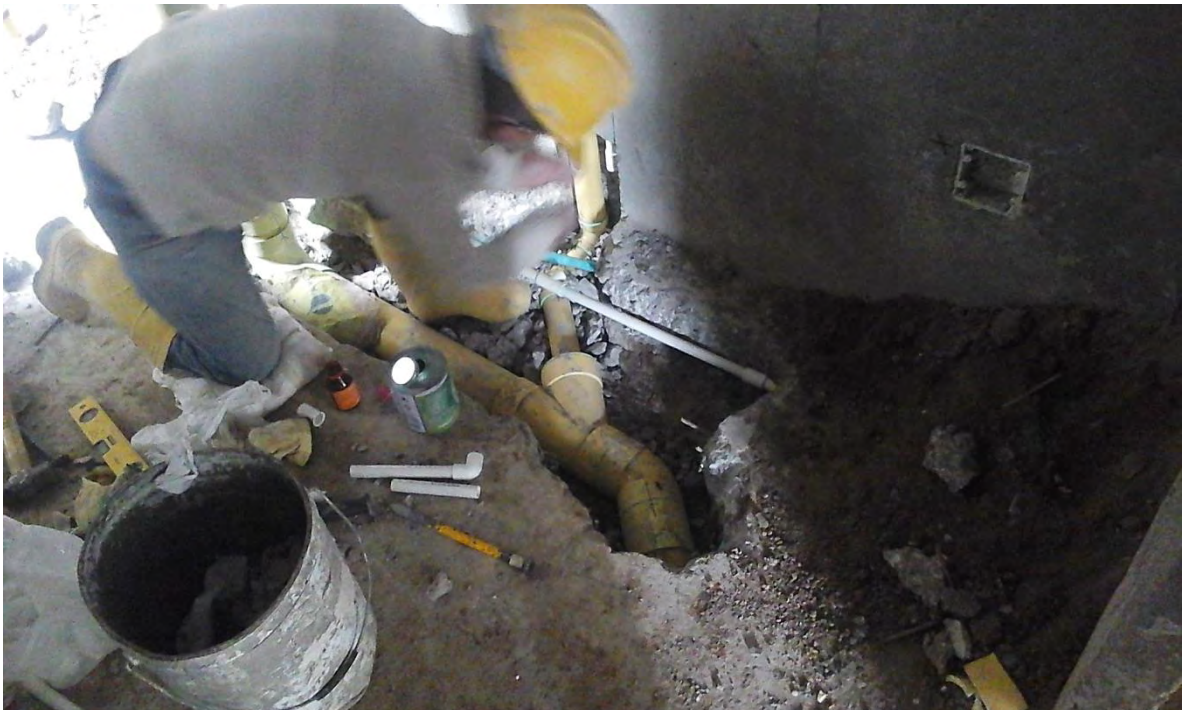
Figura 33. REPARACION SISTEMA SANIATARIO APT 101 TORRE 5
