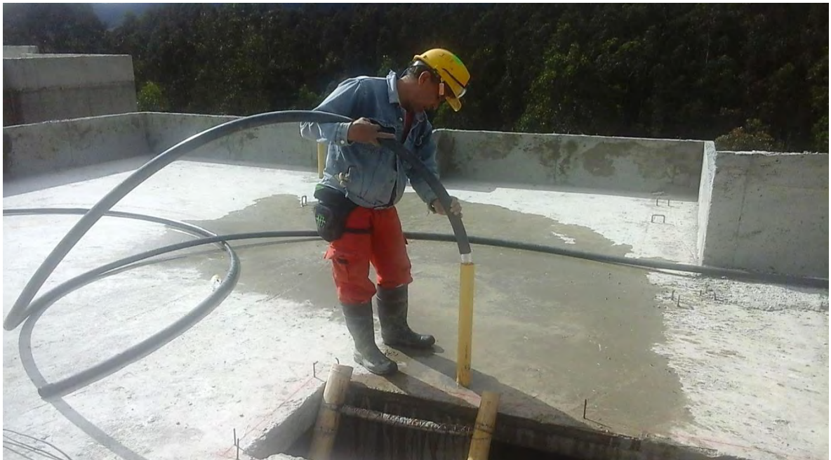
Figura 31. LLENADO SISTEMA SANITARIO (COCINA 103-503) TORRE 5
