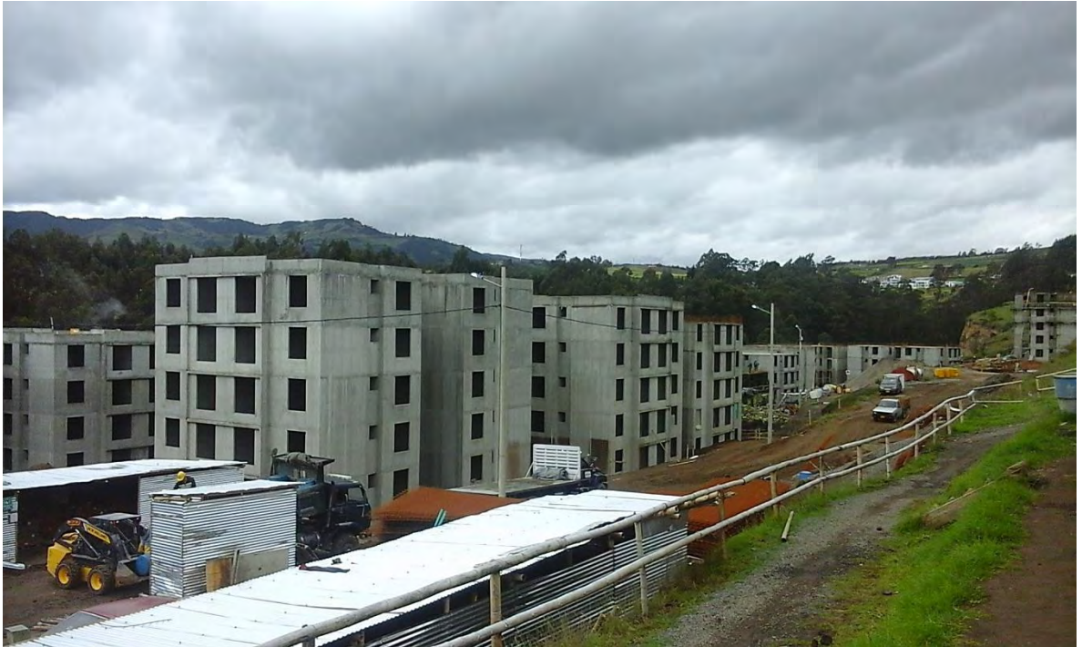
Figura 46. ESTADO ACTUAL DEL PROYECTO
