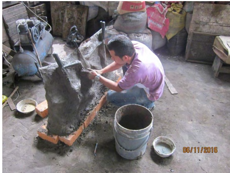
Foto 30. Proceso de recubrimiento con material refractario.
