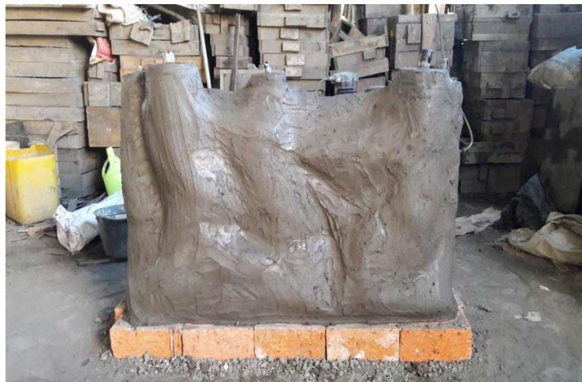
Foto 31. Molde totalmente recubierto
