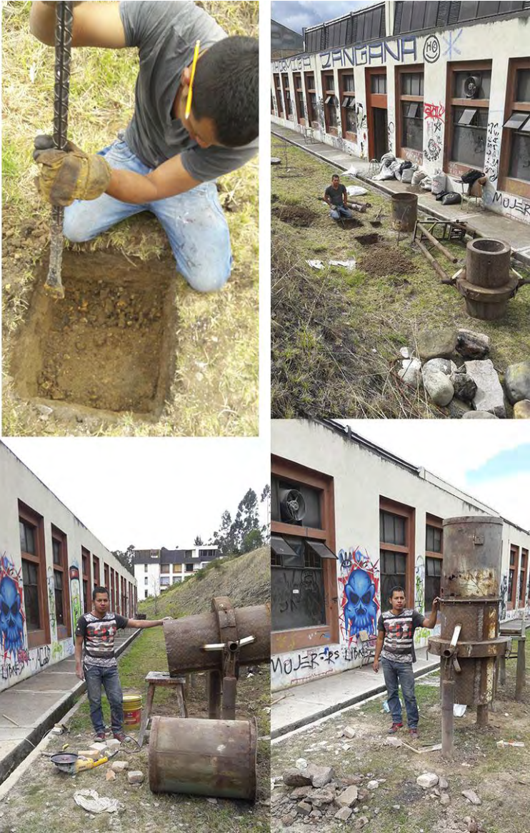
Foto 49. Instalación del horno de fundición hierro gris.
