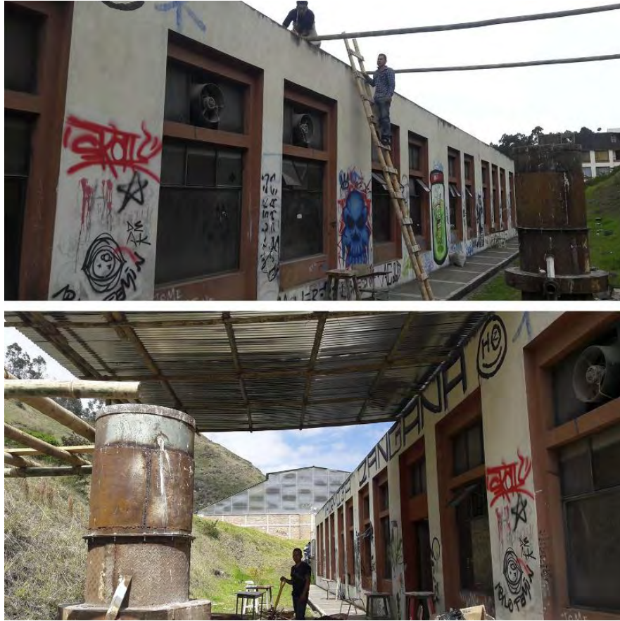
Foto 50. Adecuación del espacio para la fundición.
