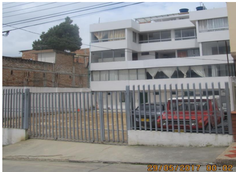
Imagen 6. Edificio de apartamentos y parqueadero Cr 20ª Cl 9 barrió Villa Lucia.
