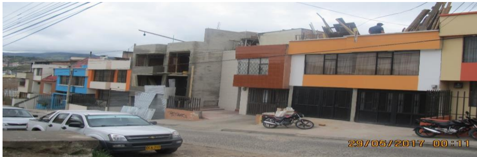
Imagen 4. Fachada de casas Cr. 21ª Cl. 8 barrió Villa Lucia.
