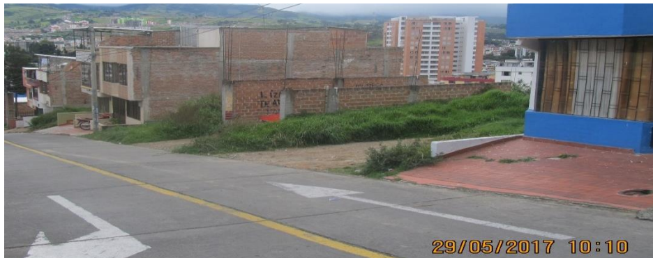
Imagen 7. Lotes, viviendas y estructura en obra negra Cr 20b CI 8 barrió Villa Lucia.
