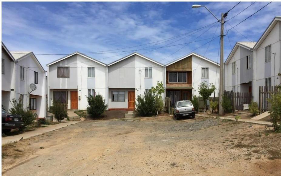
Ilustración 8: Fase final ampliación - Proyecto Villa Verde - Fuente: https://www.archdaily.co/co/02-309072/villa-verde-elemental .
