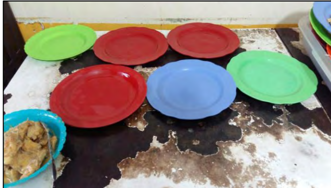
Imagen 3. Superficies de la cocina en mal estado.
