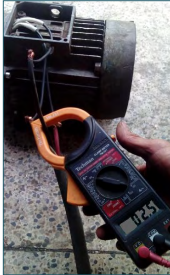
Figura 66. Corriente de línea del motor reparado.
