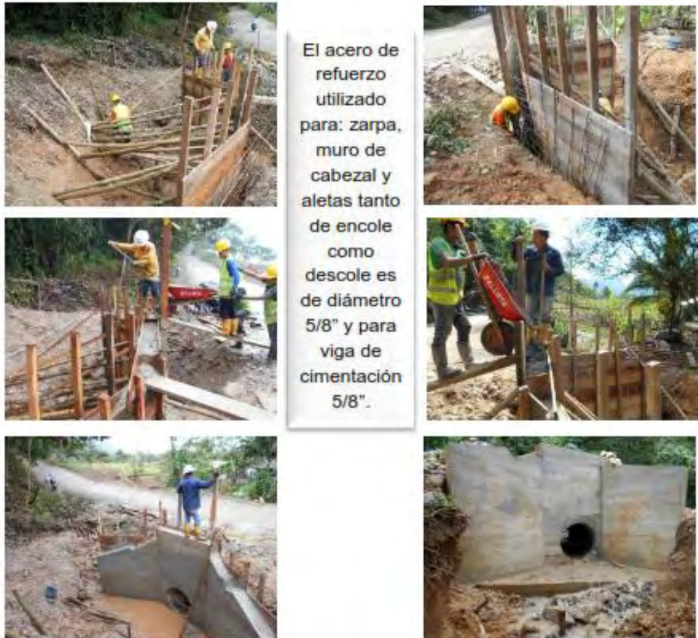
Ilustración 47. Formaleteo y fundido de concreto de resistencia a la compresión
