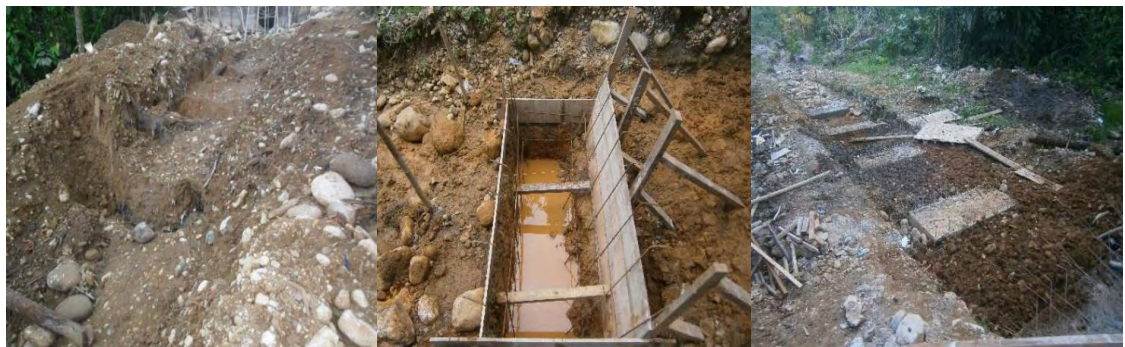
Ilustración 31. Espolones de disipador canal rap. pantallas deflectoras
