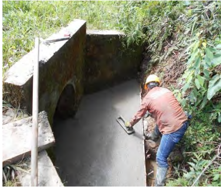
Ilustración 56. Alcantarilla de encole N°7
