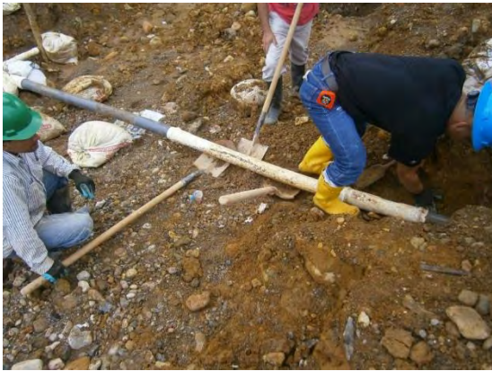
Ilustración 16. Reparación acometida de acueducto
