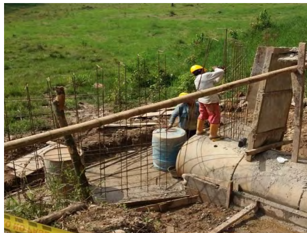
Ilustración 65. Construcción de alcantarilla de descole N°4
