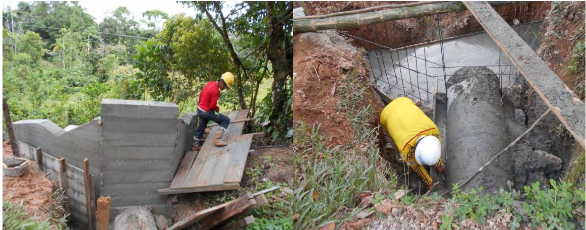
Ilustración 71. Proceso constructivo alcantarilla de descole N°3
