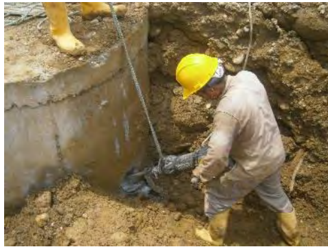
Ilustración 12. Abertura con taladro mecánico
