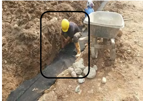
Ilustración 78. Instalación de material granular para drenes
