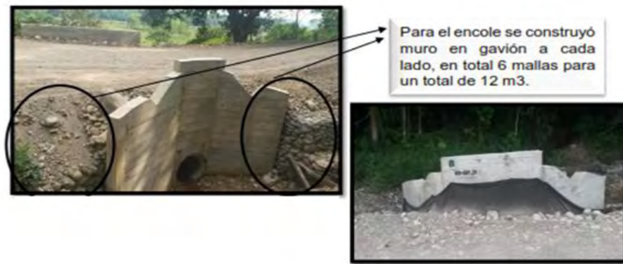
Ilustración 54. Alcantarilla N°8 encole
