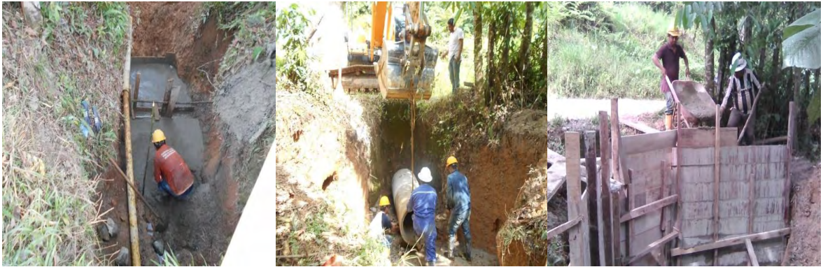
Ilustración 75. Proceso constructivo alcantarilla N°1
