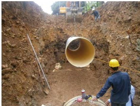
Ilustración 8. Instalación de tubería RIB STEEL 51”
