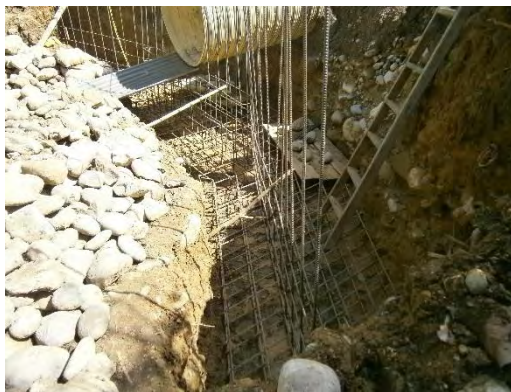
Ilustración 24. Acero de refuerzo cabezal
