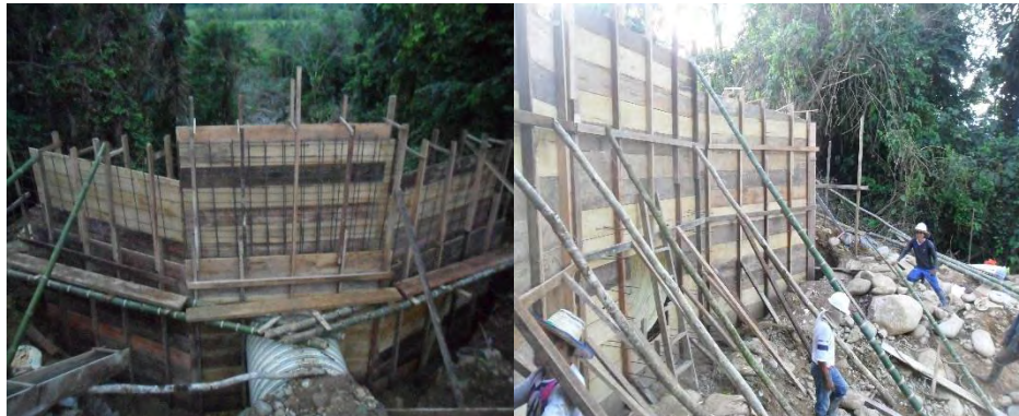
Ilustración 28. Formaleta de muro cabezal y aletas
