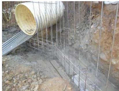
Ilustración 23. Acero de refuerzo cabezal
