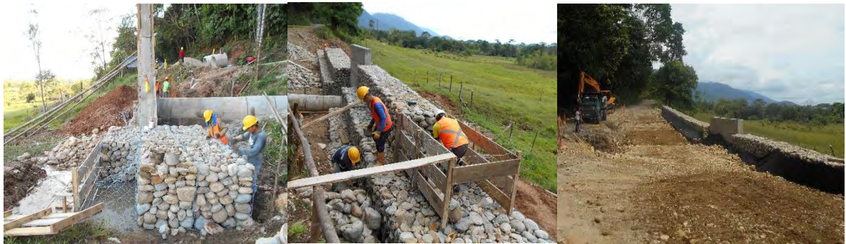
Ilustración 52. Construcción de muro en gavión para muro cabezal de decole alcantarilla N°8
