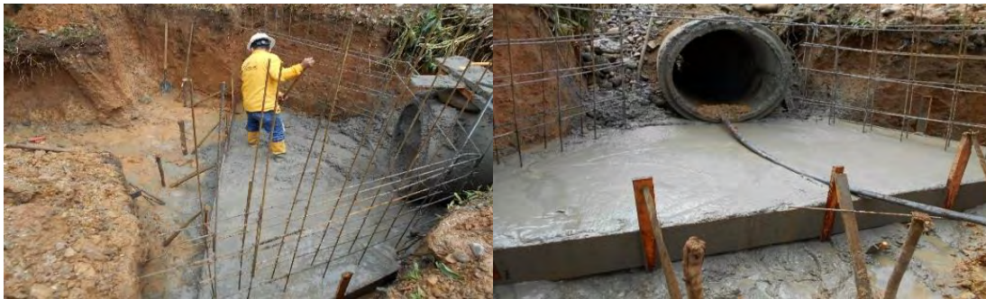
Ilustración 46. Concreto de zarpa de alcantarilla
