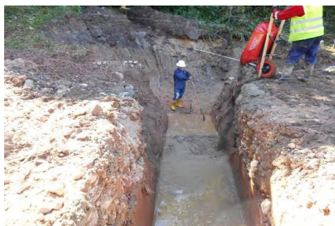
Ilustración 43. Instalación de concreto para solado
