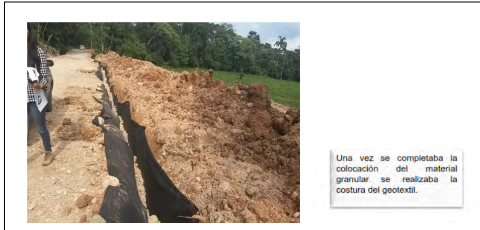
Ilustración 79. Instalación de drenes
