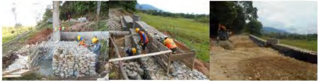
Ilustración 53. Proceso constructivo alcantarilla de encole
