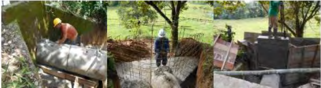
Ilustración 69. Proceso constructivo alcantarilla de descole N°5
