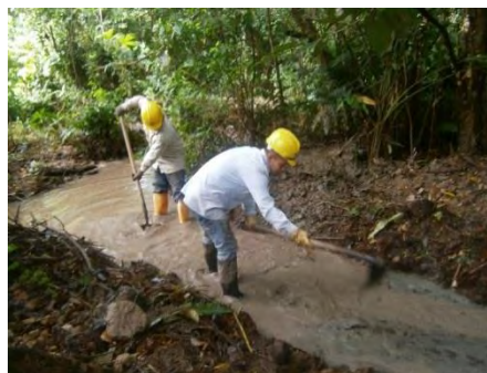
Ilustración 6. Descolmatación de canal de desagüe
