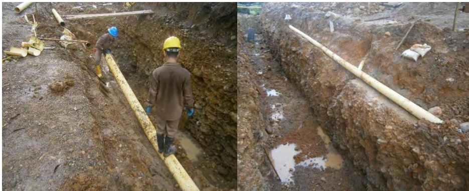
Ilustración 21. Reposición de tubería sanitaria D=8"
