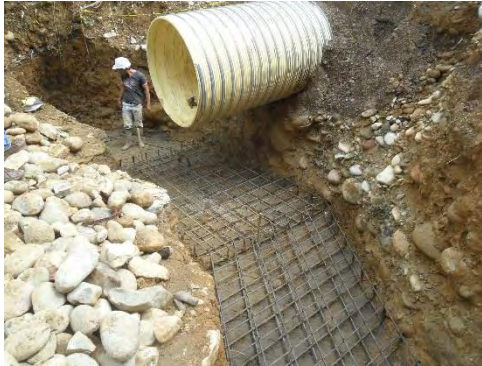
Ilustración 22. Acero de refuerzo de zapata
