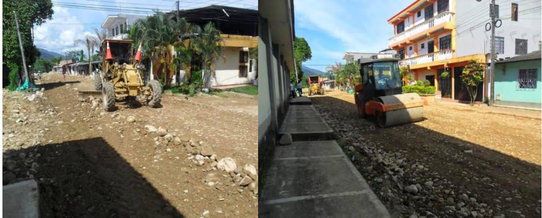
Ilustración 35. Nivelación y compactación de material para rehabilitación de la carrera N°9
