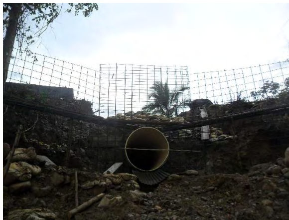
Ilustración 26. Acero de refuerzo de muro cabezal y aletas
