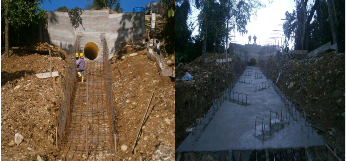
Ilustración 32. Instalación de acero de refuerzo y fundición de concreto para placa de dissipador canal rap. pantallas deflectoras
