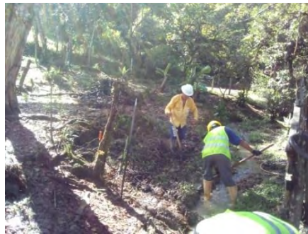
Ilustración 42. Excavación manual de zona de descole
