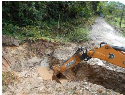
Ilustración 41. Excavación mecánica para instalación de tubería
