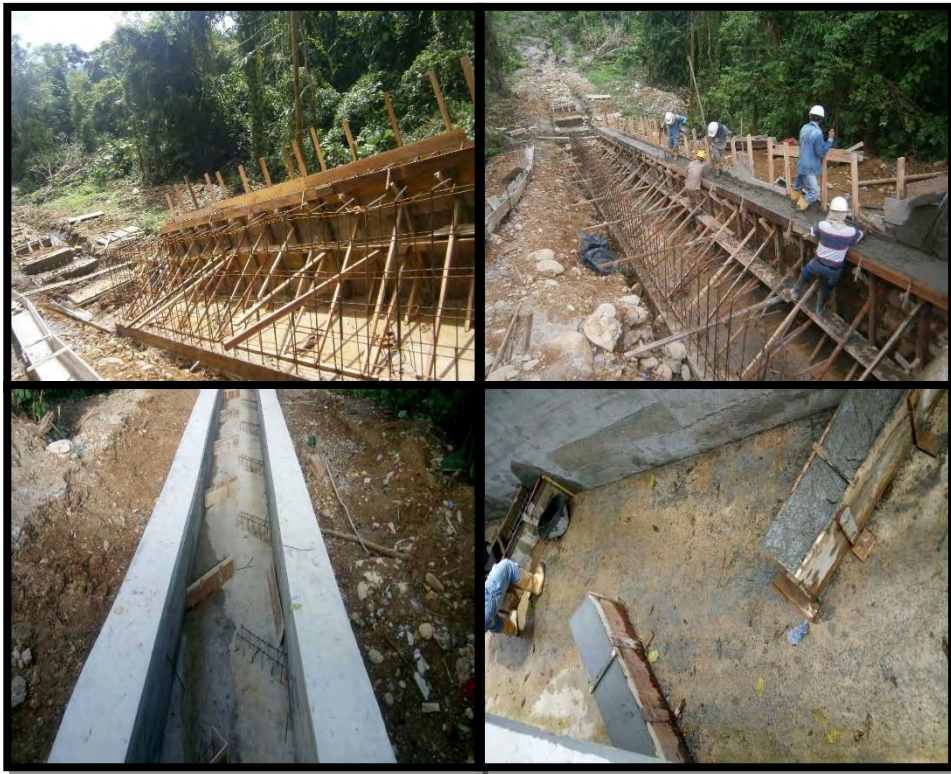
Ilustración 33. Fundición de concreto para paredes de disipador canal rap. pantallas deflectoras
