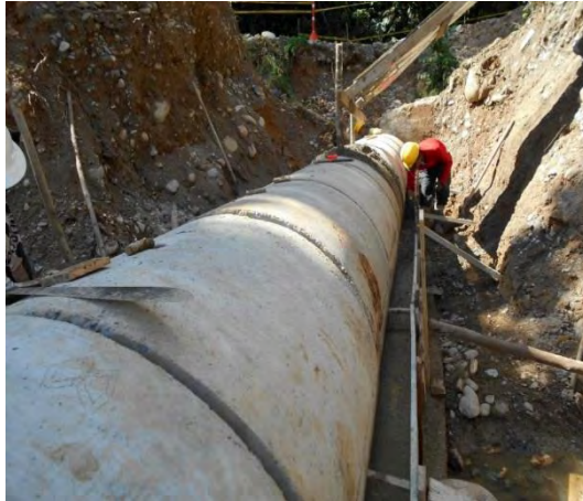
Ilustración 59. Tubería de 900mm
