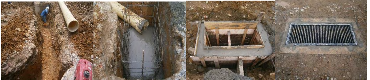
Ilustración 14. Proceso constructivo de sumidero
