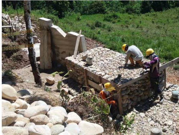
Ilustración 66. Construcción de muro en gavión alcantarilla de descole N°4
