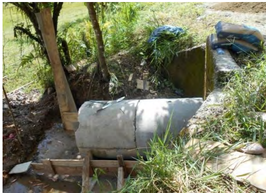
Ilustración 57. Tubería de 900mm
