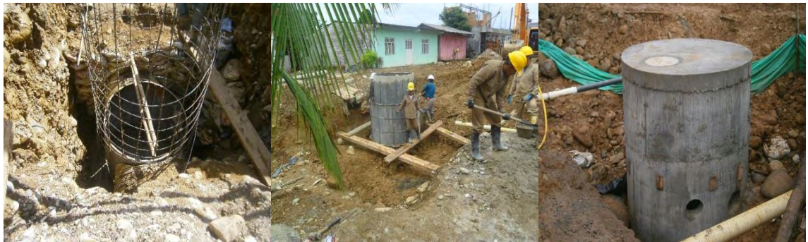
Ilustración 11. Cámara de inspección
