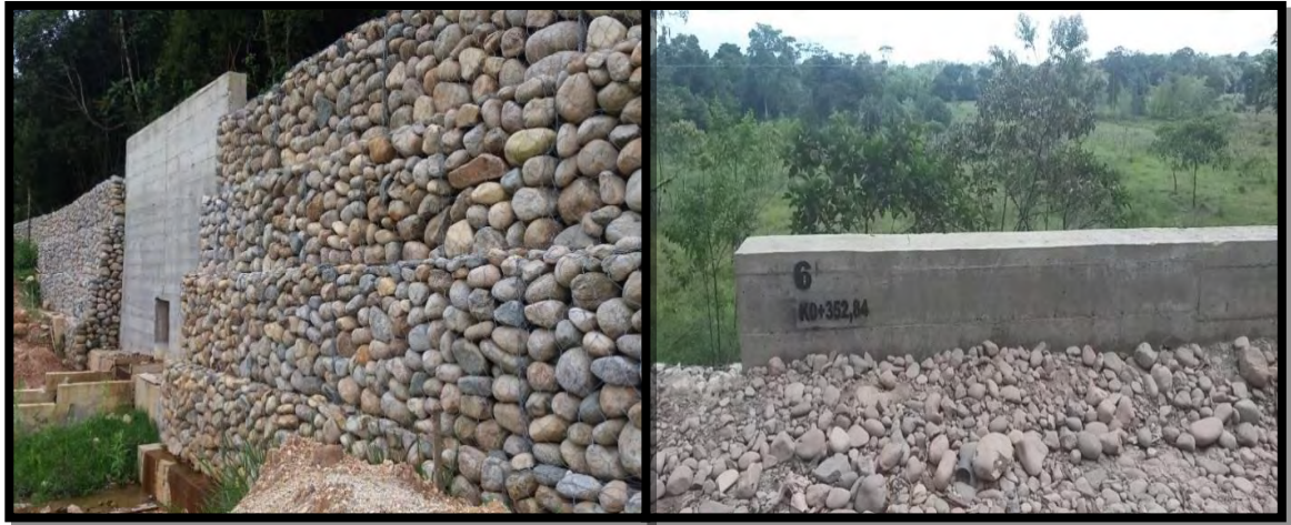
Ilustración 61. Muro de gavión de alcantarilla de descole N°6
