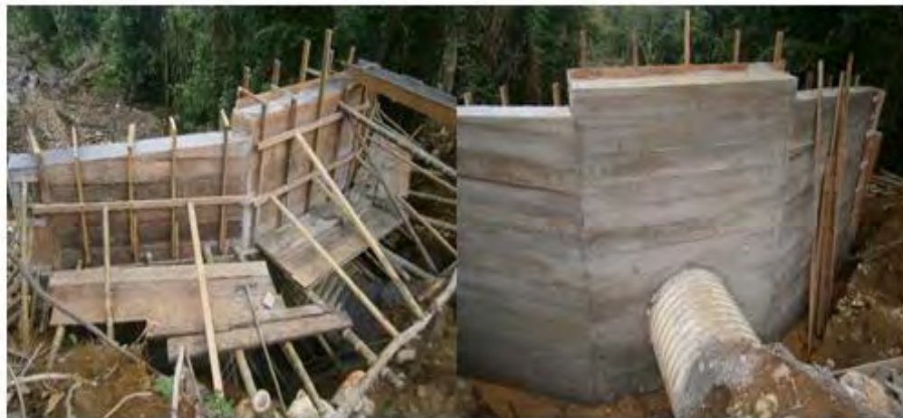
Ilustración 29. Desencofrado de muro cabezal y aletas
