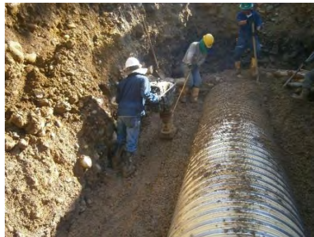
Ilustración 9. Compactación de material de atraque
