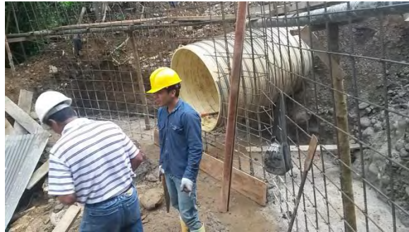
Ilustración 25. Instalación de formaleta en cabezal
