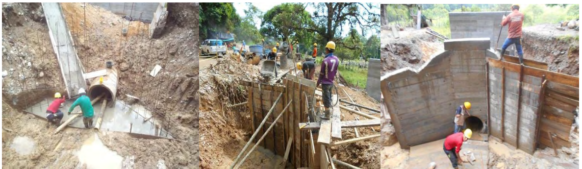
Ilustración 63. Proceso constructivo alcantarilla de encole N°6
