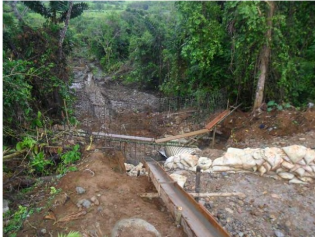
Ilustración 27. Vaciado de concreto para muro cabezal
