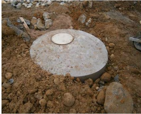
Ilustración 18. Cámara de inspección
