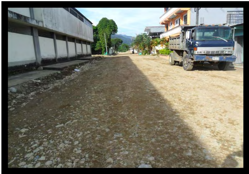
Ilustración 36. Carrera N°9 rehabilitada
