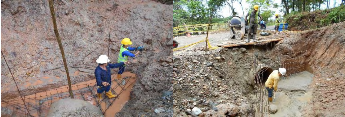
Ilustración 45. Instalación de acero de refuerzo para zarpa de encole
