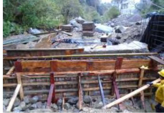
Figura 41. Encofrado canal de recolección
