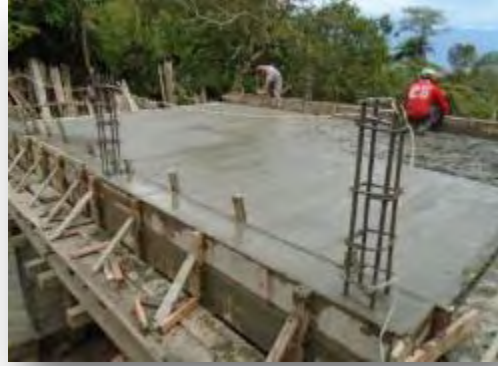
Figura 20. Vertimiento concreto losa
