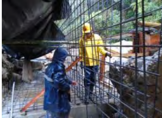
Figura 40. Figurado acero de refuerzo cajilla
