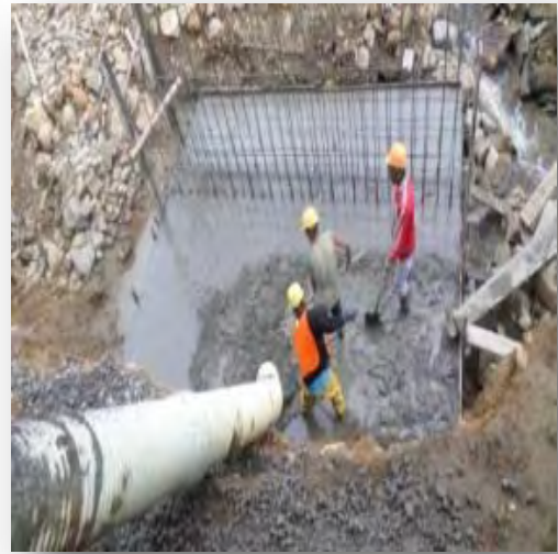
Figura 7. Vertimiento concreto Zarpa estribo
