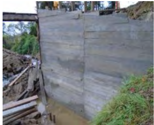
Figura 11. Aleta de estribo finalizada
