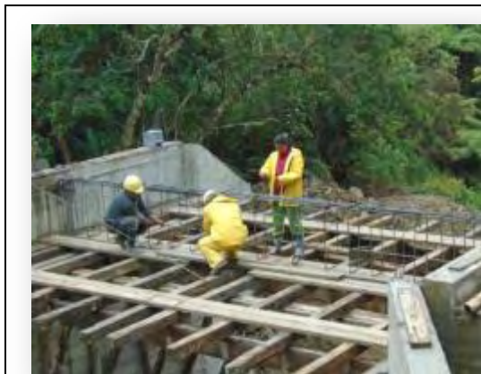
Figura 12. Figurado acero de refuerzo viga
