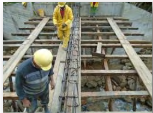
Figura 13. Figurado acero de refuerzo viga central
