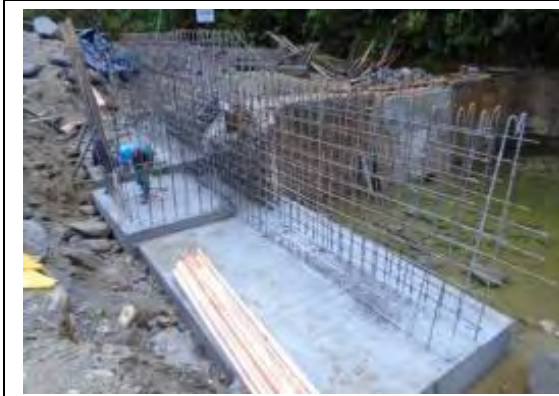
Figura 43. Concreto de 3000 psi para zarpa
