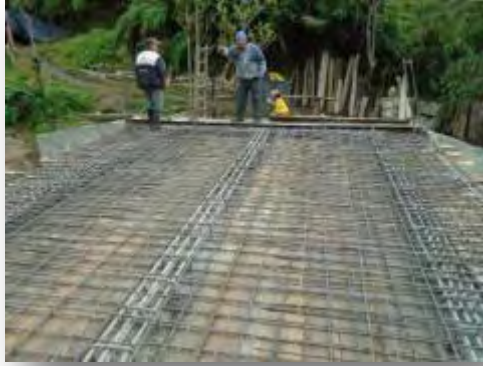
Figura 19. Armado y figurado acero de refuerzo losa
