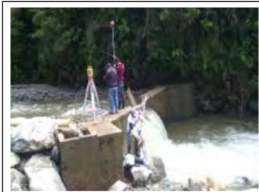
Figura 30. Localización y Replanteo
