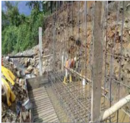
Figura 6. Figurado y armado de acero de refuerzo
