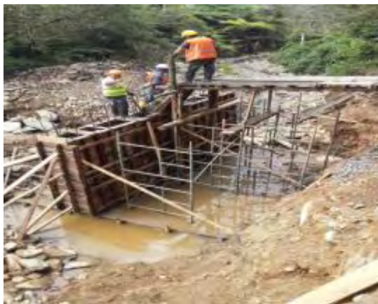
Figura 8. Vertimiento concreto estribo
