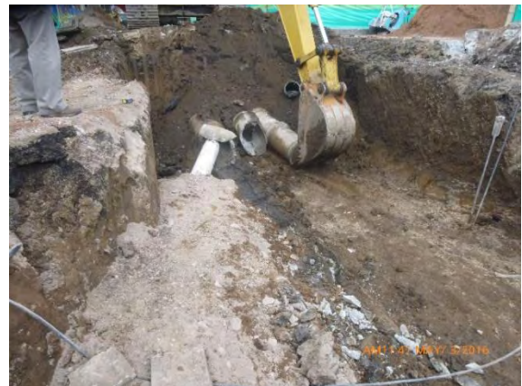
Foto 10. Demolición de tubería existente.
