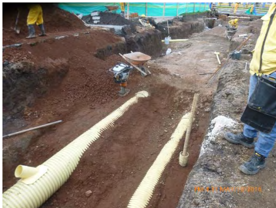
Foto 53. Atraque tubería pluvial y sanitaria
