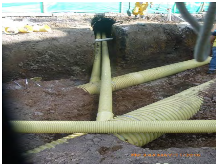
Foto 48. Acometida domiciliaria del alcantarillado Pluvial y sanitario
