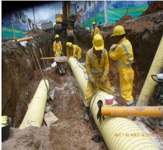
Foto 30. Posicionamiento nuevo tubo
