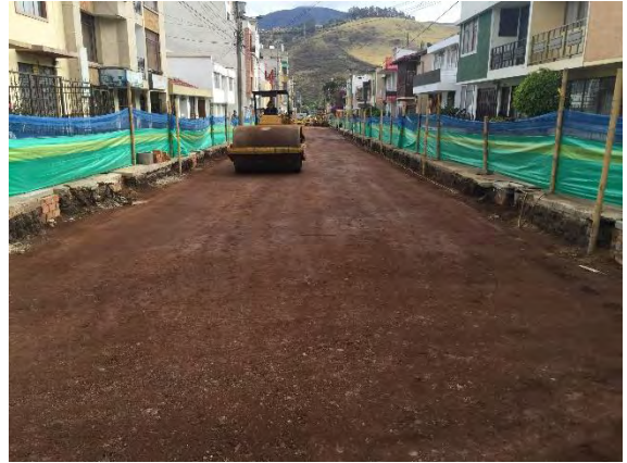
Foto 81. Compactación final sub-base vía
