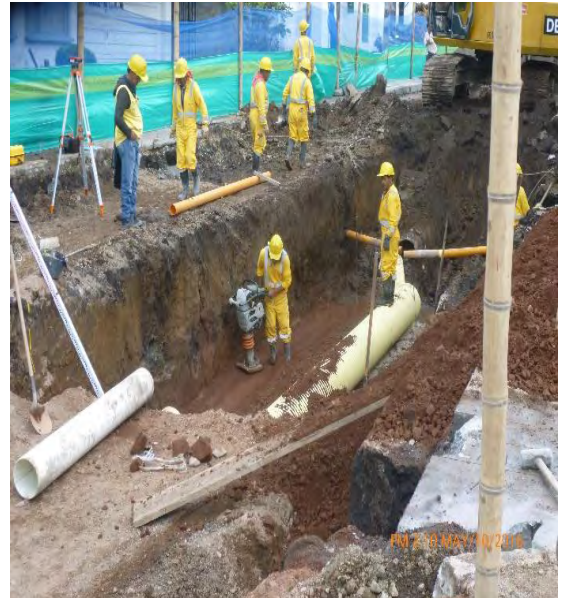
Foto 27. Material de cimentación de la tubería
