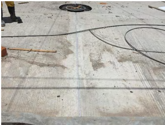
Foto 97. Sellamiento de junta
