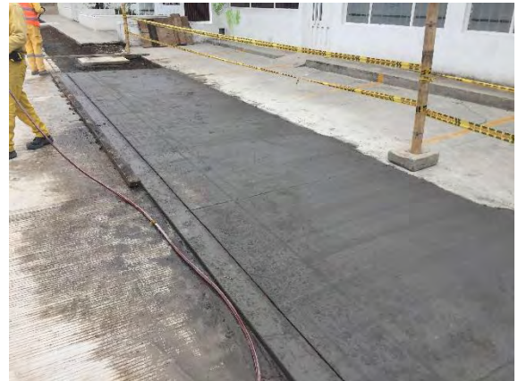
Foto 107. Reposición andén en concreto
