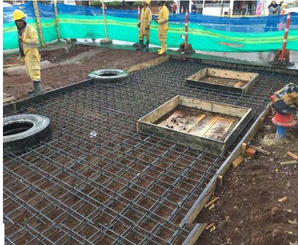
Foto 88. Refuerzo de las losas con estructuras
