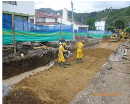
Foto 56. Tendido de material
