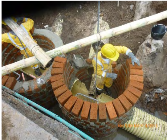
Foto 71. Construcción pozo de inspección
