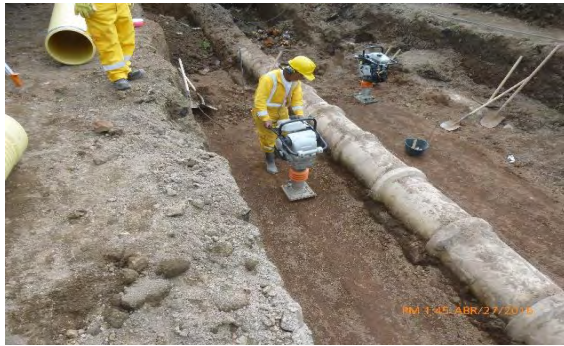
Foto 49. Cimentación tubería pluvial y sanitaria
