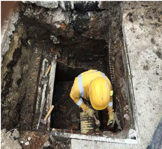
Foto 67. Recuperación sumidero existente
