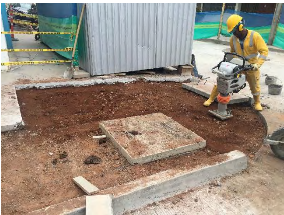
Foto 82. Compactación sub-base andén
