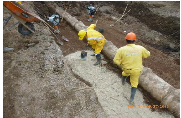
Foto 52. Cama en arena tubería pluvial y sanit
