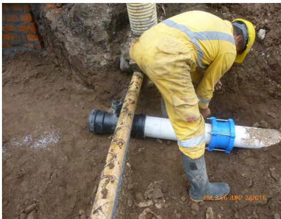
Foto 39. Instalación Tee HD
