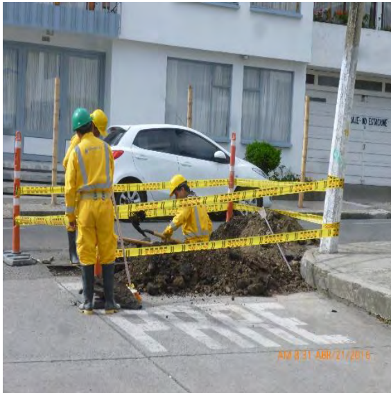
Foto 11. Apiques para localización tuberías
