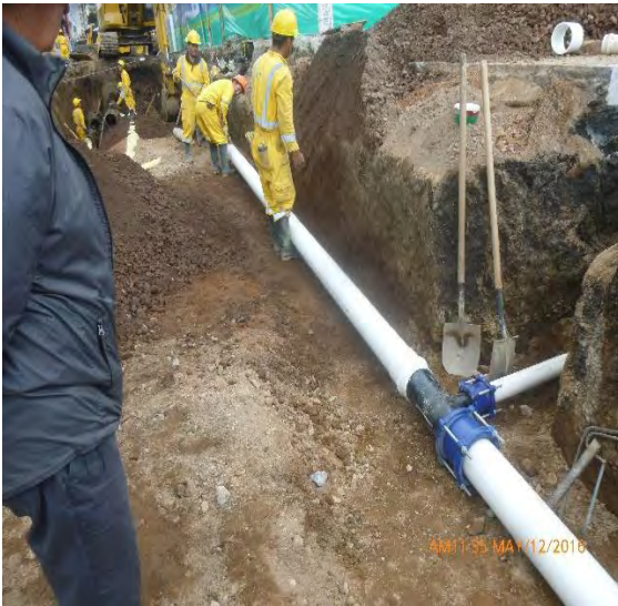
Foto 20. Instalación de tubería 6" y 3"
