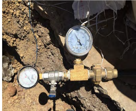
Foto 23. Medición de presión
