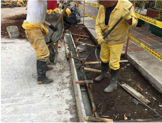
Foto 99. Construcción de bordillo
