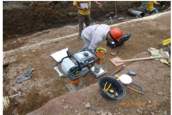
Foto 62. Ensayo densidad "in situ" atraque
