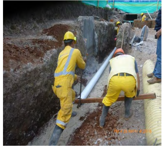
Foto 19. Instalación tubería presión de 6"
