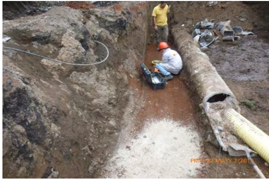
Foto 61. Ensayo densidad "in situ" cimentación
