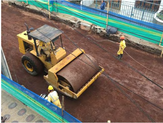
Foto 80. Compactación sub-base vía
