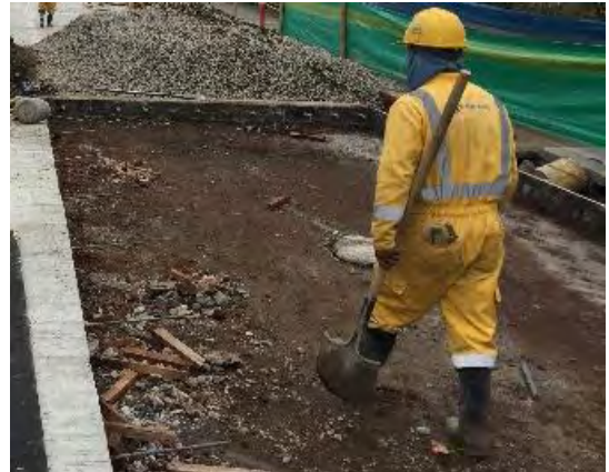
Foto 87. Refuerzo longitudinal y transversal
