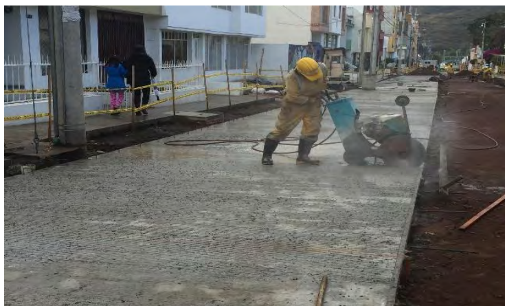
Foto 96. Corte junta transversal
