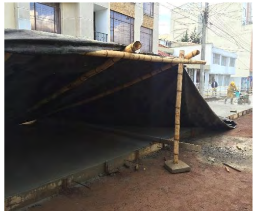
Foto 94. Protección en losa blanda
