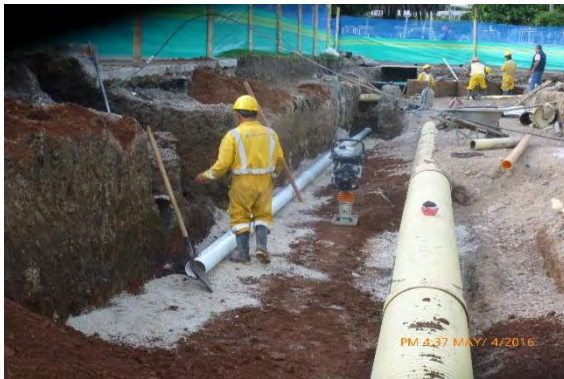
Foto 51. Cama en arena tubería presión
