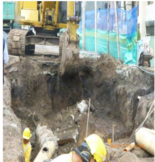
Foto 12. Excavación a máquina.
