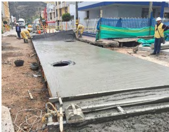
Foto 93. Protección contra la lluvia
