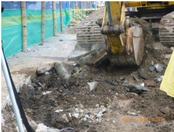
Foto 9. Demolición de pavimento.
