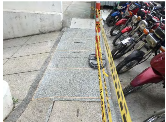
Foto 109. Reposición andén en granito lavado
