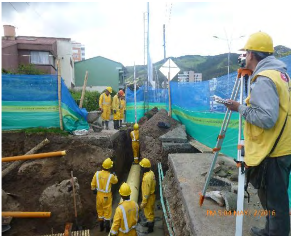
Foto 28. Alineación y chequeo de tubería
