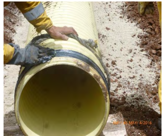
Foto 29. Limpieza y lubricación
