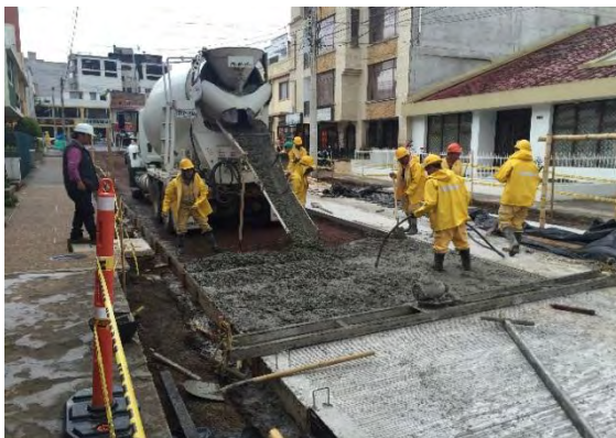
Foto 89. Vaciado y vibrado del concreto
