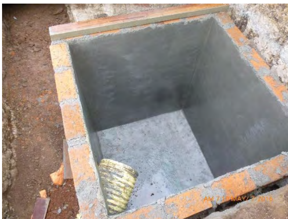
Foto 42. Construcción cajilla domiciliaria
