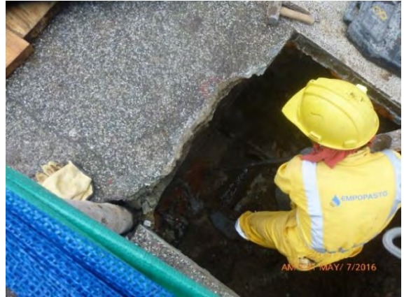
Foto 8. Demolición de andén y cajilla.
