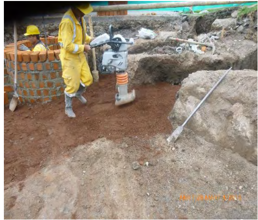
Foto 72. Relleno en pozo de inspección
