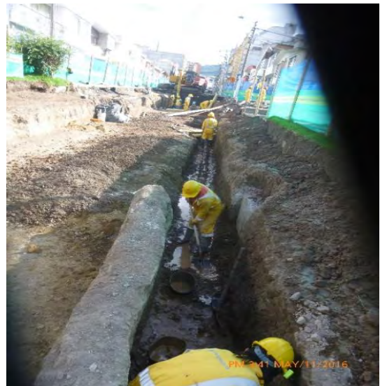
Foto 14. Excavación manual y perfilado
