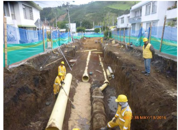
Foto 54. Atraque tubería pluvial y sanitaria
