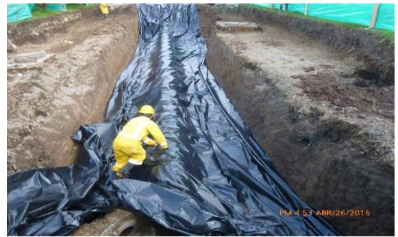
Foto 50. Protección de cimentación de tubería contra invierno
