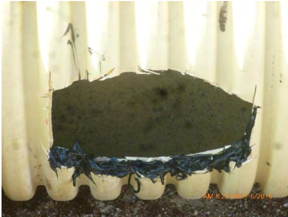
Foto 44. Sellado tubería colector
