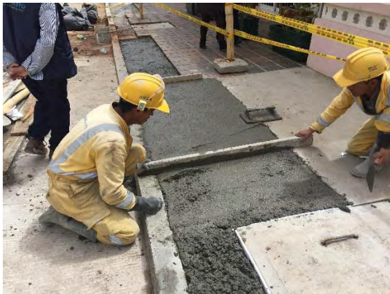
Foto 106. Vaciado de concreto en andén
