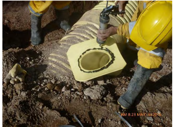
Foto 45. Instalación silla "Y"
