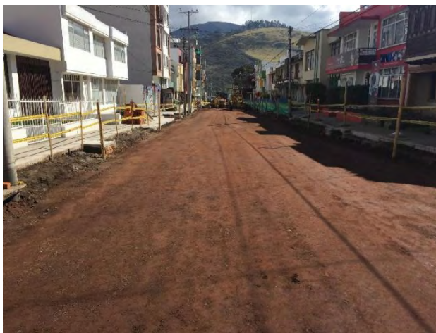
Foto 84. Sub-base terminada con perfil de bombeo
