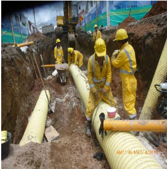
Foto 26. Alcantarillado Pluvial y Sanitario en tubería de P.V.C.
