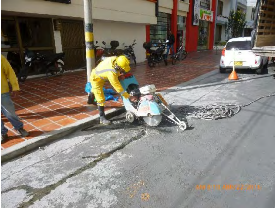
Foto 7. Corte de pavimento.
