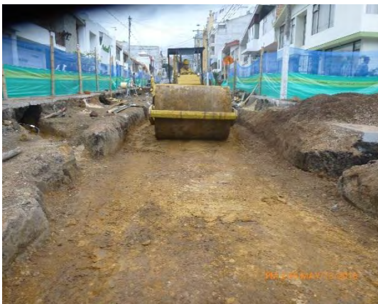
Foto 59. Compactación con cilindro vibratorio
