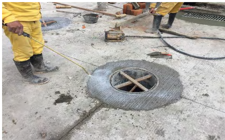
Foto 95. Curado del concreto
