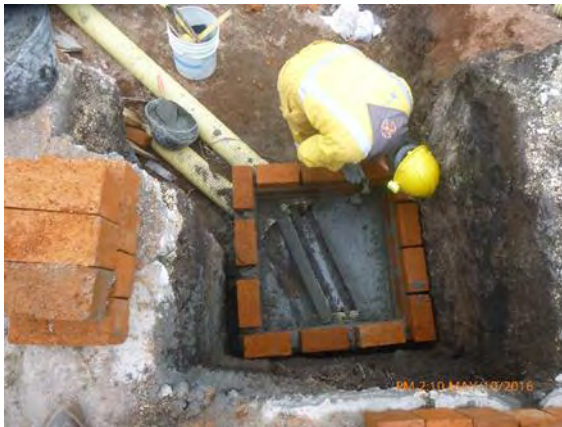
Foto 75. Construcción de cajilla domiciliaria
