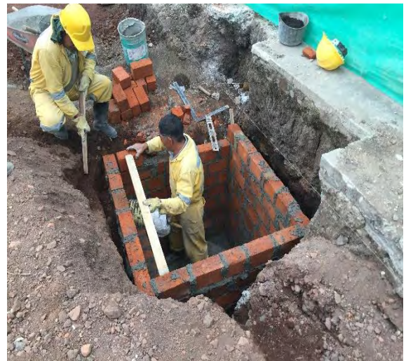
Foto 68. Construcción cámara del sumidero
