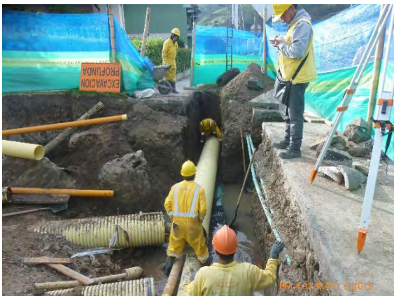
Foto 35. Instalación de tubería sobre filtro
