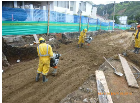
Foto 58. Compactación con canguro
