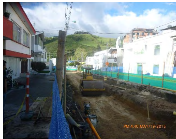
Foto 60. Compactación con cilindro vibratorio
