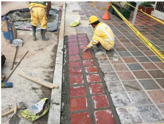
Foto 108. Reposición de andén en tableta
