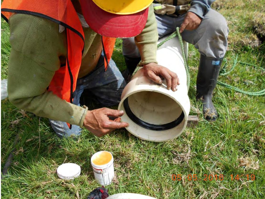
Ilustración 59. Lubricación tubería para instalar.
