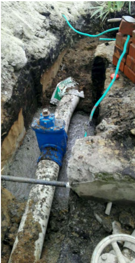
Ilustración 62. Instalación válvula de cierre.
