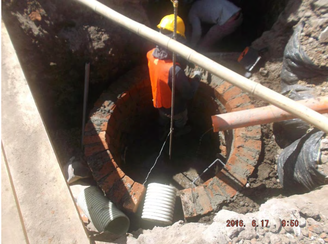
Ilustración 18. Construcción cámara de inspección.
