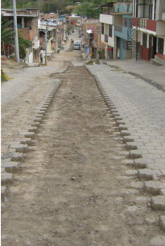
Ilustración 41. Estado actual de las vías.
