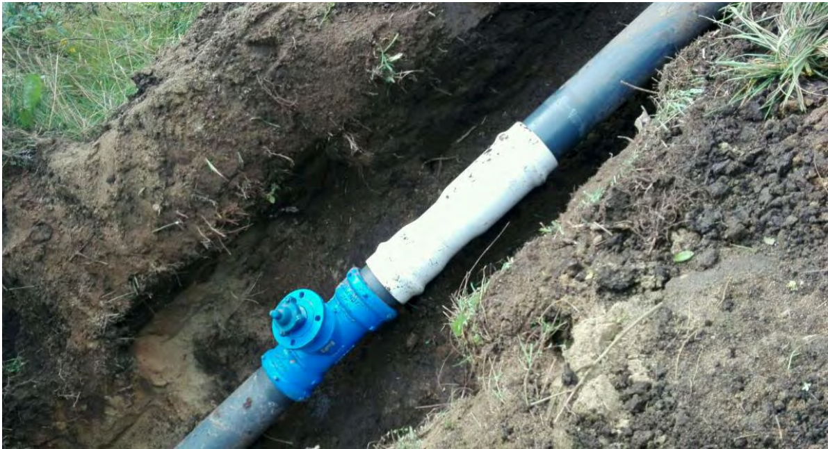
Ilustración 65. Instalación unión de reparación, tee para válvula ventosa.
