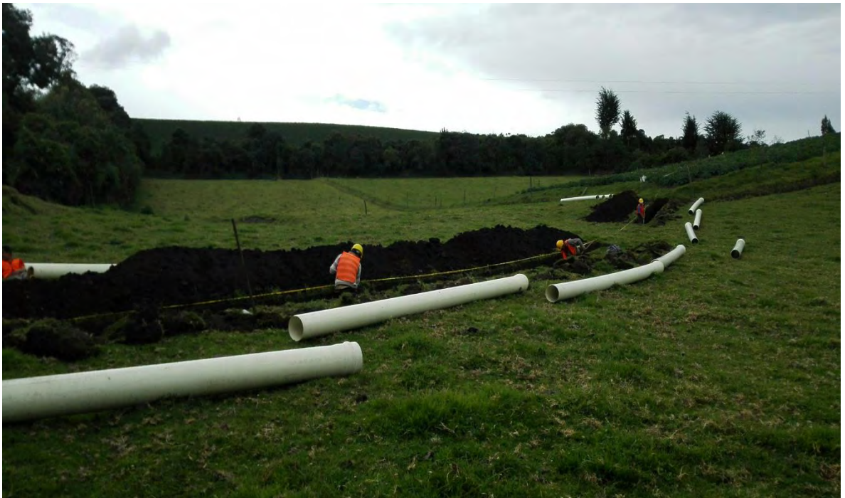
Ilustración 61. Instalación tubería vereda Piacún.
