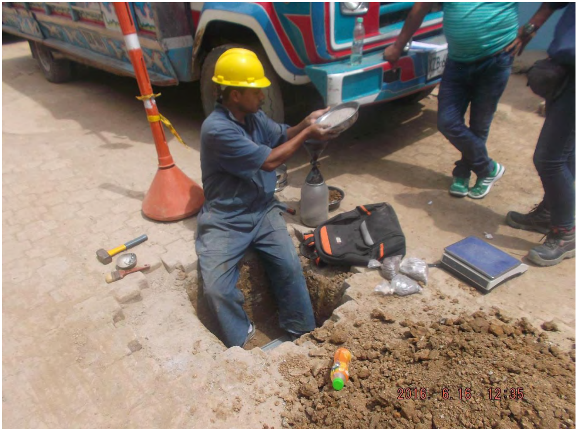
Ilustración 22. Ensayo de densidad - base.
