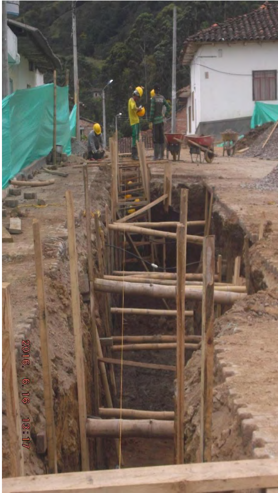
Ilustración 16. Instalación entibado barrio centro.
