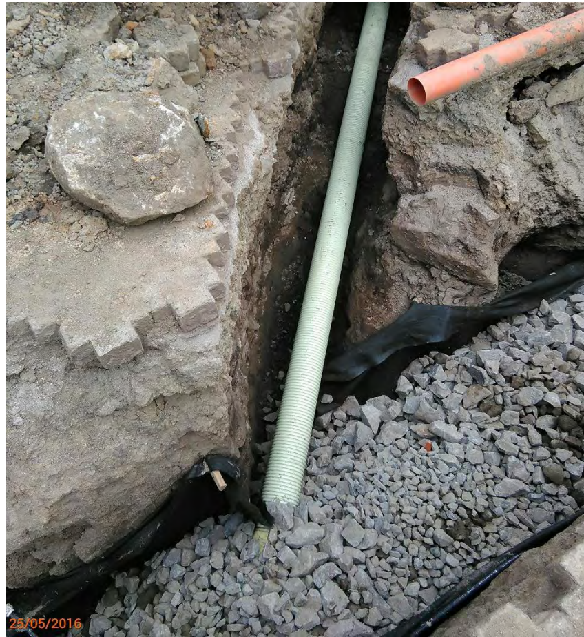
Ilustración 24. Excavación e instalación tubería acometida domiciliaria.
