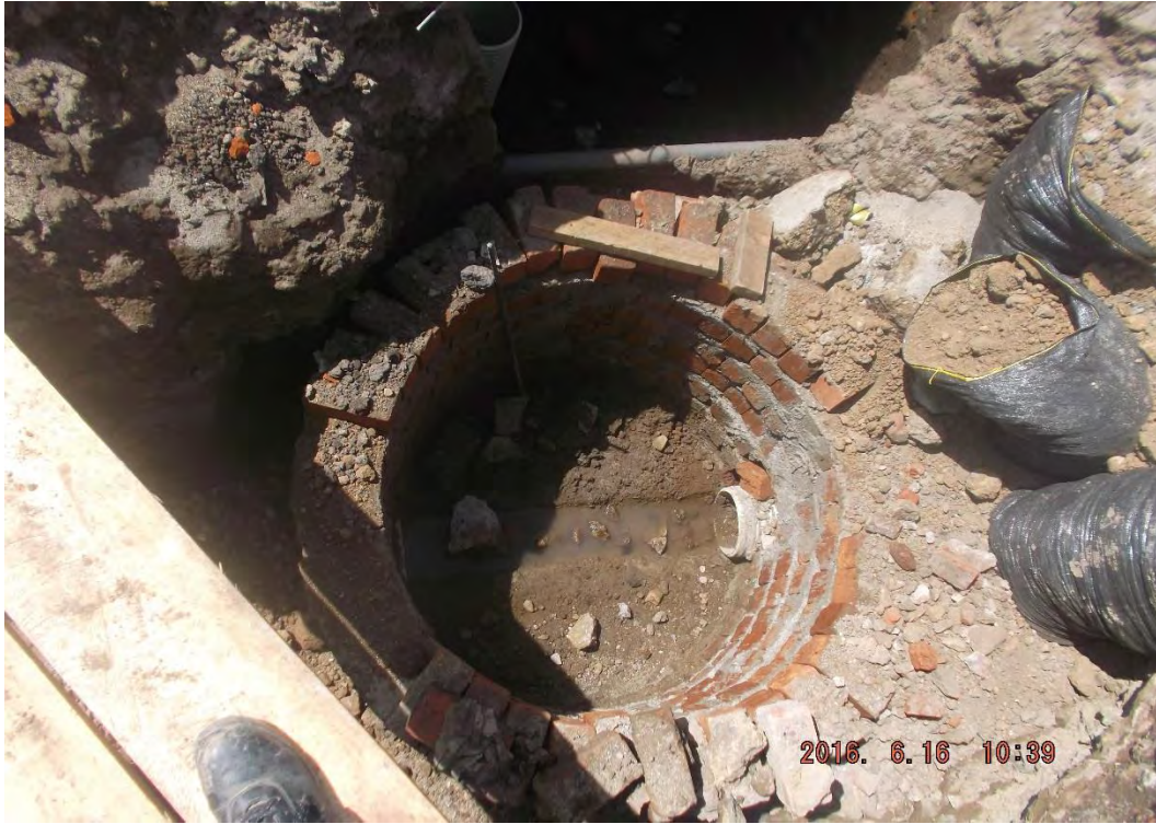
Ilustración 19. Demolición cámara de inspección existente.
