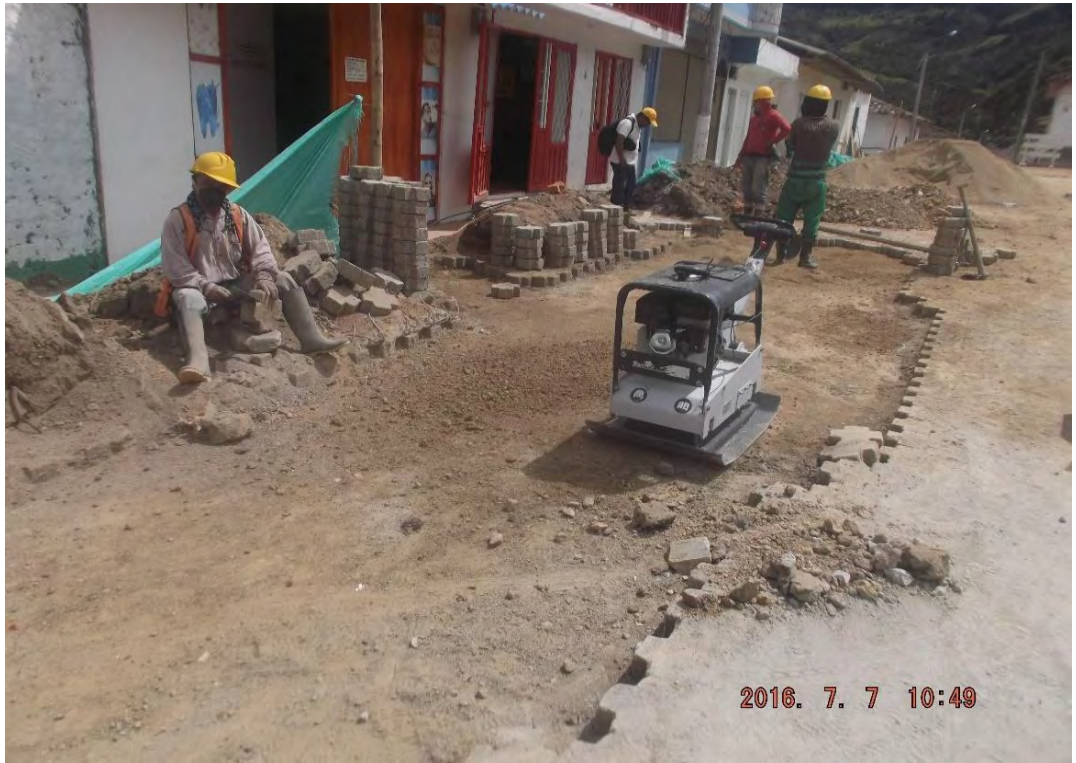
Ilustración 31. Nivelación base en recebo compactada.
