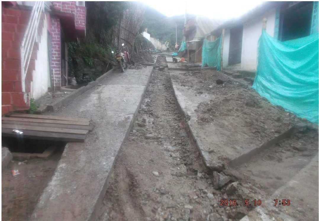
Ilustración 13. Demolición estructura de pavimento.
