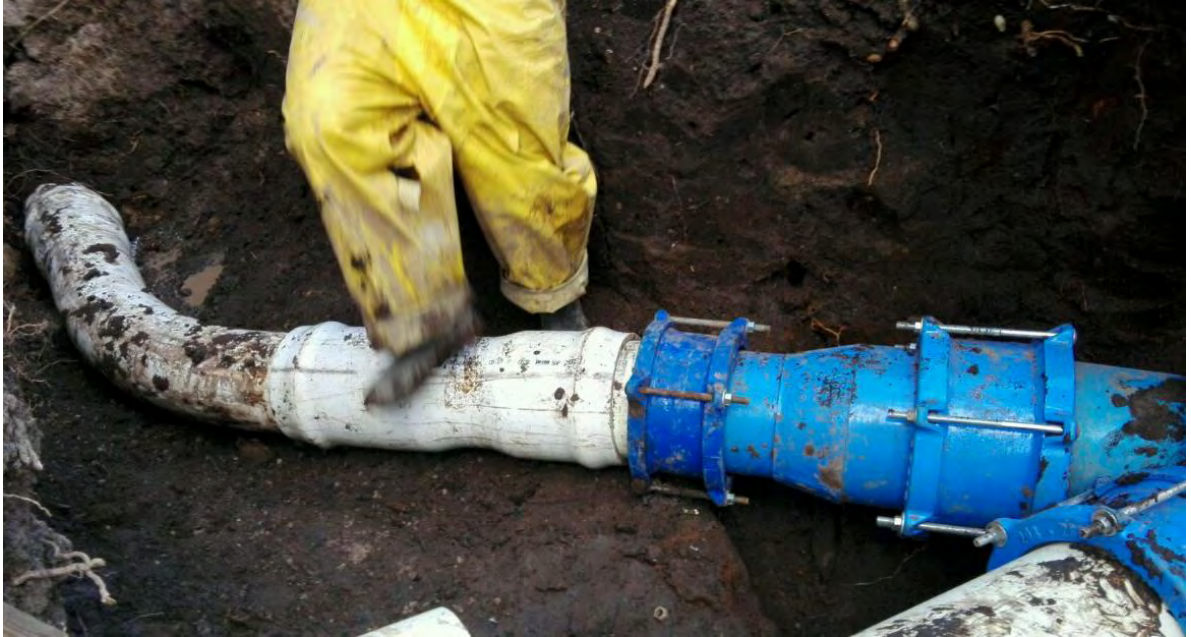
Ilustración 64. Instalación unión de reparación, unión dresser, campana reductora.
