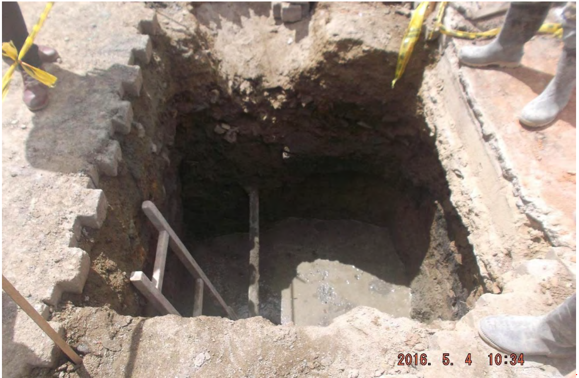
Ilustración 26. Excavación y solado de sumidero.
