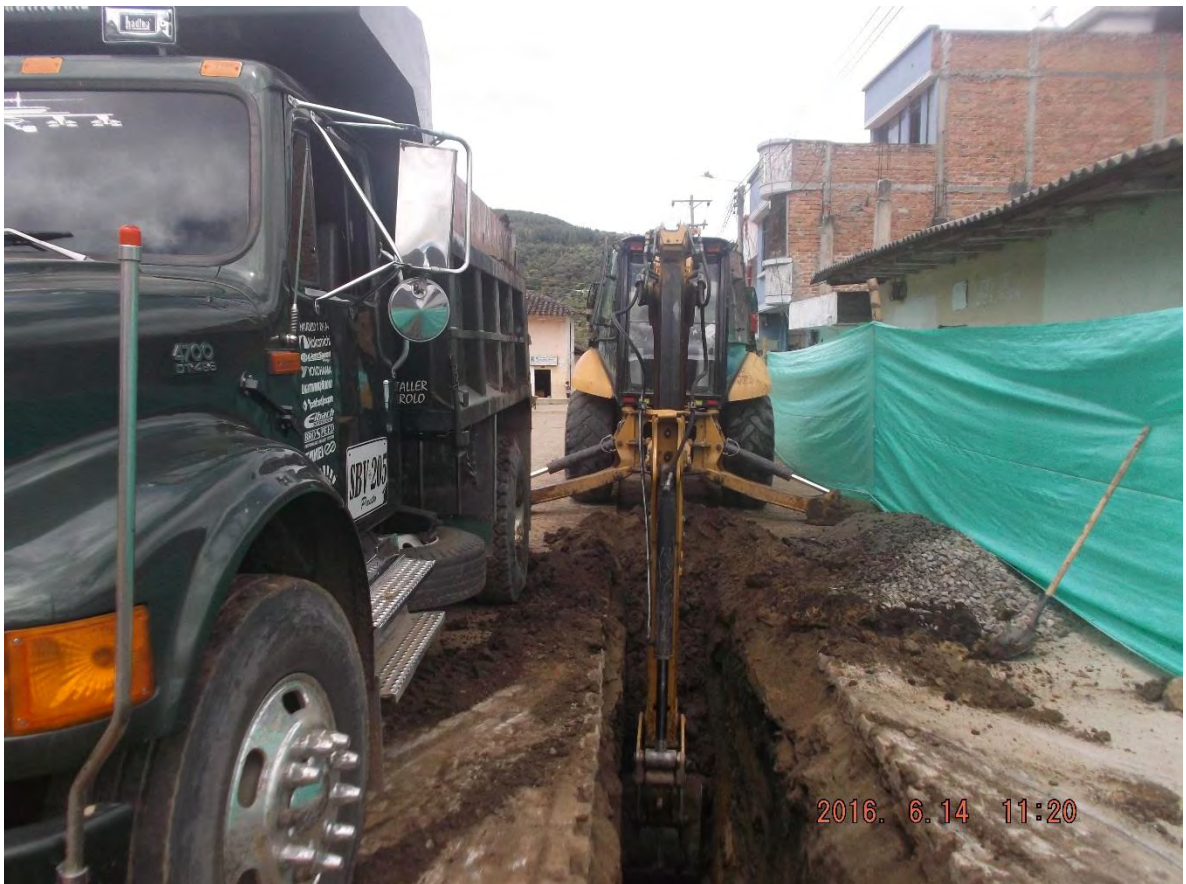
Ilustración 14. Excavación mecánica barrio centro.
