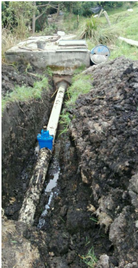
Ilustración 63. Instalación válvula de cierre.
