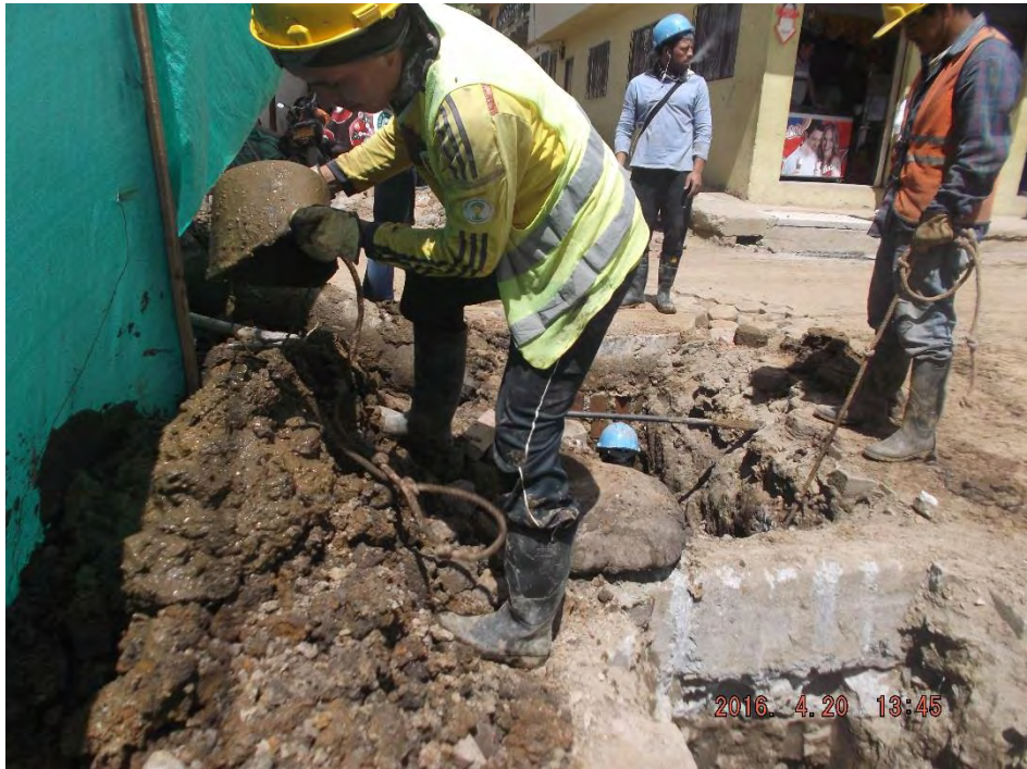
Ilustración 15. Retiro de lodos con balde.
