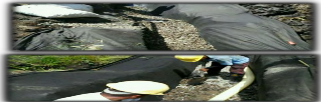
Ilustración 39. Instalación de filtro
