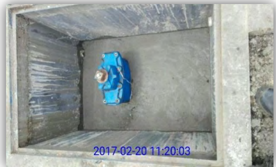
Ilustración 18 Instalación válvula de cierre
