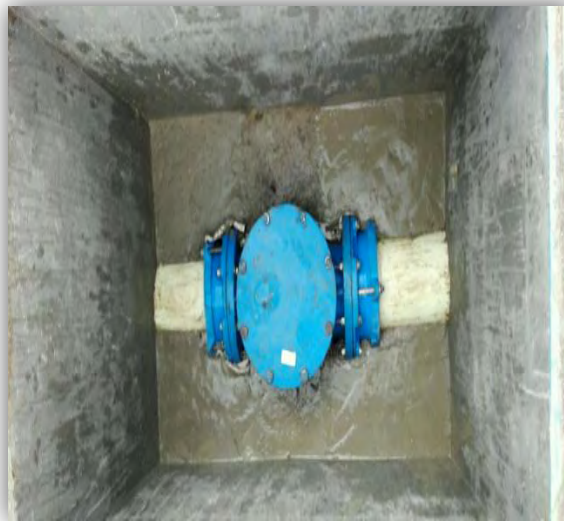
Ilustración 16. Instalación de cheque de 8"
