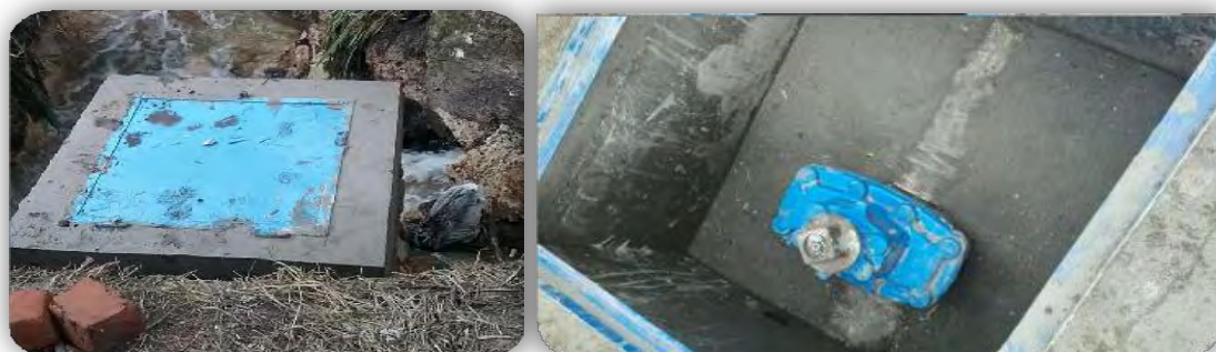
Ilustración 32 Elaboración cajilla de inspección e instalación de válvula de cierre de 8"
