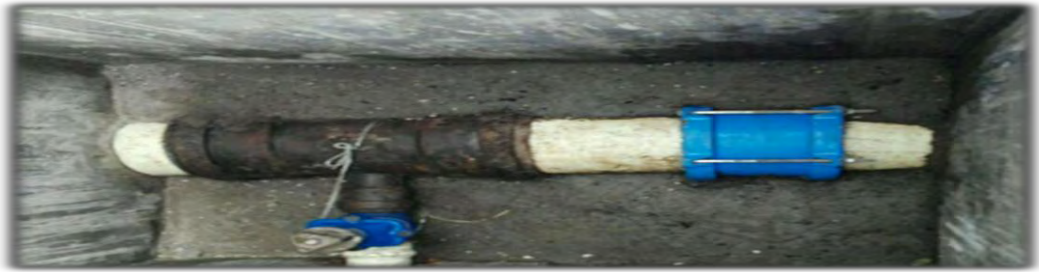
Ilustración 45. Instalación válvula purga en conducción existente de 6"
