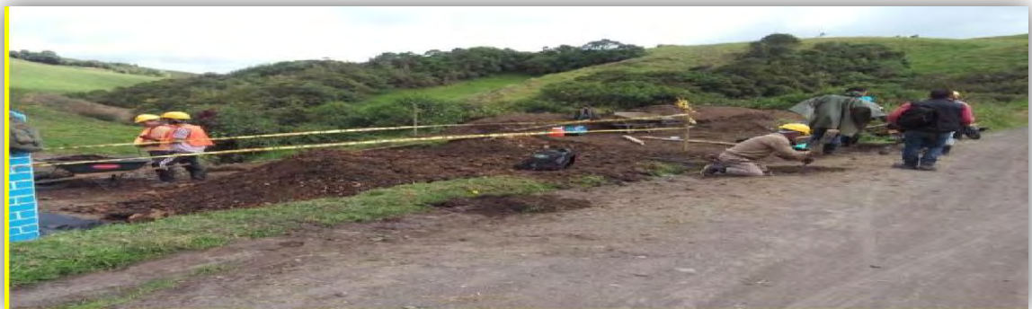
Ilustración 23. Señalización en obra
