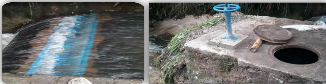
Ilustración 31. Instalación de rejilla metálica y rueda de manejo en bocatoma 2
