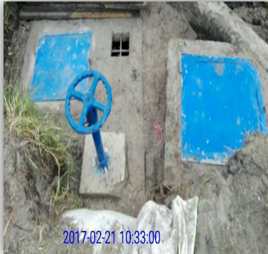
Ilustración 15. Instalación de rueda de manejo y tapas para bocatoma y cajilla
