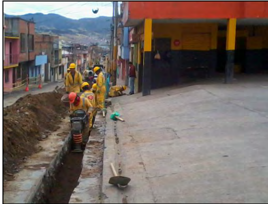
Figura 29. Relleno para acueducto.
