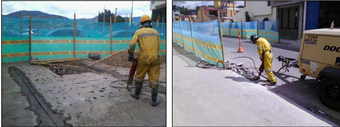
Figura 16. Demolición de pavimento.
