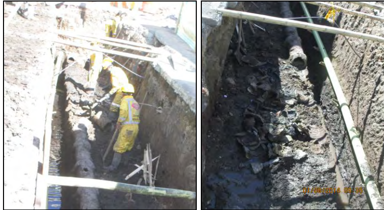
Figura 37. Retiro tubería existente de alcantarillado.
