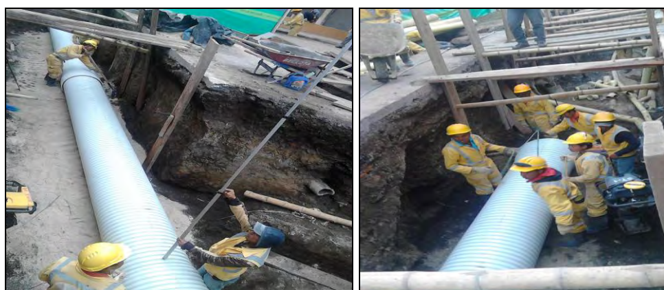
Figura 46. Instalación red de alcantarillado pluvial.
