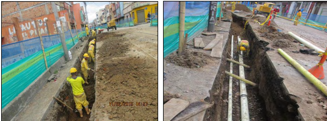
Figura 27. Excavación e instalación red de acueducto tubería de 6”.
