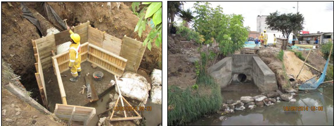
Figura 53. Construcción de estructura de descole al río Pasto.
