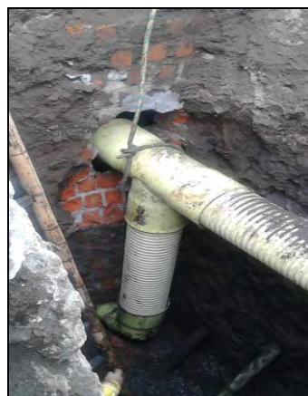
Figura 51. Instalación de cámara de caída.
