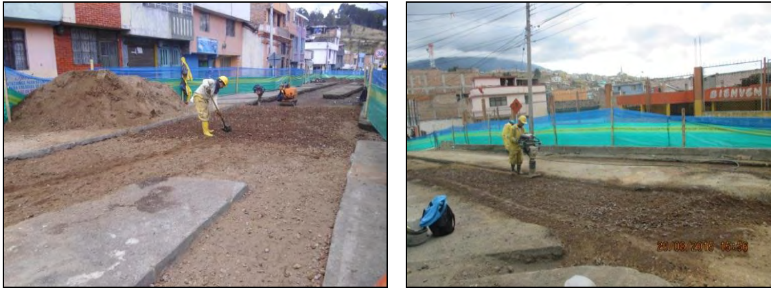
Figura 59. Instalación de base para parcheo.
