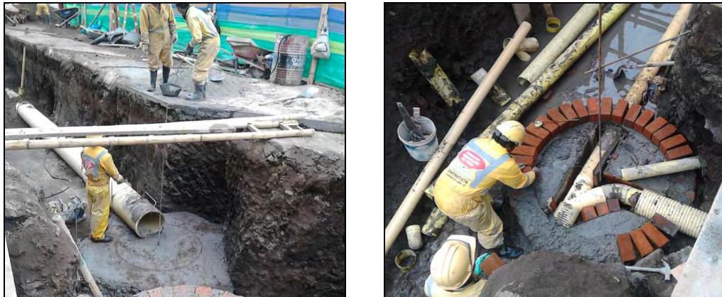
Figura 47. Construcción de pozos de inspección.
