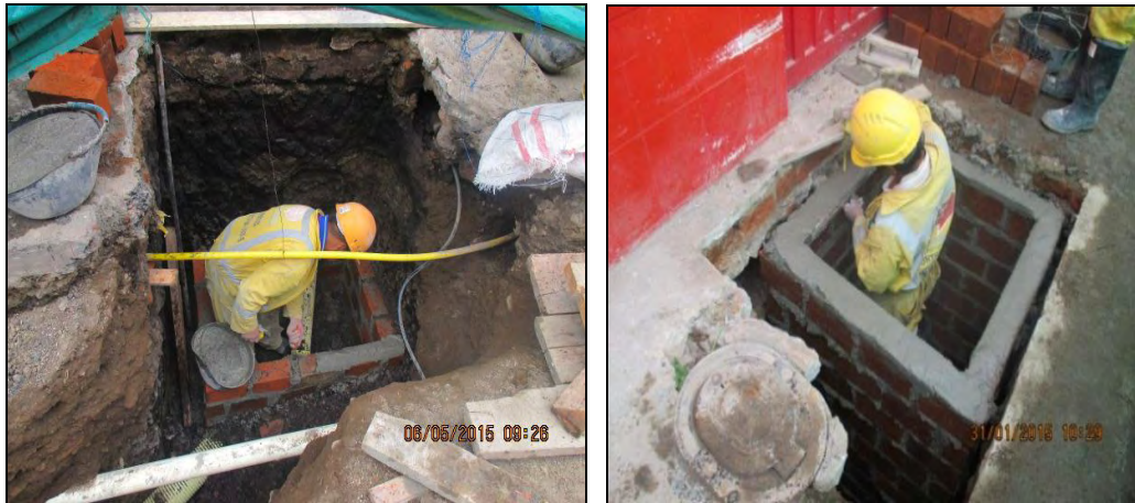
Figura 44. Construcción de cajas domiciliarias.
