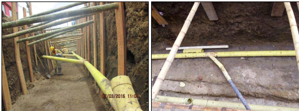
Figura 38. Manejo de aguas con tubería lisa de 4”.
