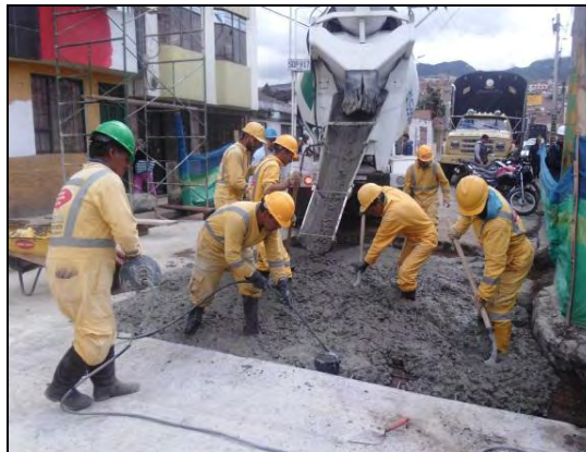
Figura 58. Vaciado de concreto para pavimento.
