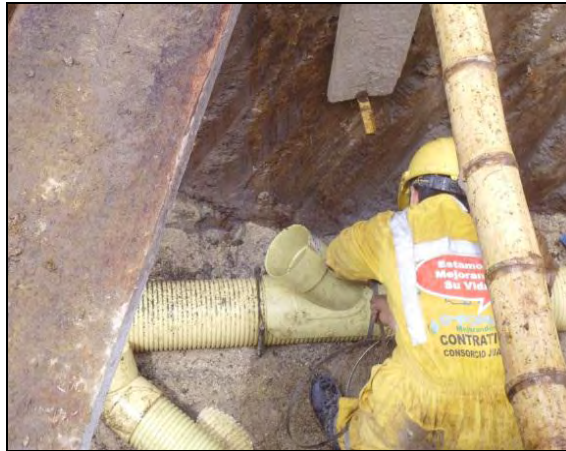
Figura 42. Instalación silla YEE.
