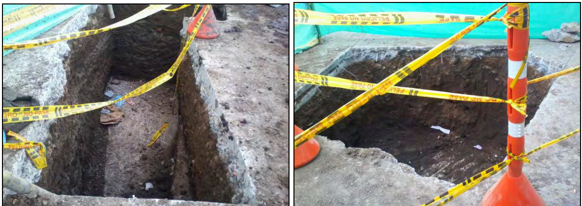
Figura 17. Apiques para localizar box coulvert sobre Carrera 9.
