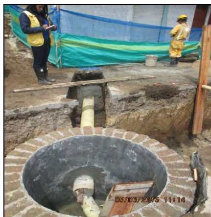
Figura 49. Instalación tubería de 10” para sumideros.
