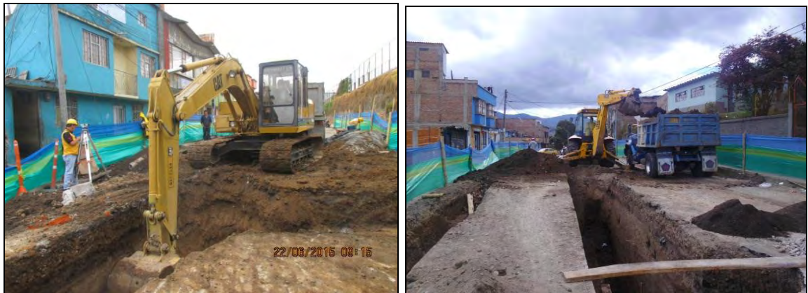
Figura 35. Excavación mecánica para alcantarillado.
