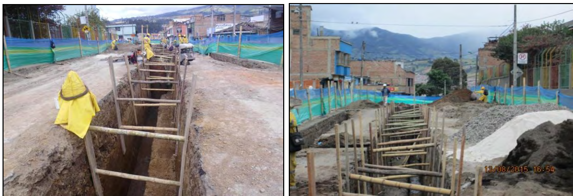
Figura 36. Proceso de entibado en las excavaciones.
