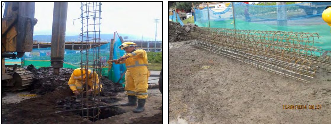
Figura 21. Figuración de acero para pilotes.
