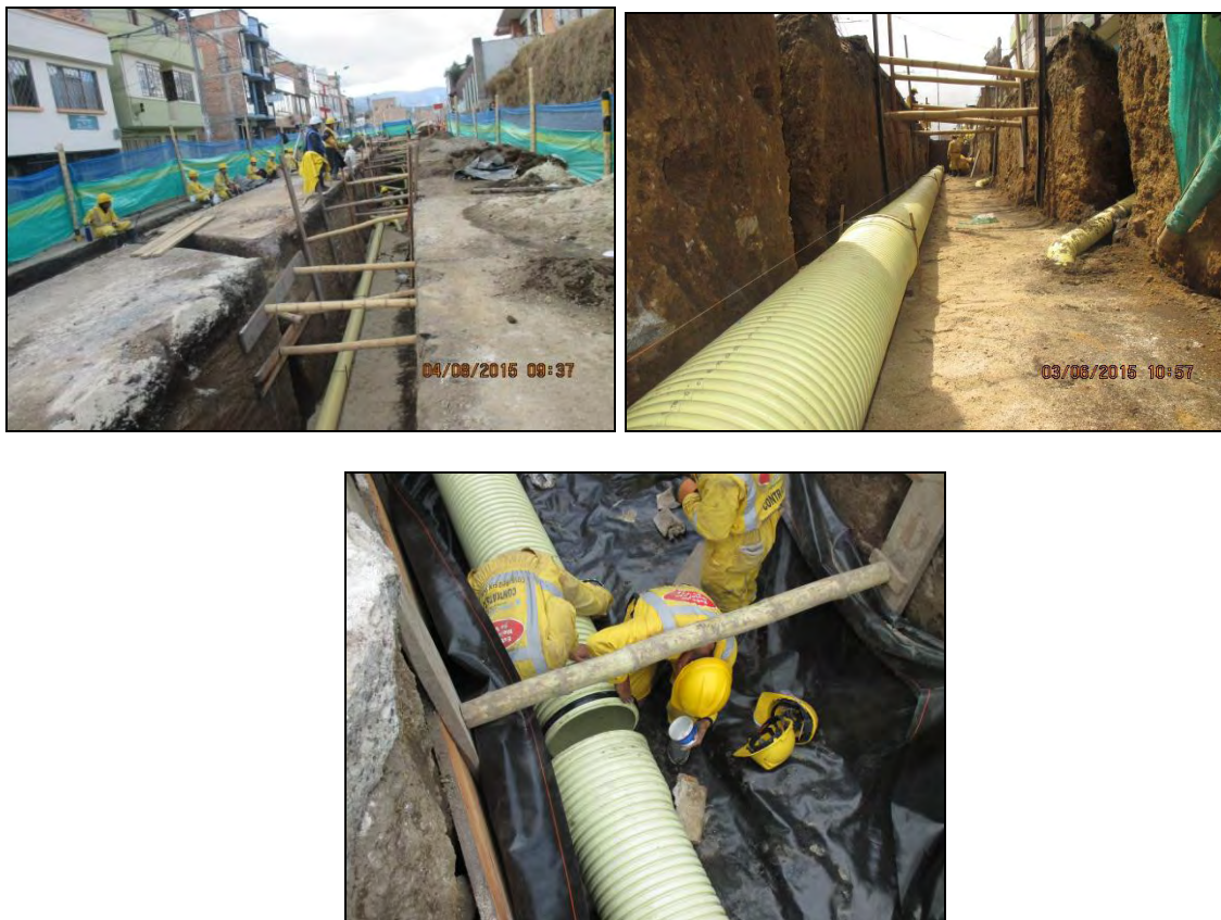
Figura 39. Instalación red de alcantarillado.
