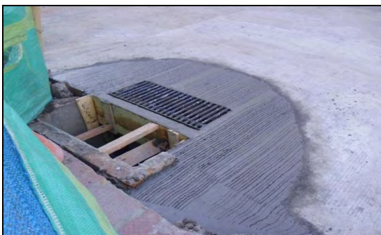
Figura 52. Construcción de sumideros.
