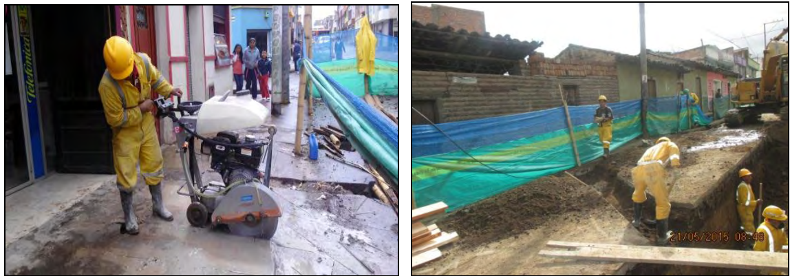
Figura 41. Corte y demolición de pavimento para acometidas domiciliarias de alcantarillado.
