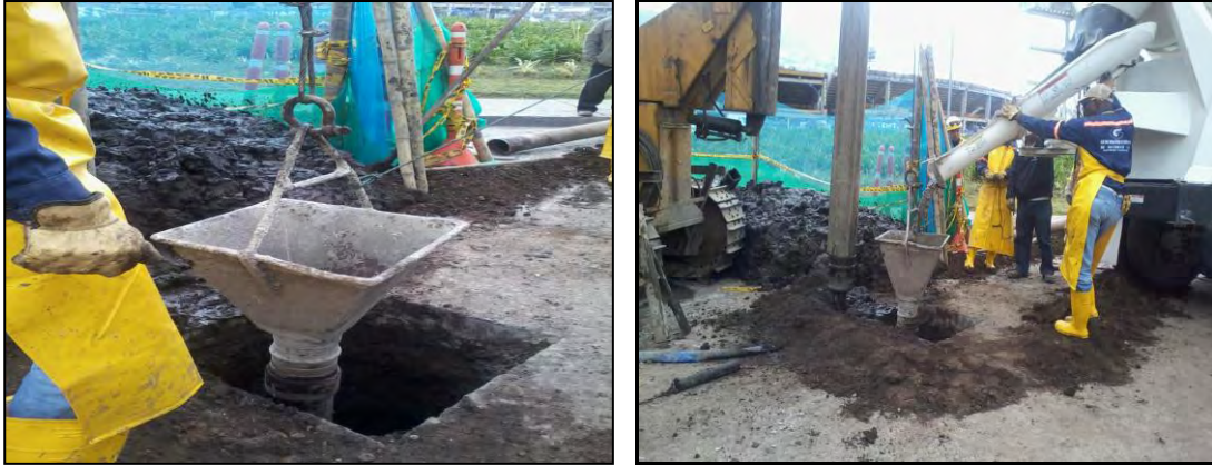
Figura 22. Vaciado de concreto para pilotes.
