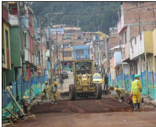
Figura 56. Instalación de base con motoniveladora.
