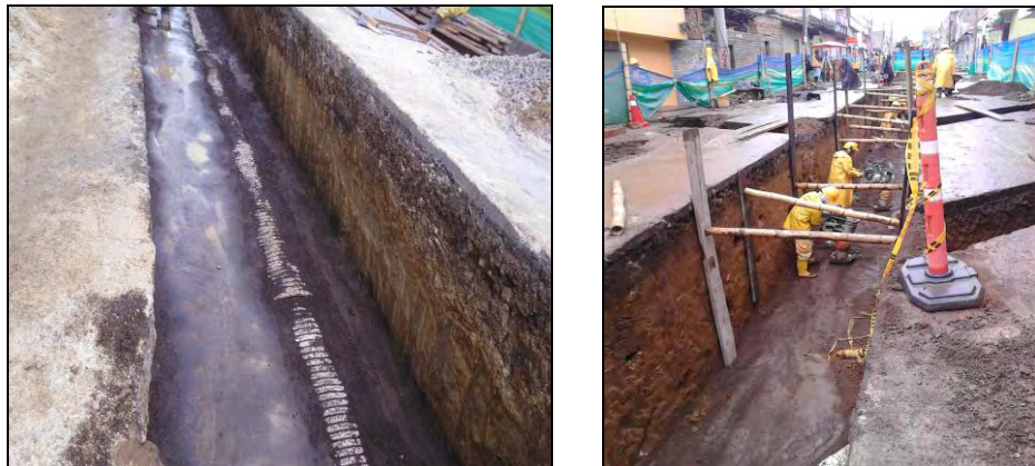
Figura 45. Atraque y relleno de tubería.
