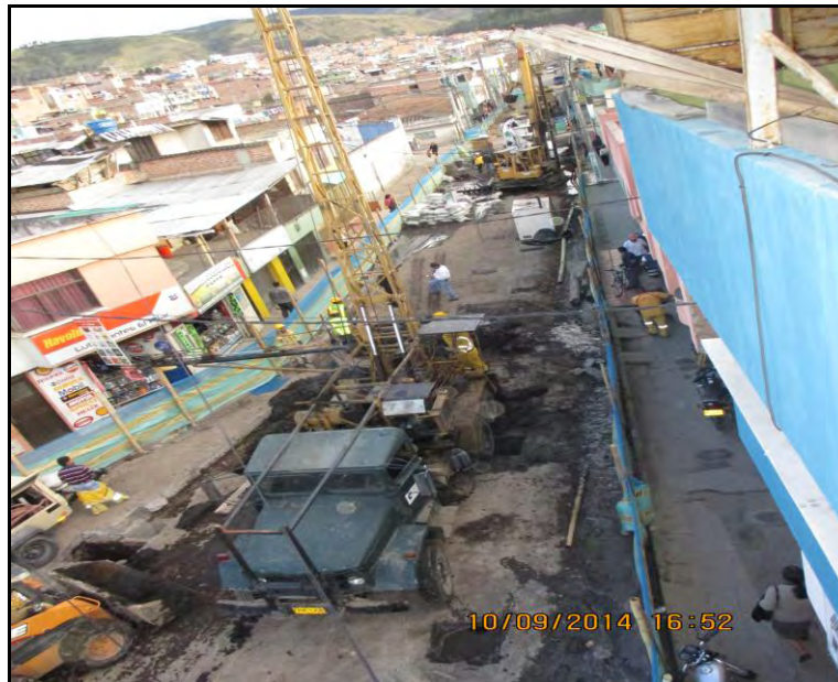
Figura 19. Ubicación de PILOTEADORAS sobre calle 12B
