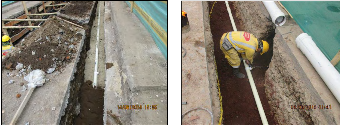
Figura 26. Instalación red de acueducto tubería de 3”.
