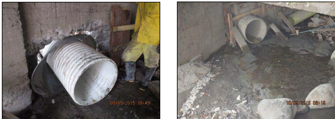
Figura 54. Construcción de pasamuro en puente chapal.
