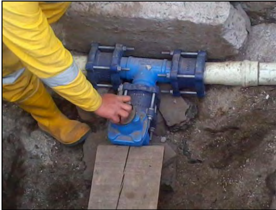
Figura 31. Instalación codos en HD con su respectivo atraque.
