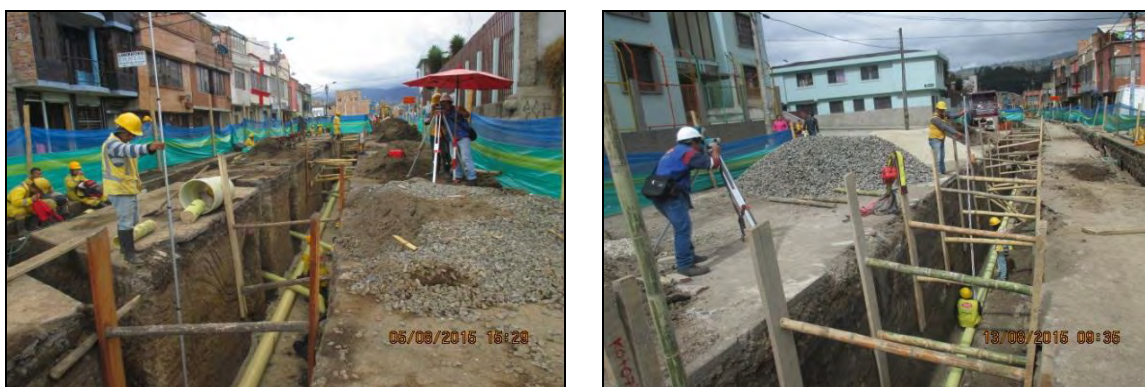
Figura 40. Nivelación de tubería.
