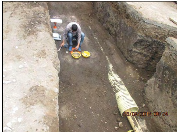
Figura 63. Toma de densidades para relleno sobre cota clave de tubería con recebo.
