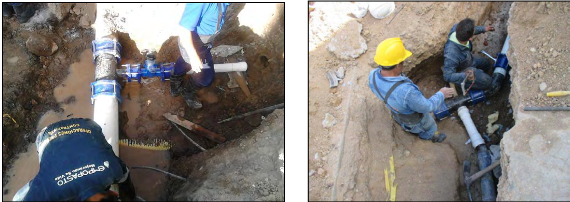
Figura 34. Empalmes a tubería existente.
