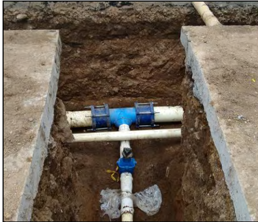
Figura 33. Instalación TEE 6" a 3".
