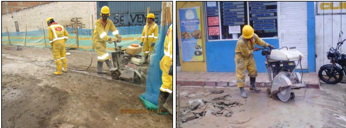
Figura 15. Corte de pavimento.
