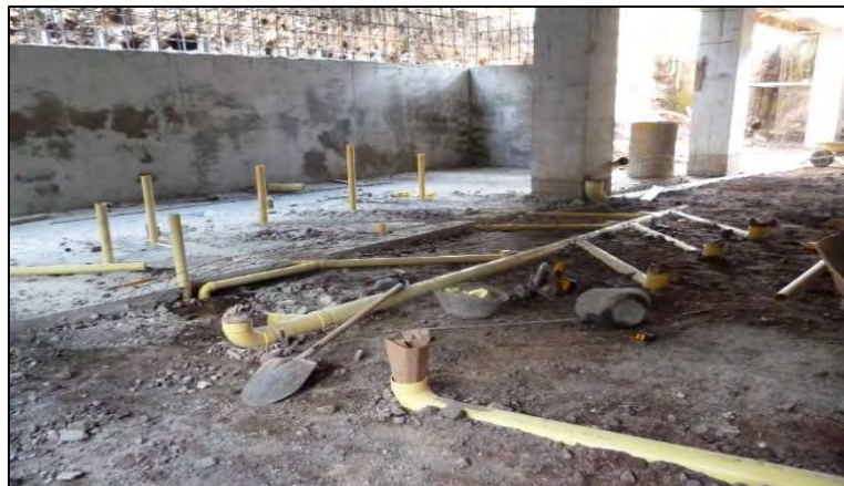
Imagen 26.- Instalación red sanitaria sótano.
