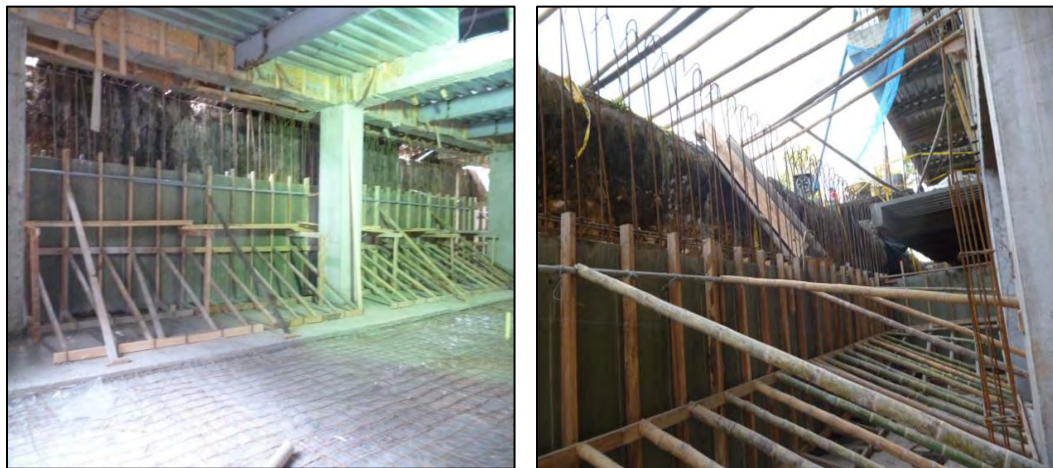
Imagen 22.- Formaleta cuerpo muro de contención
