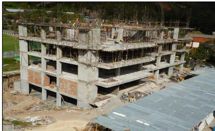
Imagen 17.- Pantallas y columnas nivel N+11.10
