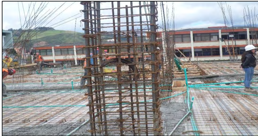
Imagen 12.- Fundición losa nivel 7.40
