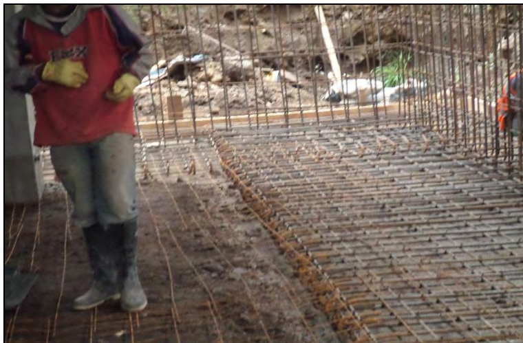
Imagen 20.- Refuerzo zarpa muro contención.
