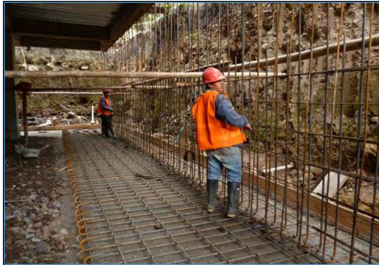
Imagen 21.-Refuerzo cuerpo muro de contención.
