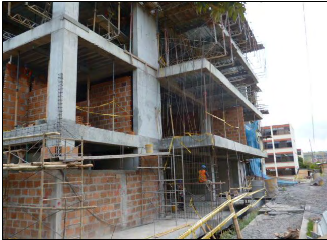
Imagen 32.- Refuerzo muro fachada.
