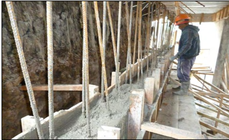
Imagen 23.- Muro de contención
