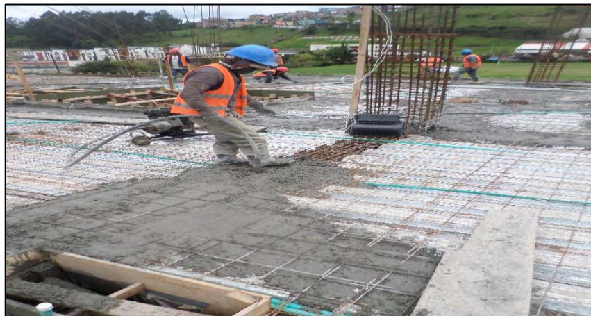
Imagen 13. Fundición losa nivel 7.40
