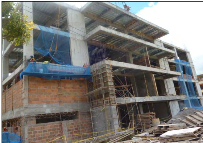
Imagen 33.- Formaleta muro fachada.
