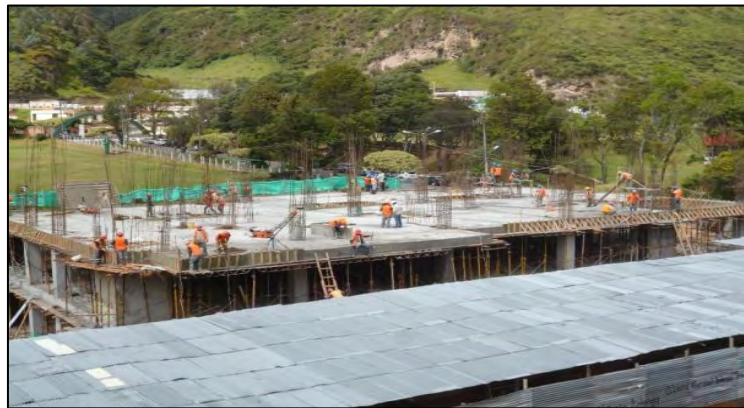
Imagen 3.- Estado inicial de la obra.
