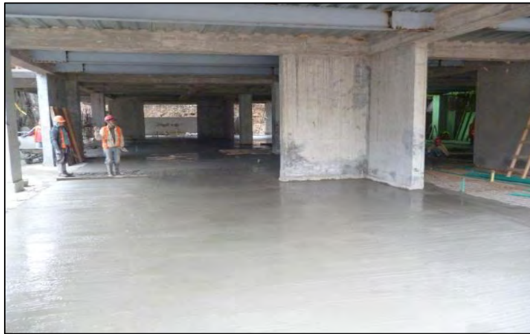
Imagen 28.- Concreto contra piso sótano.
