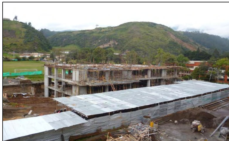
Imagen 11.- Pantallas y columnas nivel 3.7
