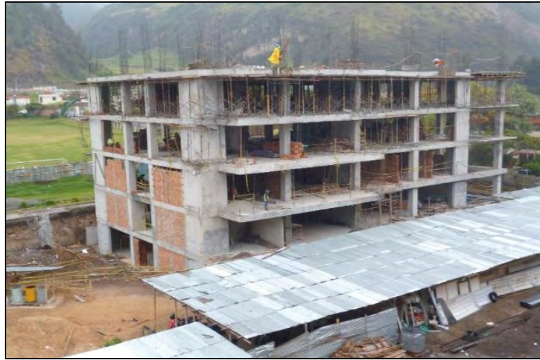
Imagen 18.- Fundición losa nivel N+14.8
