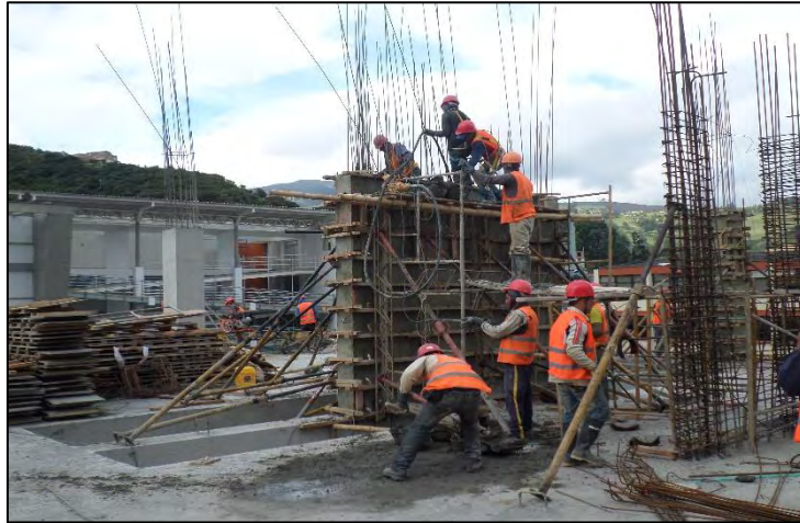
Imagen 9.- Fundición pantallas y columnas.
