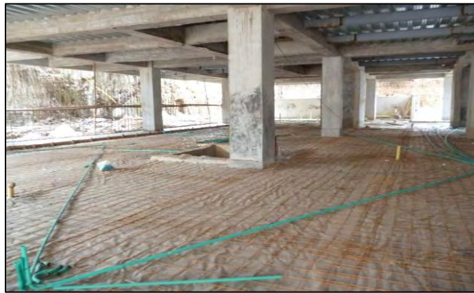
Imagen 25.- Malla electro soldada y polysec sótano.
