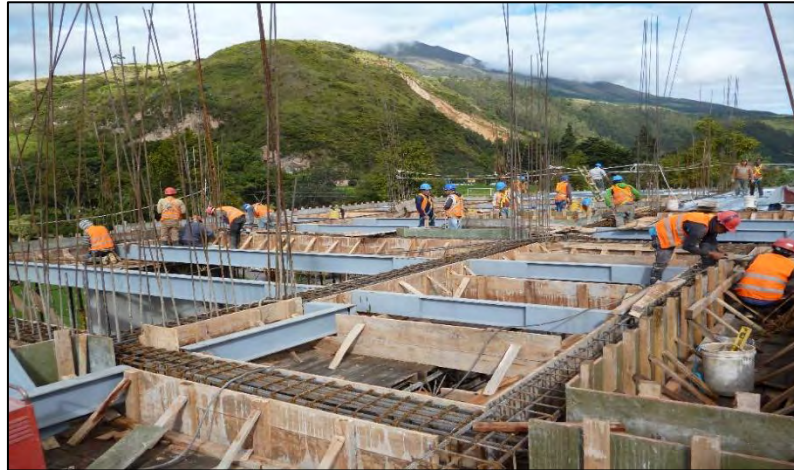
Imagen 15.- Ubicación perfiles y aplome laterales
