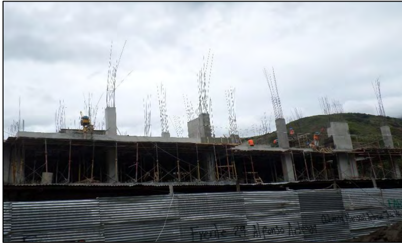
Imagen 14.- Columnas y pantallas nivel 7.40
