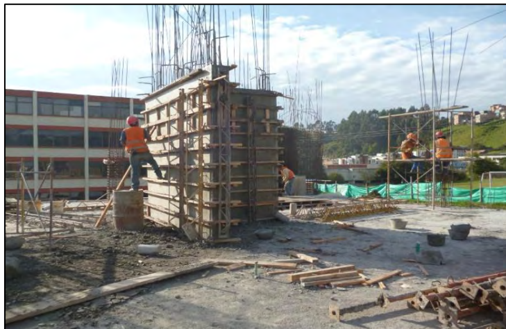
Imagen 10.- Retiro de formaleta.
