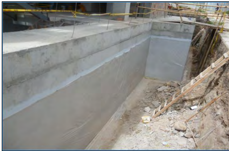
Imagen 24.- Acabado muro contención
