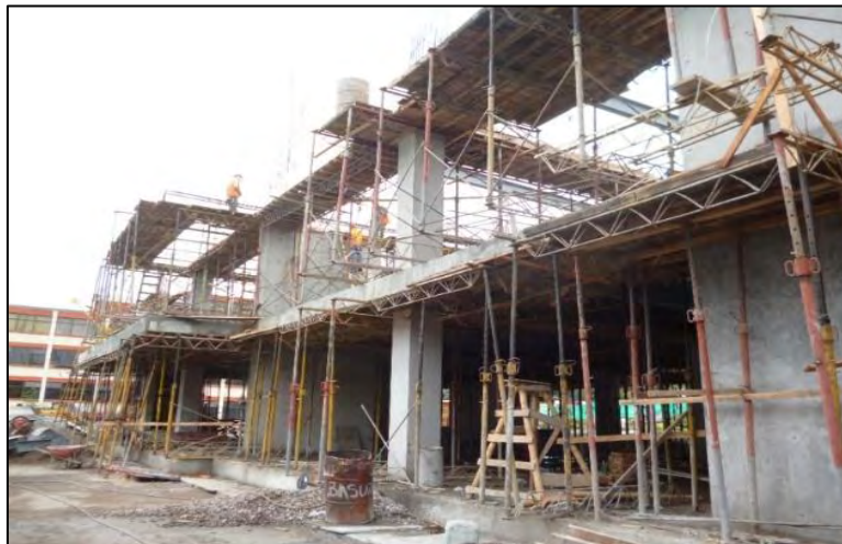
Imagen 7. Formaleta para vigas
