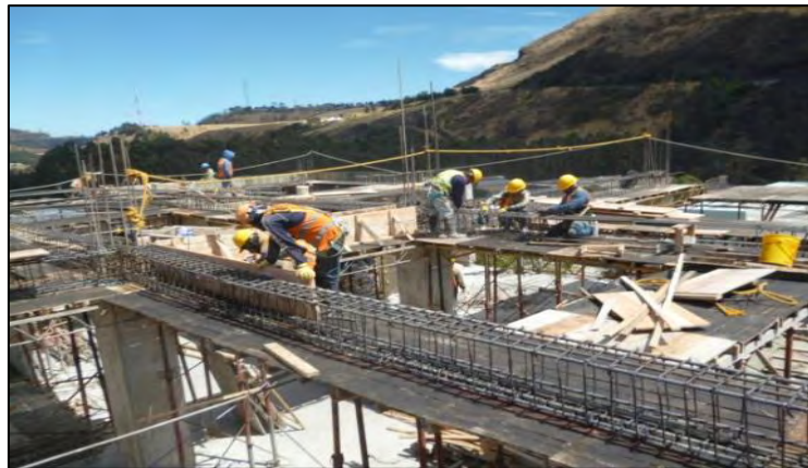
Imagen 5.- Armado de refuerzo en vigas
