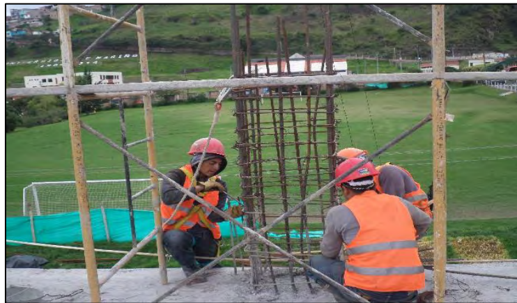
Imagen 4.- Armado de refuerzo en columnas
