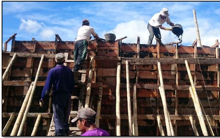
Figura 33. Fundición de muros
