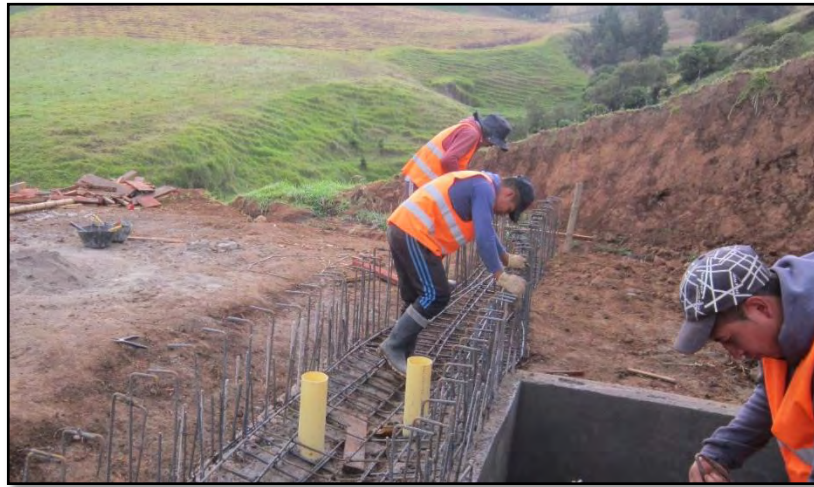
Figura 21. Armado de refuerzo para canaleta y desarenador
