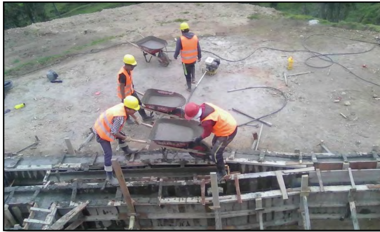
Figura 23. Fundición de canaleta y desarenador
