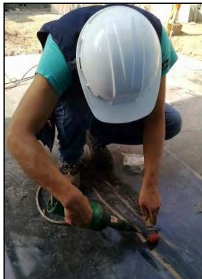
Figura 40. Instalación de geo membrana
