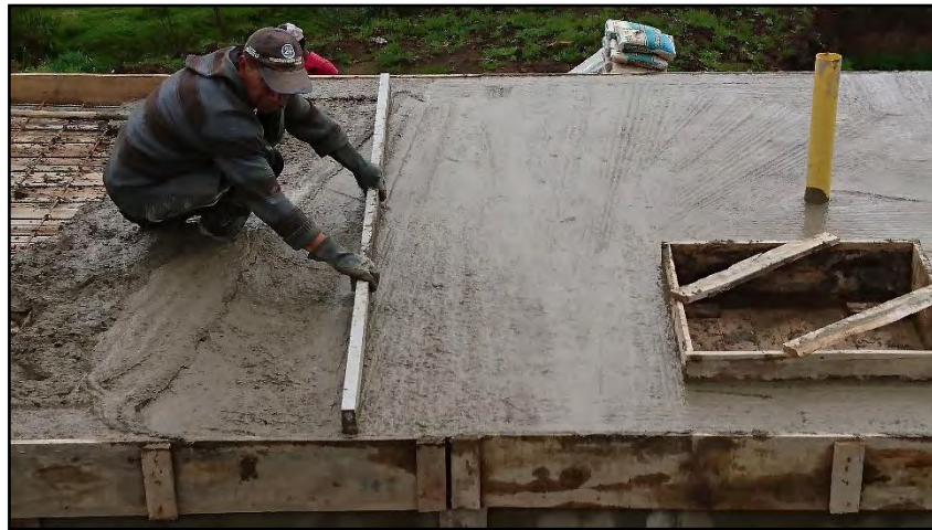
Figura 34. Fundición de losa de cubierta
