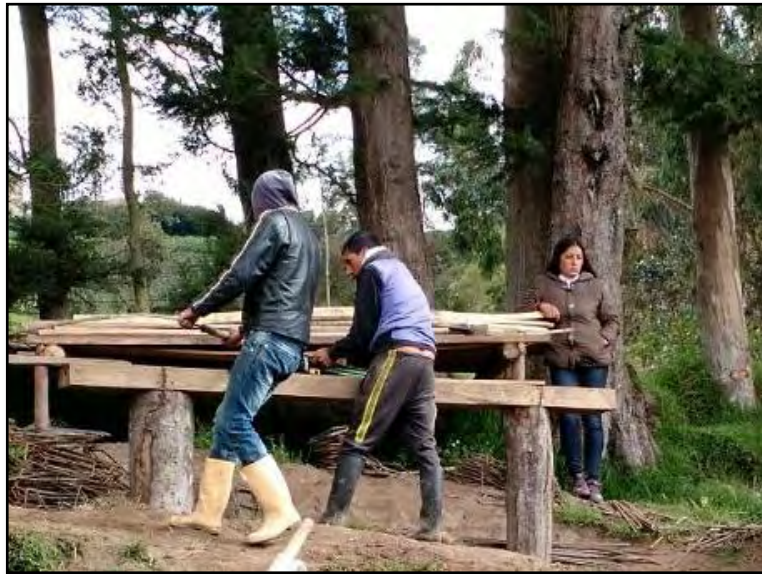
Figura 19. Figurado de acero de refuerzo
