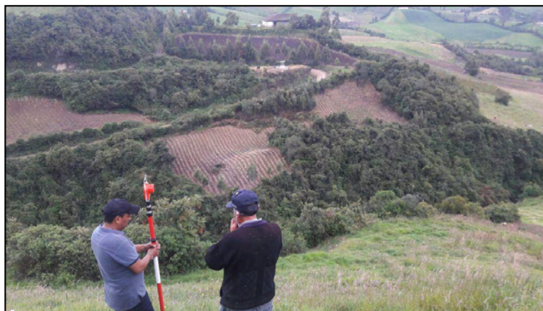
Figura 13. Comisión topográfica en labores de replanteo
