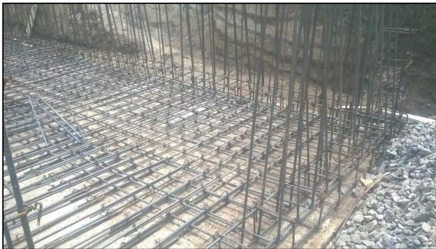
Figura 28. Acero de refuerzo de losa de piso
