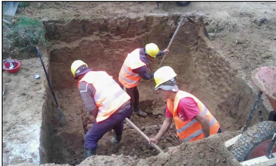
Figura 17. Excavaciones para construcción de cámara de válvulas del desarenador
