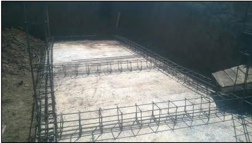
Figura 27. Acero de refuerzo de vigas
