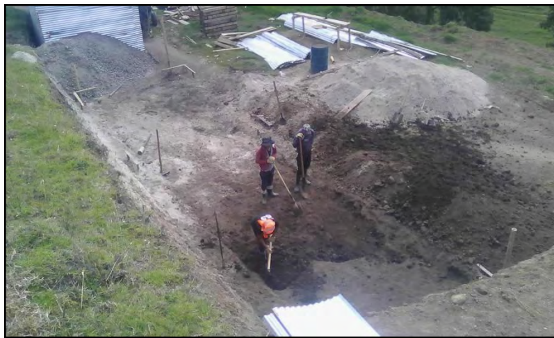
Figura 24. Excavación para construcción de tanque séptico y FAFA
