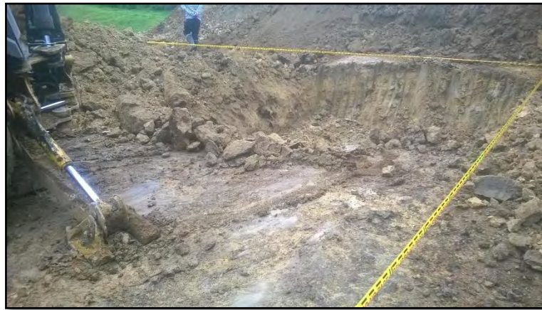
Figura 37. Excavación de humedal con maquinaria
