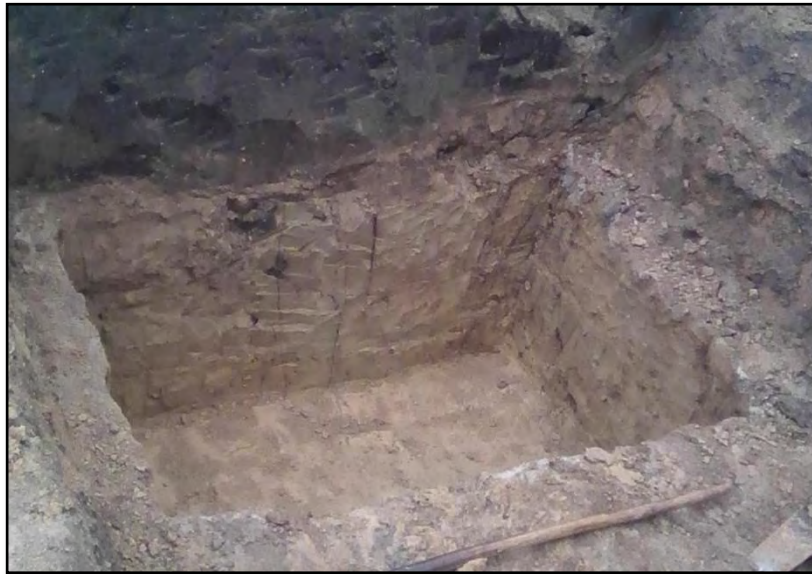
Figura 18. Perfilado de excavación para cámara de válvulas
