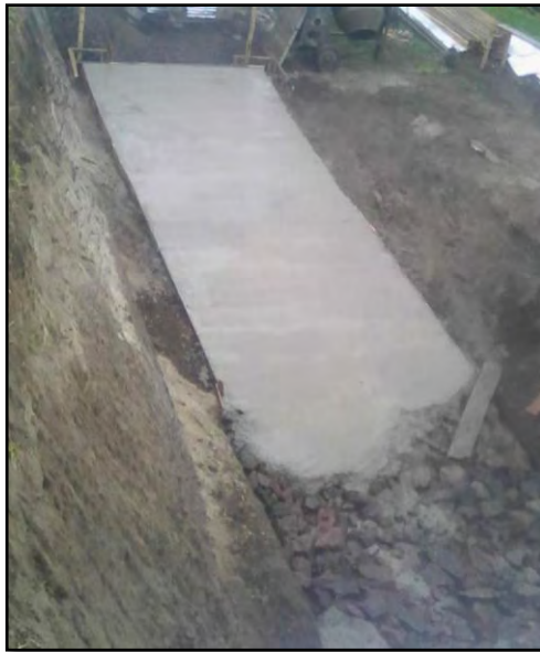
Figura 26. Fundición concreto ciclópeo
