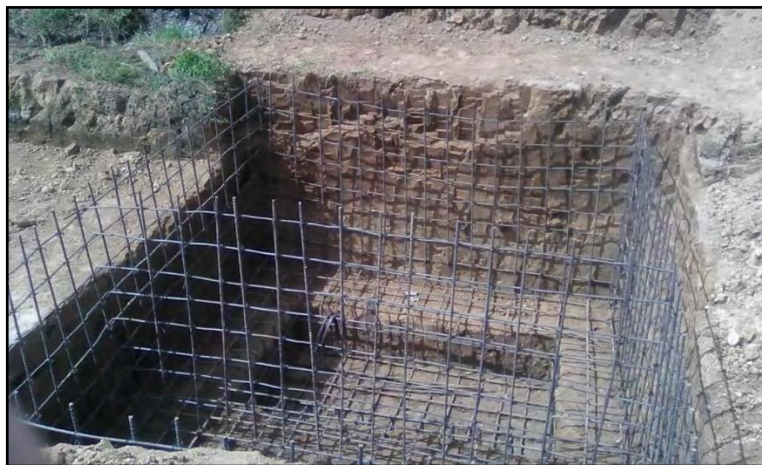
Figura 20. Armado de acero de refuerzo para caja de válvulas desarenador
