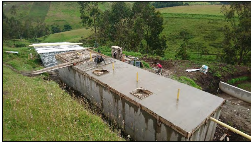
Figura 35. Losa de cubierta
