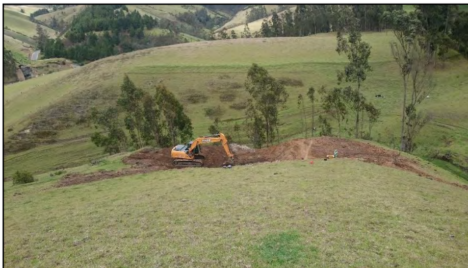
Figura 15. Maquinaria realizando explanaciones del terreno
