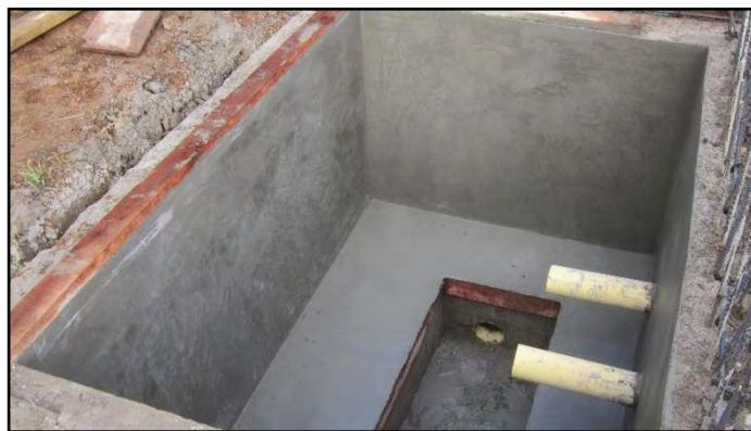
Figura 22. Fundición de cámara de válvulas del desarenador
