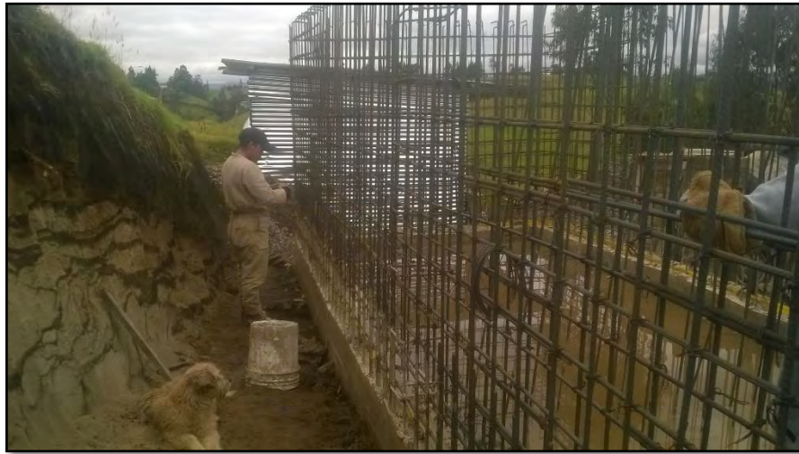
Figura 29. Acero de refuerzo de muros
