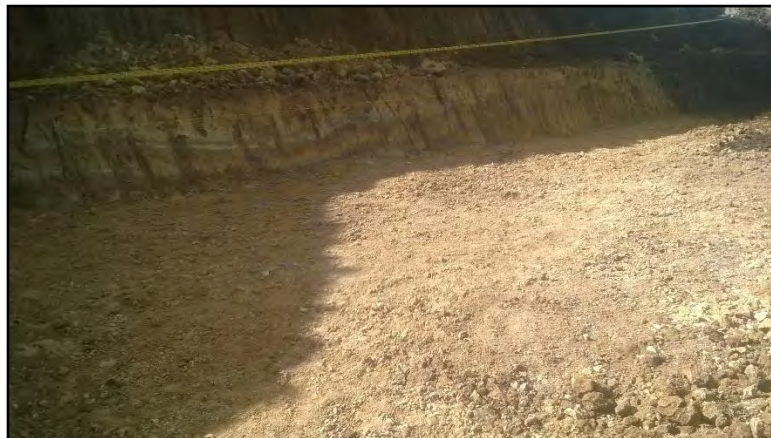
Figura 38. Perfilado de excavación de humedal
