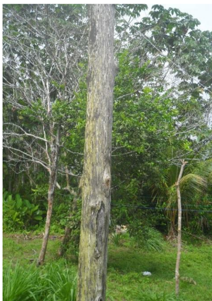
Figura 6. Hongos en los postes vereda El Naranjo
