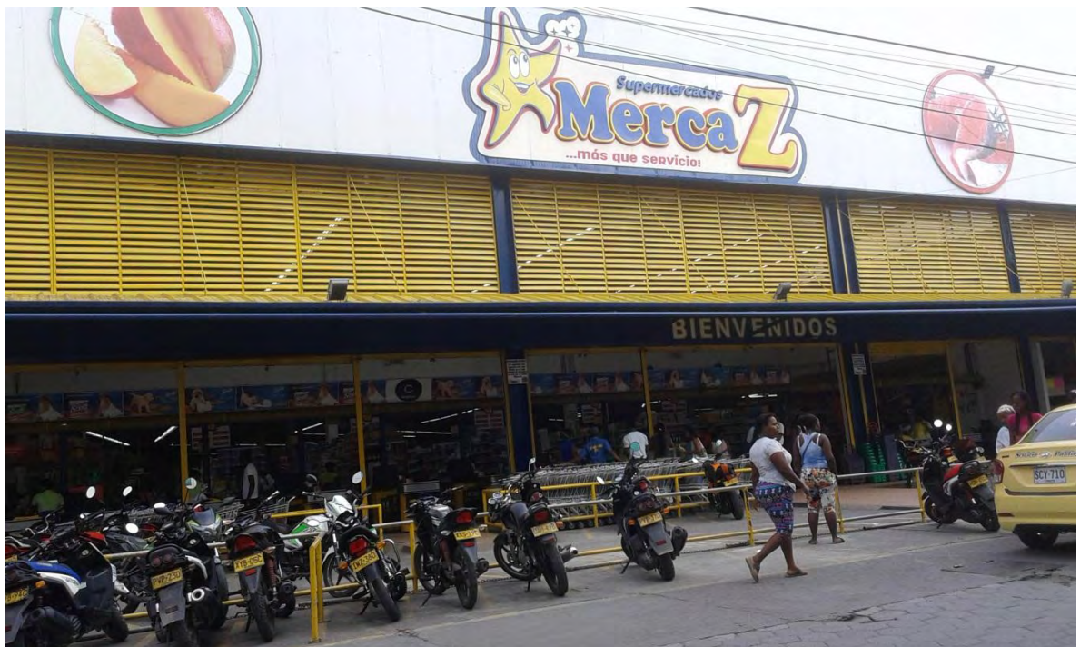
Figura 1. Fachada exterior del Autoservicio Merca Z.
