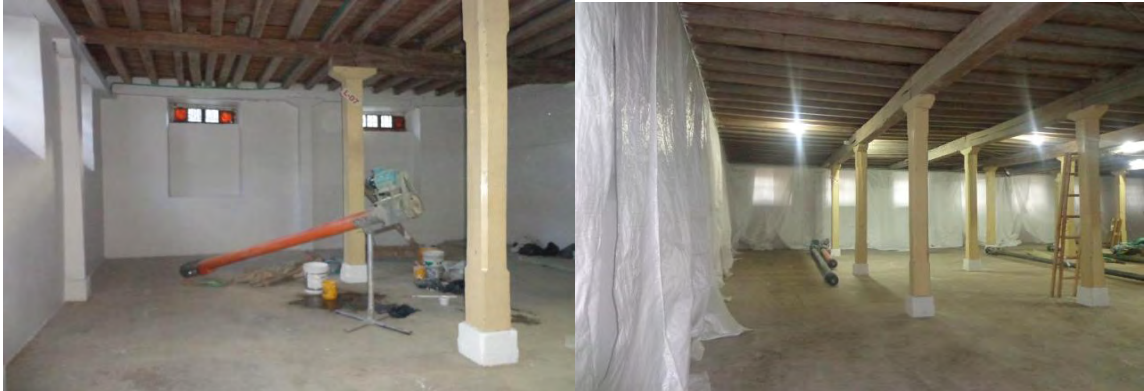
Figura 10. Limpieza, pintado, aislamiento y protección de bodega con plástico
