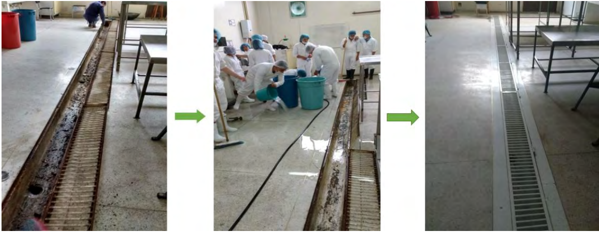
Imagen 22. Limpieza de desagües
