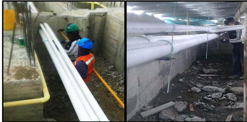
Figura 33. Instalación tubería red contra Incendios. Febrero 2017.
