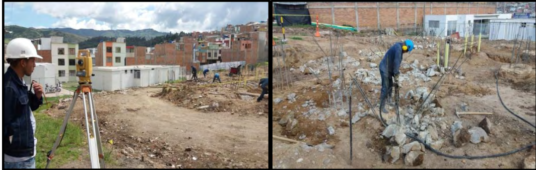
Figura 21. Nivelación del terreno descabece de pilotes. Diciembre de 2016
