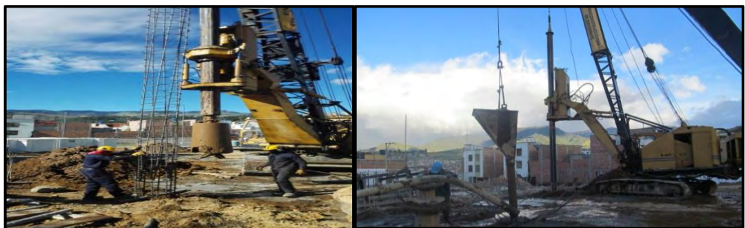
Figura 18. Instalación Acero de refuerzo y fundición de pilotes. Noviembre de 2016.
