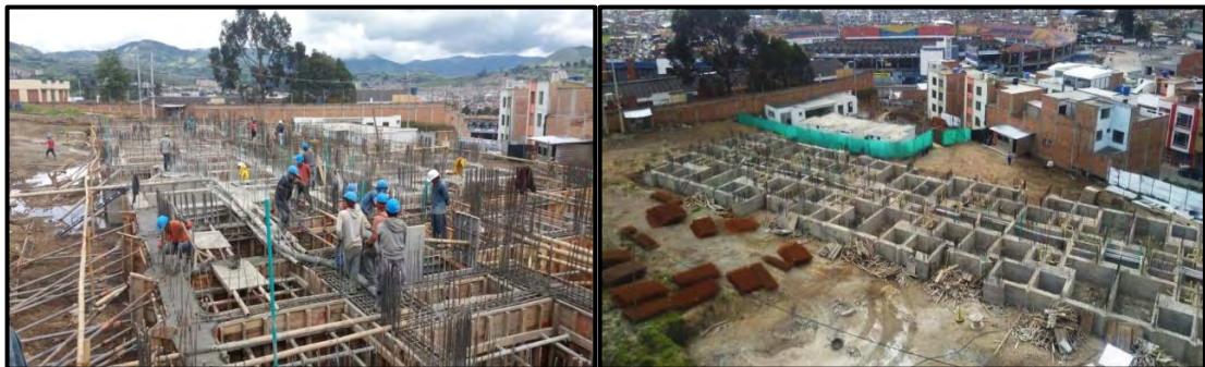
Figura 27. Proceso de fundición y terminación de dados y vigas de cimentación. Enero de 2017.
