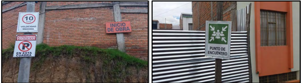
Figura 12. Señalización en la obra. Febrero 2017
