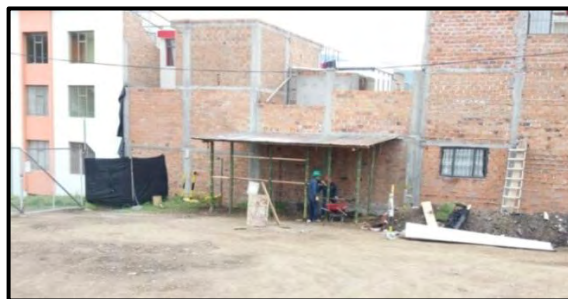
Figura 15. Construcción de campamento de 15 m 2 . Diciembre 2016.
