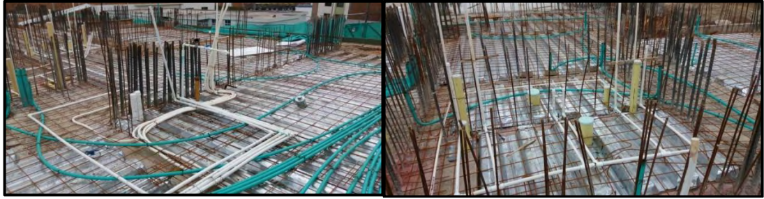
Figura 32. Instalaciones hidráulicas. Marzo 2017.
