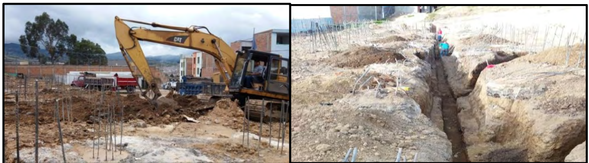
Figura 19. Excavación mecánica y manual para colector principal de aguas residuales. Diciembre de 2016.
