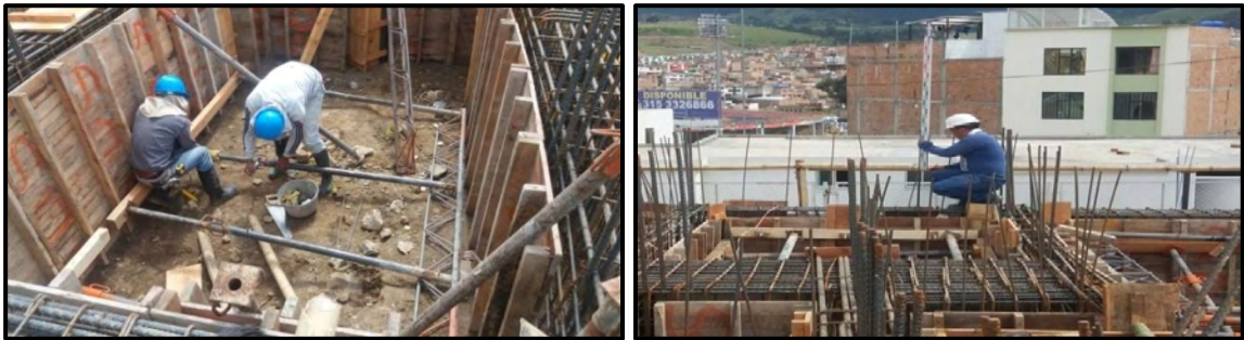
Figura 26. Encofrado y nivelación de vigas de cimentación. Diciembre de 2016.
