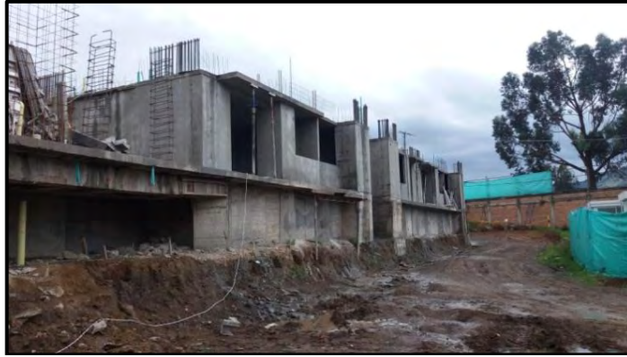
Figura 36. Estado de la obra en la finalización de la pasantía. Abril 2017.
