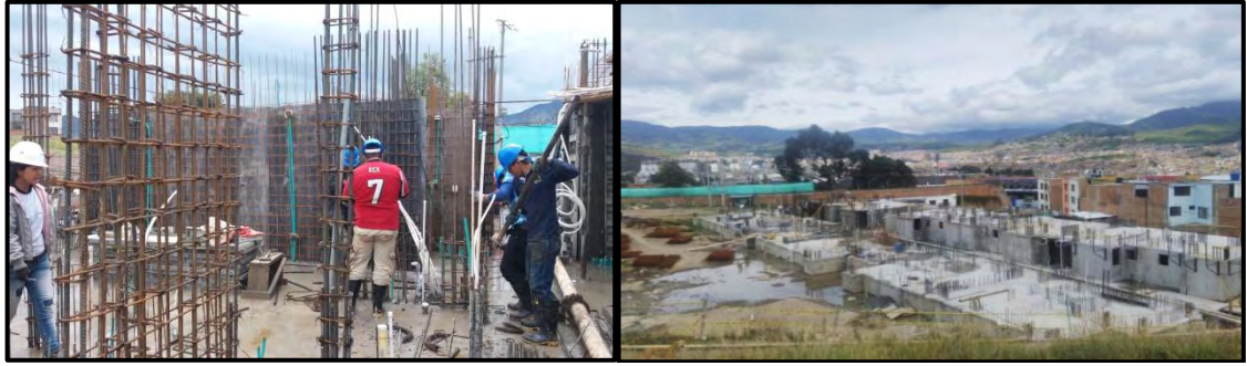
Figura 30. Armado de acero para muros estructurales. Abril 2017.
