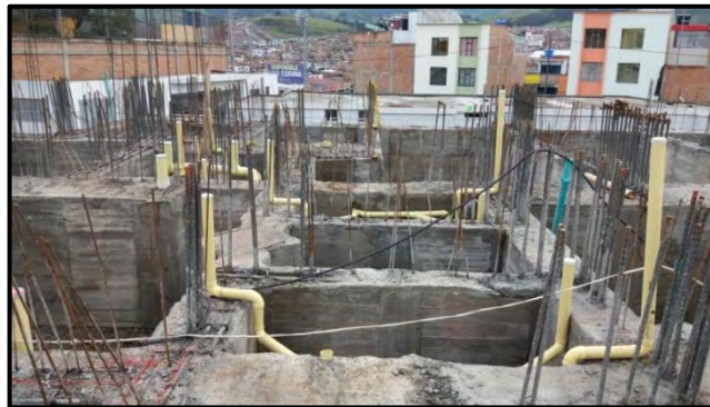
Figura 7. Pruebas de estanqueidad para tubería sanitaria. Enero 2017
