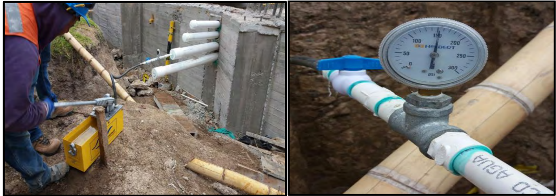
Figura 6. Pruebas hidrostáticas para tubería a presión. Febrero 2017
