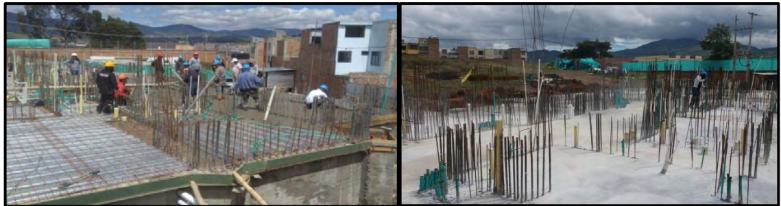
Figura 29. Fundición placa de contrapiso. Marzo 2017.
