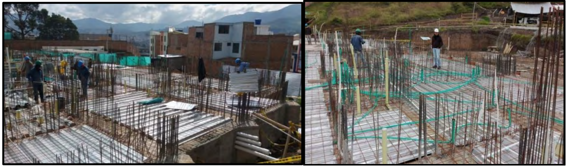
Figura 28. Instalación steel deck 3" y malla electrosoldada. Febrero 2017.
