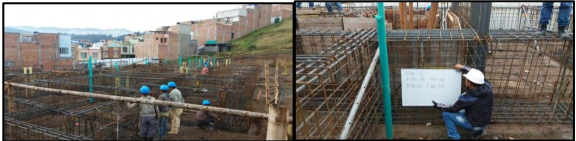
Figura 24. Amarre de vigas de cimentación y seguimiento para informe. Diciembre de 2016.
