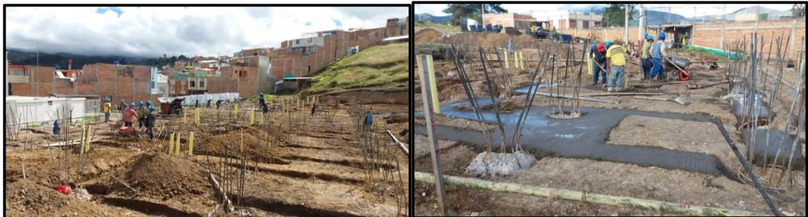
Figura 22. Excavación manual y fundición de solados de limpieza. Diciembre de 2016.
