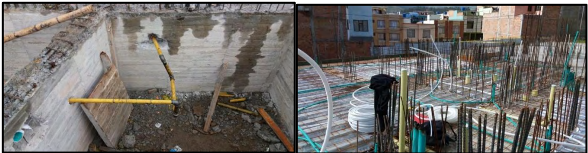
Figura 34. Tubería principal red de gas domiciliario en hierro galvanizado e instalación de tubería interna a los apartamentos. Marzo 2017.
