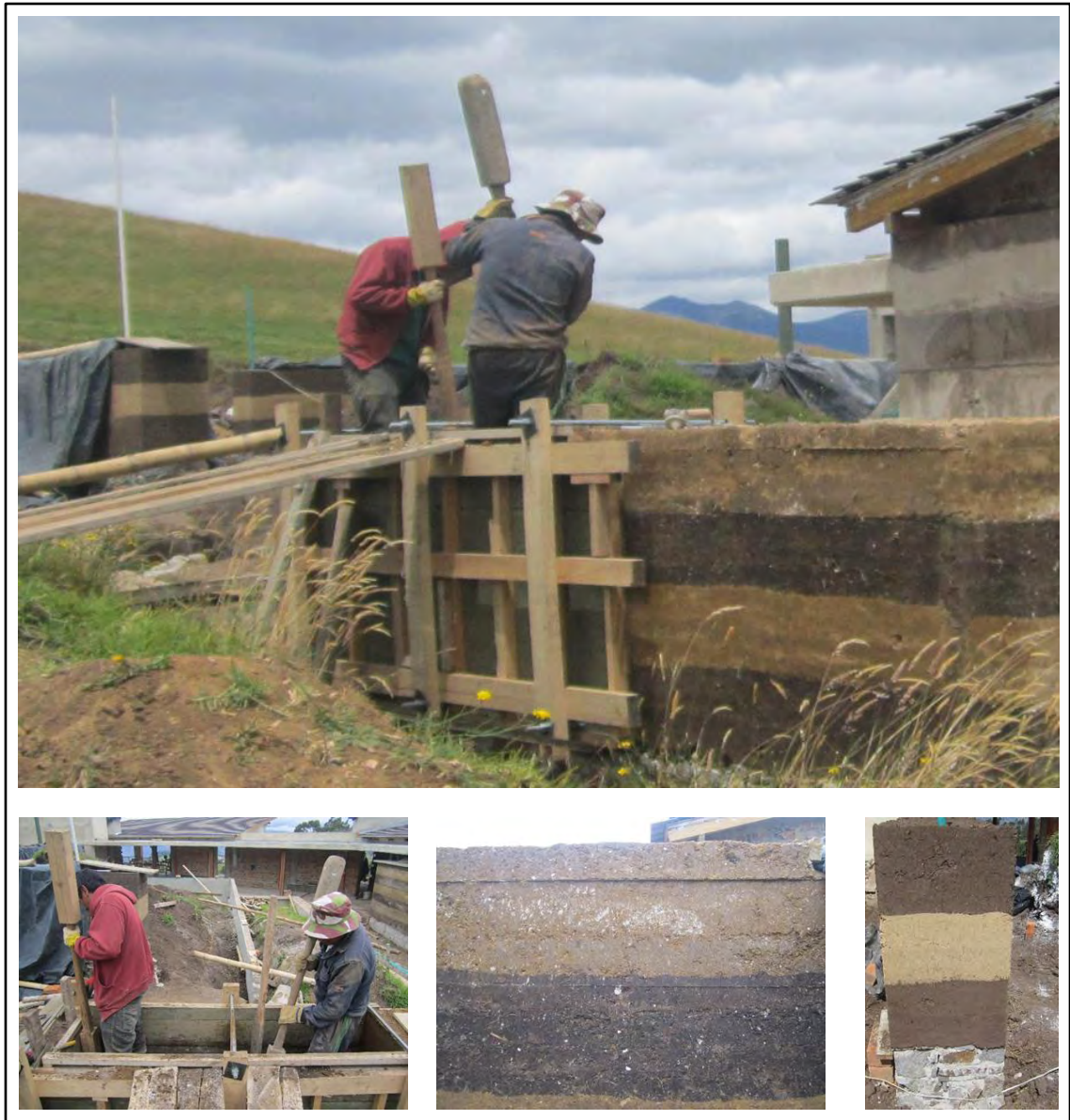
Figura 37. Proceso constructivo del muro en suelo apisonado
