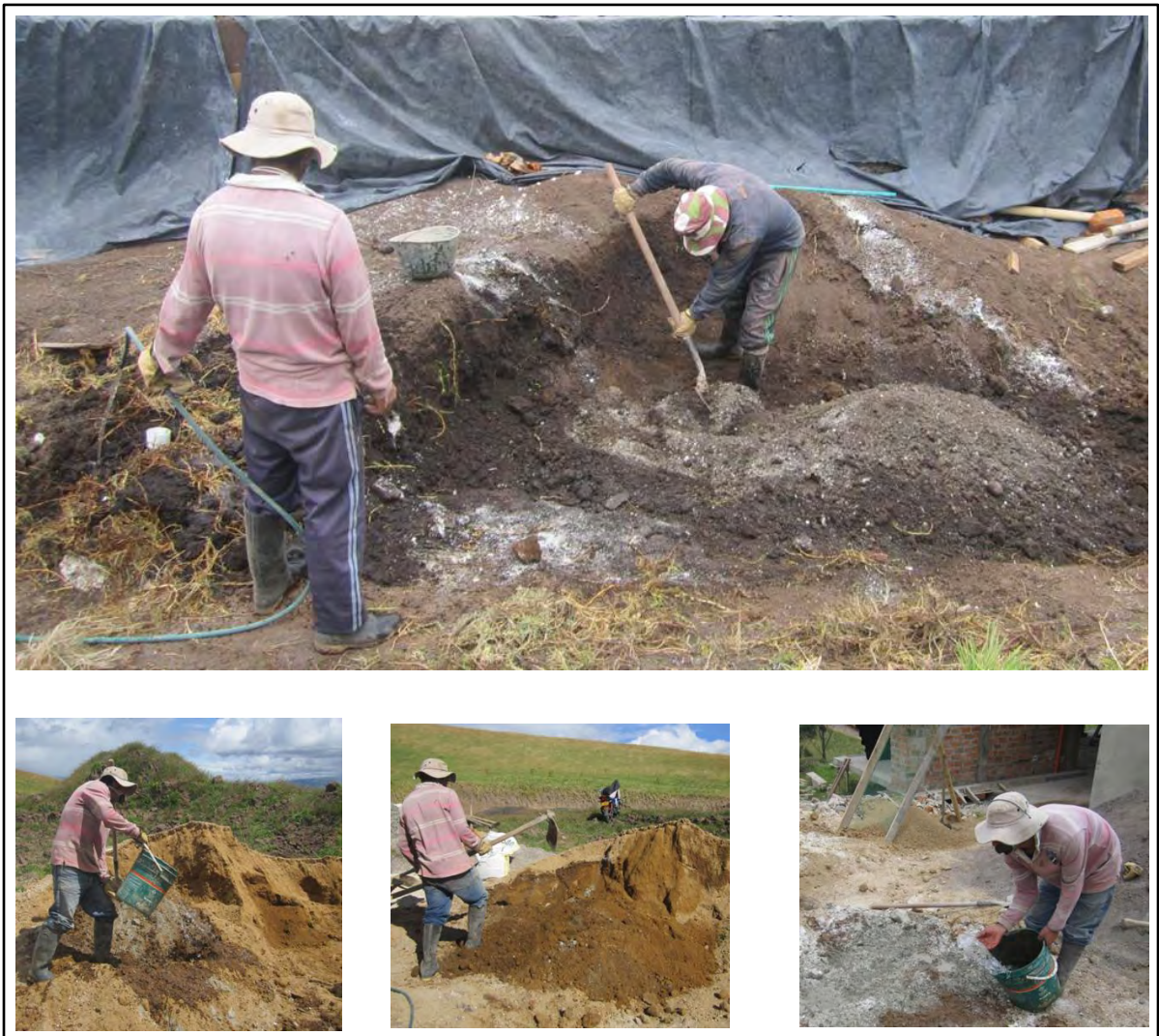
Figura 36. Proceso de humedecido del suelo en obra
