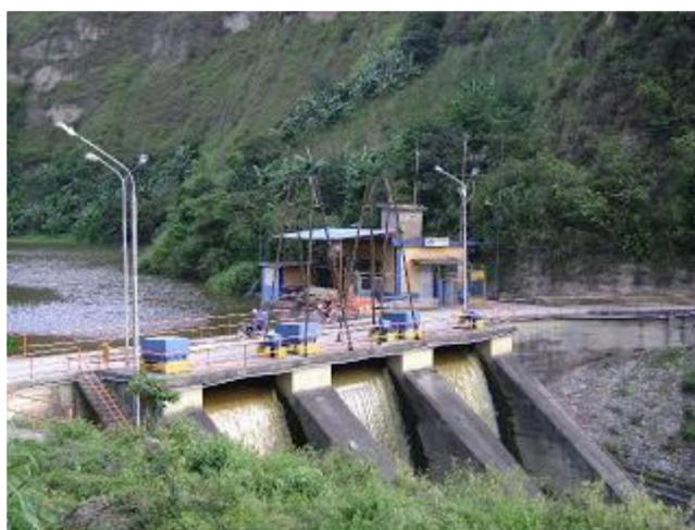
Imagen 3. Fotos de la Hidroeléctrica de San Pablo (N).
