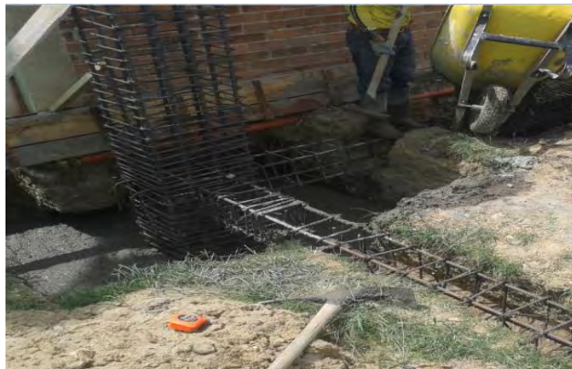
Concreto para vigas de cimentación de 3000 psi
