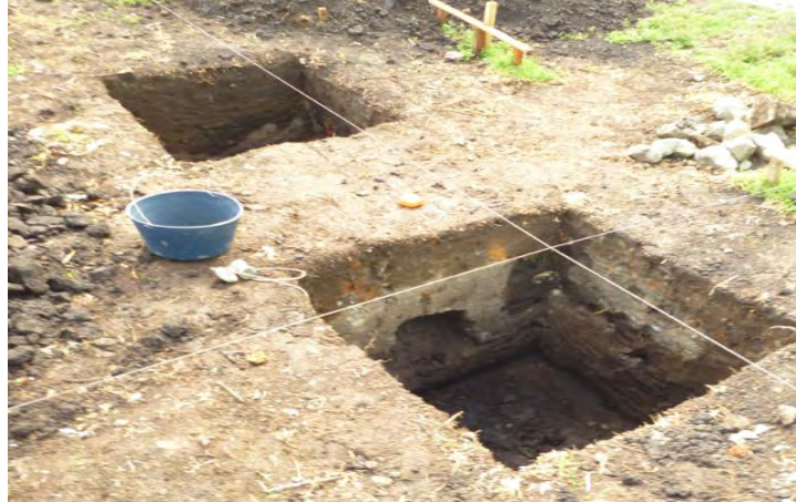
Figura 6. Excavación a mano en material conglomerado
