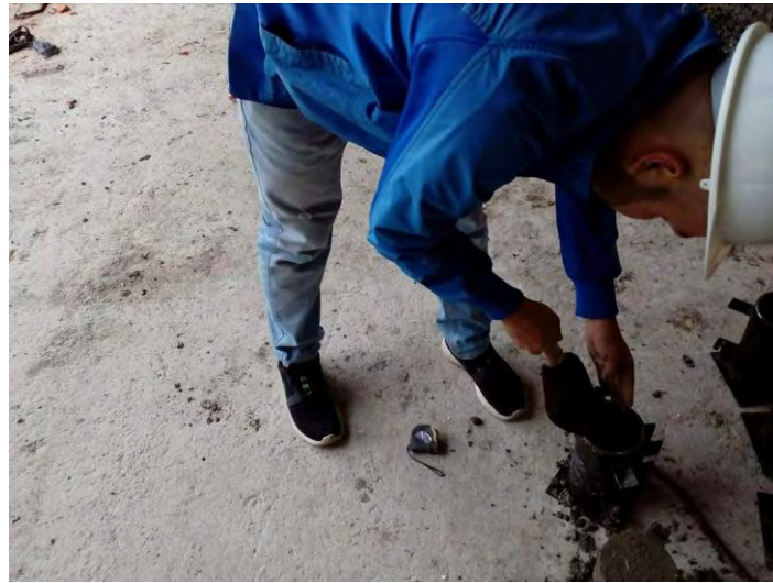
Figura 67. Toma de cilindros de concreto.
