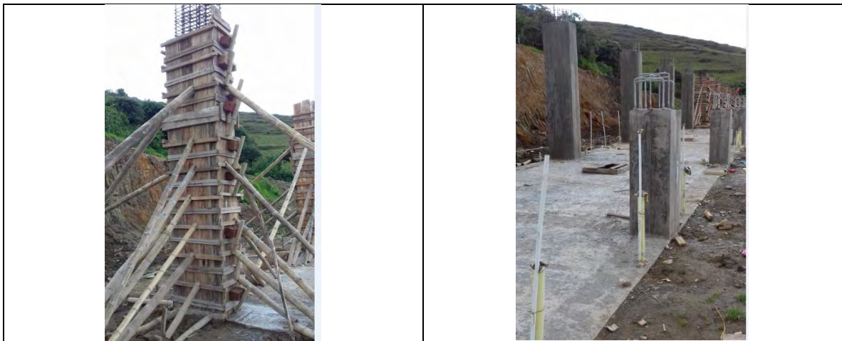
Figura 55,56. Formaleta, apuntalado y fundición de columnas 40*80 cm.
