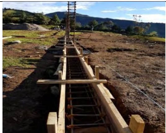
Figura 19. Formaleta y fundición vigas cimentación cerramiento zona oriental.
