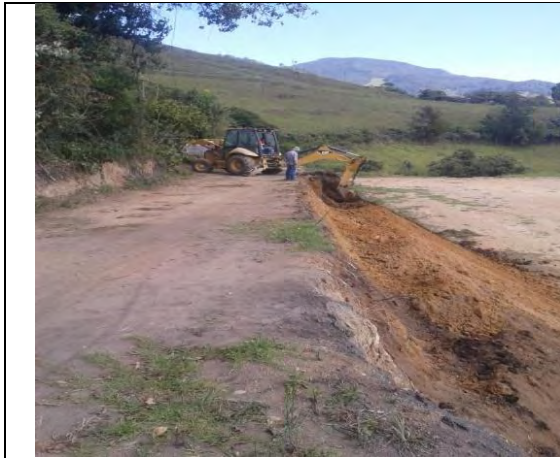
Figura 3. Excavación graderías zona occidental.
