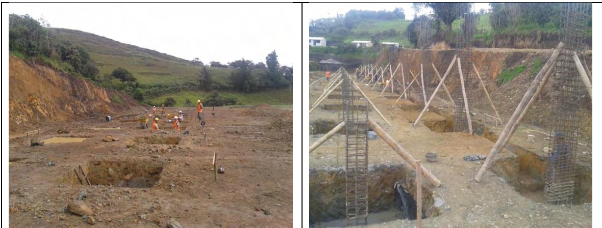
Figura 43,44. Excavaciones zapatas y vigas de cimentación de graderías.
