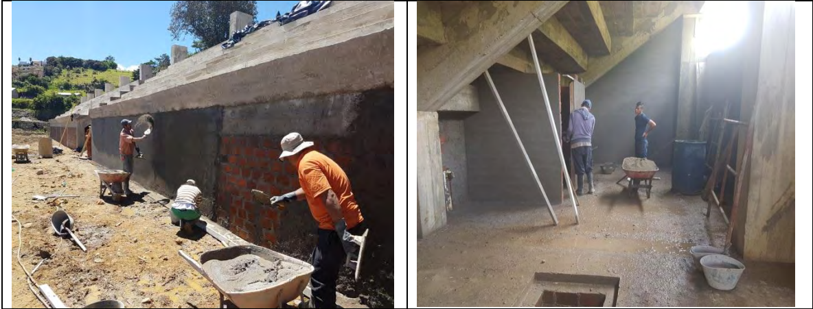
Figura 38,39. Repellos de muros y pisos externos e internos de las tribunas.
