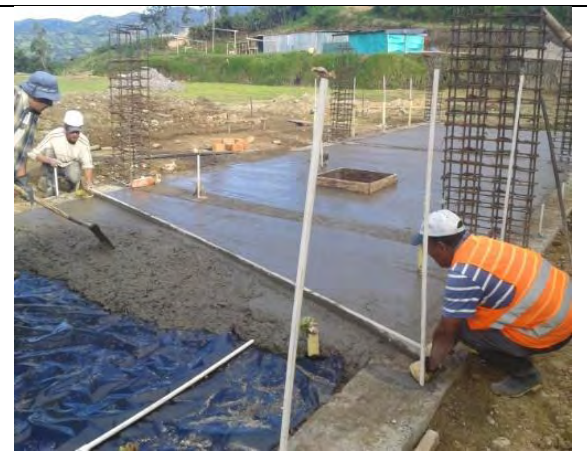
Figura 31. Fundición placa de piso e: 8cm.
