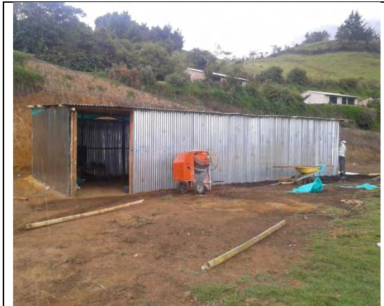
Figura 5. Construcción campamento de obra.
