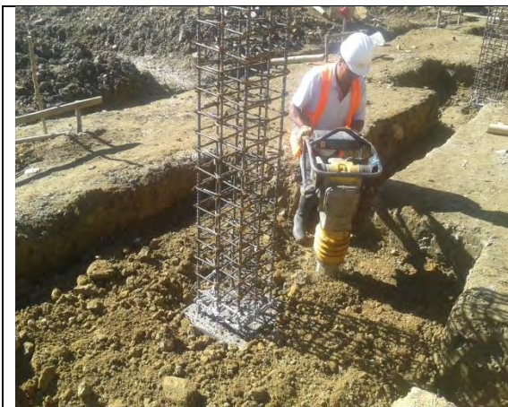
Figura 6. Relleno y compactación zapatas.
