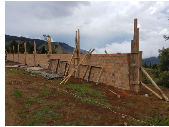
Figura 20. Fundición de columnas de cerramiento con tubos para malla eslabonada.
