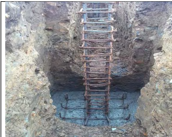
Figura 18. Fundición solado, parrilla y castillo columnas cerramiento.
