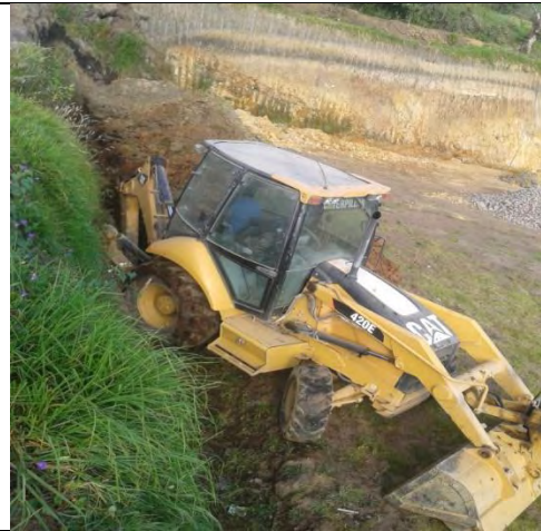
Figura 4. Excavación filtro 2, zona sur.
