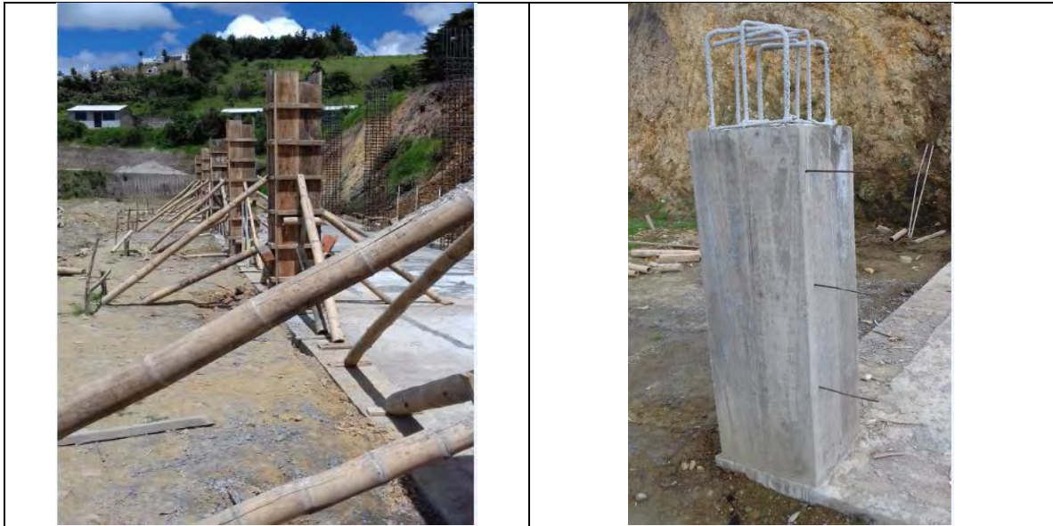
Figura 53,54. Formaleta y fundición columnas 45*45 cm.
