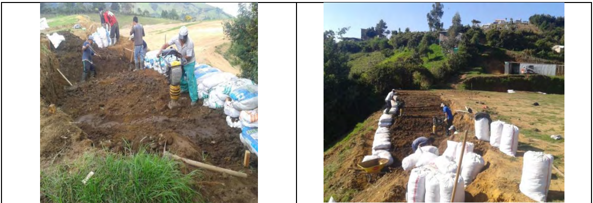
Figura 15,16. Excavación, relleno, conformación terraplén y mejoramiento con estopas zona oriental.
