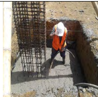
Figura 48. Fundición zapatas de las graderías.
