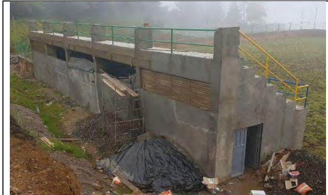
Figura 42. Instalación pasamanos, puertas, ventanas tipo persianas.
