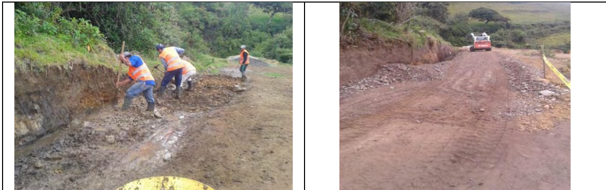
Figura 9,10. Conformación y mejoramiento vía de acceso.
