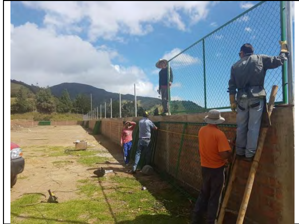
Figura 66. Instalación malla de cerramiento.
