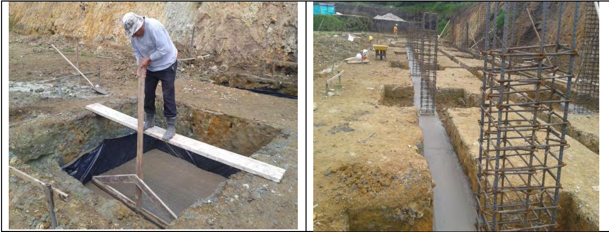
Figura 45,46. Fundición solados de zapatas y vigas de cimentación de tribunas.
