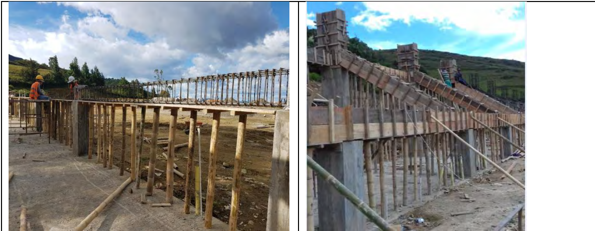
Figura 57,58. Armado y fundición vigas aéreas de graderías.
