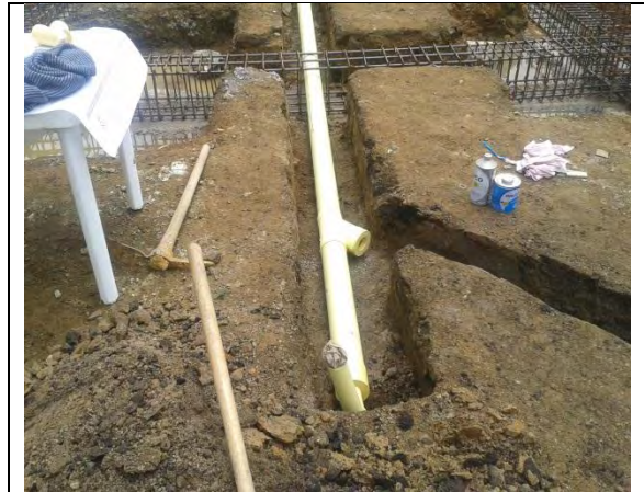
Figura 29. Excavaciones e instalación sanitaria.
