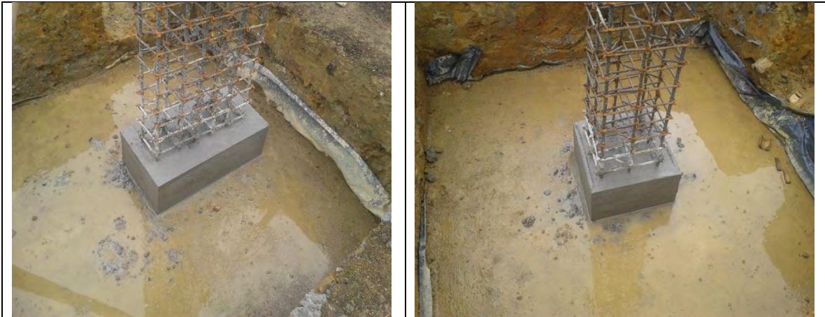
Figura 49,50. Fundición de pedestales zapatas de graderías.
