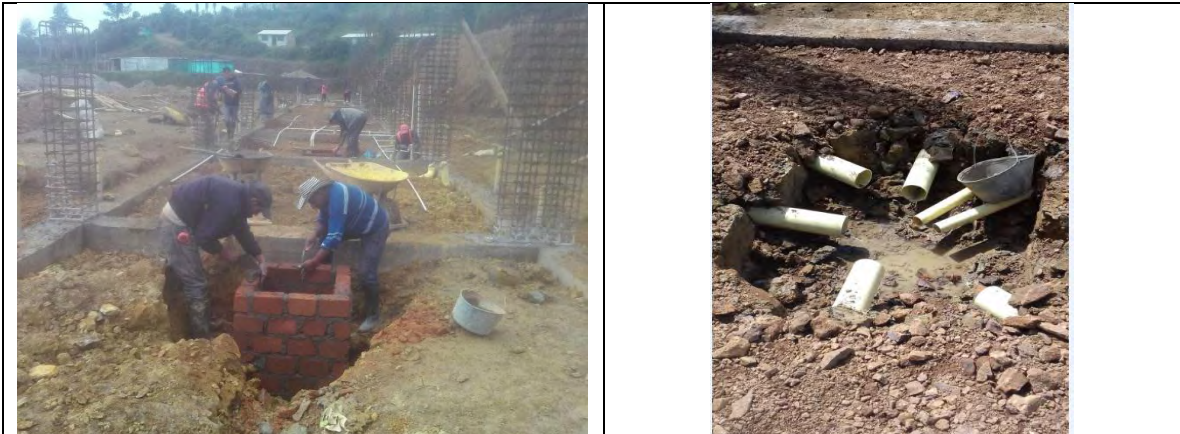
Figura 32,33. Cajas de inspección 60*60 batería sanitaria.
