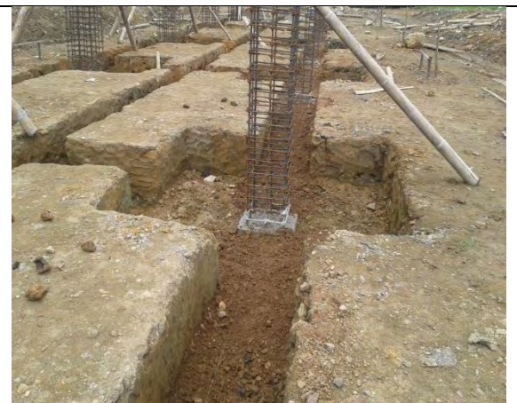
Figura 7. Relleno recebo compactado para vigas de cimentación.
