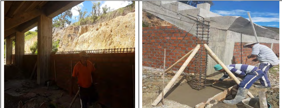
Figura 34,35. Instalación mampostería de la batería sanitaria.
