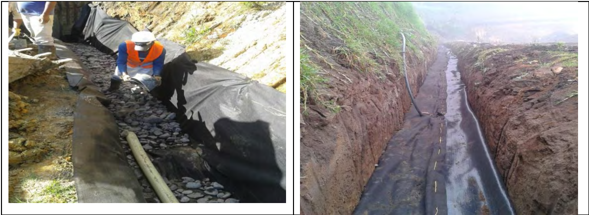
Figura 13,14. Construcción y terminado de filtros.
