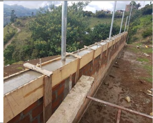
Figura 21. Fundición viga aérea de cerramiento.
