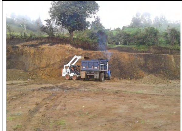
Figura 8. Desalojo carga, zona gradería.
