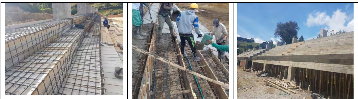
Figura 59, 60,61. Armado y fundición de graderías.
