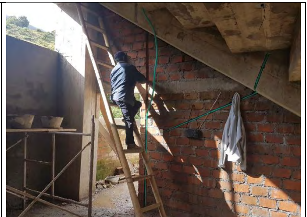
Figura 41. Regatas sobre muros internos de las baterías sanitarias.
