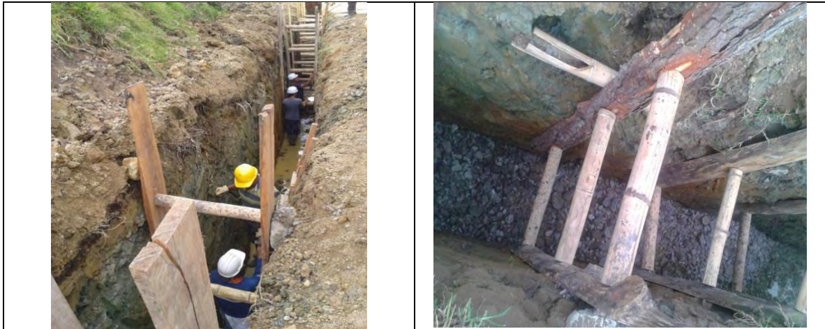
Figura 11,12. Estabilidad excavación filtros (Entibado) e instalación cama triturado filtro 1 zona occidental.
