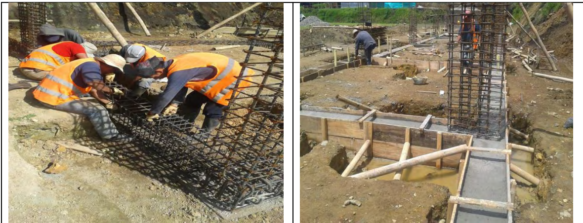
Figura 51,52. Armado y fundición de vigas de cimentación de graderías.
