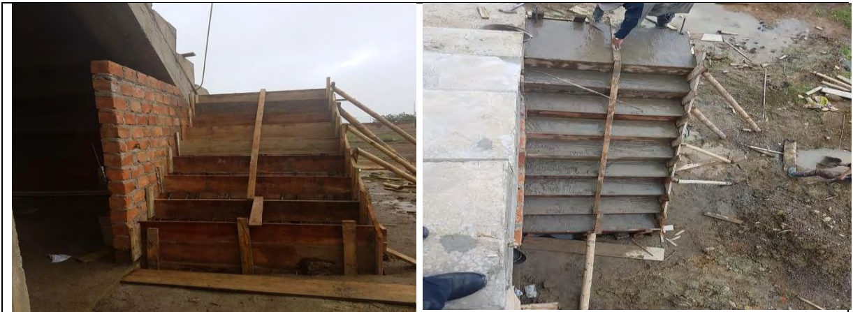
Figura 62,63. Formaleta y fundición gradas de acceso.
