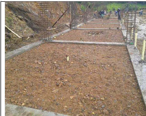
Figura 30. Nivelación de piso recebo compactado.
