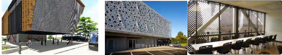
Figura 106. Piel del edificio.
