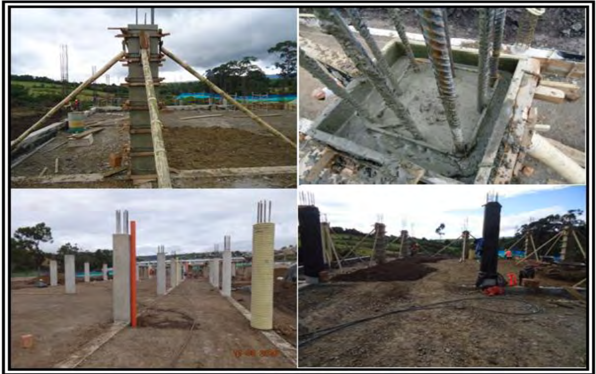
Figura 22. Procedimiento constructivo columnas de 0.30 m x 0.35 m
