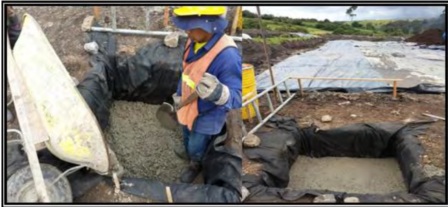
Figura 16. Concreto de limpieza zapatas
