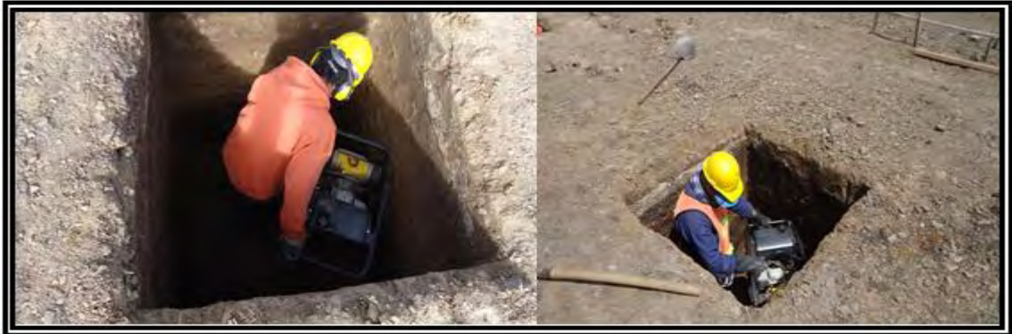
Figura 13. Relleno compactado con recebo
