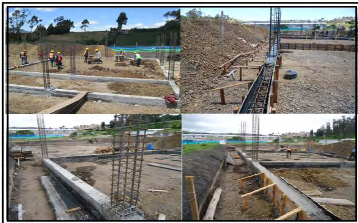
Figura 19. Procedimiento constructivo vigas de cimentación
