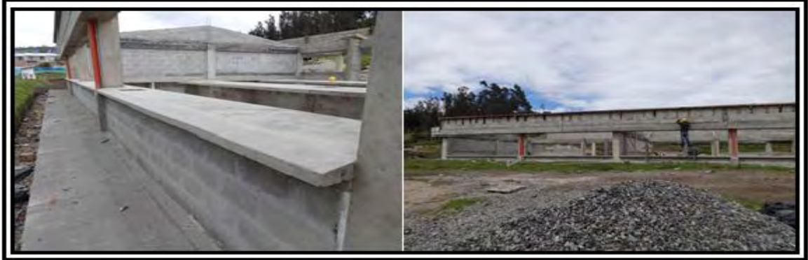
Figura 28. Procedimiento constructivo alfajías en concreto 3000 psi
