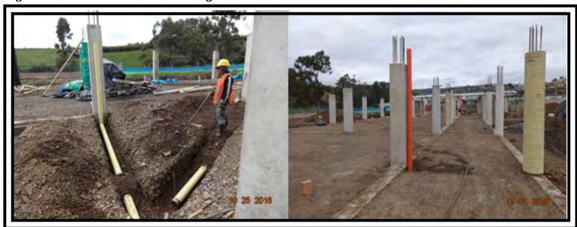
Figura 42. Instalación tubería de aguas lluvias de 4"
