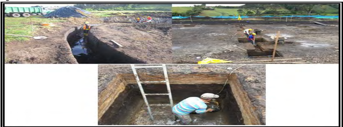
Figura 12. Excavación en material común
