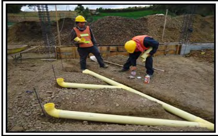
Figura 40. Instalación tubería sanitaria de 4"
