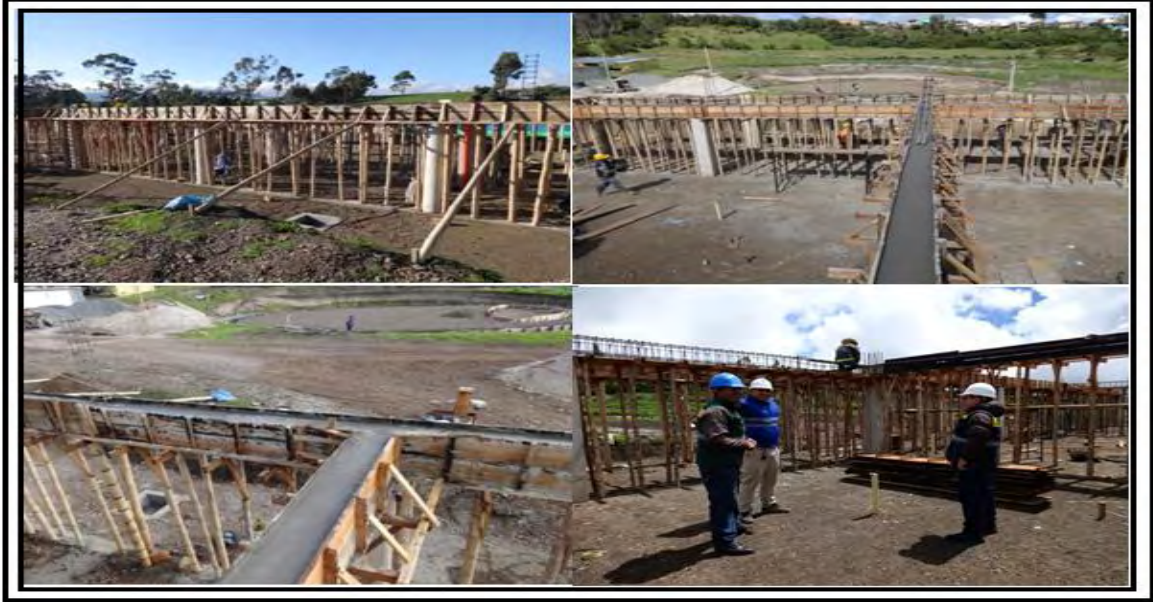
Figura 20. Procedimiento constructivo viga aérea
