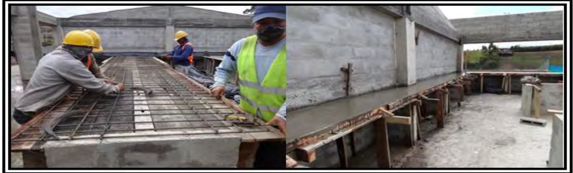
Figura 26. Procedimiento constructivo mesones en concreto b=0,60 m, e= 0,8 m.
