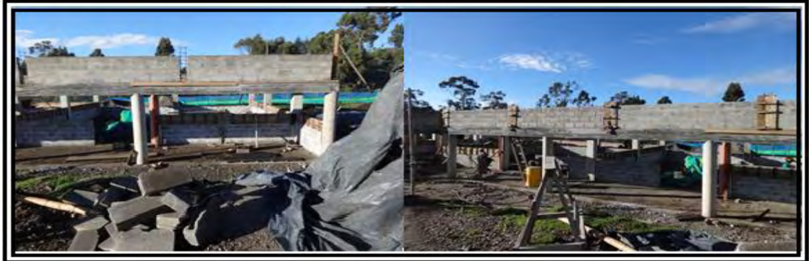
Figura 23. Procedimiento constructivo columnetas de 0.10 x 0.20 m
