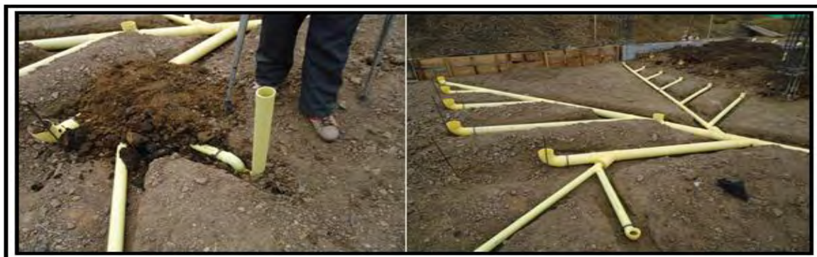
Figura 39. Instalación tubería sanitaria PVC 2"
