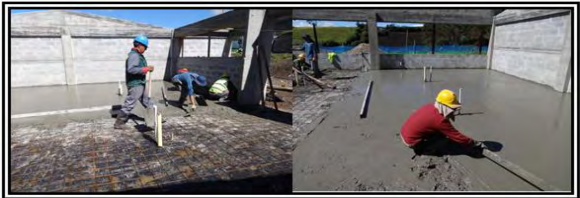
Figura 34. Procedimiento constructivo placa de pisos
