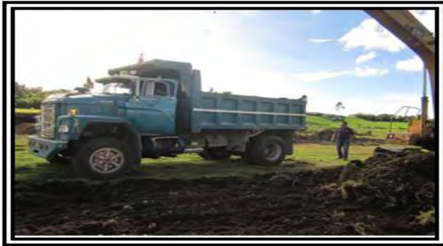
Figura 9. Retiro de sobrantes
