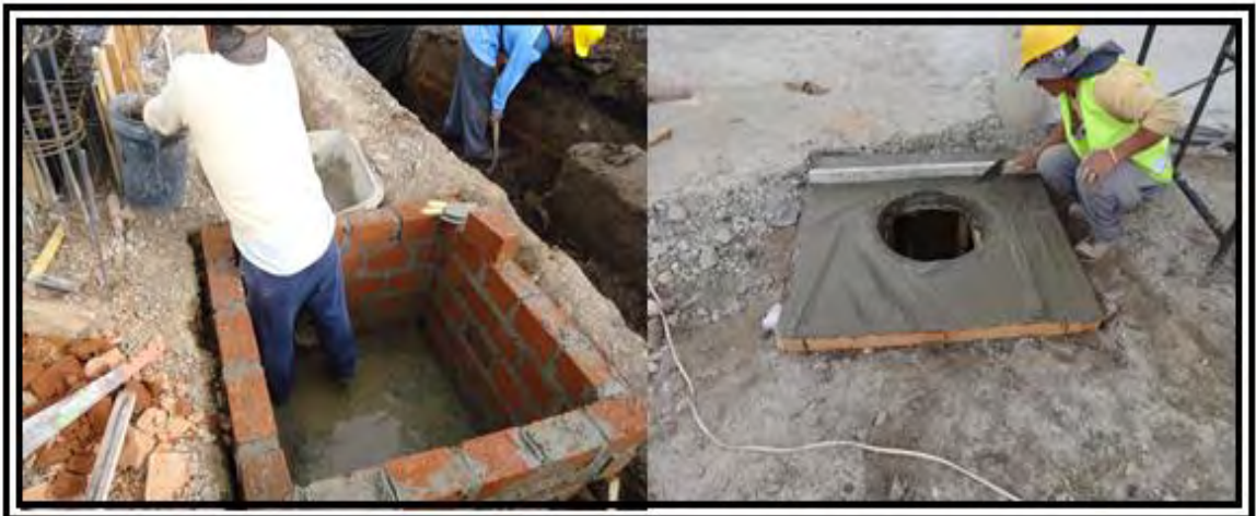
Figura 47. Construcción cajilla sanitaria 1,0 m x 1,0 m.
