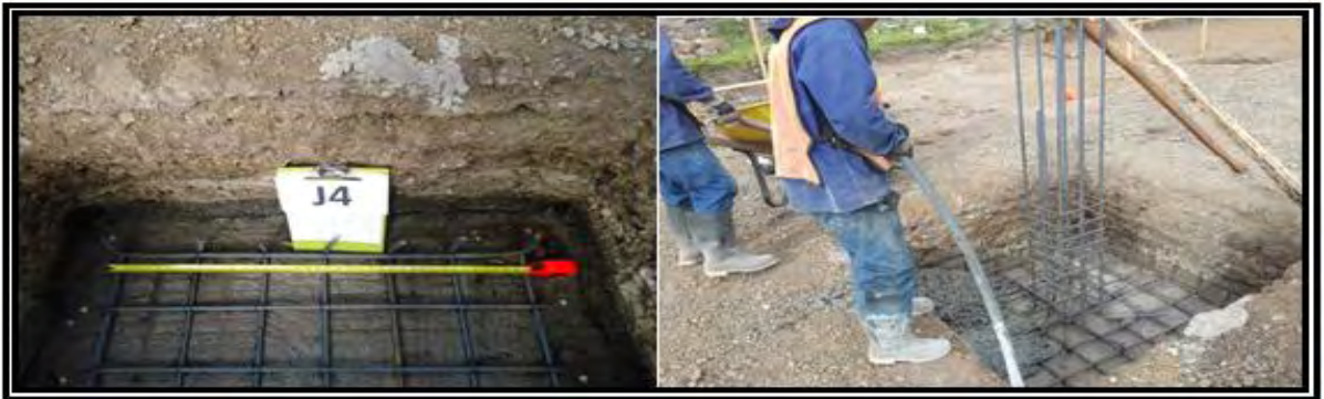
Figura 17. Concreto de Zapatas
