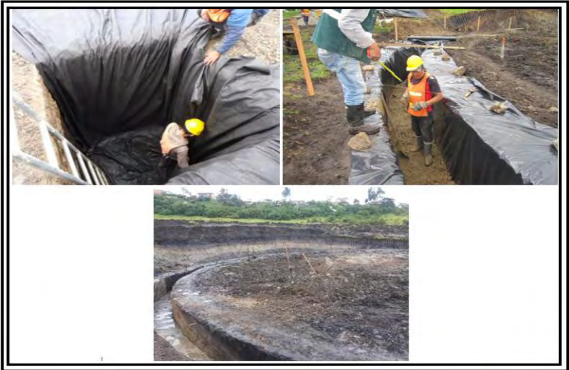
Figura 14. Mejoramiento suelo cemento
