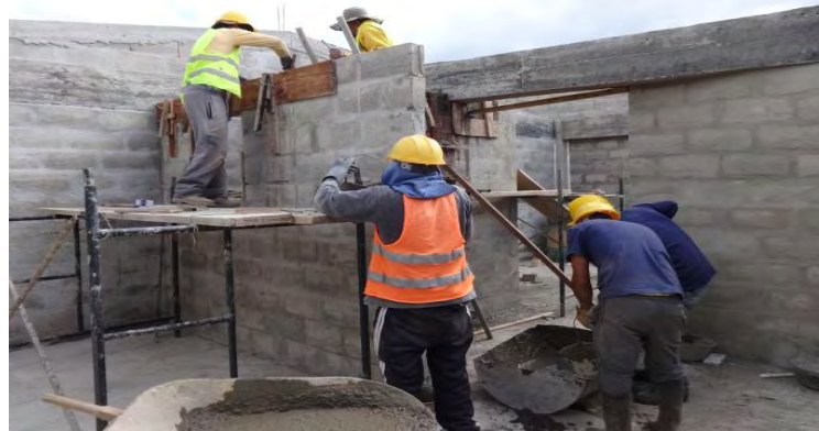
Figura 27. Procedimiento constructivo dinteles en concreto 3000 psi
