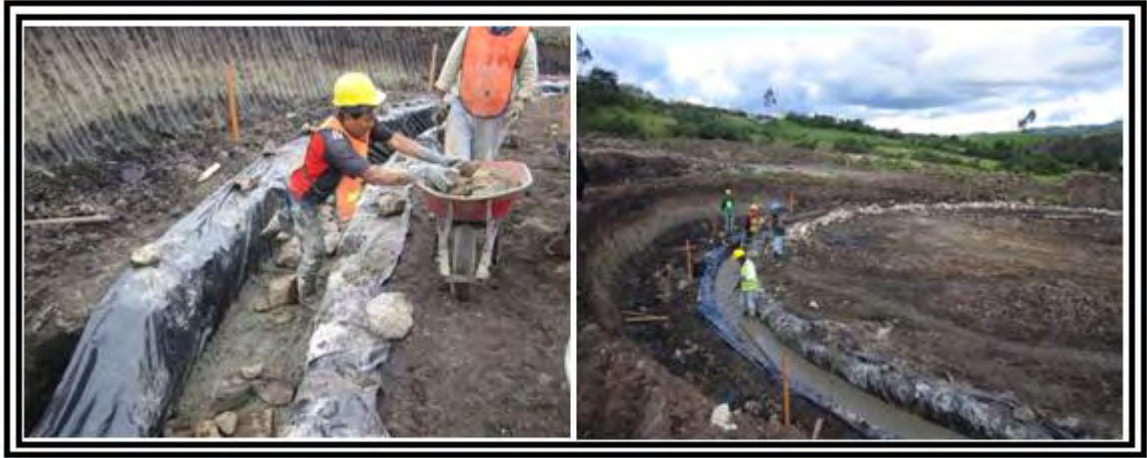
Figura 15. Mejoramiento suelo cemento
