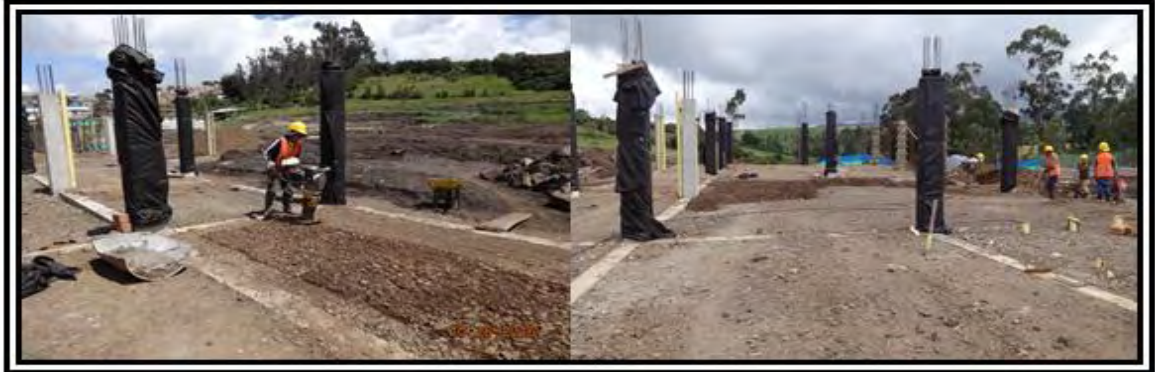
Figura 33. Procedimiento constructivo relleno compactado con recebo e= 0.40 m
