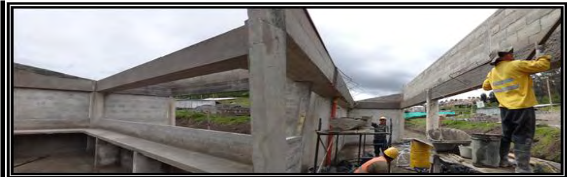
Figura 32. Procedimiento constructivo repello vigas aéreas.
