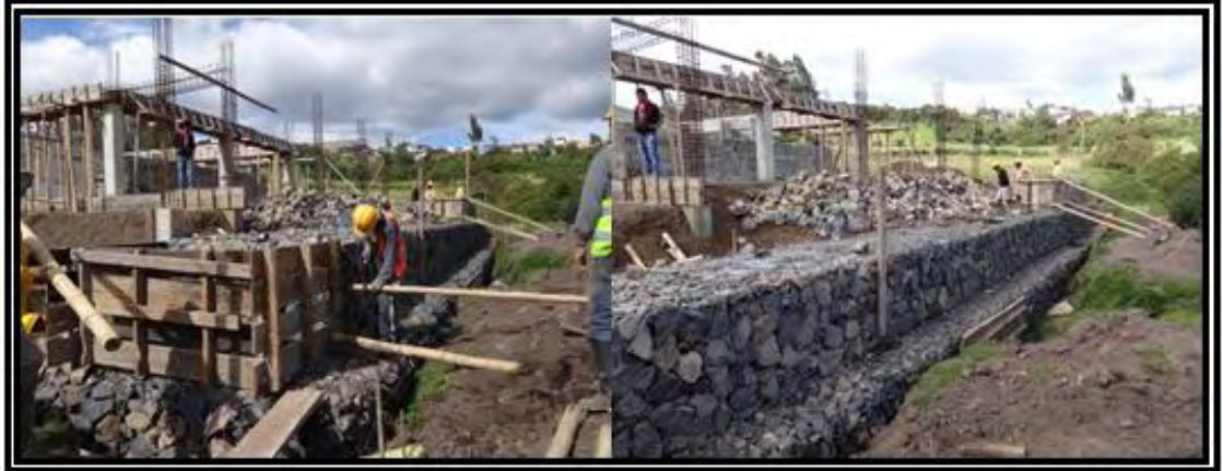
Figura 50. Proceso construcción muro de contención en Gavión
