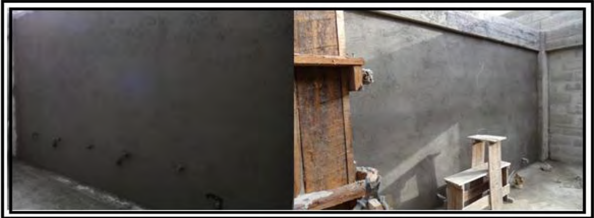
Figura 31. Procedimiento constructivo repello muros.
