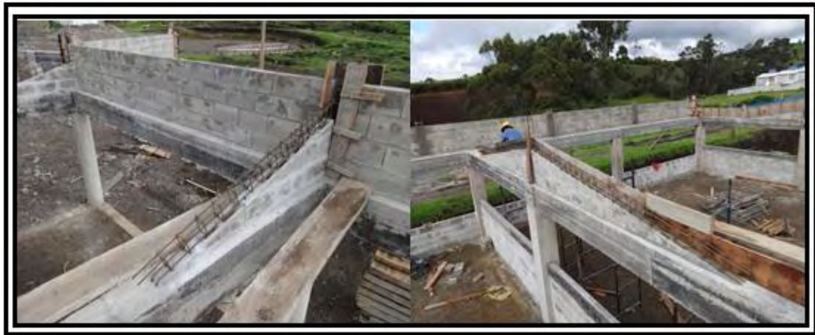
Figura 21. Procedimiento constructivo viga de remate 0.10 x 0.20 m
