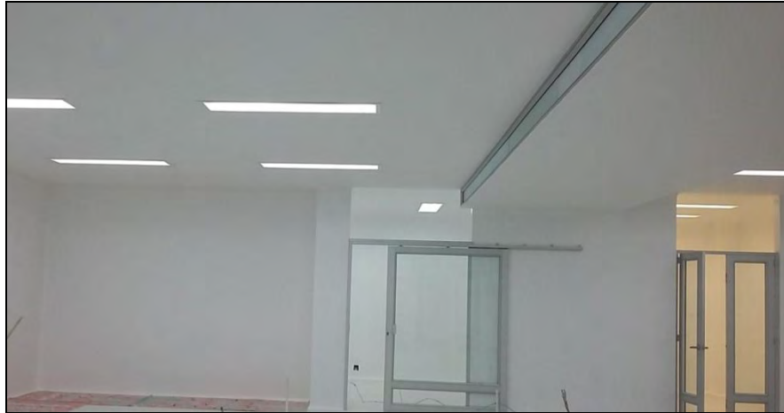
Figura 8. Terminado de cielo raso en fibrocemento descolgado - Anfiteatro.
