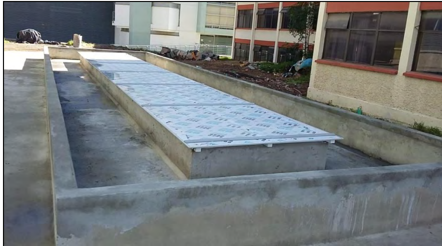
Figura 12. Instalación de estructura de cubierta y lámina alveolar - Anfiteatro.
