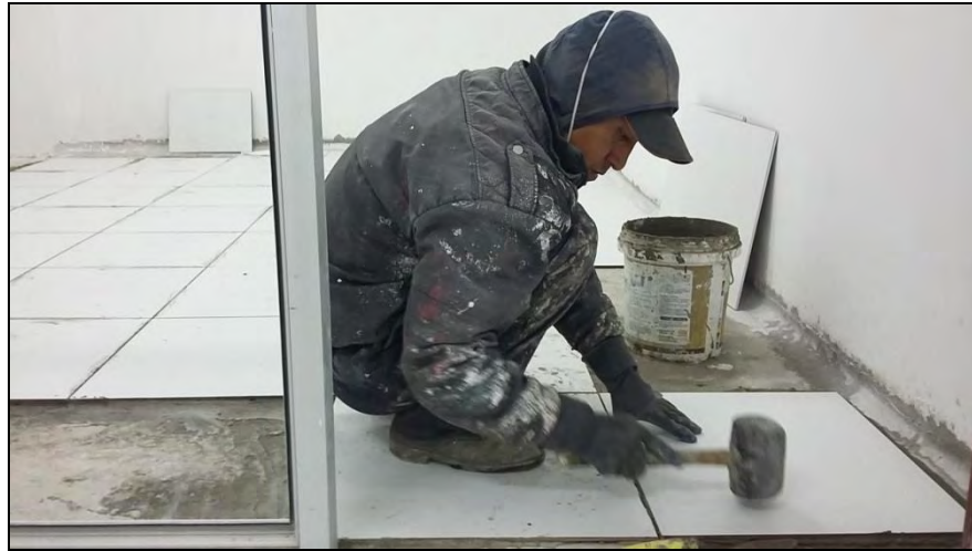
Figura 13. Instalación enchape de piso en cerámica 51x51 ártica blanca - Anfiteatro.
