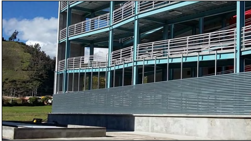
Figura 17. Muro en ladrillo tipo farol y alfajía en concreto - Anfiteatro. Nivel N + 0.00
