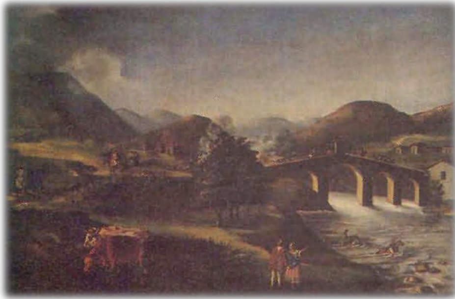
Figura 39. Puente Juanambú completo
