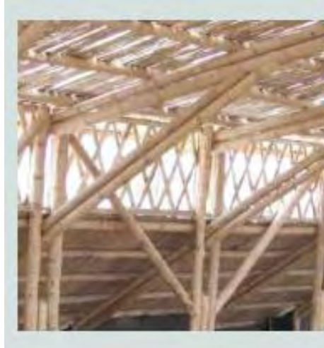
Figura 54. Estructura interna de espacios
