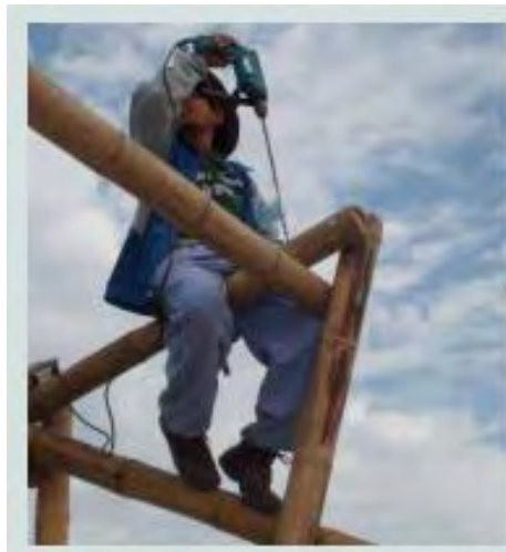
Figura 53. Armado in situ de estructura general
