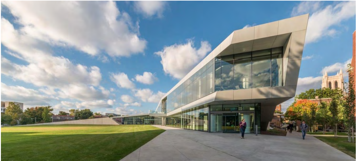
Figura 14: Vista exterior Centro Universitario Tinkham Veale.
