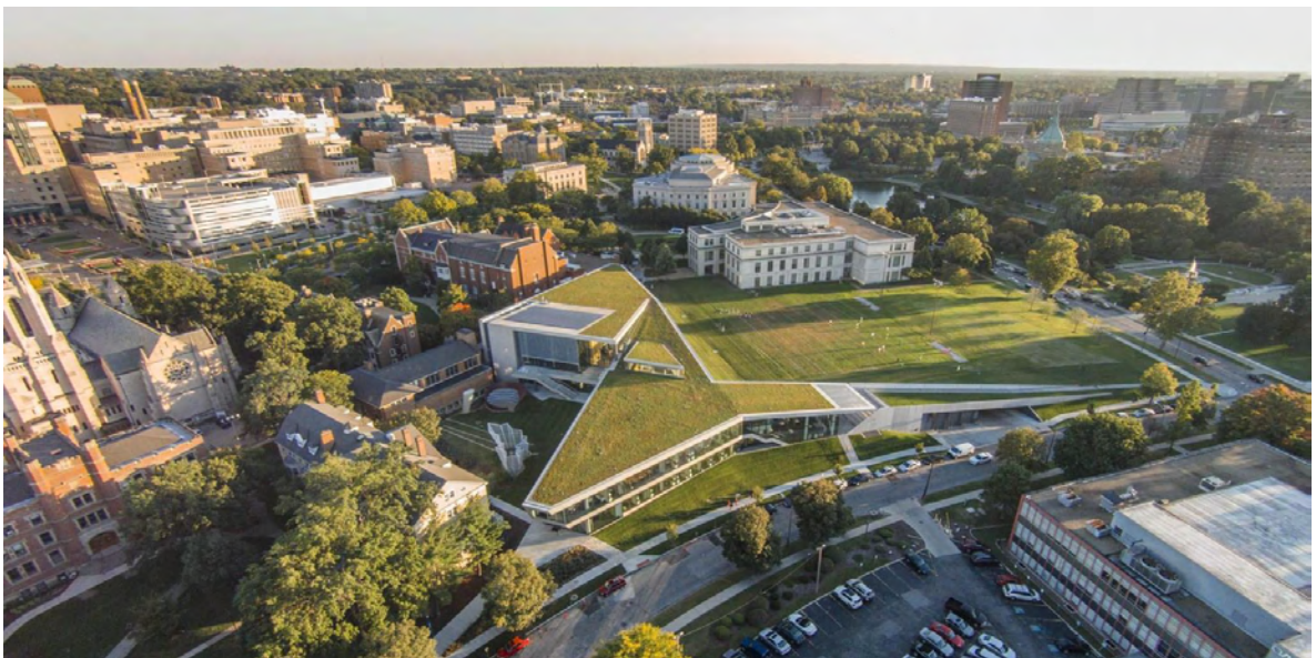
Figura 15: Vista exterior Centro Universitario Tinkham Veale.
