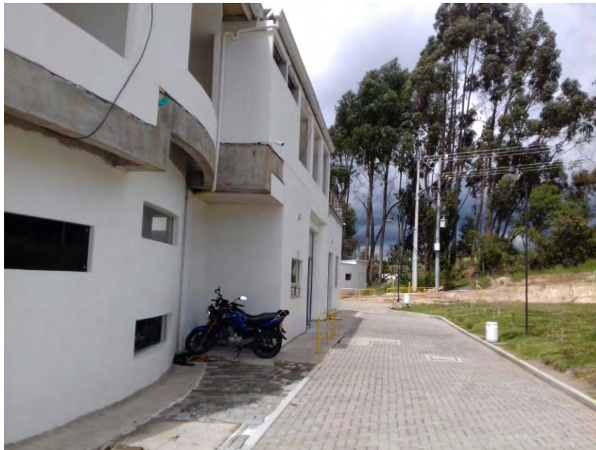
Figura 49. Circuito cámara IP Estación de salida
