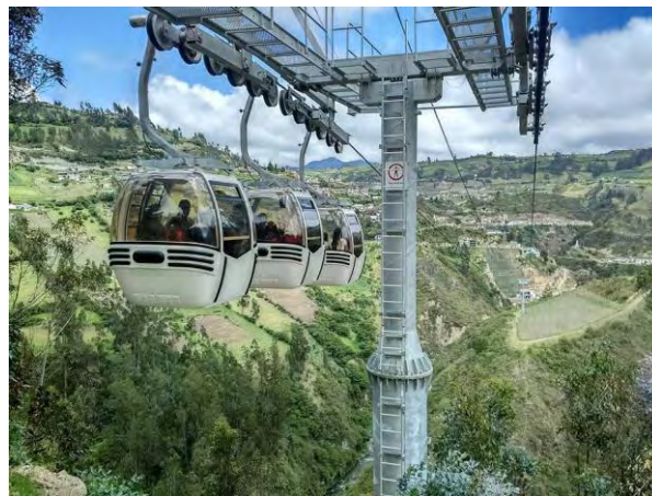
Figura 52. Torre Estación intermedia
