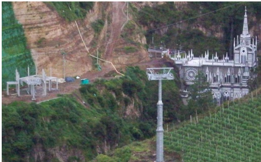
Figura 18. Estación de llegada en Construcción
