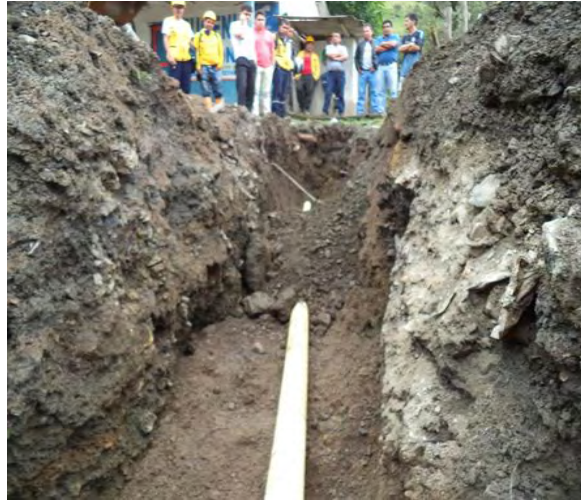
Imagen 92. Colocación de la nueva tubería en Novafort.
