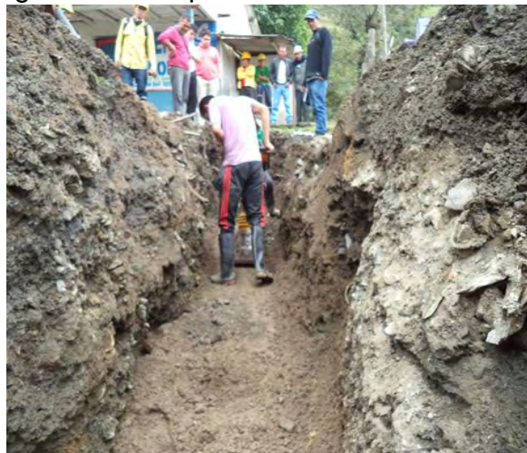
Imagen 103. Compactación de suelo de relleno.
