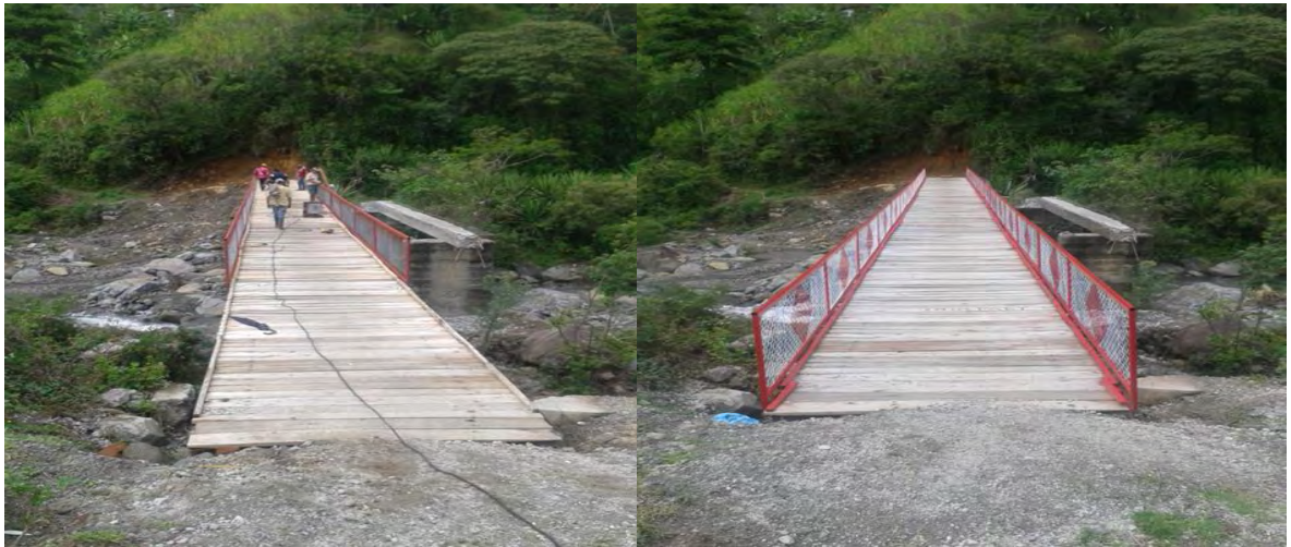
Imagen 2418 Instalación barandas de seguridad.
