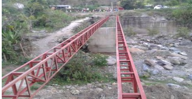
Imagen 162. Puente peatonal vereda pueblo viejo.
