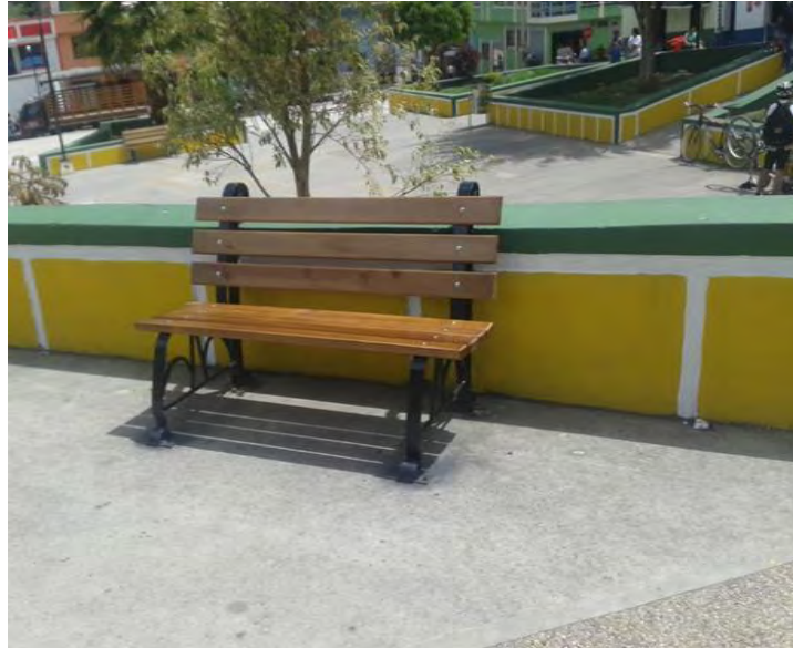
Imagen 15. Instalación de bancas en parque central.
