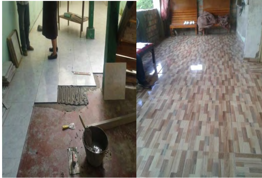
Imagen 42. Cambio de pisos viviendas.
