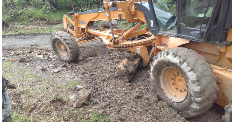
Imagen 46. Escarificación del terreno.
