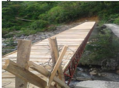
Imagen 173. travesaños de madera - puente.
