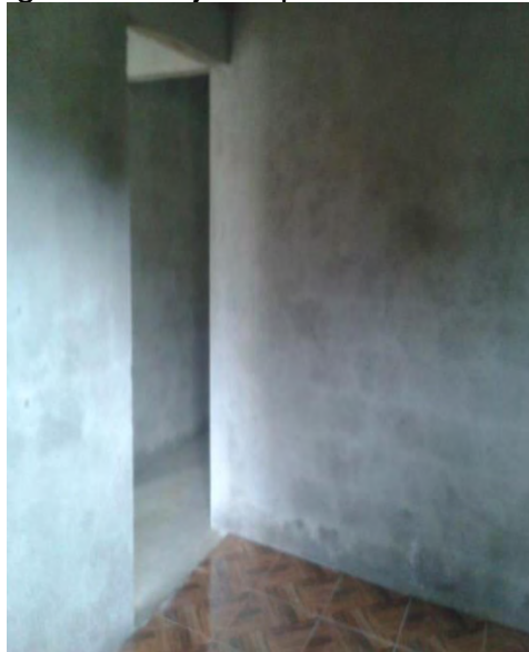
Imagen 45. Mejoras paredes viviendas.
