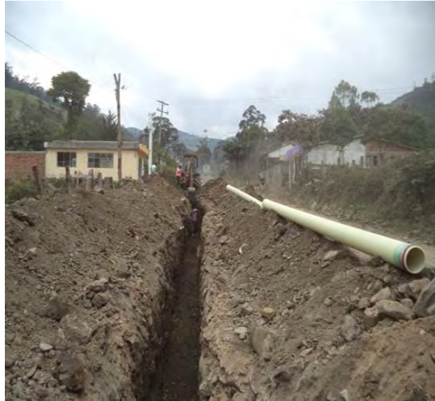
Imagen 80. Excavaciones y cambio de tubería.
