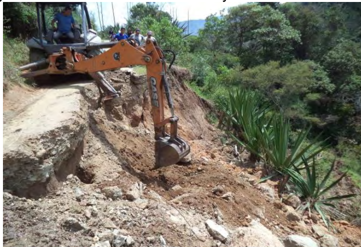
Imagen 4. Remoción de escombros y adecuación del terreno.
