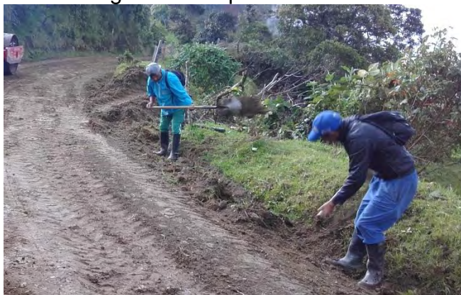
Imagen 50. Limpieza de cunetas
