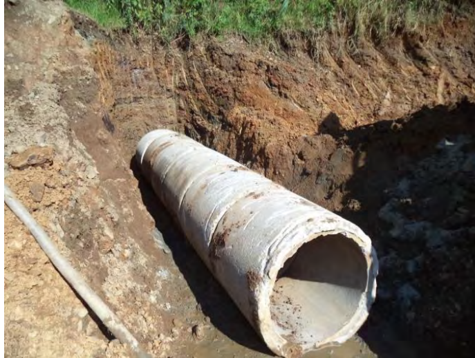
Imagen 5. Tubería de concreto de 36”.
