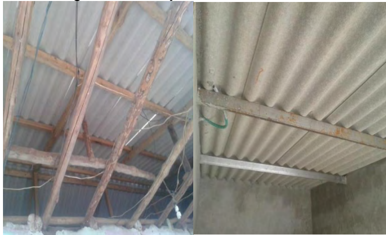
Imagen 2444. Mejora cubiertas viviendas.
