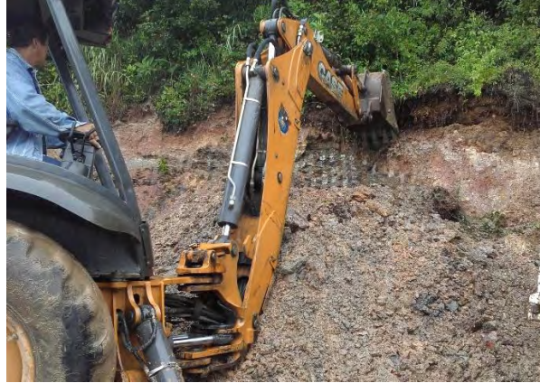
Imagen25 47. Perfilado del Talud.
