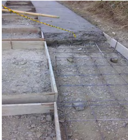
Imagen 30. Vaciado de concreto para las huellas.
