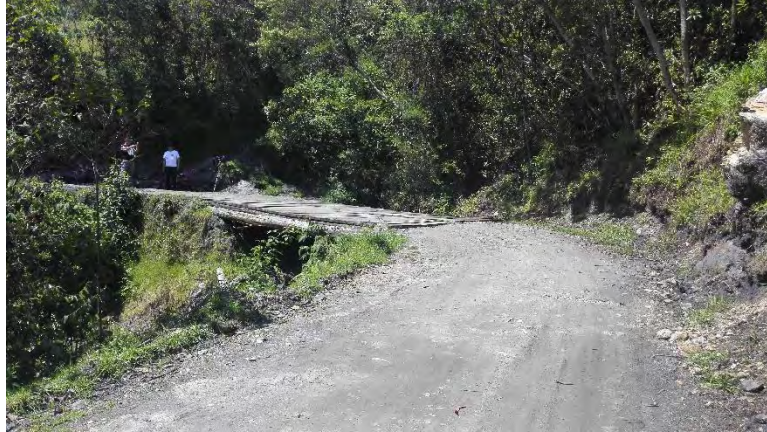
Imagen 33. Lugar donde se proyecta el box Culvert.
