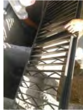
Imagen N°.12 Instalación rejillas metálicas
