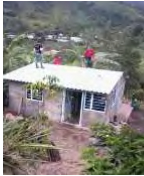
Imagen N°.73 Instalación de elementos de cubierta.
