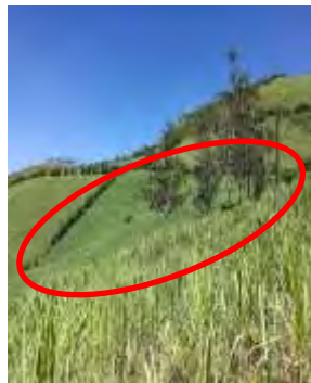
Imagen N°.87 Identificación de terreno invadido, cuenca de acueducto veredal
