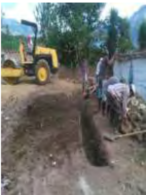
Imagen N°.17 Relleno de excavación
