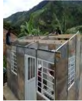
Imagen N°.72 Instalación de elementos de cubierta.
