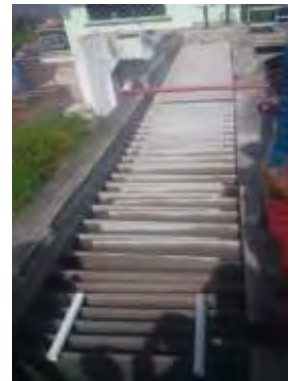
Imagen N°.6 Placas planas del canal de entrada.
