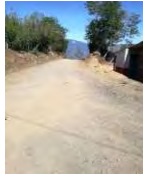
Imagen N°.92 Carretera Circunvalar Sta. Inés Cariaco Bajo
