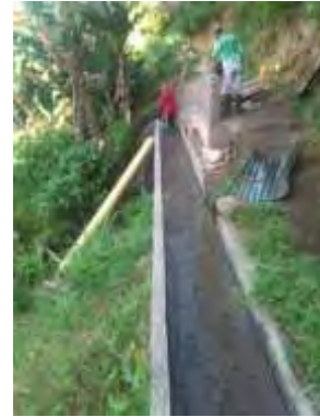
Imagen N°.42 Muro de contención finalizado junto a canal de viaducto.
