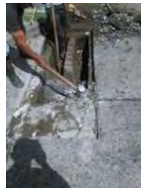
Imagen N°.10 Demolición tapa de concreto
