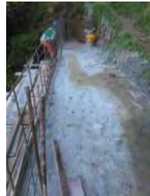
Imagen N°.40 Placa de piso fundida y refuerzo de muro de contención
