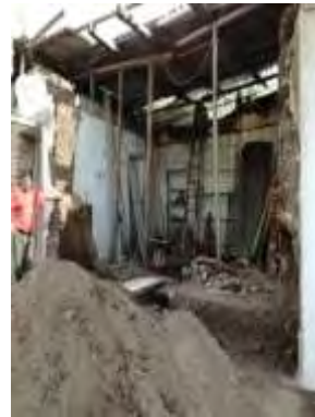
Imagen N°.98 Atención a solicitud presentada por comunidad por obra que obstaculiza paso por vía principal.
