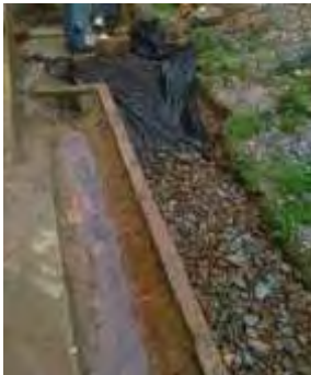
Imagen N°.53 Finalización de trabajos en Escuela Churupamba.
