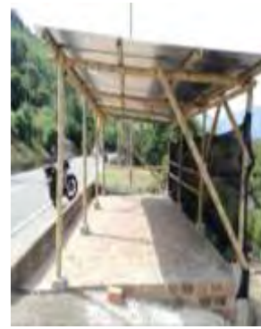
Imagen N°.86 Obstrucción visual de señalización vertical en el lugar de notificación.
