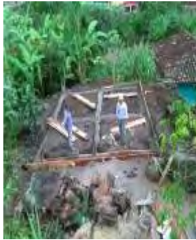
Imagen N°.65 Preparación para fundición de elementos de cemento.
