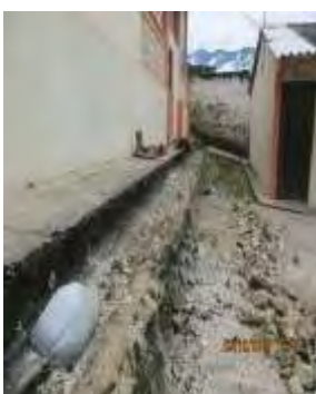
Imagen N°.59 Ejecución trabajos en Escuela hatillo.
