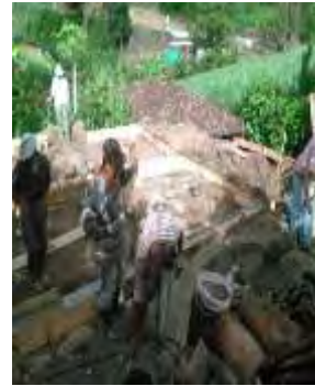
Imagen N°.66 Elaboración de concreto.
