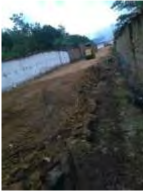
Imagen N°.19 Compactación de material
