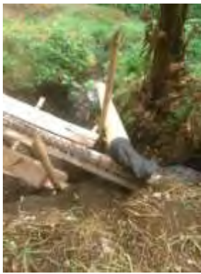
Imagen N°.33 Desagüe temporal de emisor final.
