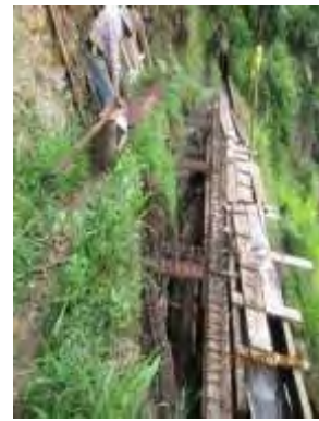
Imagen N°.38 Armadura de refuerzo y formaleta de placa de piso
