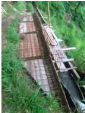
Imagen N°.39 Armadura de refuerzo y formaleta de placa de piso
