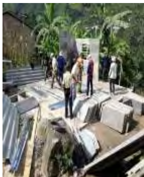
Imagen N°.69 Instalación de materiales prefabricados para vivienda.
