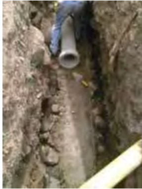
Imagen N°.13 Instalación tubería de cemento de 10"
