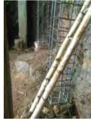
Imagen N°.36 Construcción armadura de refuerzo de columnas
