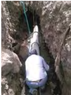
Imagen N°.15 Instalación tubería de cemento de 10"
