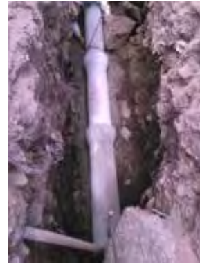
Imagen N°.14 Instalación tubería de cemento de 10"
