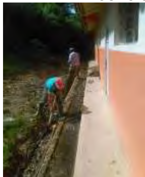
Imagen N°.47 Ejecución de trabajos en Escuela Churupamba.
