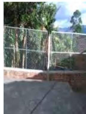
Imagen N°.8 Cerramiento
