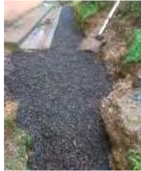
Imagen N°.52 Ejecución de trabajos en Escuela Churupamba.
