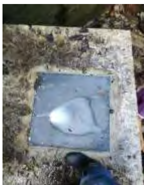
Imagen N°.77 Tapas metálicas.
