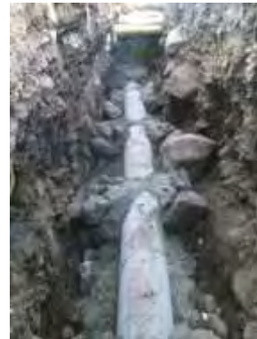
Imagen N°.16 Instalación tubería de cemento de 10"
