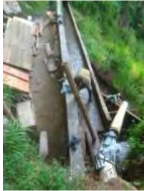
Imagen N°.41 Desencofrado de Muro de contención.
