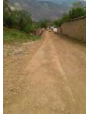
Imagen N°.20 Conformación de calzada
