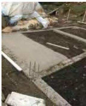
Imagen N°.67 Fundición placa de piso
