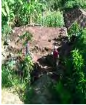
Imagen N°.63 Nivelación del terreno.
