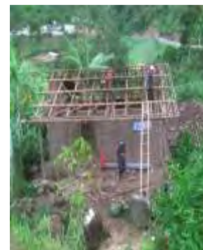
Imagen N°.62 Desmonte y Demolición de estructuras existentes
