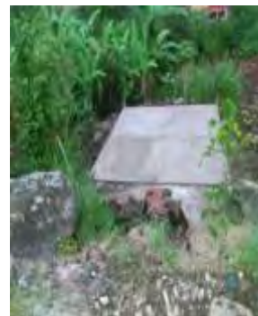
Imagen N°.68 Placa de piso para vivienda prefabricada terminada.
