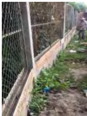
Imagen N°.7 Cerramiento
