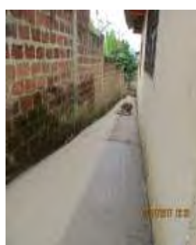
Imagen N°.60 Ejecución trabajos en Escuela hatillo.
