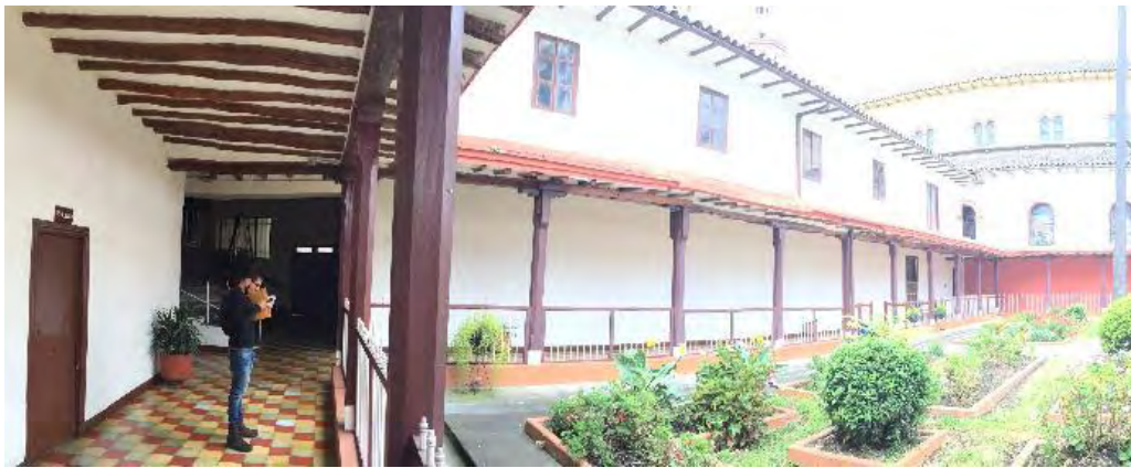
Figura 43. Fachada posterior, ala norte Fuente: Ing. Esp. Iván Castillo
