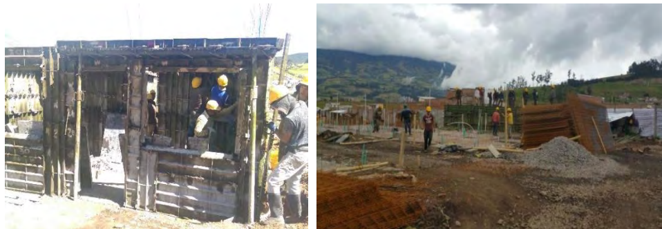
Figura 16. Proceso de instalación de formaleta.
