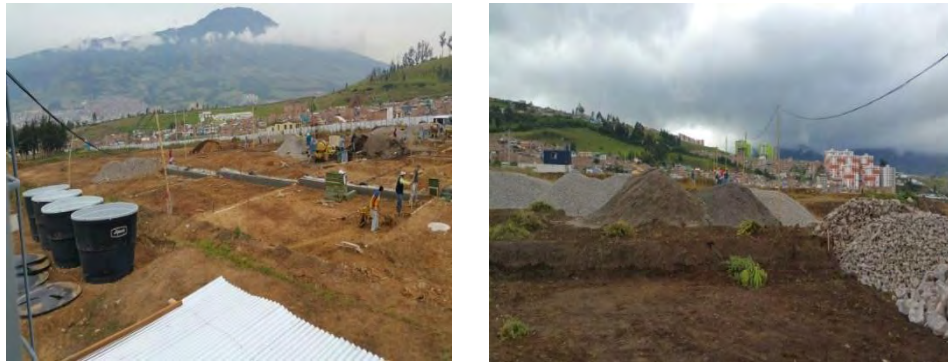
Figura 6. Excavaciones y acopio de materiales.
