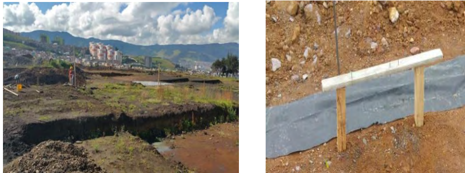
Figura 4. Localización y replanteo.
