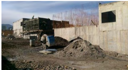
Figura 20. Mezcla de concreto en obra.
