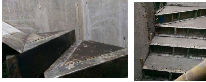
Figura 19. Formaleta metálica de gradas.
