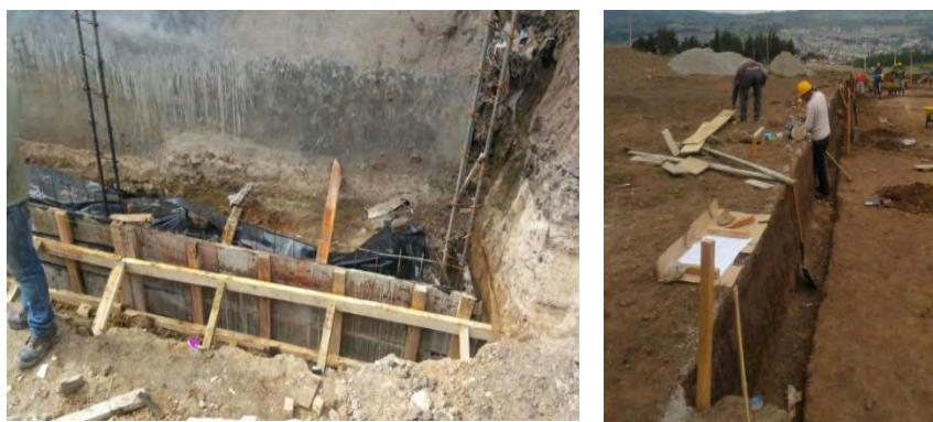
Figura 7. Construcción de muros de contención.
