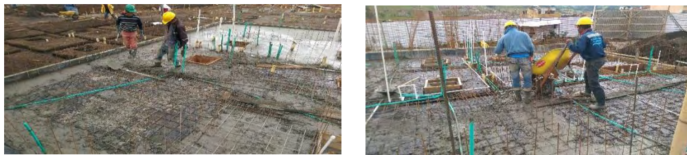
Figura 12. Fundición de vigas de cimentación.
