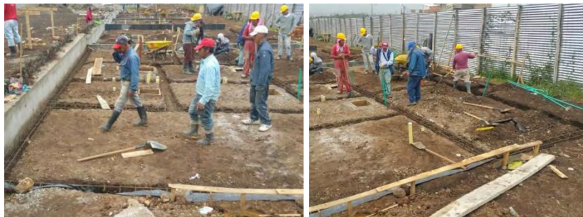
Figura 10. Amarre de castillos en vigas de cimentación.
