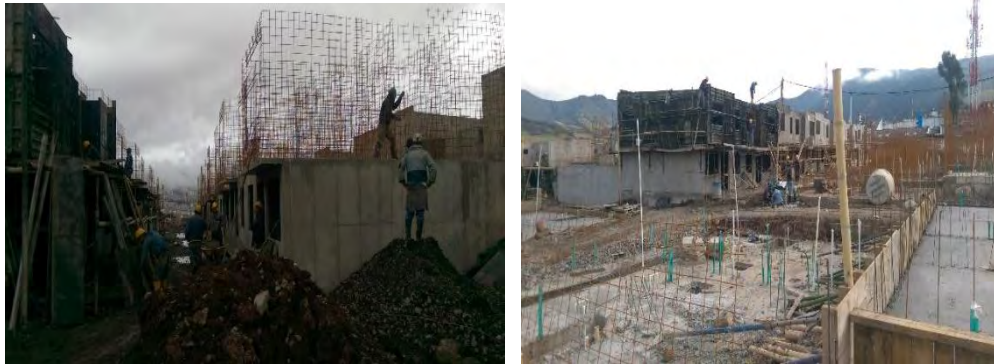
Figura 18. Fundición segundo piso.
