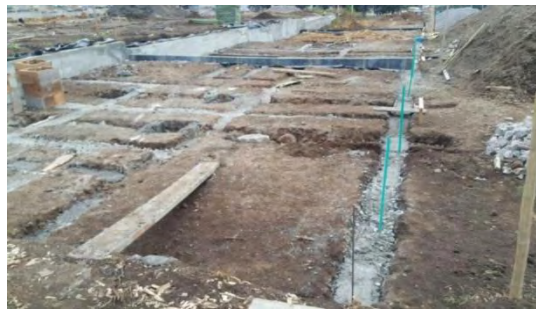
Figura 9. Vaciado del concreto de limpieza.
