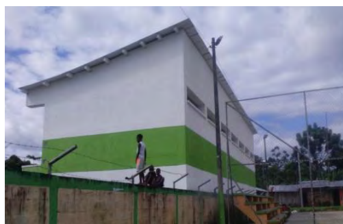
Foto 121. Pintura Muros exteriores.
