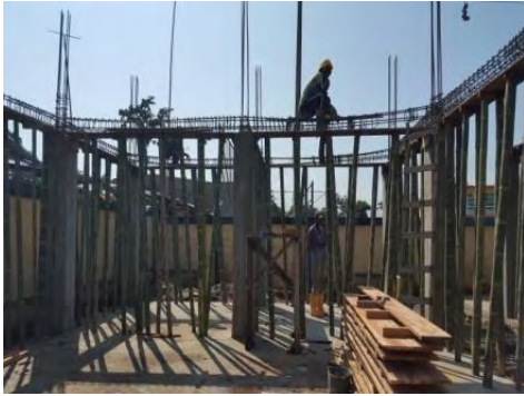
Foto 32: Acero de refuerzo de vigas aéreas comedor.
