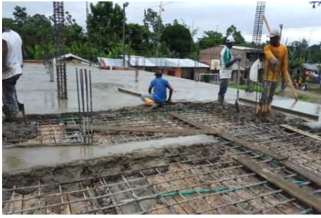
Foto 49: Nivelación con codal metálico.
