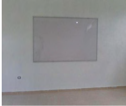
Foto 85. Suministro e instalación de tablero en formica.
