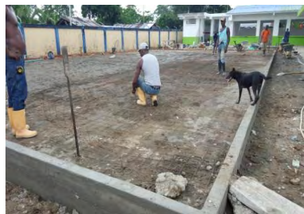
Foto 126. Instalación malla electrosoldada.
