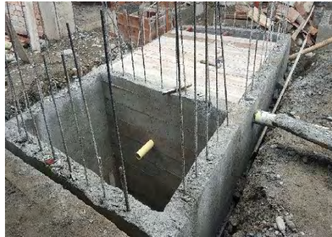
Foto 92. Muros fundidos tanque séptico.
