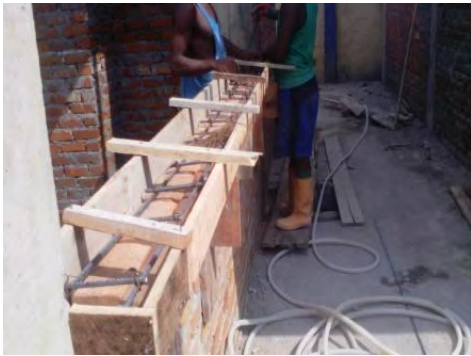
Foto 42: Refuerzo y formaleta alfajía
