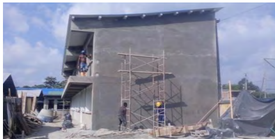
Foto 36: Viga de borde.
