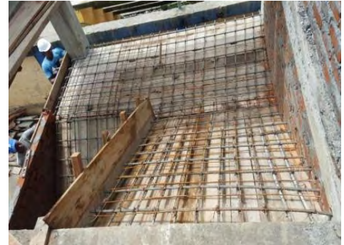
Foto 52: Acero de refuerzo.
