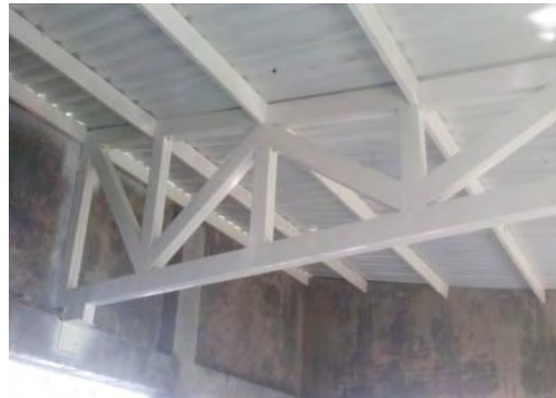
Foto 68. Estructura metálica terminada.
