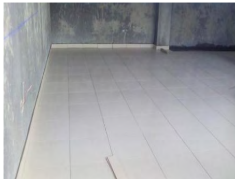
Foto 109: Piso en cerámica tráfico 5.
