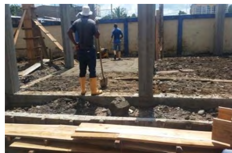
Foto 9. Compactación con placa vibratoria.
