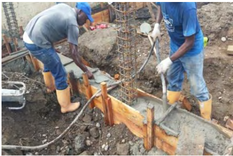
Foto 20. Vibrado del concreto
