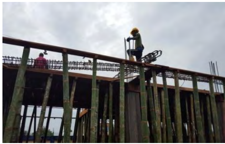
Foto 34: Acero de refuerzo bloque dos pisos.
