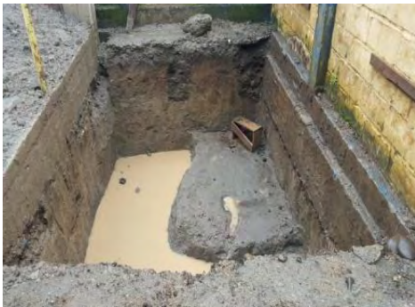
Foto 55: Excavaciones tanque de almacenamiento.
