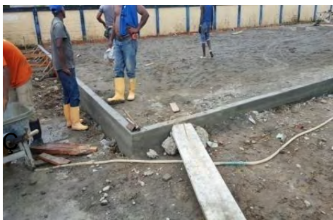
Foto 125. Viga sardinel fundida.
