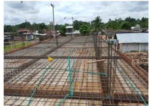
Foto 46: Acero de refuerzo e instalaciones eléctricas.
