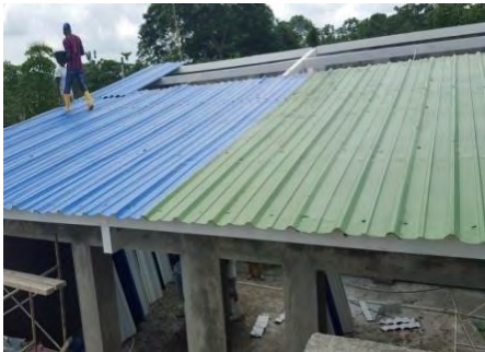
Foto 69. Instalación de lámina termo acústica.
