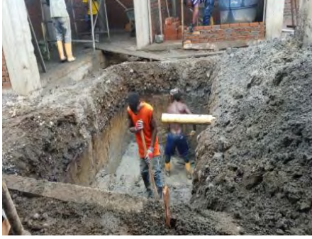
Foto 90. Excavación tanque séptico.
