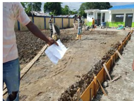
Foto 124. Formaleta viga sardinel.
