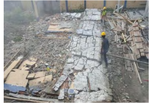
Foto 11. Demolición de estructuras existentes
