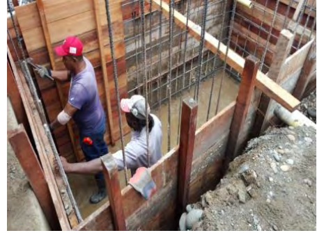
Foto 91. Acero de refuerzo tanque séptico.
