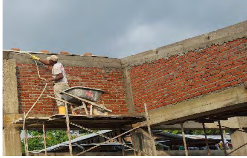
Foto 41. Viga remate de cubierta.
