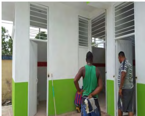
Foto 80. Puertas batería sanitaria.
