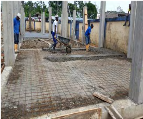
Foto 104. Instalación malla electrosoldada aulas.
