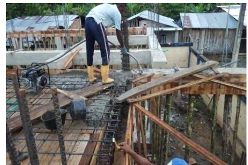
Foto 48: Vibrado del concreto.
