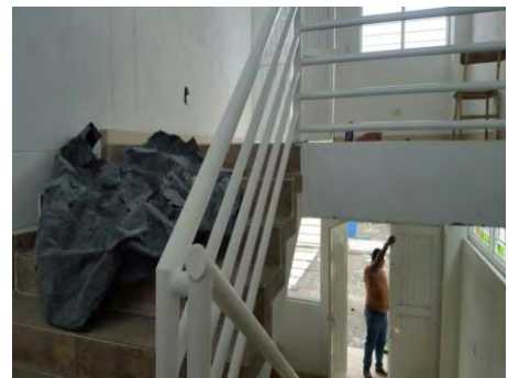
Foto 84. Pasamanos de escalera.
