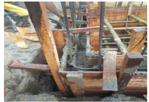
Foto 58: Vibrado del concreto.
