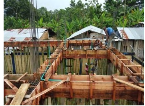
Foto 33: formaleta de madera vigas aérea comedor.
