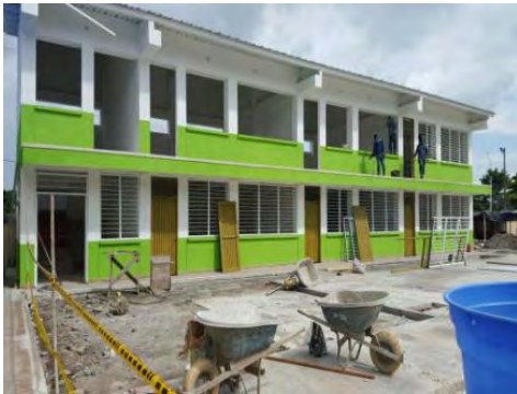
Foto 81. Protector metálico 6 aulas.
