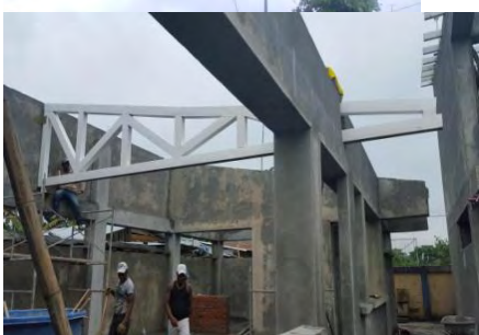
Foto 66. Instalación cercha metálica.
