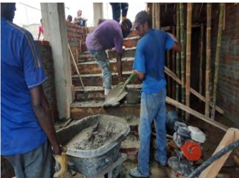
Foto 53. Vaciado concreto escalera.
