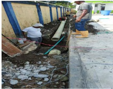
Foto 96. Instalación tubería alcantarillado 12”
