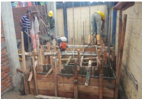
Foto 57: Fundición tanque almacenamiento.
