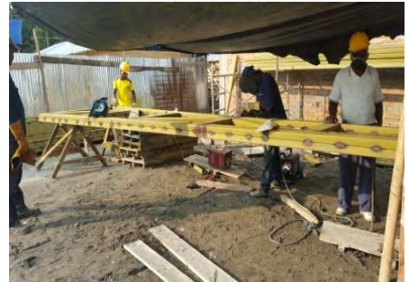
Foto 65. Soldadura de la estructura metálica.
