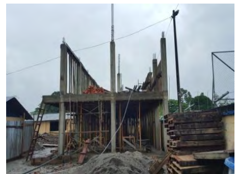
Foto 31. Columnas primer y segundo nivel
