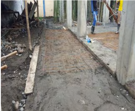
Foto 106. Instalación malla electrosoldada andenes.
