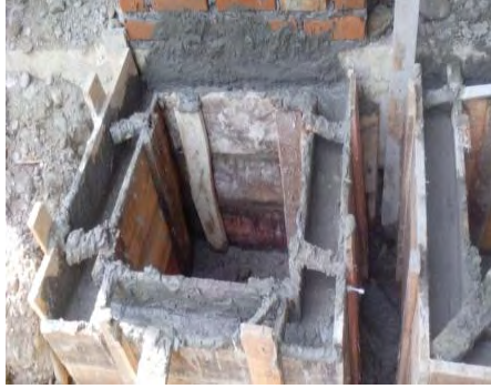
Foto 93. Fundición caja de inspección.
