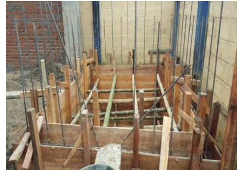
Foto 56: Formaleta de tanque de almacenamiento.
