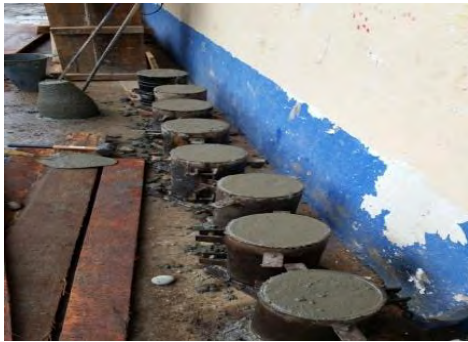
Foto 24. Cilindros para ensayo de resistencia de compresión.
