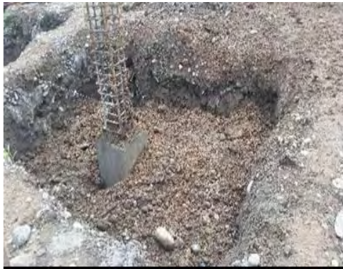
Foto 6. Relleno con material del sitio.
