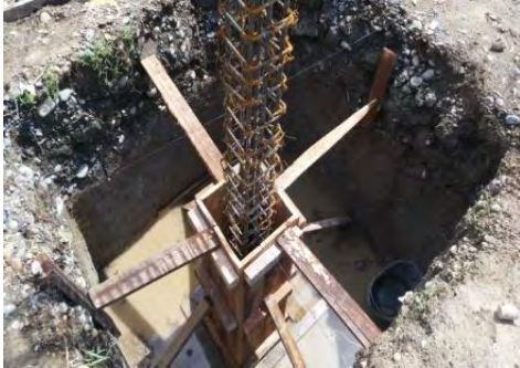
Foto 16. Formaleta en madera para pedestales.
