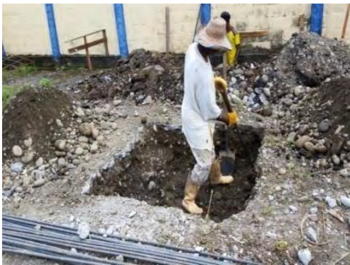
Foto 4. Excavación de zapata.
