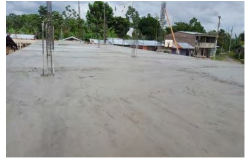
Foto 50: Losa aérea fundida.
