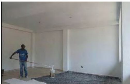
Foto 120. Pintura muros y cielo.
