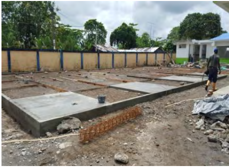
Foto 127. Fundición por paños.
