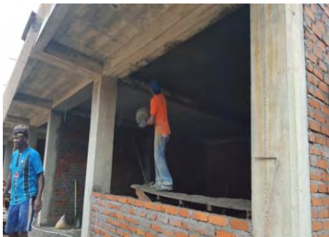
Foto 114. Repello cielo raso.
