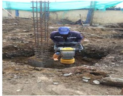
Foto 7. Compactación con apisonador de impacto.
