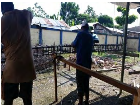
Foto 26. Armado del acero de refuerzo columnas.
