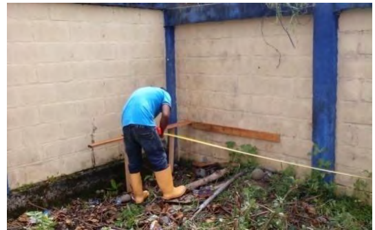
Foto 2. Localización y replanteo.
