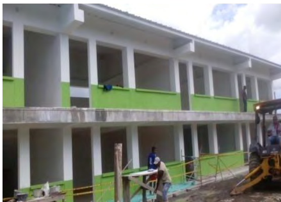
Foto 44. Alfajías ubicadas en el bloque de 6 aulas.
