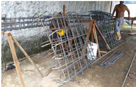
Foto 13. Acero de refuerzo zapatas.
