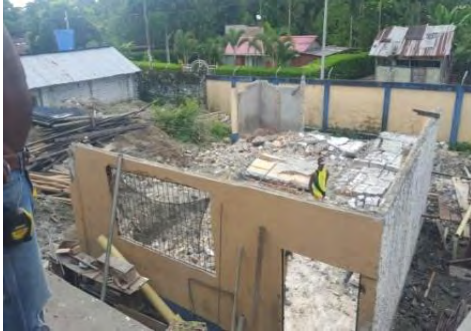
Foto 10. Demolición de 2 aulas
