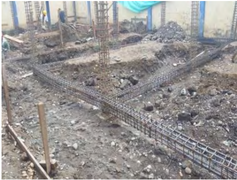
Foto 18. Acero de refuerzo
