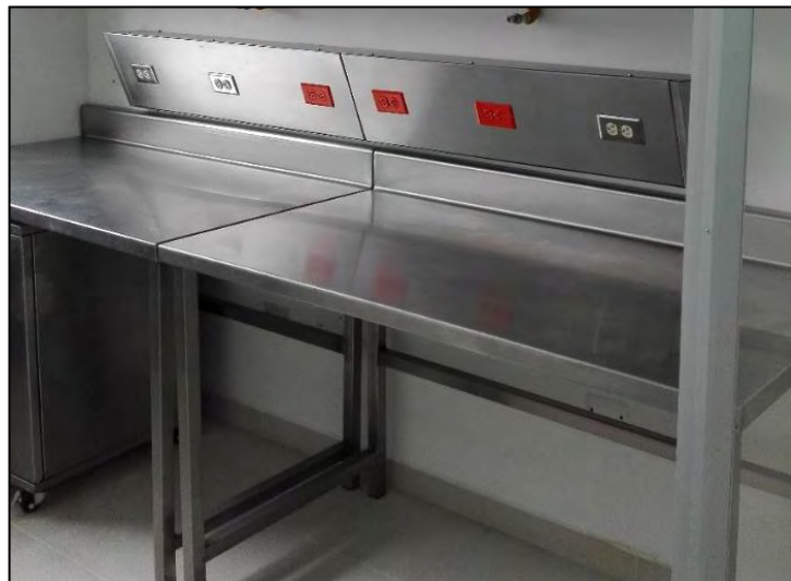
Figura 37. Caja de conexiones
