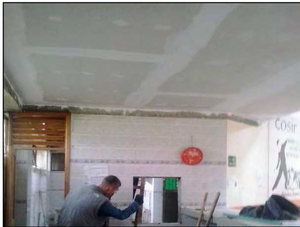
Figura 12. Cielo raso en fibrocemento
