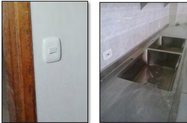
Figura 9. Interruptor sencillo y toma GFCI
