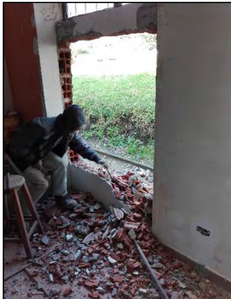
Figura 13. Demolición de muro
