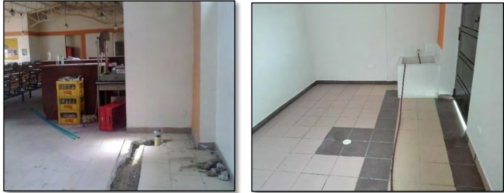
Figura 14. Adecuación de espacio para bodega de almacenamiento.
