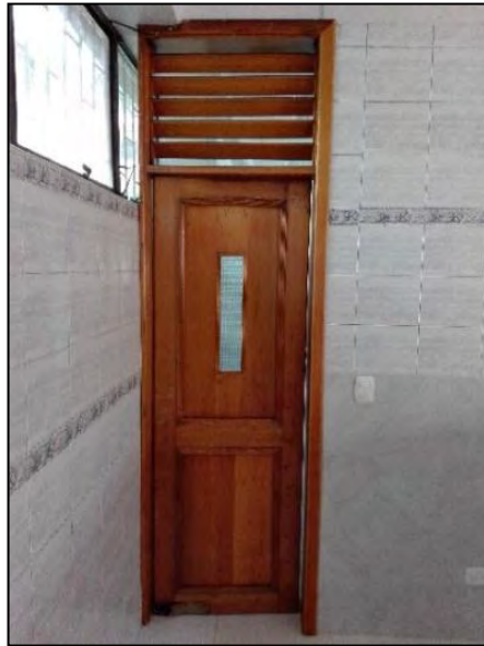
Figura 24. Mantenimiento de puertas en madera.
