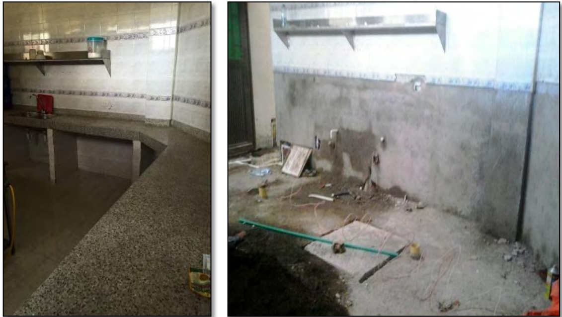
Figura 6. Demolición de mesón.
