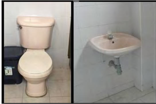
Figura 20. Mantenimiento de sanitarios y lavamanos.
