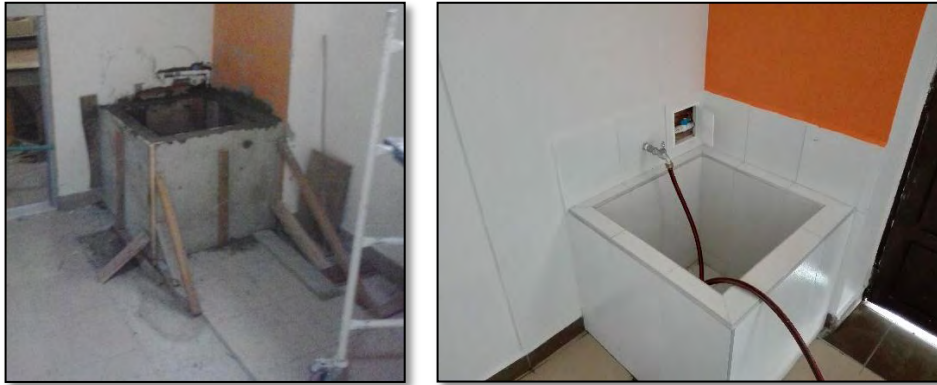
Figura 22. Poceta en concreto incluye enchape
