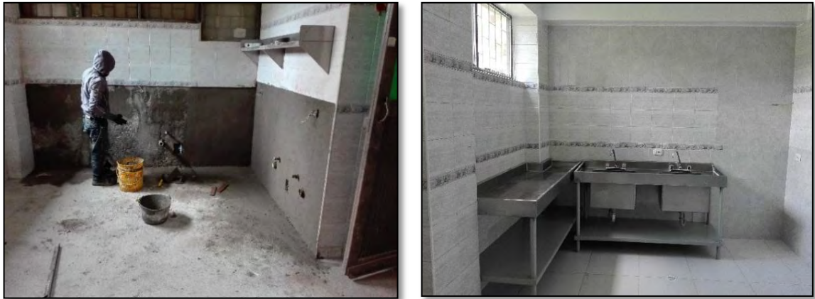
Figura 11. Enchape de pared
