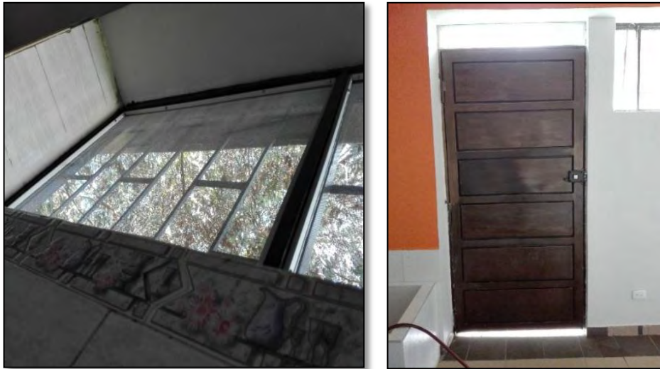
Figura 16. Ventana corrediza y puerta metálica.
