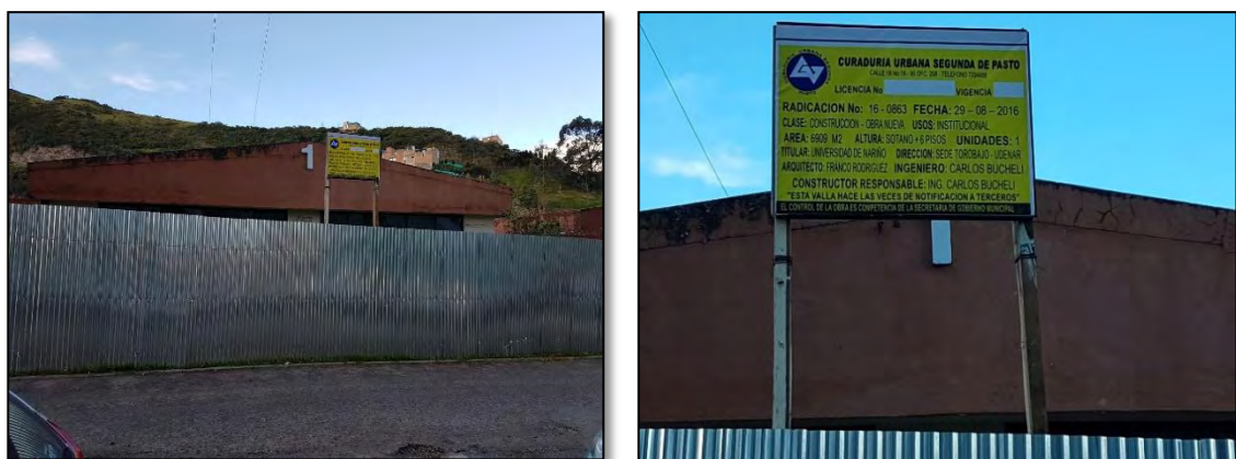
Figura 3. Valla de construcción bloque 1 sector sur Universidad de Nariño – sede torobajo
