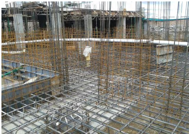
ILUSTRACIÓN 3. ESTADO DE OBRA AL INICIO DE LA PASANTIA
