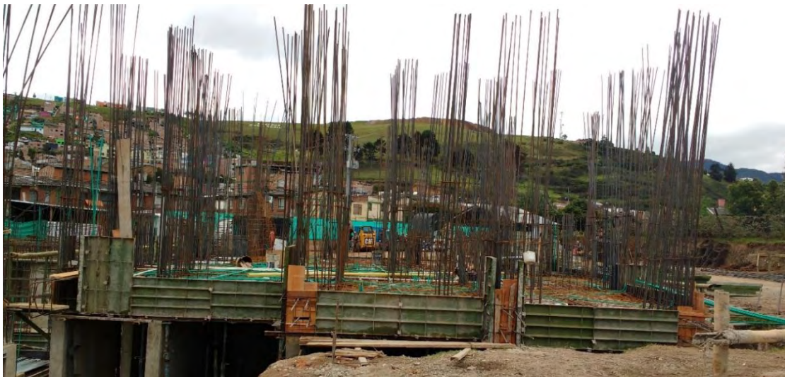
ILUSTRACIÓN 22. ESTADO DE LA OBRA AL INICIO DE LA PASANTIA
