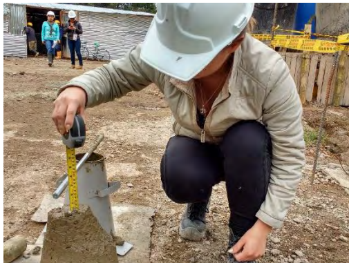
ILUSTRACIÓN 24. VERIFICACIÓN DEL ASENTAMIENTO
