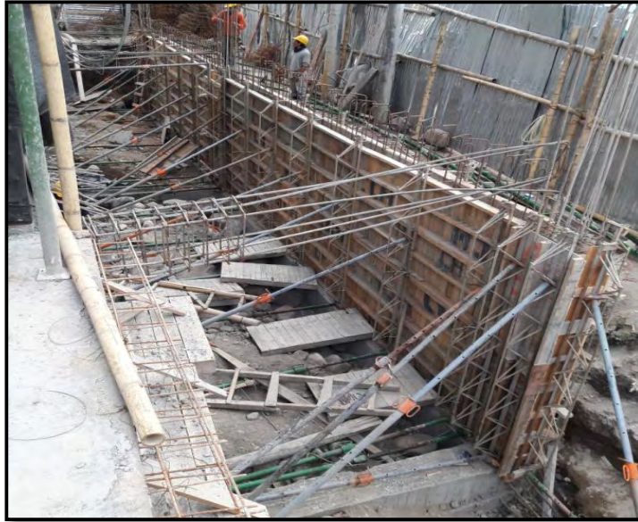
Figura 38. Muro de contención
