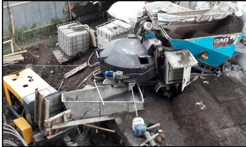
Figura 35. Instalación de la unidad de producción
