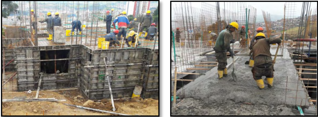
Figura 28. Armado y fundición de estructuras Torre V
