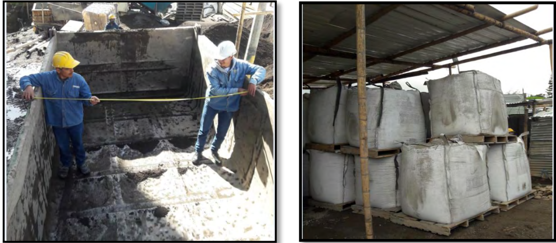
Figura 4. Medición de volquetas, almacenamiento y protección del cemento (big bags)
