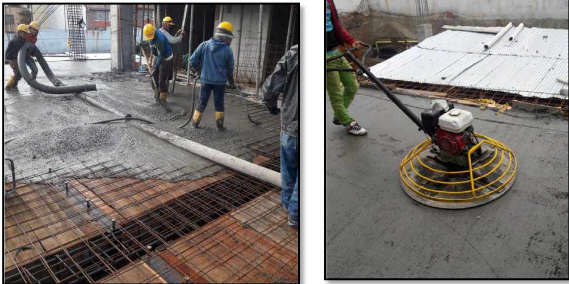
Figura 37. Fundición de losa de entrepiso y terminado con helicóptero.
