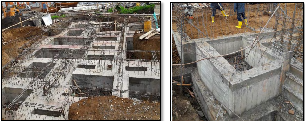
Figura 31. Zarpa y muros de carga de la cimentación Torre VI.
