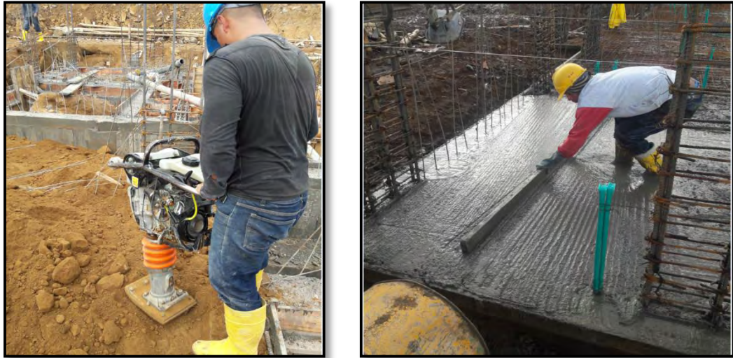
Figura 32. Relleno y losa de primer piso Torre VI.
