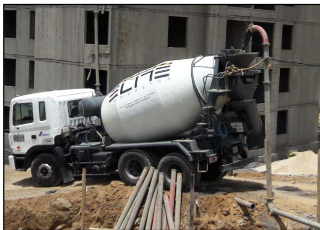
Figura 40. Producción de concreto para mixer.
