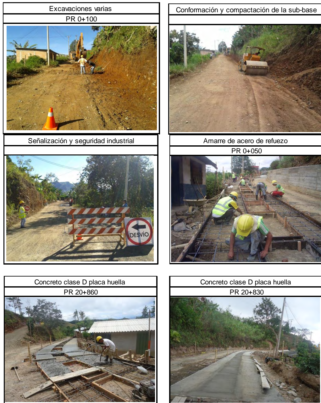
Figura 25.- Proceso de ejecución de la obra - vía Sotomayor – Aminda
