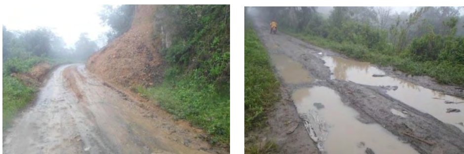
Figura 13.- Estado inicial de la obra. Vía Mallasquer – Tambo
