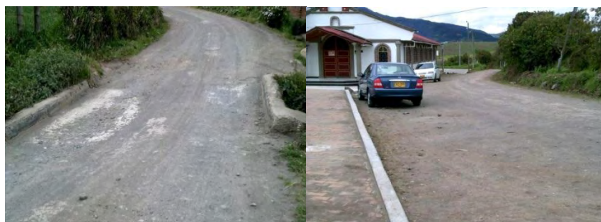
Figura 19. Estado inicial de la obra - vía Pasto – Buesaquillo
