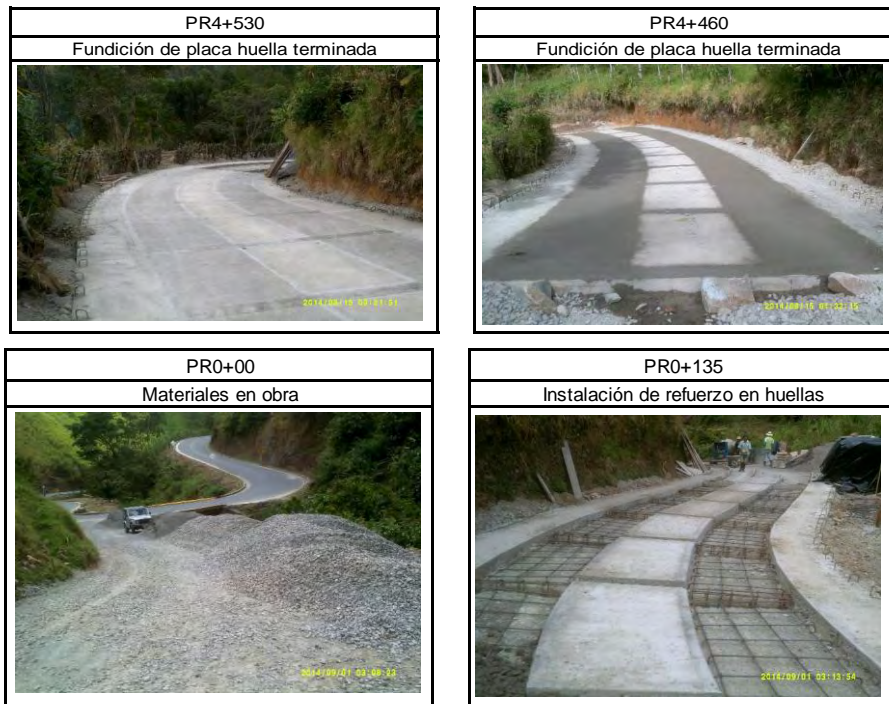
Figura 29.- Proceso de ejecución de la obra - vía cruce circunvalar – Alto Ingenio
