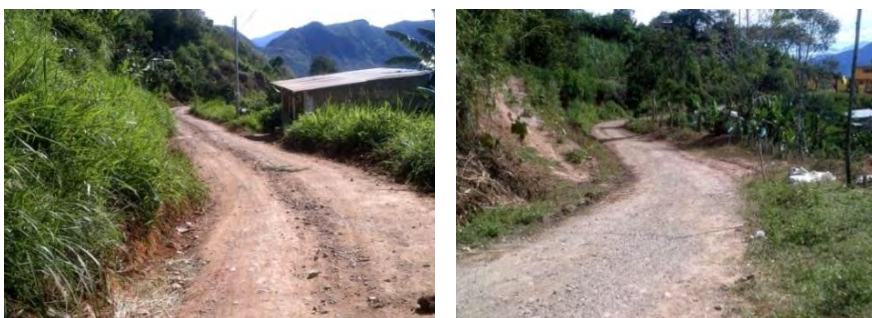
Figura 16.-Estado inicial de la obra - vía Sotomayor – Aminda
