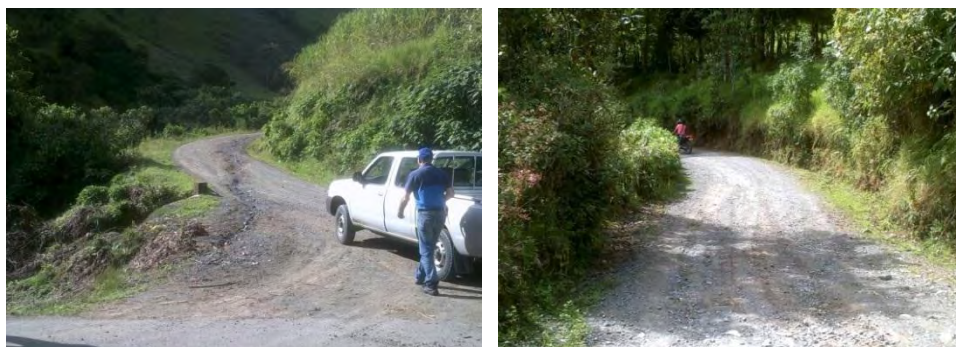
Figura 20.- Estado inicial de la obra - vía cruce circunvalar – Alto Ingenio
