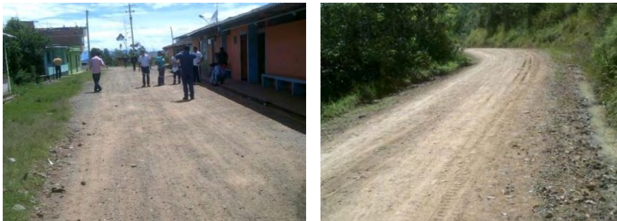
Figura 14. Estado inicial de la obra. Vía Casablanca – La Joya.
