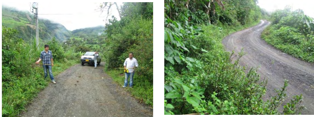
Figura 12.- Estado inicial de la obra vía Yanancha – San Antonio – Quinua.
