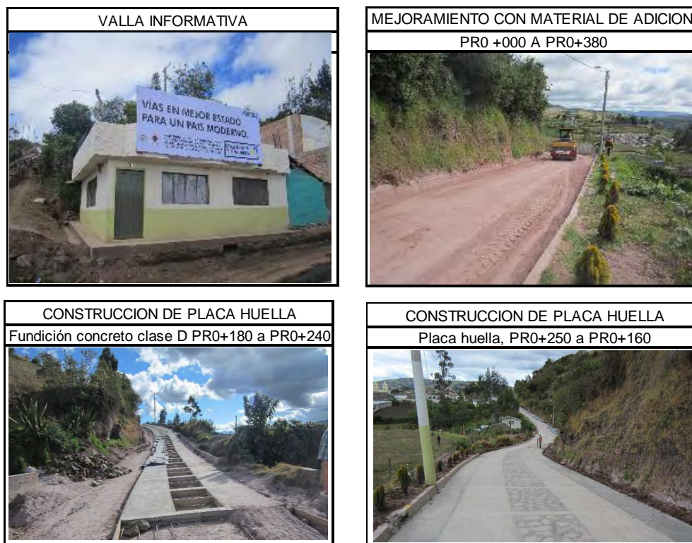
Figura 27.- Proceso de ejecución de la obra - vía Ospina – Las Mercedes – Villa del Sur
