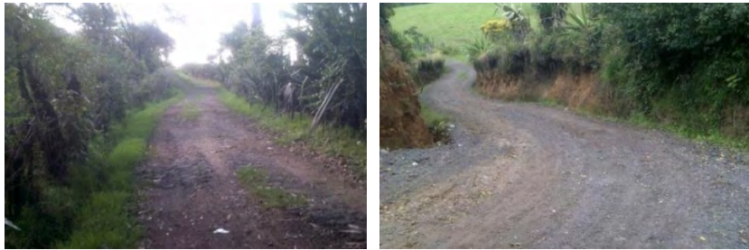
Figura 17.- Estado inicial de la obra - vía Pueblo Viejo – Nariño – El Silencio
