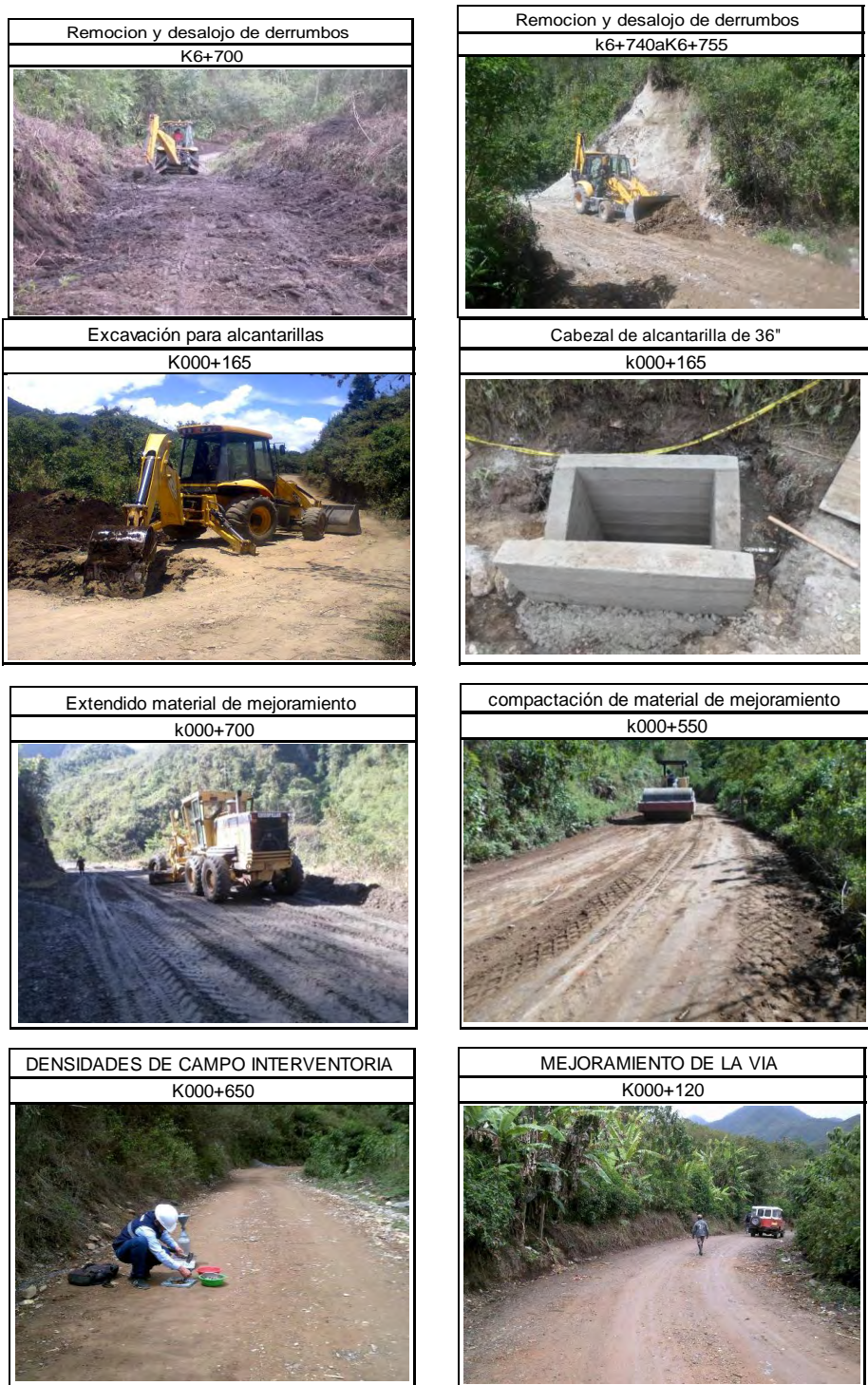
Figura 22.- Proceso de ejecución de la obra - via Mallasquer – Tambo
