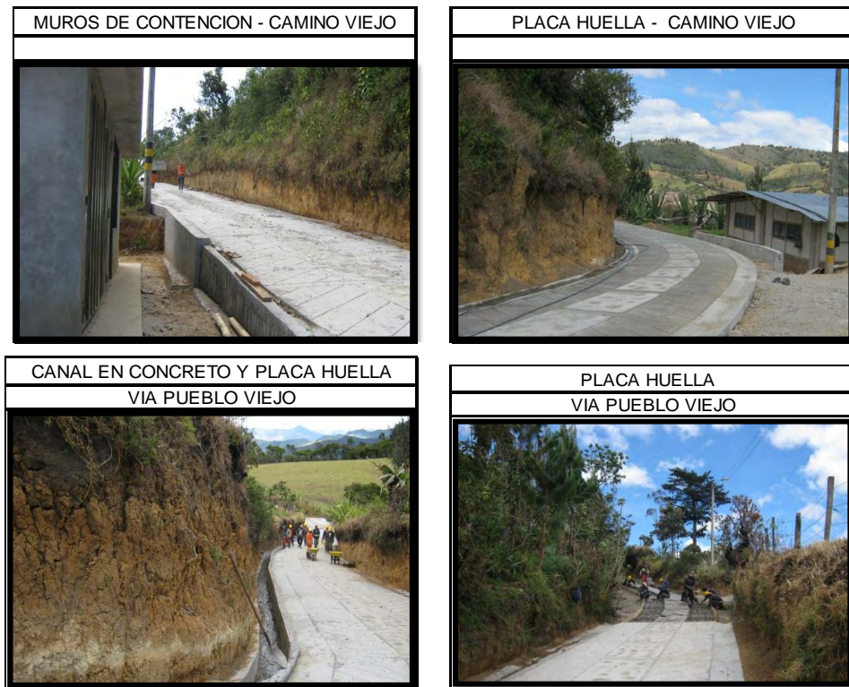
Figura 26.- Proceso de ejecución de la obra - vía Pueblo Viejo – Nariño – El Silencio
