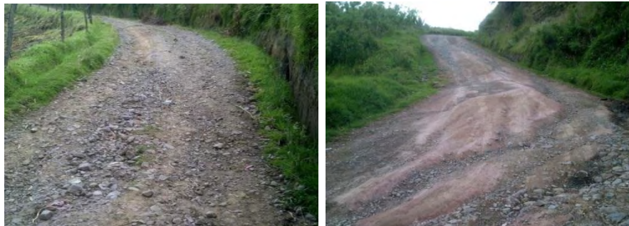
Figura 15.-Estado inicial de la obra vía Iles – Bolívar – Rosario Occidente
