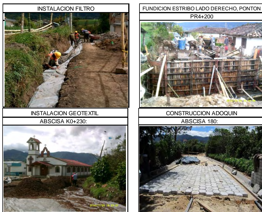
Figura 28.- Proceso de ejecución de la obra - vía Pasto – Buesaquillo
