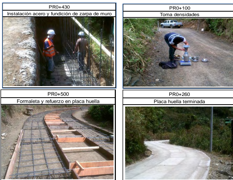
Figura 21. Proceso de ejecución de la obra - vía Yanancha – San Antonio
