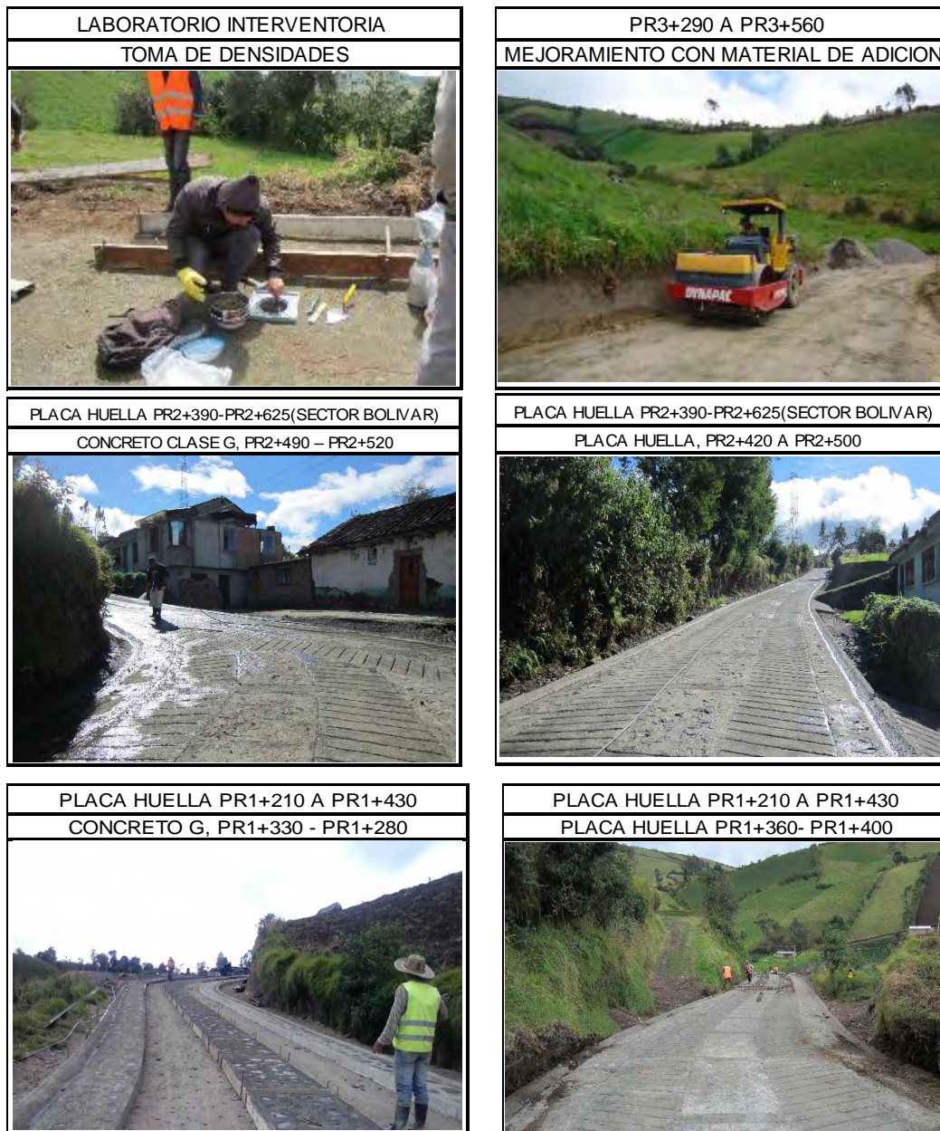
Figura 24. Proceso de ejecución de la obra- vía Iles – Bolívar – Rosario Occidente
