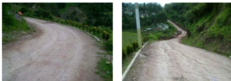
Figura 18. Estado inicial de la obra - vía Ospina – Las Mercedes – Villa del Sur.
