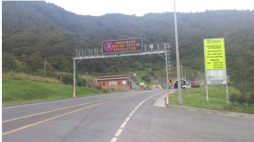
IMAGEN 26. Vía a Pasto - Buesaco, entrada túnel.
