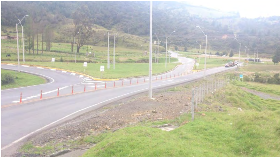
IMAGEN 27. Vía a Buesaco; daza.
