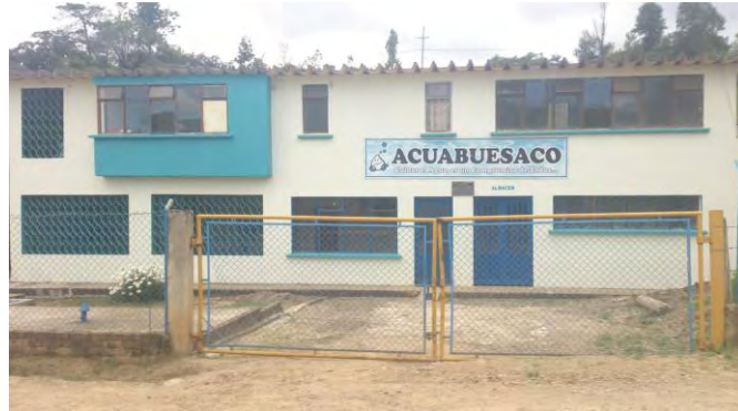
IMAGEN 33. Panorámica edificio principal acuabuesaco.
