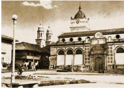
Figura 7. Antigua iglesia de San Juan Bautista. **
