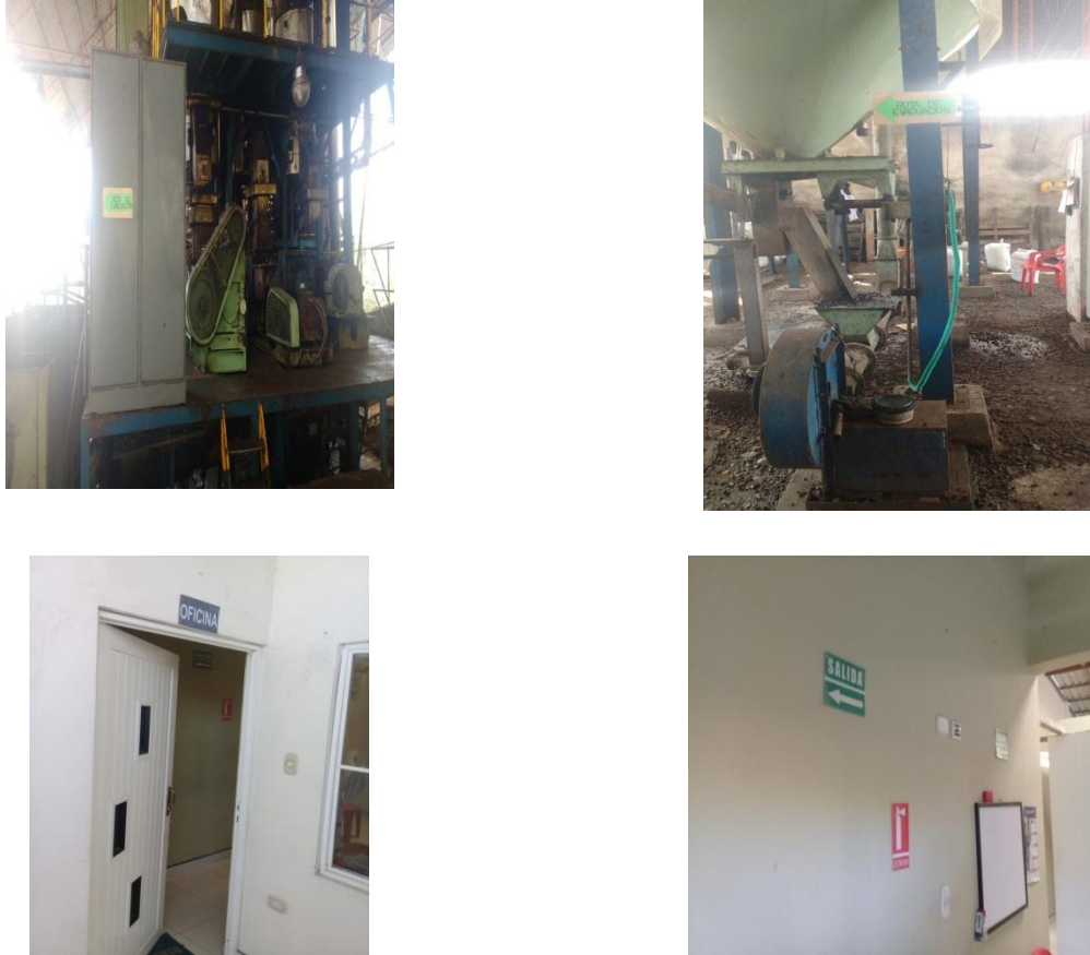
Ilustración 5. Señales instaladas en Extractora Santa Fe
