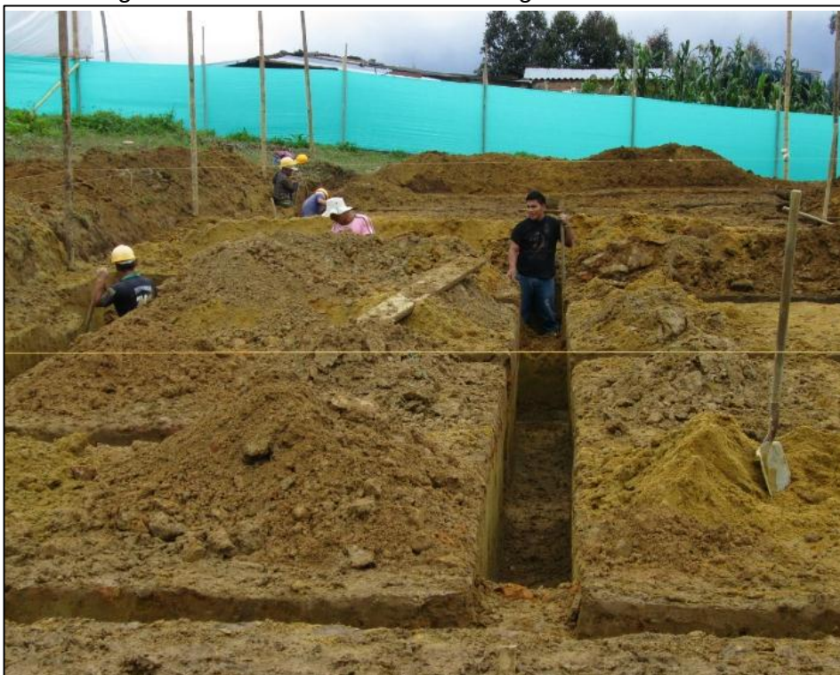
Figura 13 - Excavación manual de vigas de cimentación.
