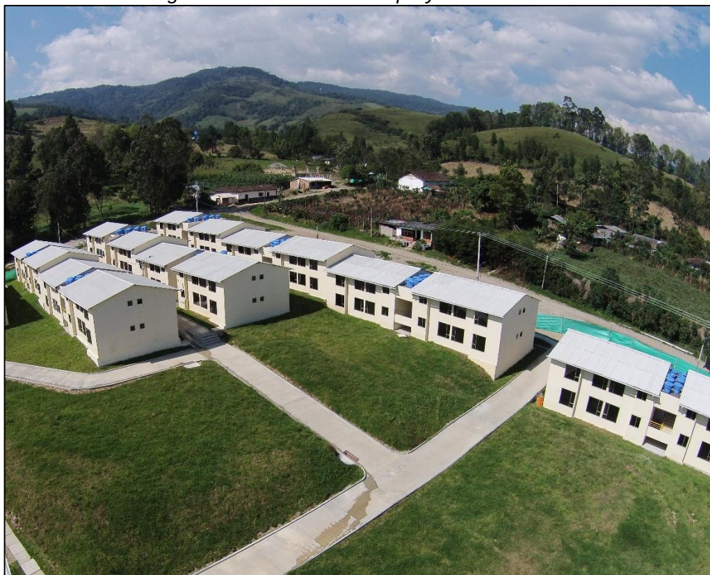
Figura 61 - Vista aérea del proyecto finalizado.
