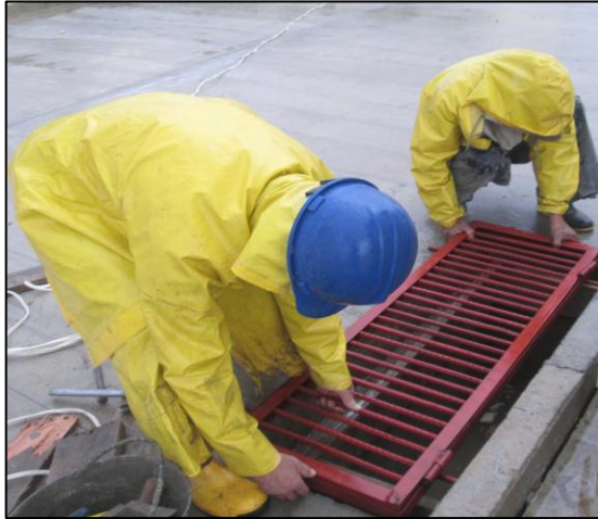
Figura 53 - Instalación de rejillas para los sumideros en la vía principal.
