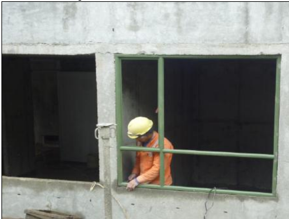
Figura 41 - Instalación de ventanas metálicas.
