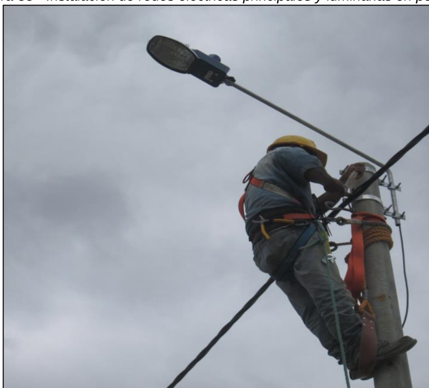
Figura 55 - Instalación de redes eléctricas principales y luminarias en postes.
