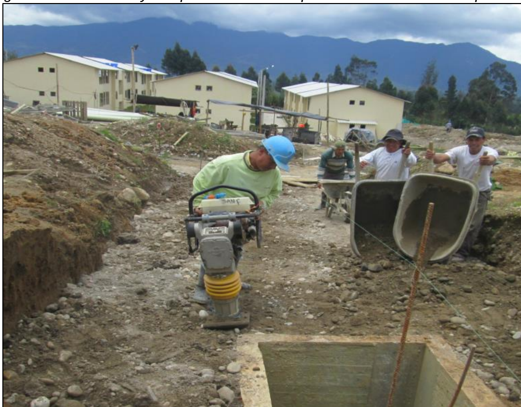
Figura 46 - Nivelación y compactación manual para la fundición de la vía peatonal.
