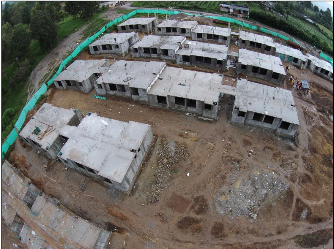
Figura 35 - Vista panorámica de los bloques de la zona sur.
