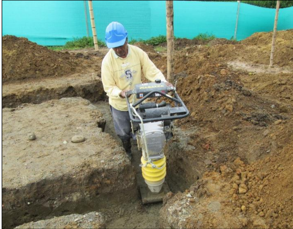
Figura 15 - Proceso de compactación del mejoramiento de suelo.
