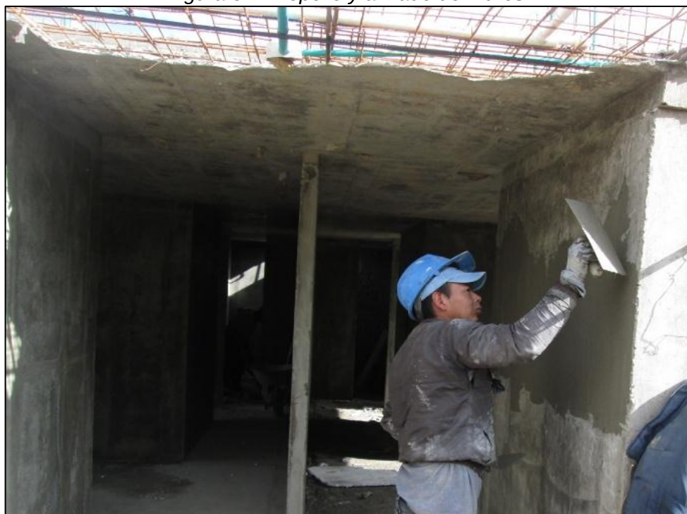
Figura 32 - Repello y afinado de muros.
