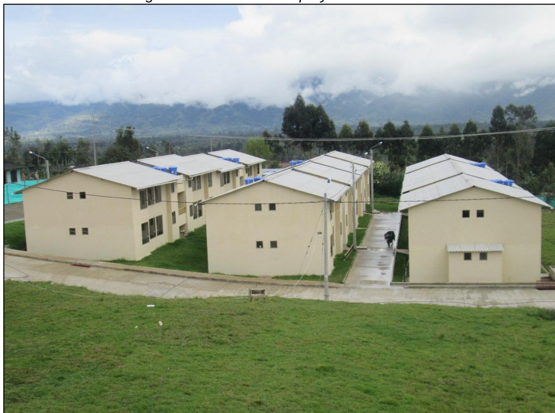
Figura 59 - Vista final del proyecto terminado.
