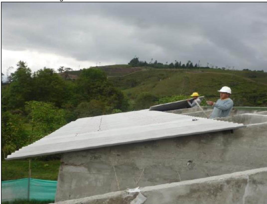
Figura 38 - Soldadura de correas e instalación de cubierta.
