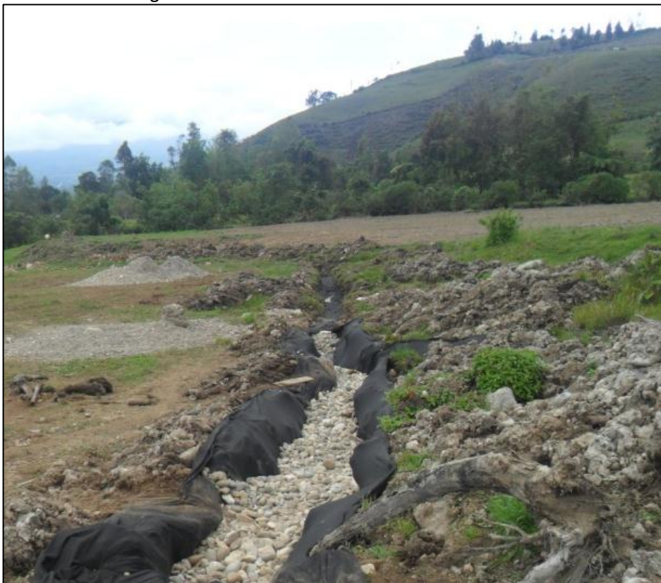
Figura 6 - Instalación de los filtros alrededor del lote.
