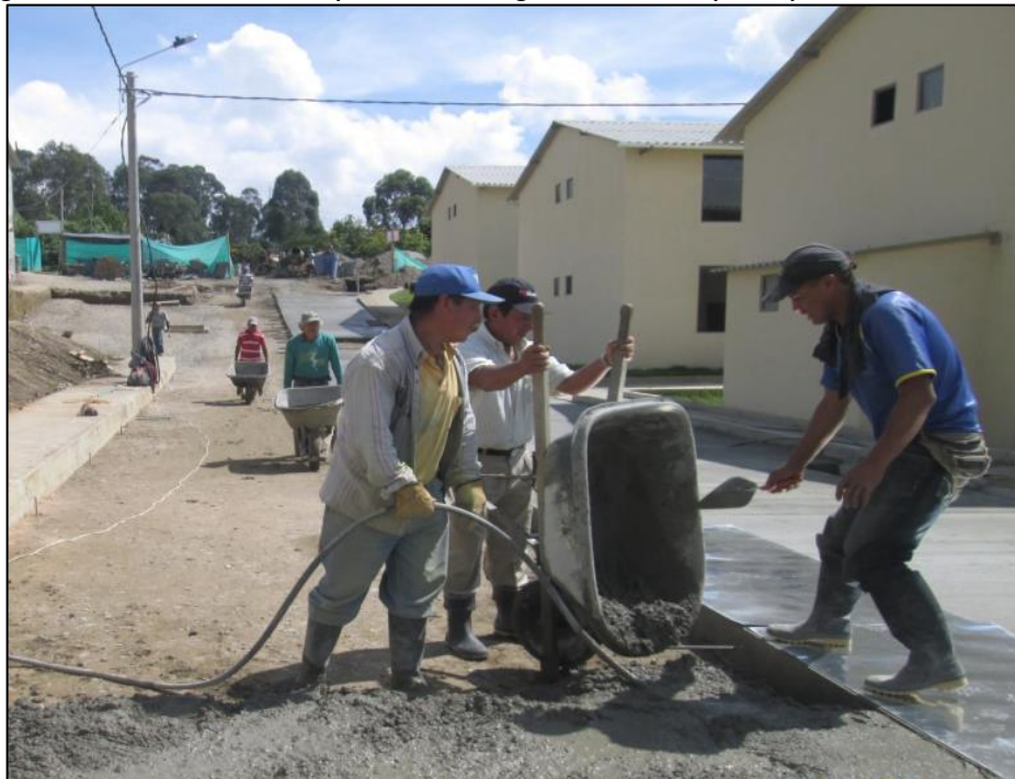
Figura 50 - Fundición del pavimento rígido de la vía principal, carril derecho.
