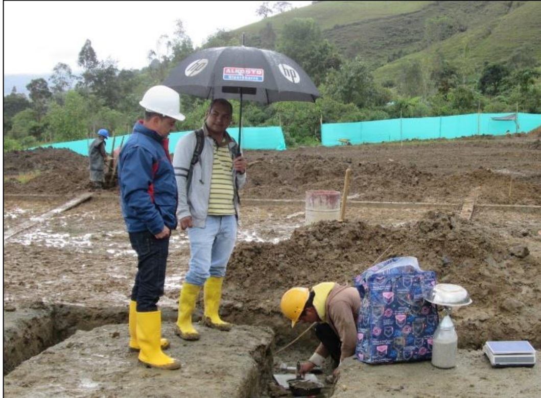
Figura 16 - Toma de densidades sobre los mejoramientos de suelo terminados.
