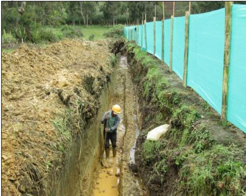
Figura 10 - Excavación manual para la conexión del alcantarillado pluvial.
