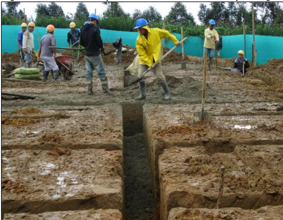
Figura 14 - Proceso de mejoramiento con suelo cemento bajo las vigas.
