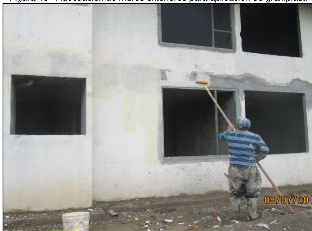
Figura 43 - Adecuación de muros exteriores para aplicación de graniplast.
