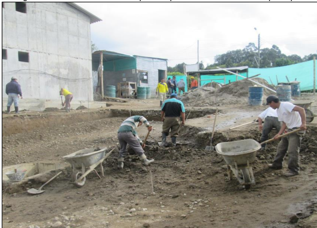
Figura 46 - Nivelación y compactación manual para la fundición de la vía peatonal.
