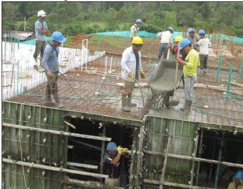
Figura 31 - Fundición losas de entepiso.
