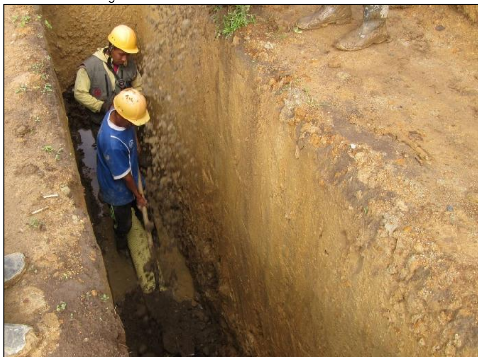
Figura 11 - Instalación de tubería PVC de 10".
