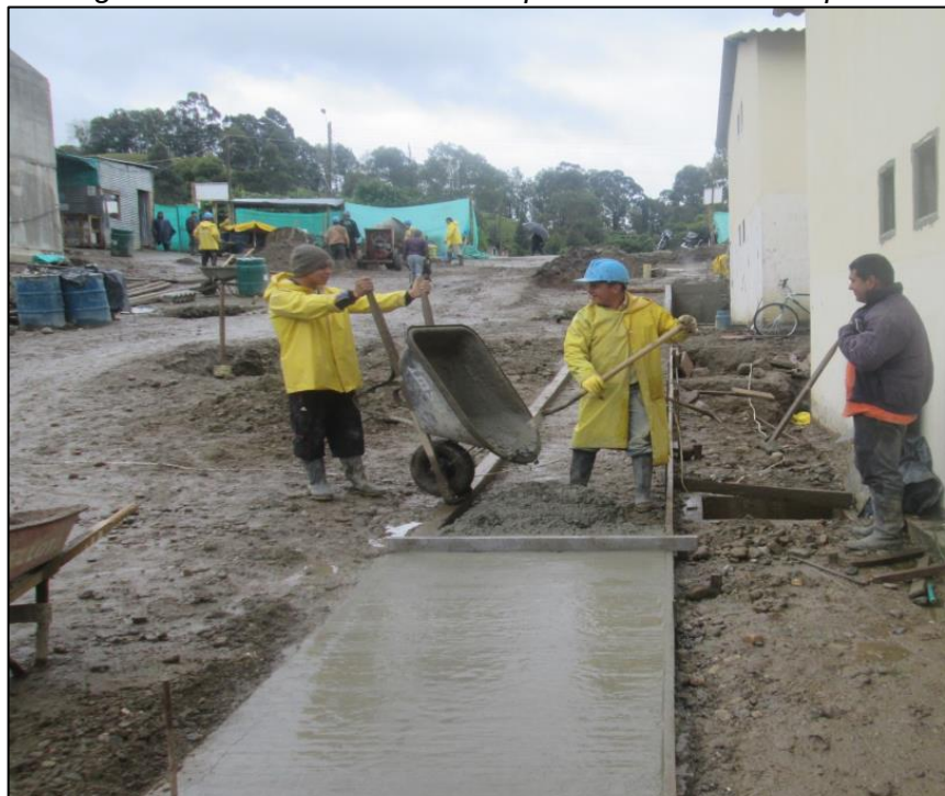
Figura 47 - Fundición de andén perimetral de los bloques.
