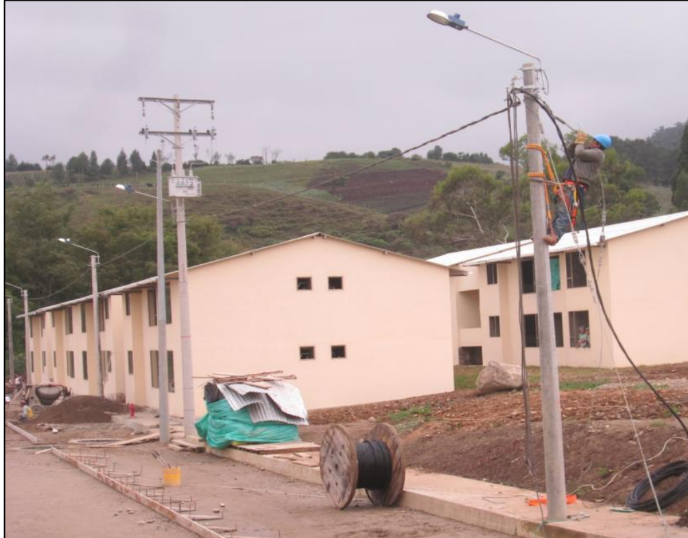
Figura 56 - Instalación de luminarias en postes
