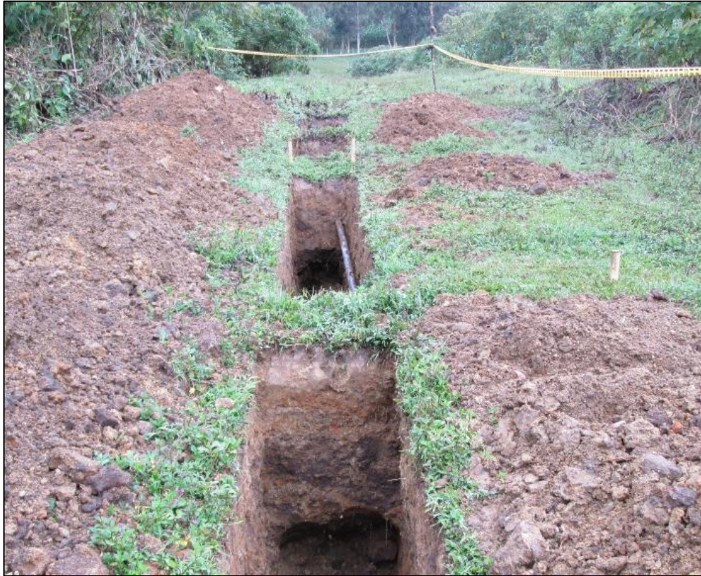
Figura 7 - Excavación manual para la conexión de la tubería
