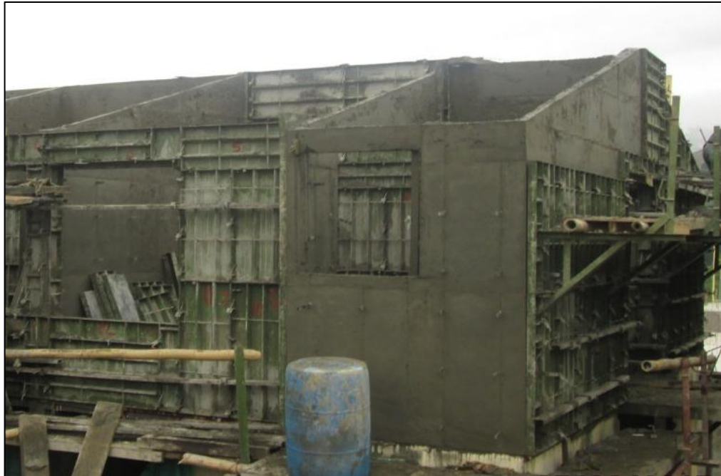
Figura 34 - Desencofrado de muros y tímpanos ya fundidos.
