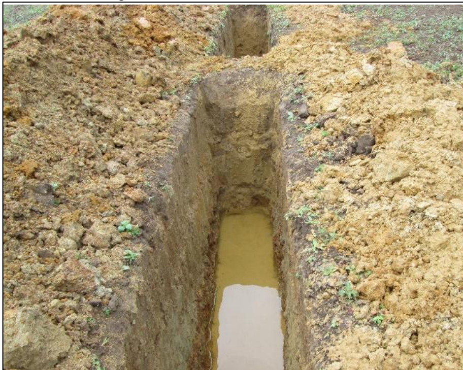
Figura 5 - Excavación manual de filtros
