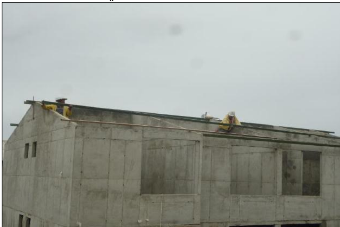
Figura 36 - Instalación de cubierta.
