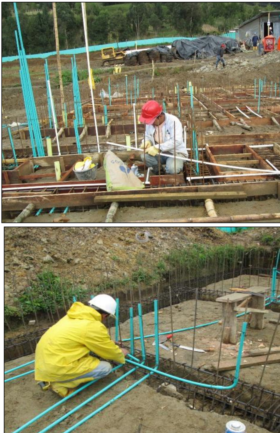
Figura 23 - Corte e instalación de tubería eléctrica.
