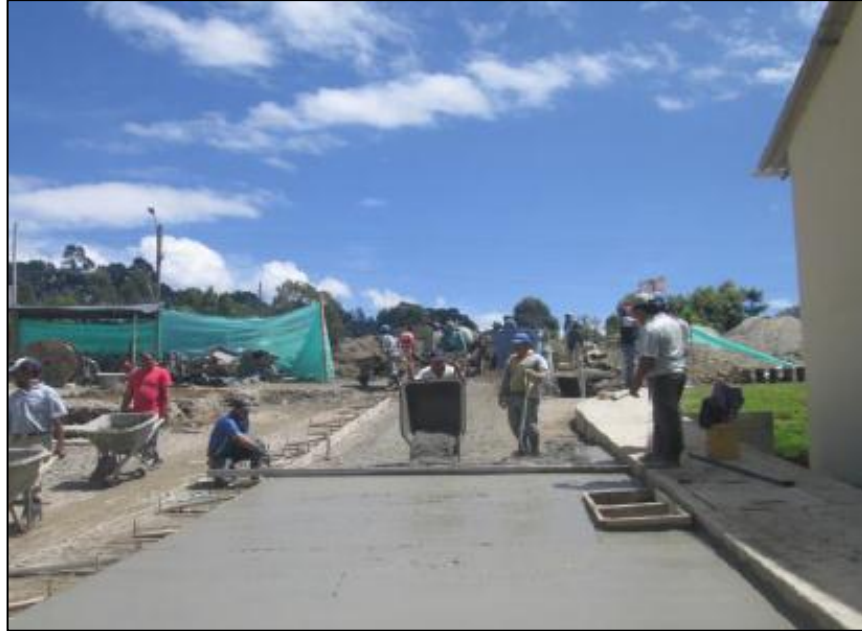
Figura 49 - Fundición del pavimento rígido de la vía principal, carril izquierdo.
