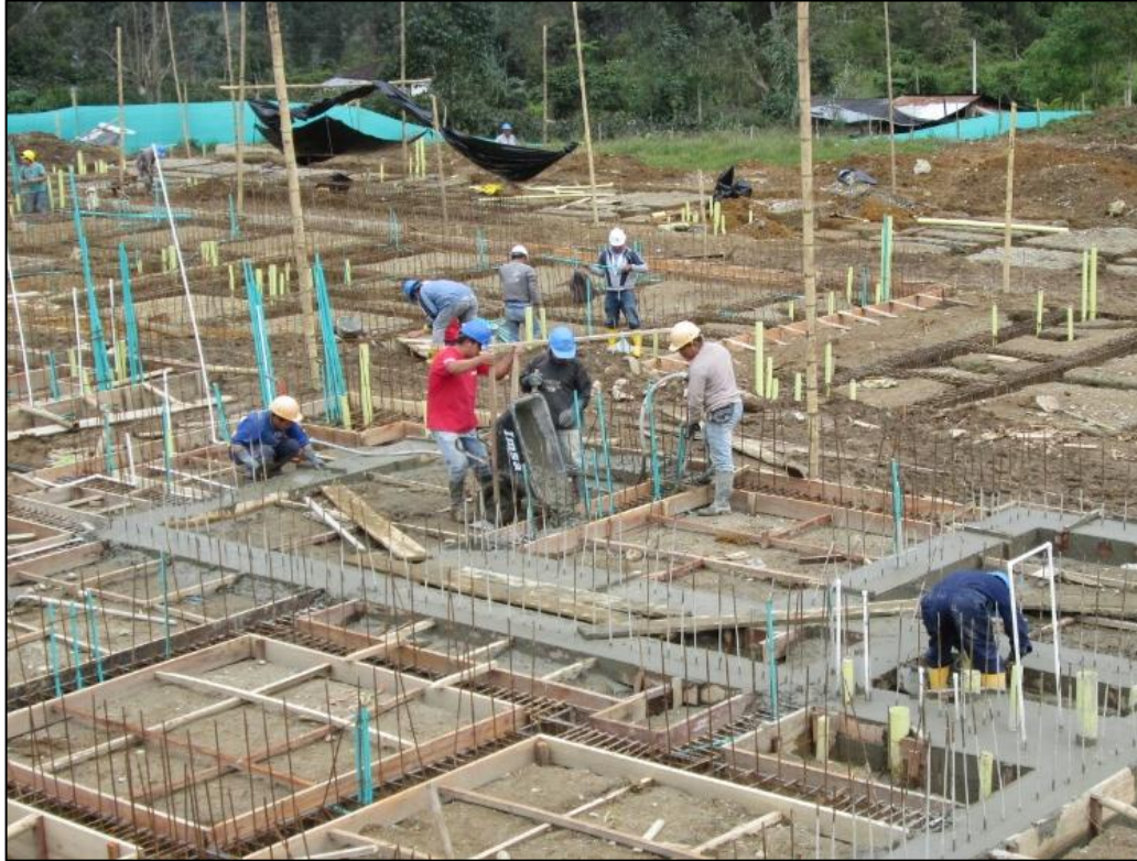
Figura 20 - Fundición de vigas de cimentación.
