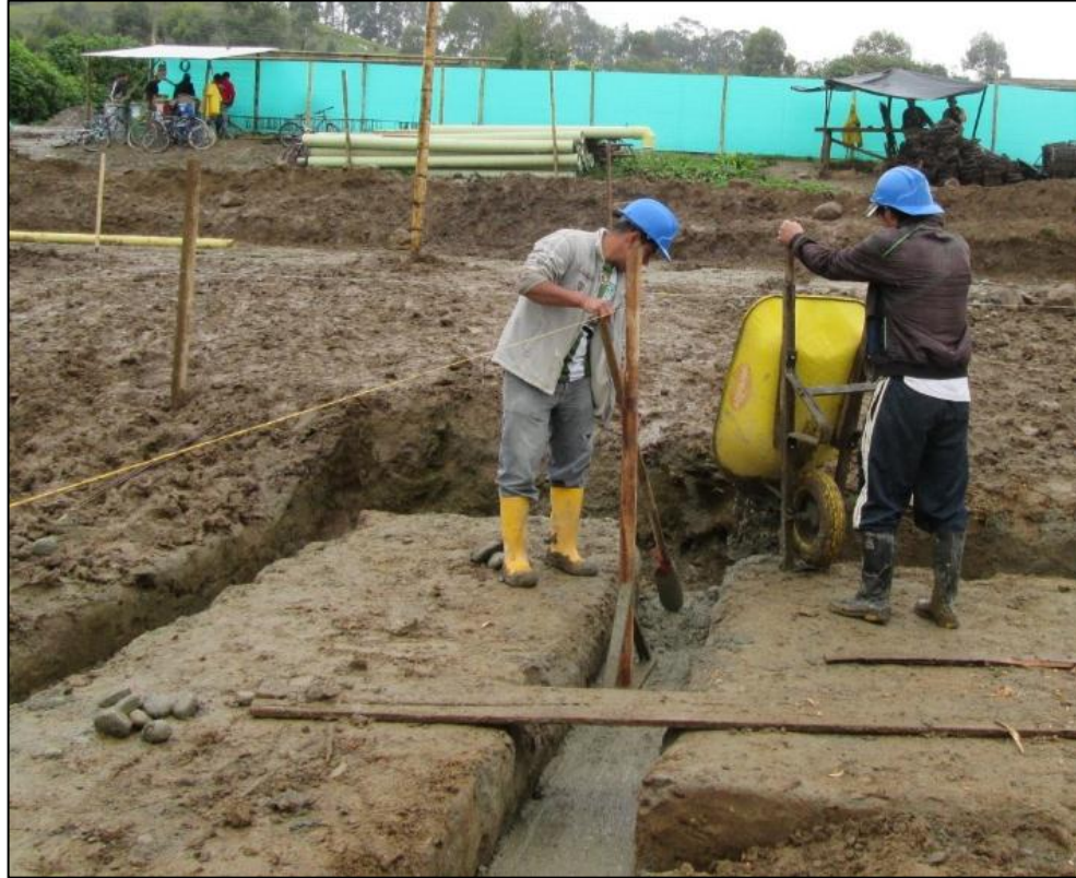
Figura 17 - Fundición de solados para las vigas de cimentación.
