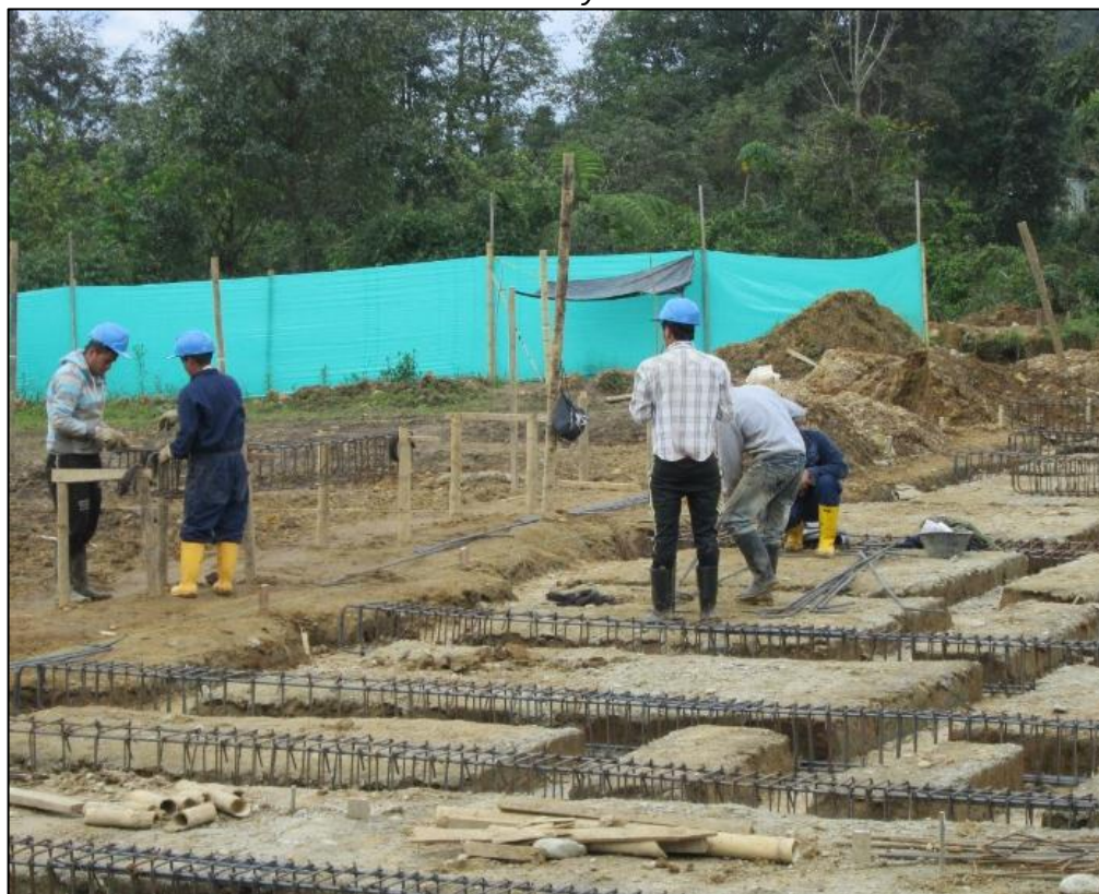
Figura 19 - Amarre de castillos para vigas de cimentación con las instalaciones hidrosanitarias y eléctricas.
