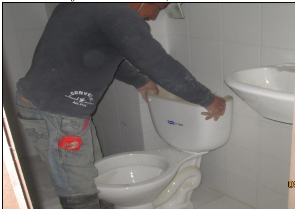
Figura 42 - Instalación de aparatos sanitarios.
