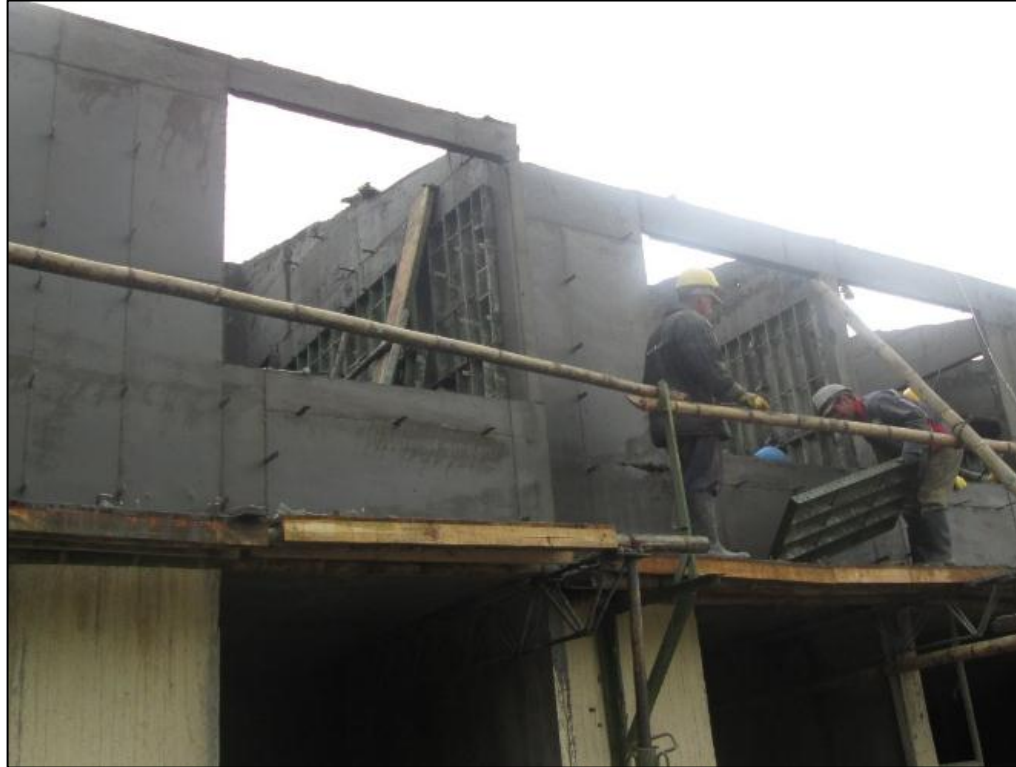
Figura 33 - Desencofrado de muros fundidos.
