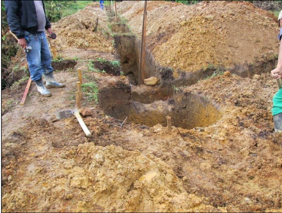
Figura 8 - Excavación manual de una cámara de inspección
