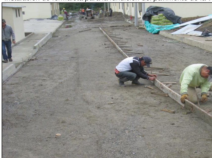
Figura 48 - Instalación de formaleta para la fundición del pavimento de la vía principal.
