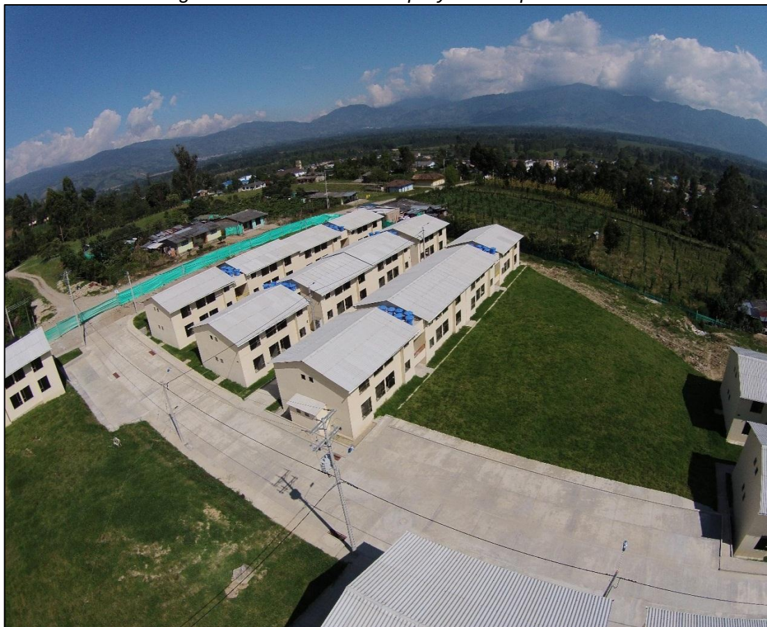
Figura 58 - Vista aérea del proyecto empradizado.
