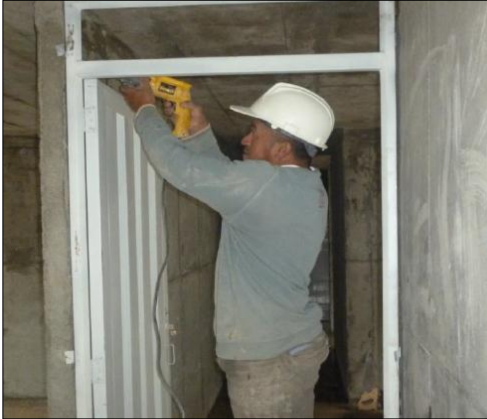
Figura 40 - Instalación de puertas metálicas.
