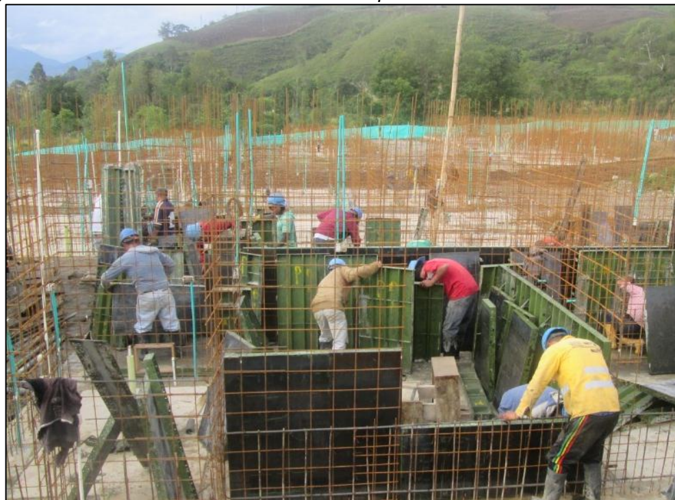
Figura 26 - Instalación de formaleta metálica para fundición de muros de concreto.
