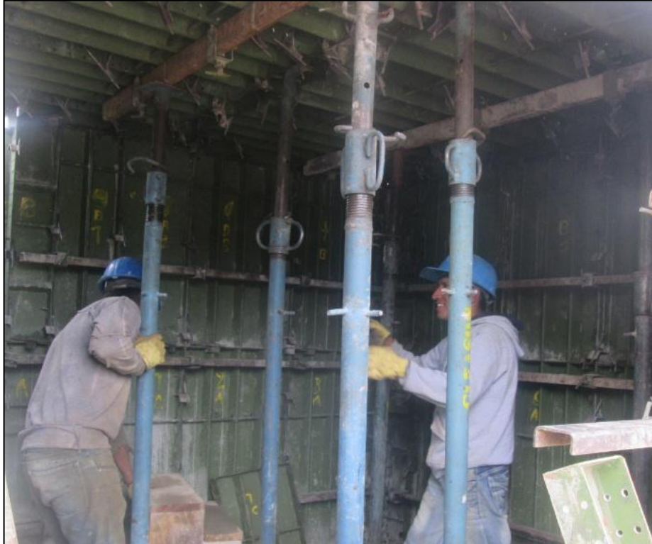
Figura 27 - Instalación de formaleta metálica para placa de entrepiso.
