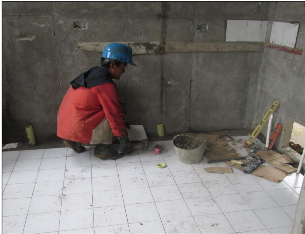
Figura 39 - Instalación de enchape sobre el piso.
