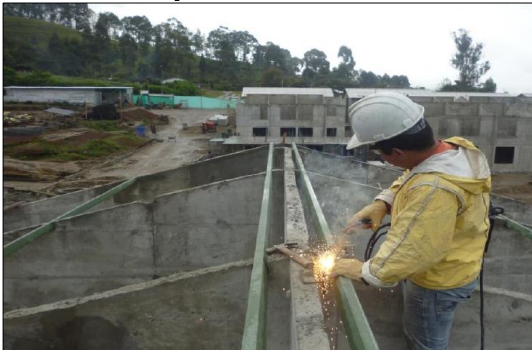
Figura 37 - Soldadura de correas.
