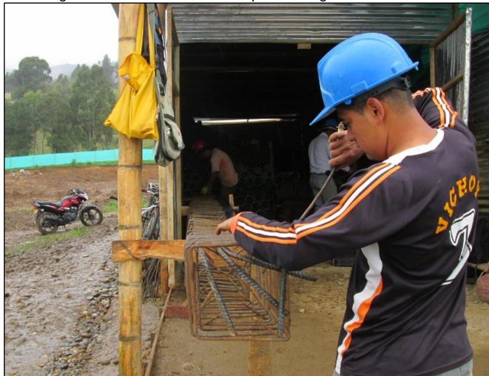
Figura 18 - Amarre de castillos para las vigas de cimentación
