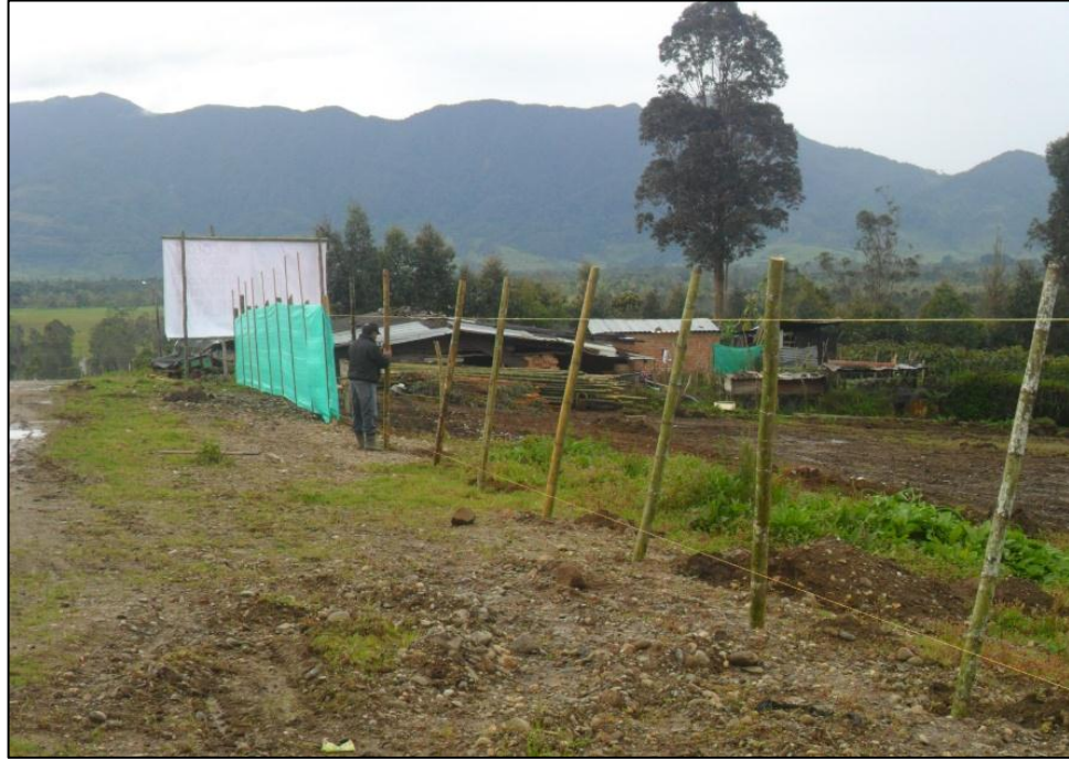
Figura 2 - Instalación de guadua y polisombra para aislamiento preventivo
