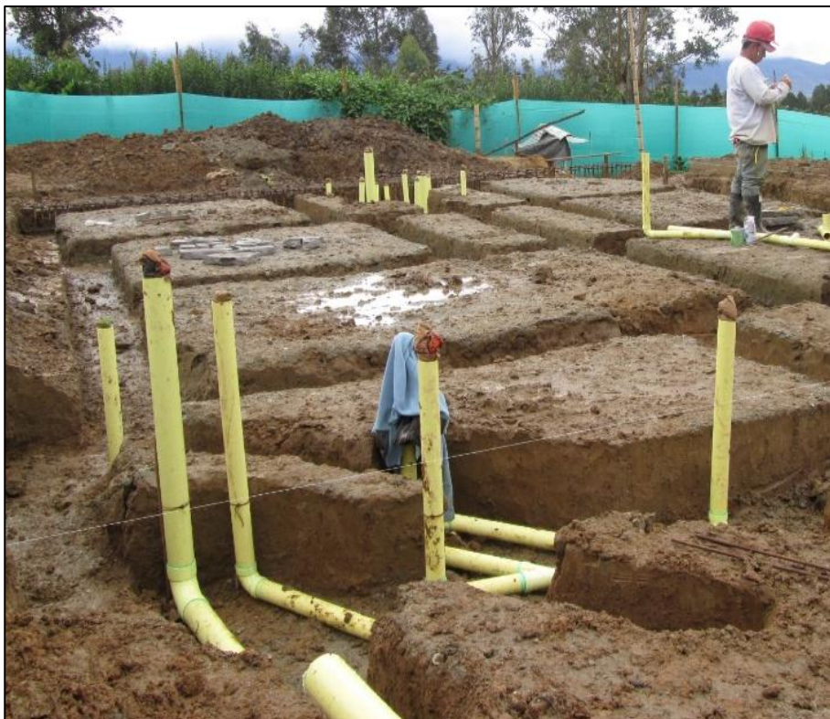
Figura 24 - Corte e instalación de tubería sanitaria.
