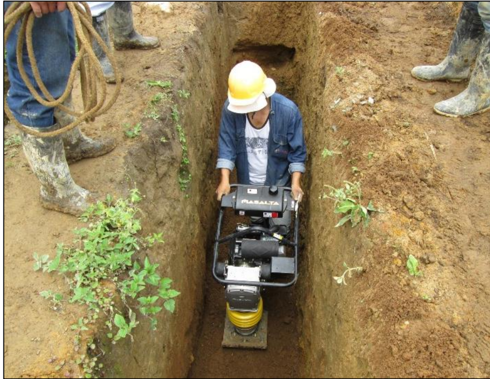
Figura 12 - Compactación del relleno, con material seleccionado haciendo uso del saltarín.
