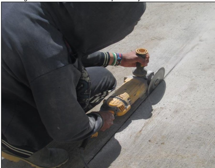
Figura 52 - Corte de concreto para las juntas de dilatación.
