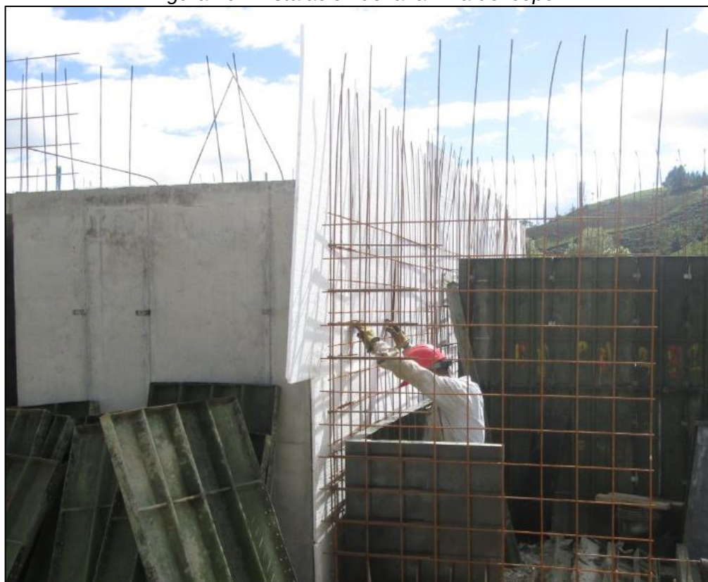
Figura 29 - Instalación de la lámina de icopor.
