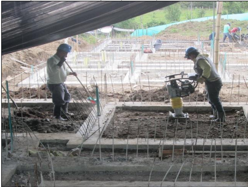
Figura 22 - Mejoramiento de suelo y compactación para fundición de placas de piso.
