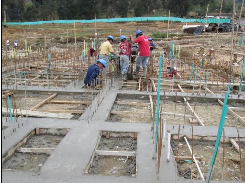
Figura 21 - Vigas de cimentación una vez fundidas.
