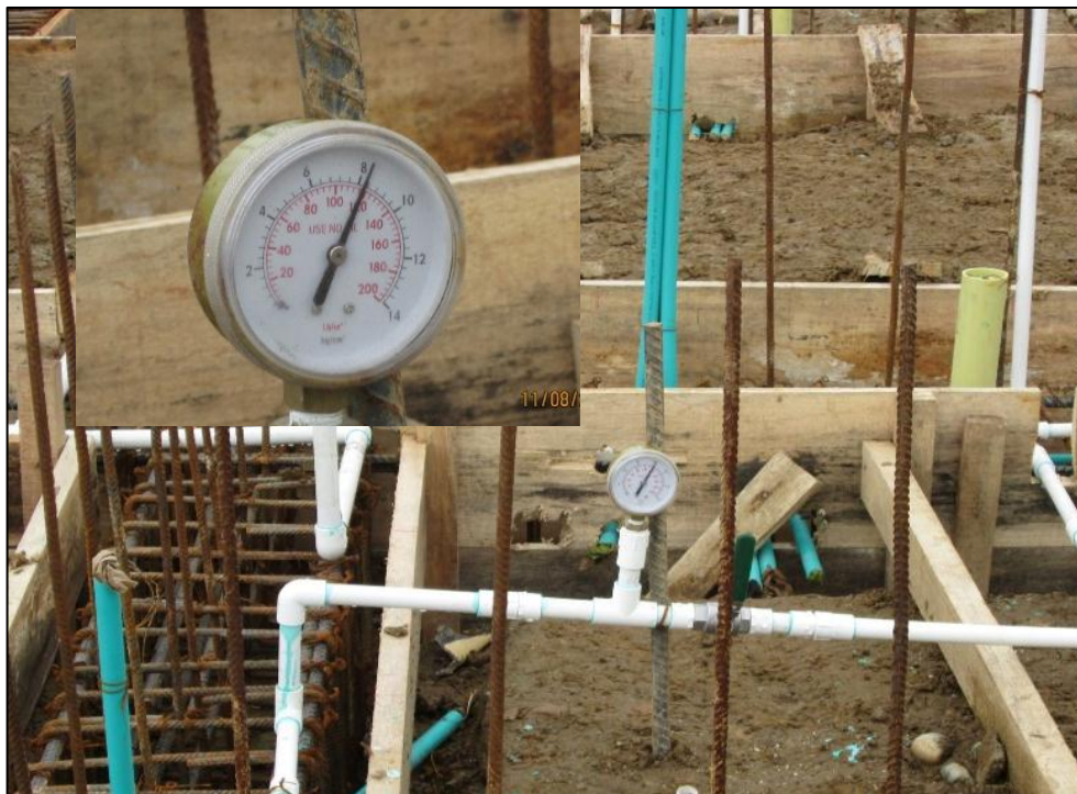
Figura 25 - Instalación de tubería hidráulica y toma de pruebas de presión.
