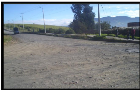
A. Zona de canalización de la quebrada
