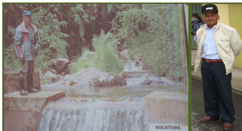
Foto 10. Señor Marcos Pejendino en la bocatoma acueducto de Anganoy.
